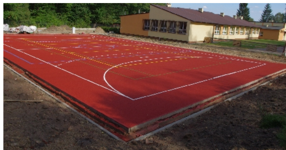
Na boisku wielofunkcyjnym w Gródkowie została już wykonana nawierzchnia.
