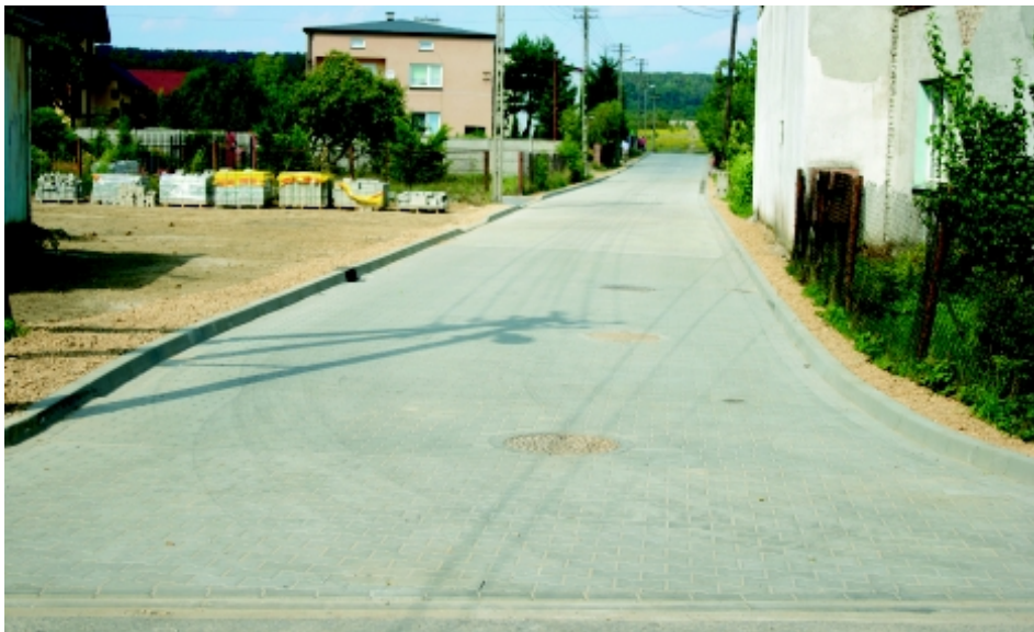
Nowo wybudowana ul. Kasztanowa w Psarach.
