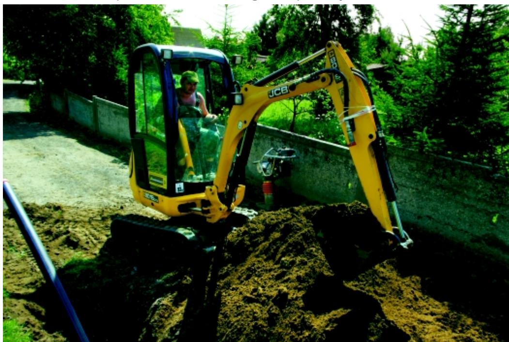
Prace nad wymianą wodociągu na ulicy Ogrodowej w Strzyżowicach.
