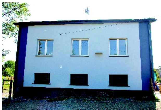
Elewacja została wykonana już na dwóch ścianach budynku Preczowie.
