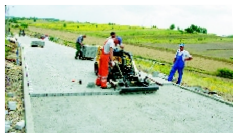
Maszynowe układanie kostki brukowej na ulicy Belnej w Strzyżowicach.
