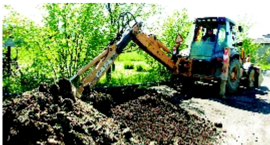
Prace na ul. Kasztanowej w Psarach.
