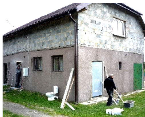
Prace budowlane na stadionie Jedności Strzyżowice.
