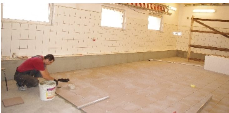
Marcin Buczyński w trakcie prac w garażu OSP Sarnów.
