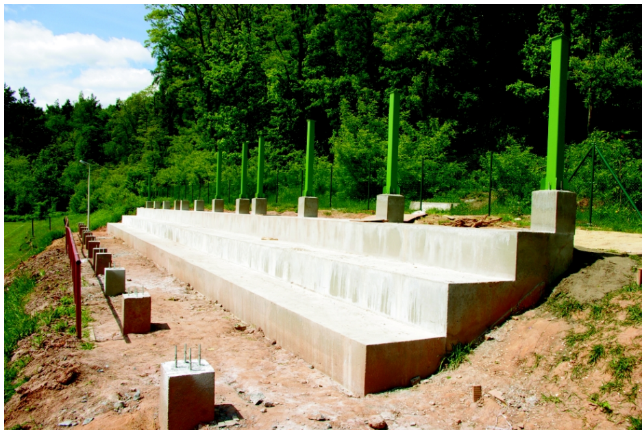
Powstał fundament przyszłej zabudowy trybun, która pomieści 120 widzów.
