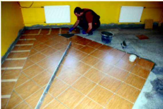
Marcin Buczyński z gminnej ekipy budowlanej podczas prac w szkole w Sarnowie.
