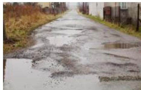
W 2012 r. planowana jest długo oczekiwana budowa ul. Kasztanowej
