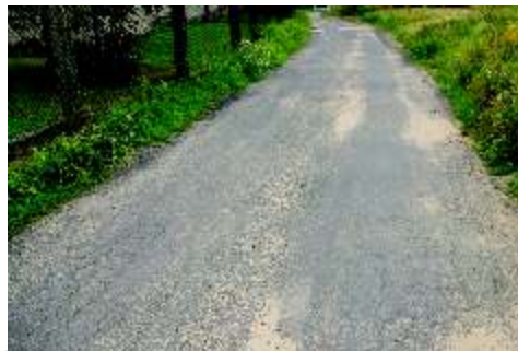
Fragment ulicy Krótkiej w Sarnowie wykonanej metodą frezu asfaltowego na gorąco.
