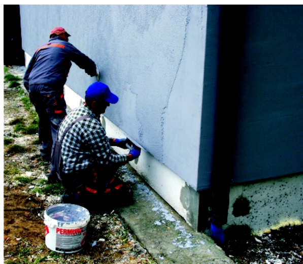
Gminna ekipa remontowa kładzie tynk akrylowy na budynku szatni Orła Dąbie
