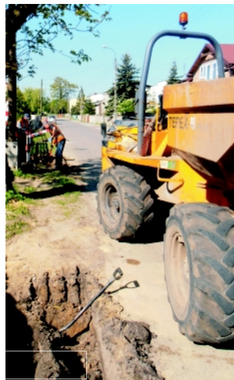
Prace nad budową wodociągu w lipcu br.
