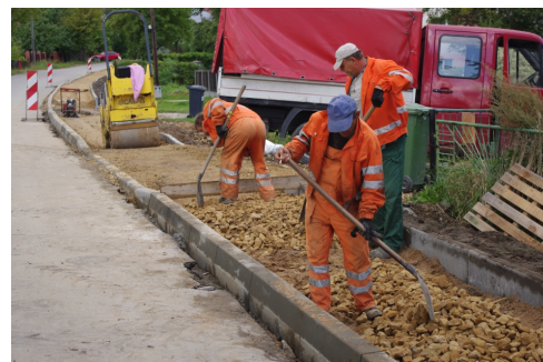
Firma Drogrem podczas pracy nad budową chodnika na ulicy Wiejskiej w Sarnowie.
