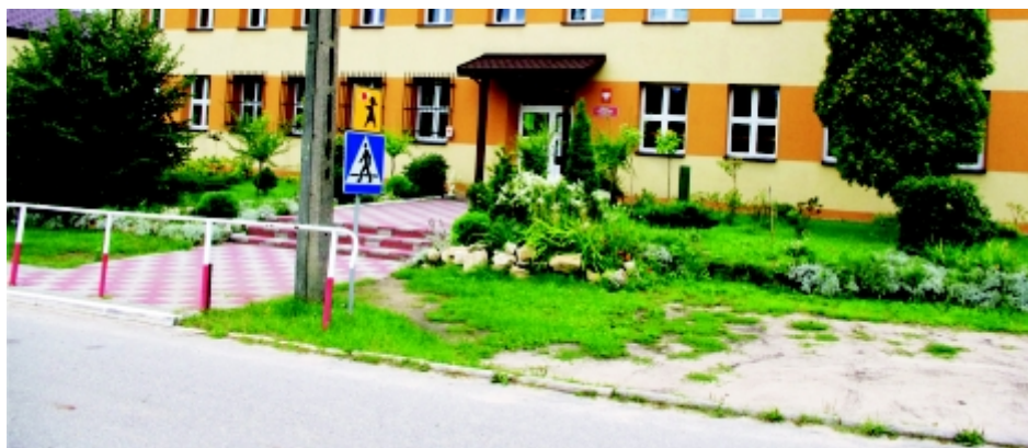
Teren przed Szkołą Podstawową w Sarnowie w lipcu bieżącego roku przed budową.
