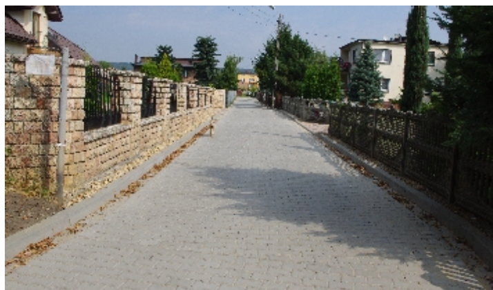
Ukończona ulica Reymonta z nową drogą dojazdową.
