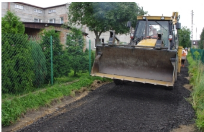
Firma Drogrem podczas prac na ulicy Wąskiej w Sarnowie.
