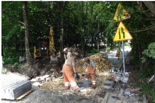
Prace ekipy z firmy Drogrem na ulicy Reymonta.
