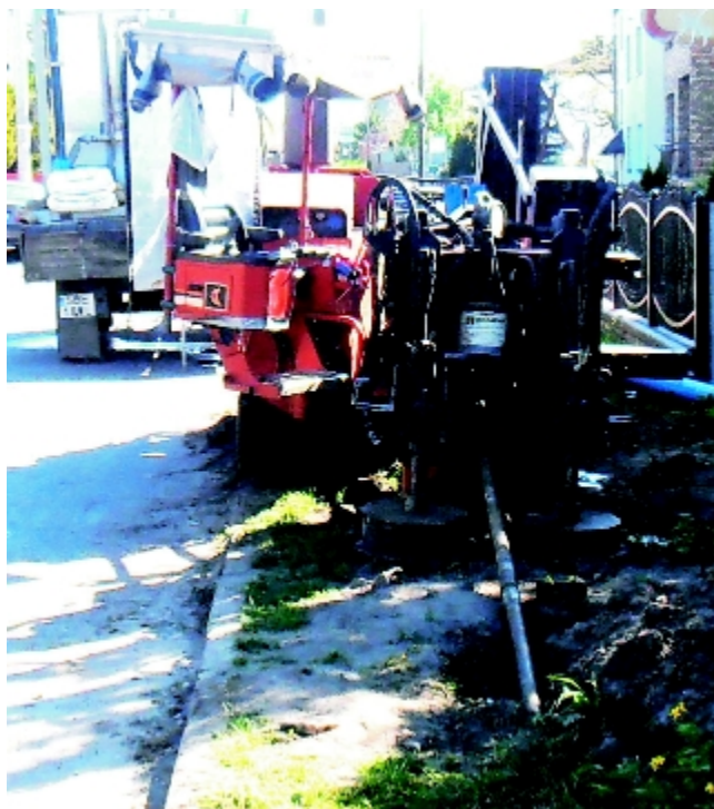
Przebudowa wodociągu metodą bezwykopową.
