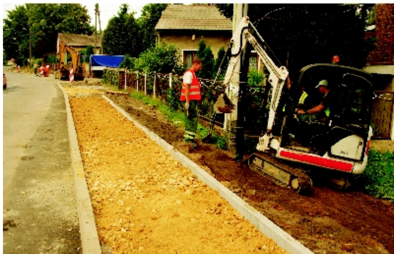
Prace przy budowie chodnika na ulicy Wiejskiej w Malinowicach.
