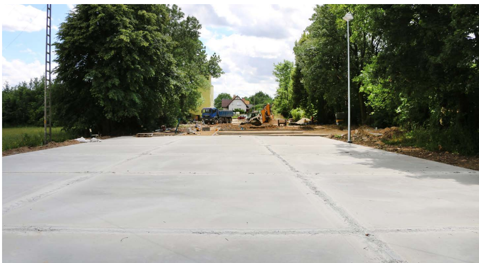
Specjalna płyta utwardzona korundem, na której zamontowane będą urządzenia skateparku
