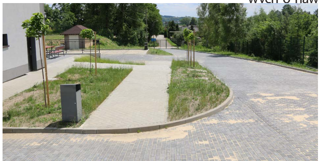
Droga dojazdowa do budynku szatni na stadionie LKS Jedność Strzyżowice
