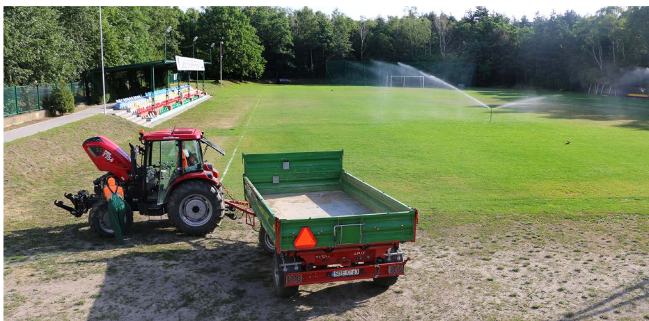
Prace nad modernizacją murawy na stadionie LKS Iskra Psary
