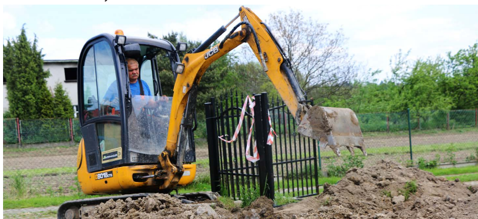
ZGK podczas prac przy wymianie wodociągu
