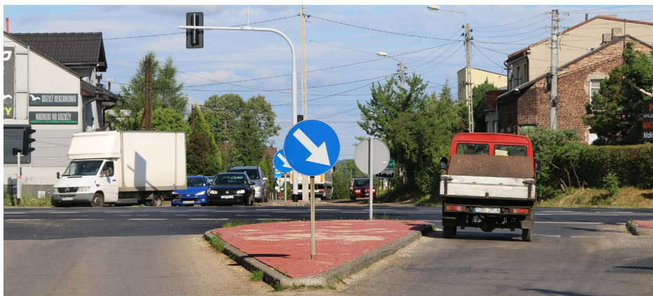
Zmodernizowana wyspa kanalizująca ruch przy DK 86 w Sarnowie
