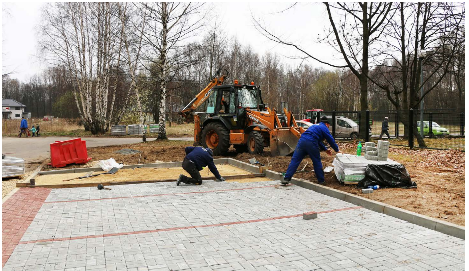
Pracownicy ZGK w trakcie budowy miejsc parkingowych
