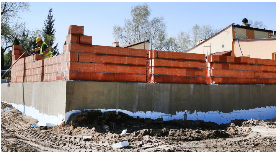
Budowa przedszkola w Gródkowie przy szkole podstawowej
