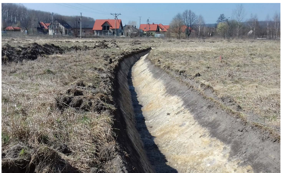
Przebudowa rowów na ul. Słonecznej w Malinowicach
