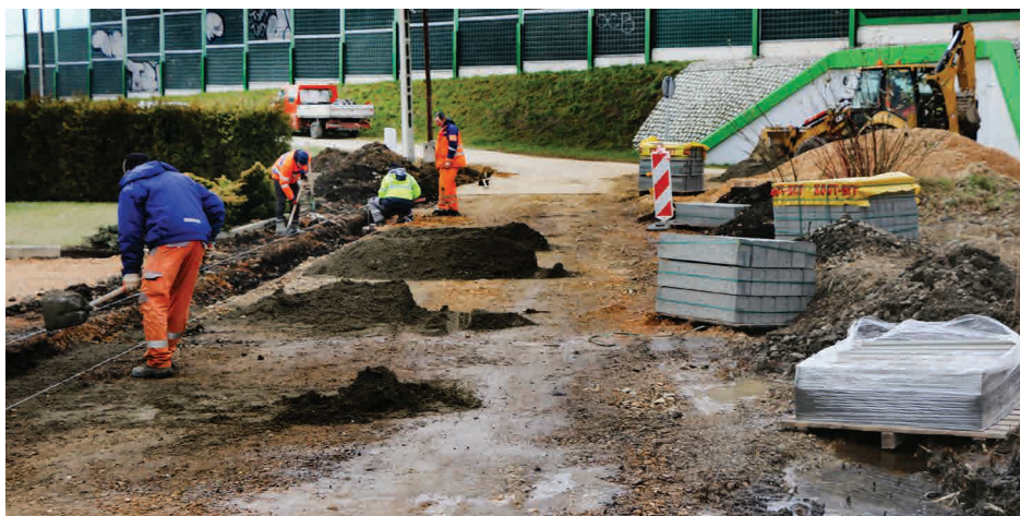
Prace na ul. Podgórnej w Sarnowie
