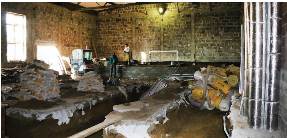
Prace nad budową sali koncertowej
