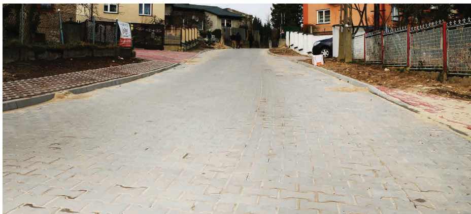
Ulica Podwale w Strzyżowicach z nową nawierzchnią z kostki betonowej
