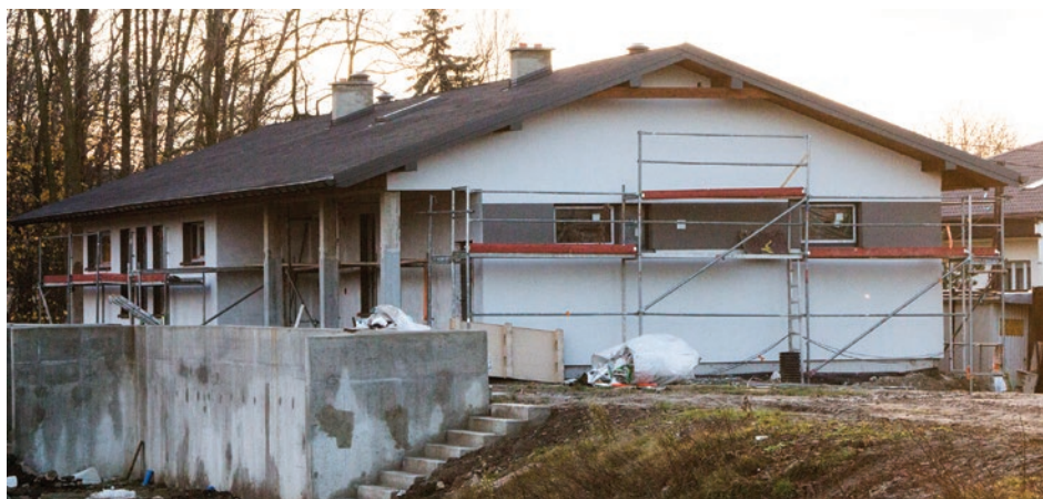
Nowo wybudowany budynek szatni KS Błękitni Sarnów
