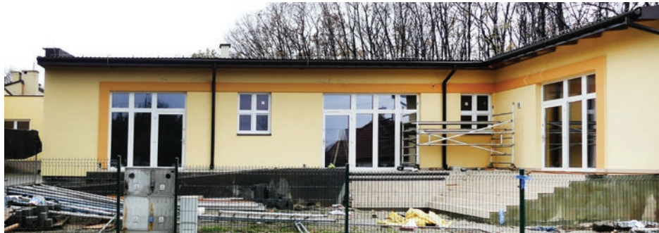
Gotowa elewacja części przedszkolnej
