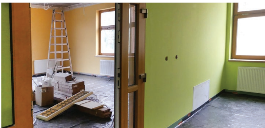
Prace wykończeniowe wewnątrz budynku przedszkolnego
