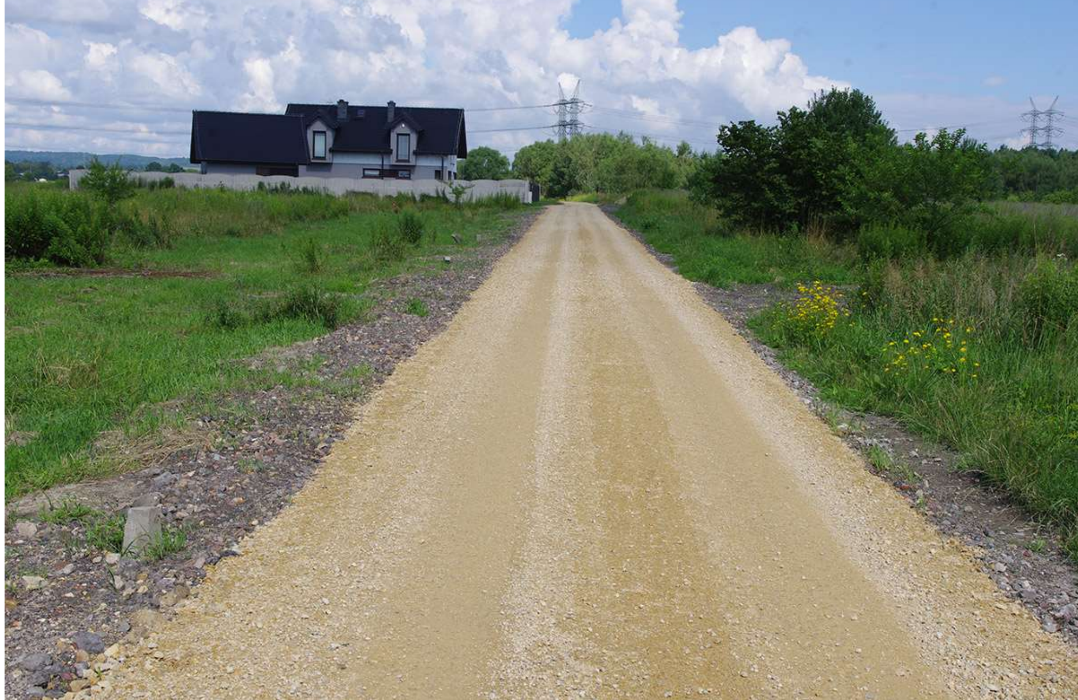
Utwardzona kruszywem ul. Skowronków w Preczowie
