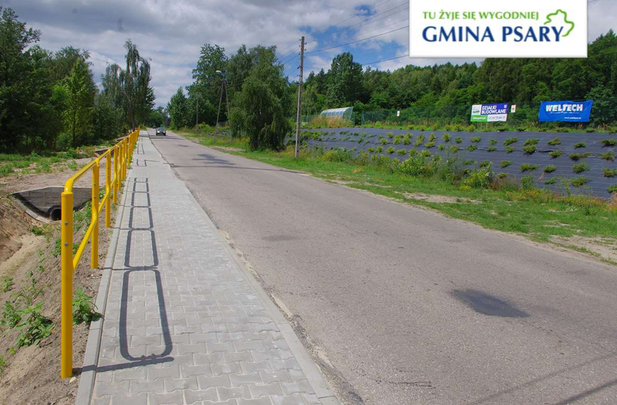
Nowy chodnik w Brzękowicach Dolnych
