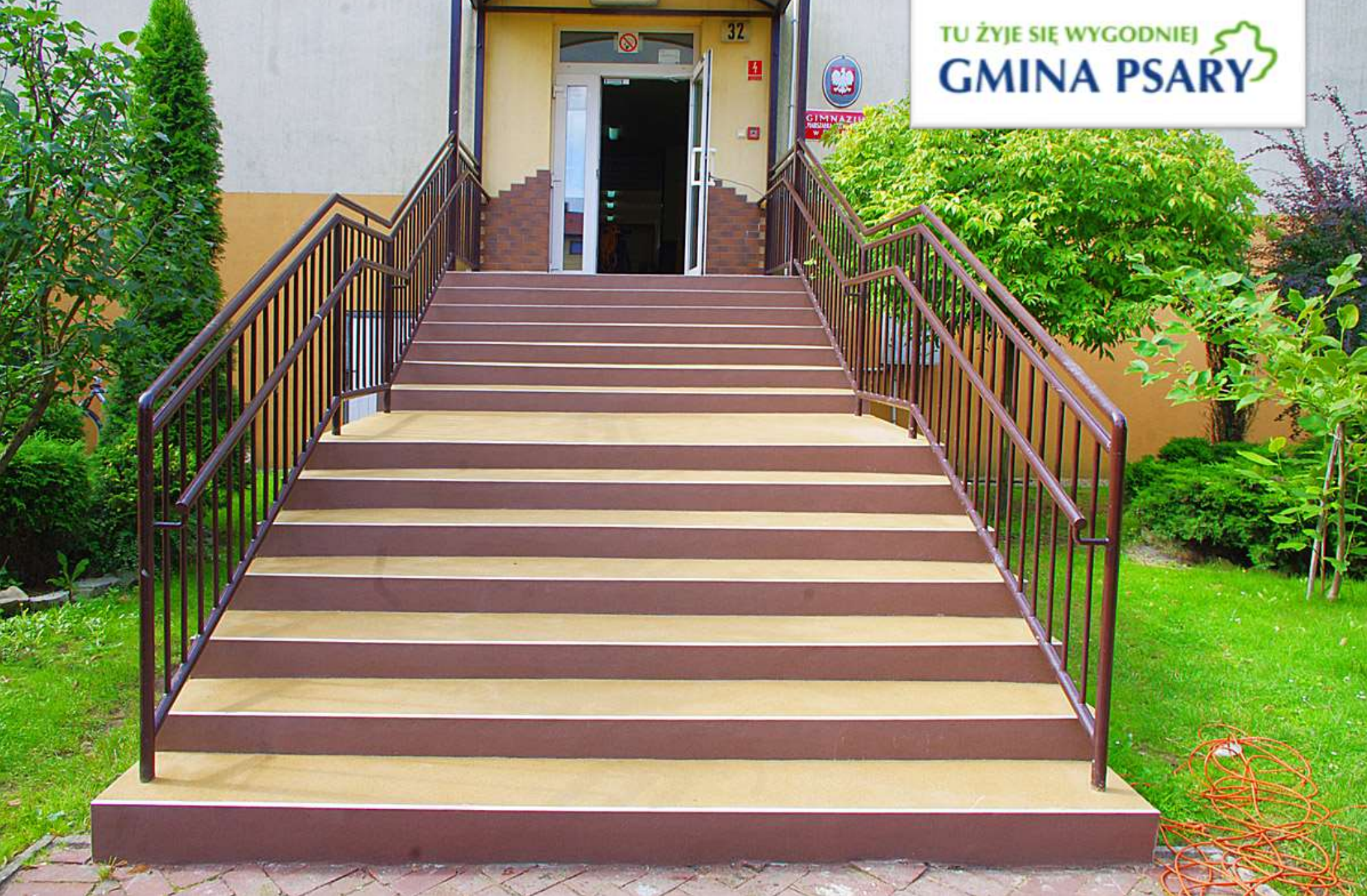
Wyremontowane schody w Gimnazjum w Psarach.
