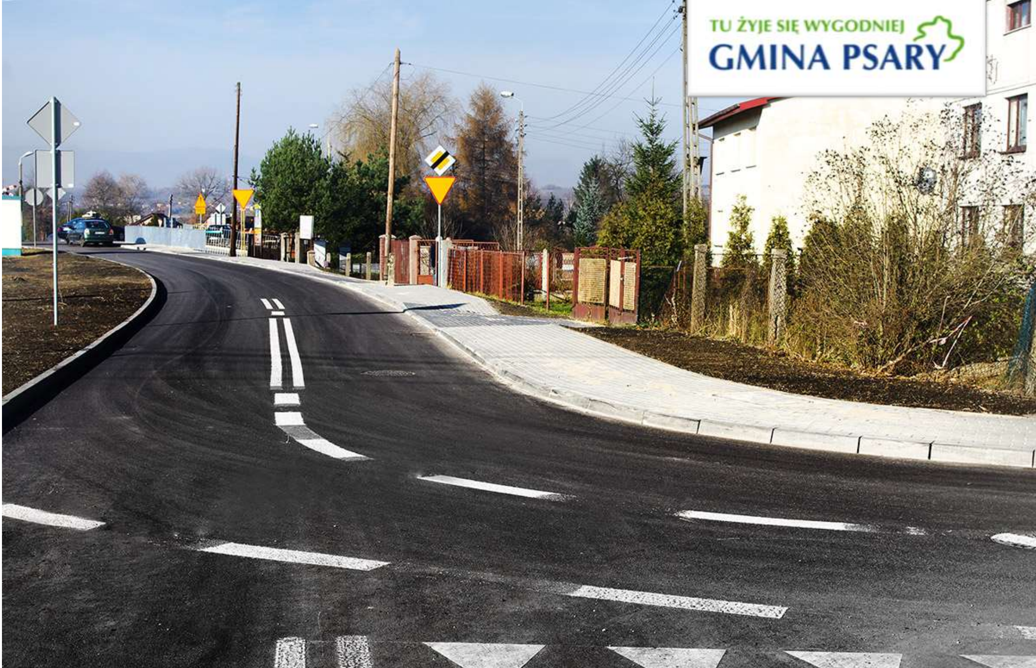
Ulica Łączna w Psarach po remoncie
