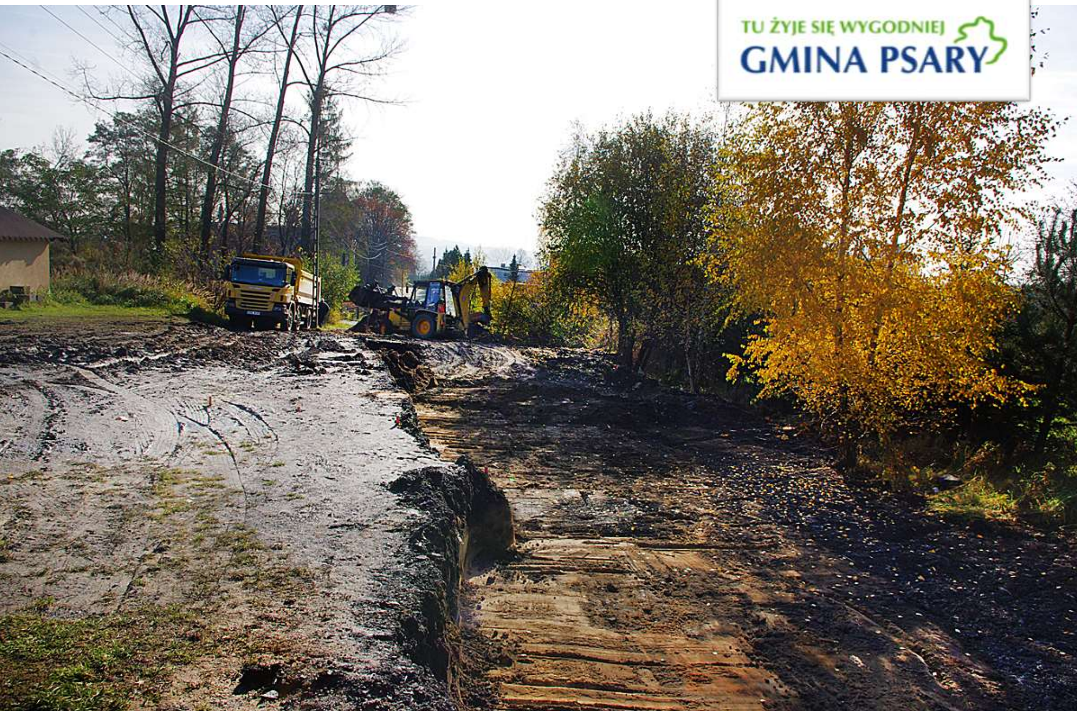
Prace na stadionie LKS Jedność Strzyżowice.
