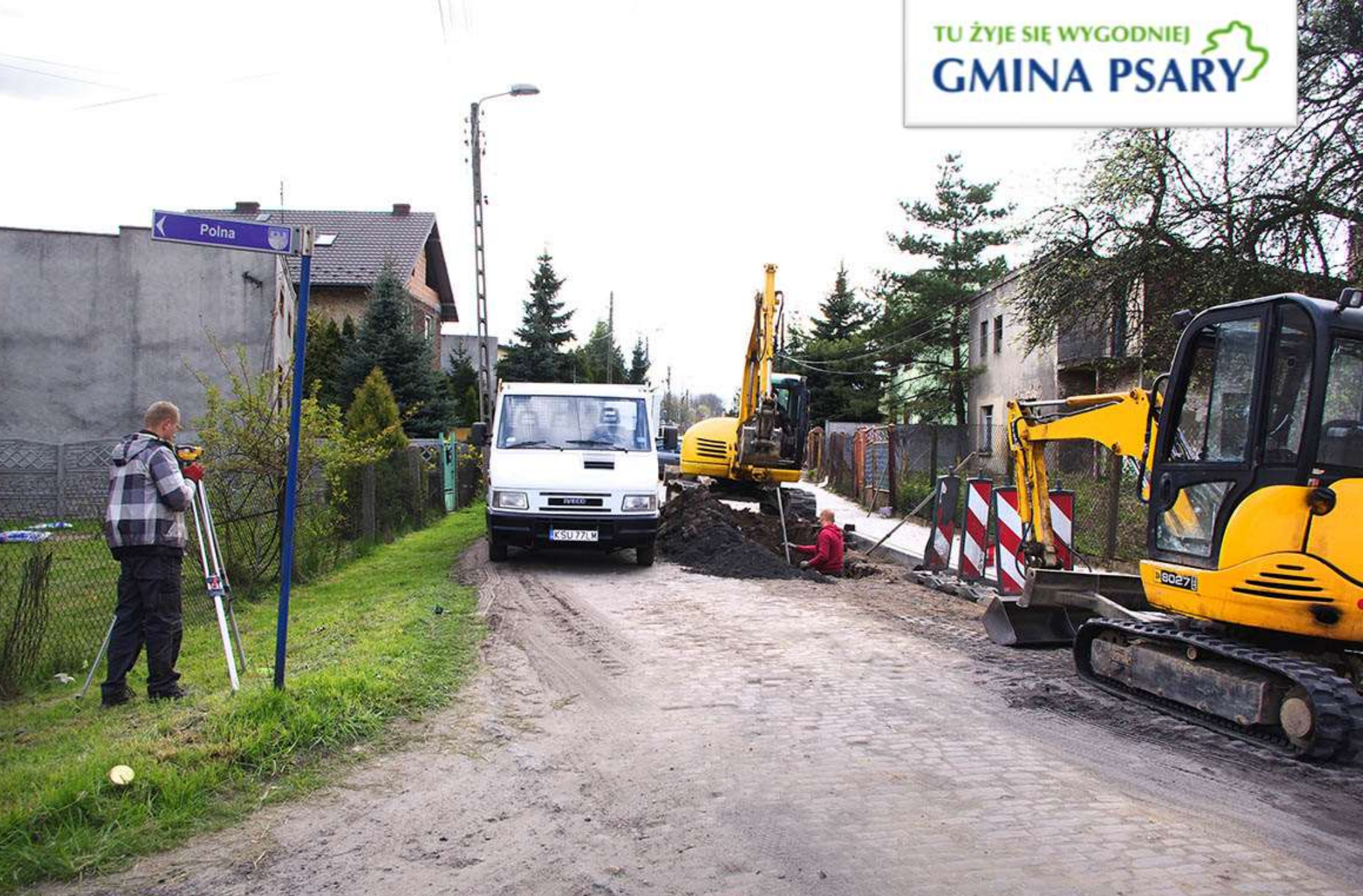
Ulica Łączna w Psarach w trakcie remontu
