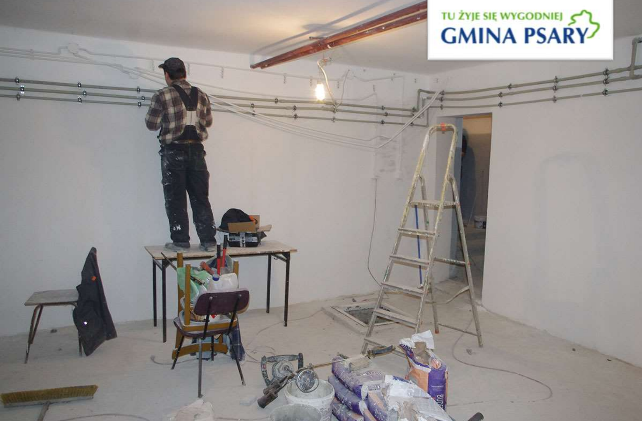
Zaadaptowanie pomieszczeń piwnicznych w budynku byłej szkoły w Malinowicach.
