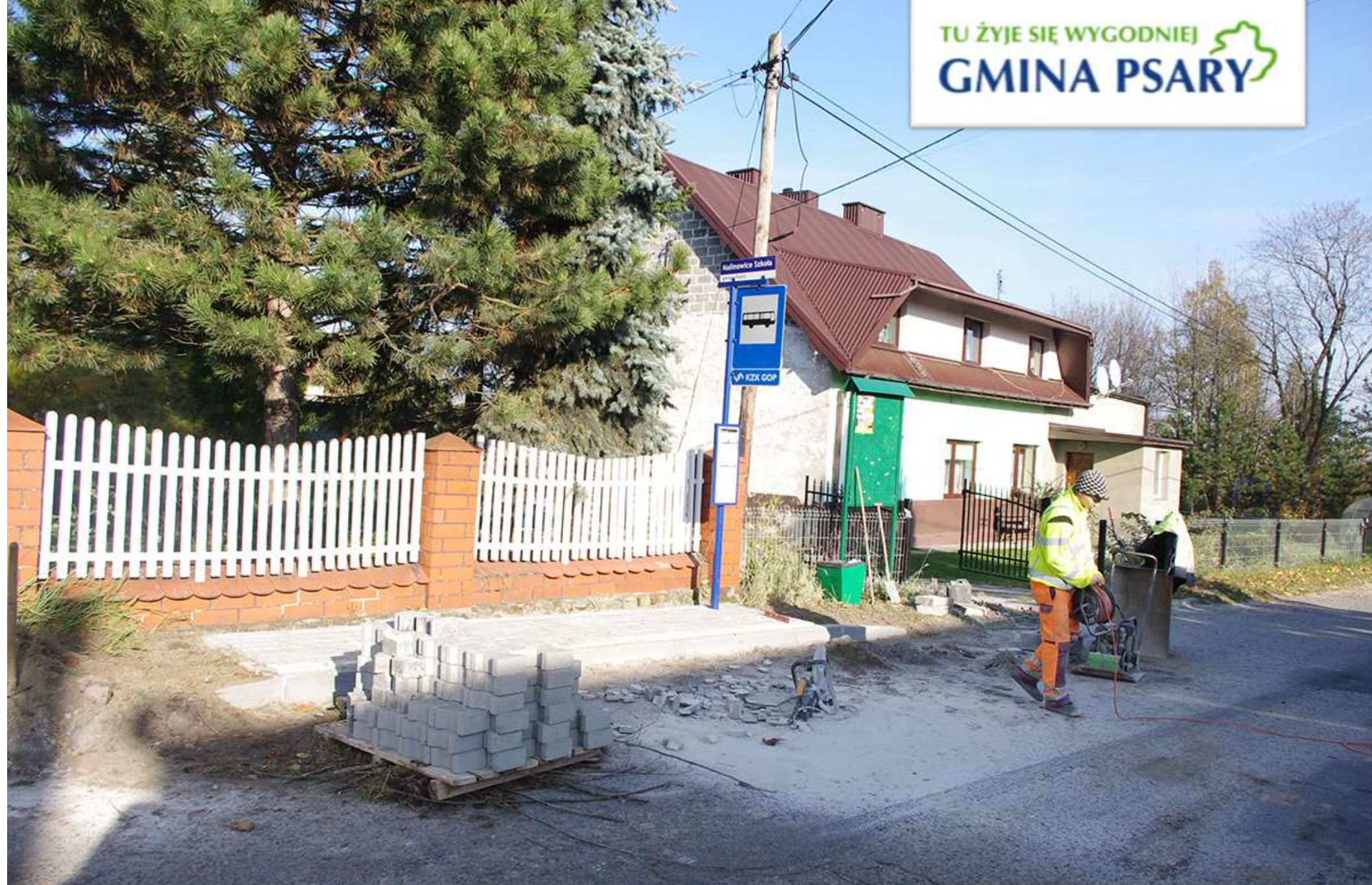
Prace przy budowie platformy autobusowej w Malinowicach.
