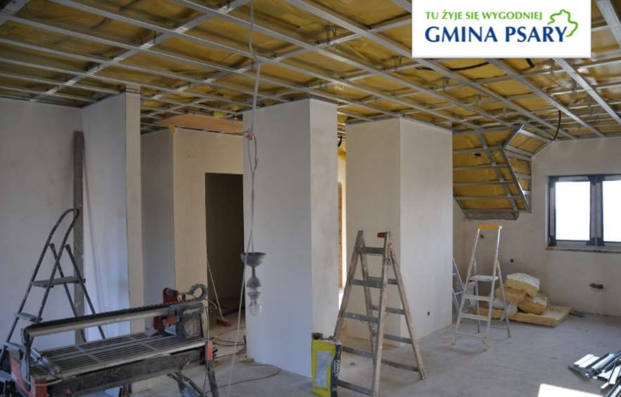
Prace podczas ocieplania dachu w domu jednego z mieszkańców gminy Psary.
