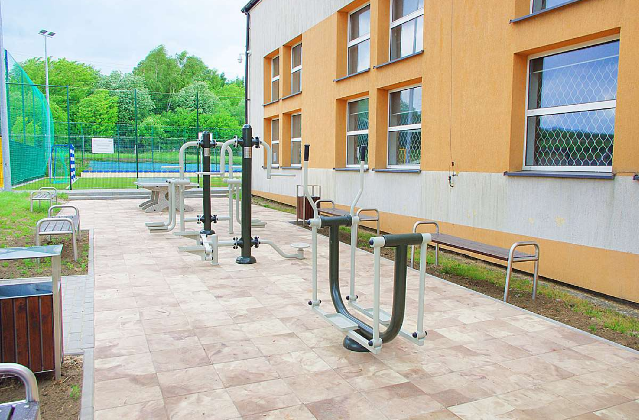
Siłownia zewnętrzna przy szkole w Dąbie.
