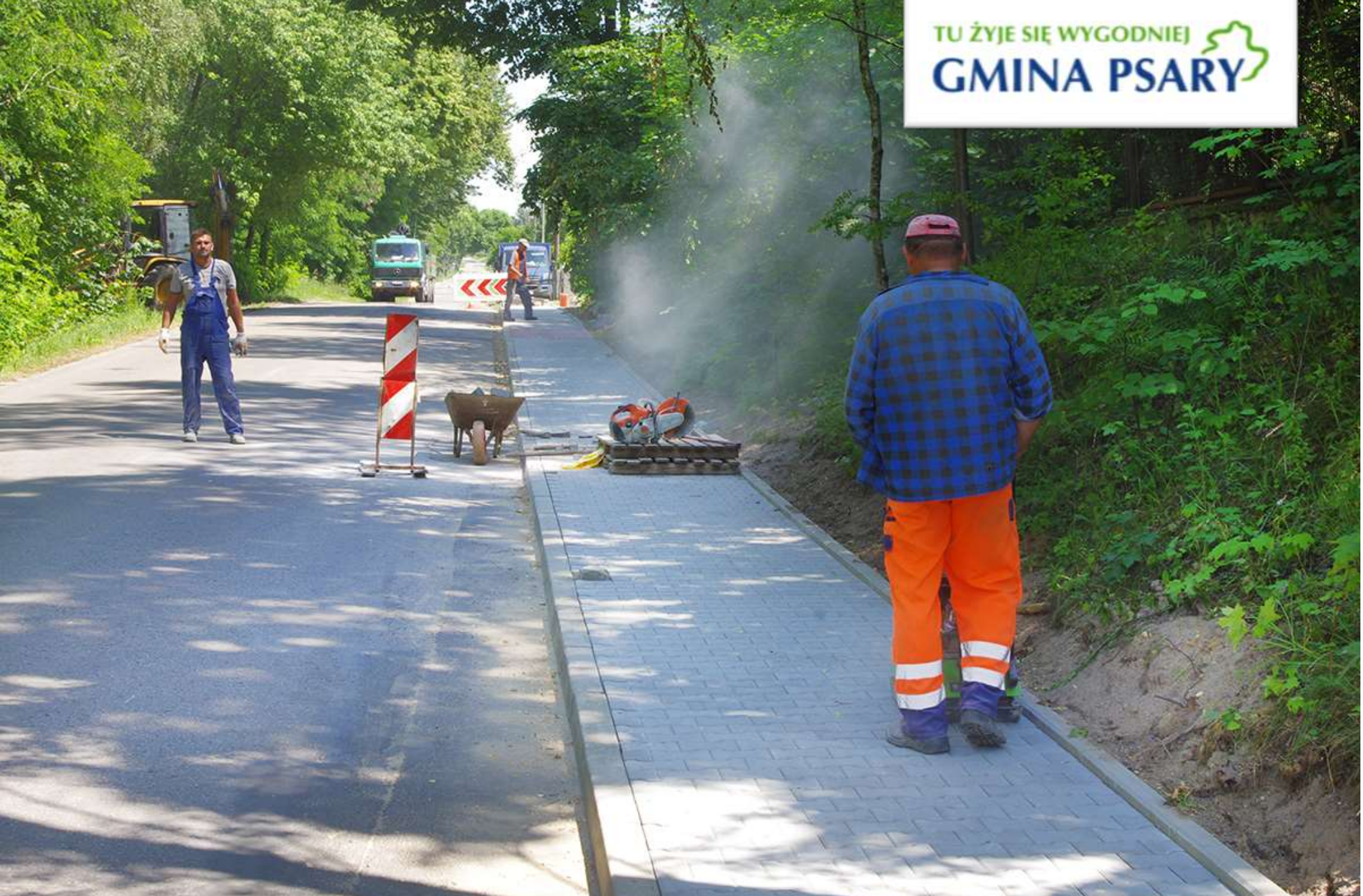
Budowa chodnika na ul. Kościuszki w Górze Siewierskiej
