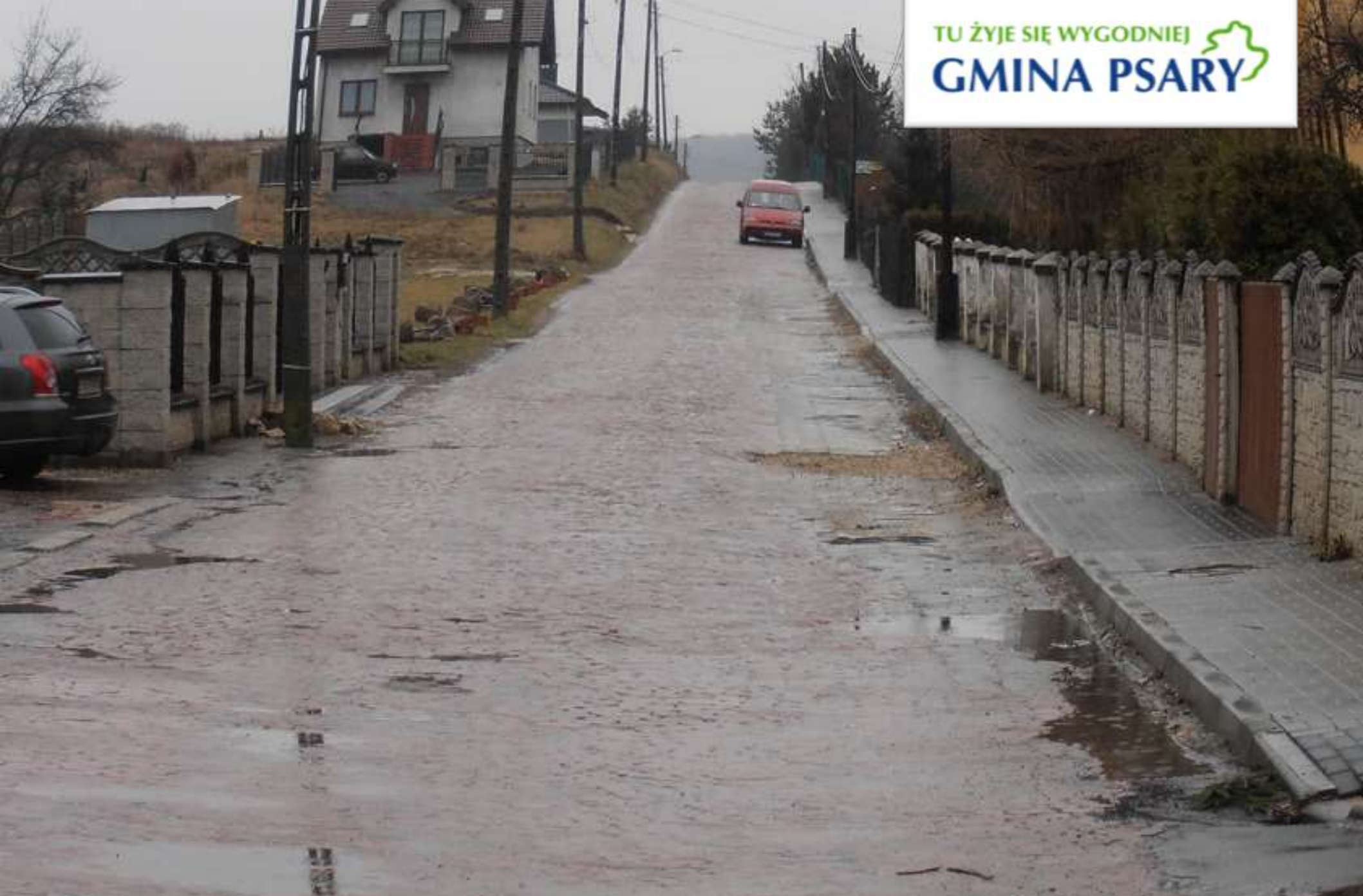
Ulica Łączna w Psarach przed przebudową
