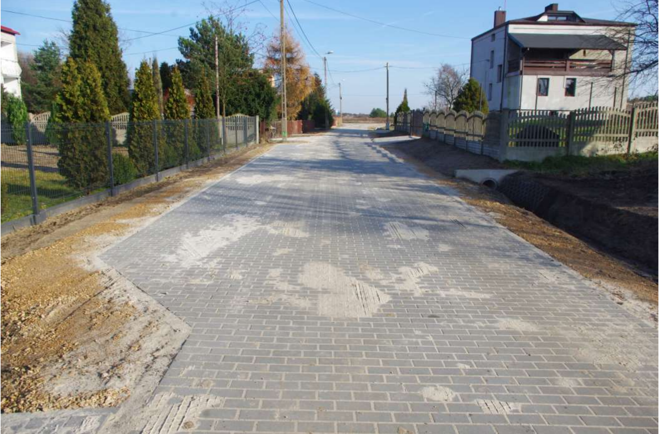
Droga w Brzękowicach Górnych po remoncie
