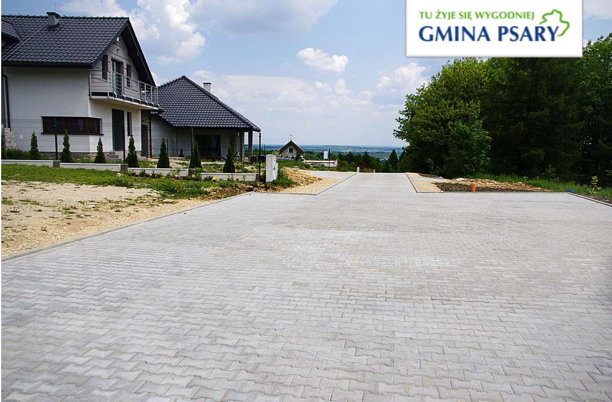
Droga na Brzękowskim Wale wykonana z kostki brukowej
