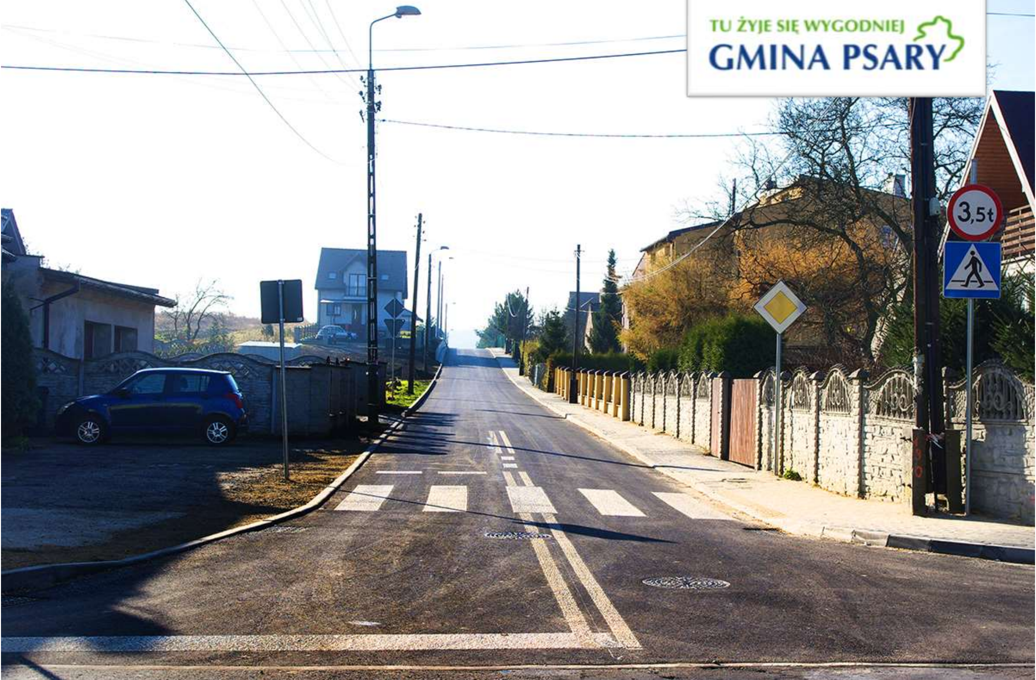
Ulica Łączna w Psarach po zakończeniu prac
