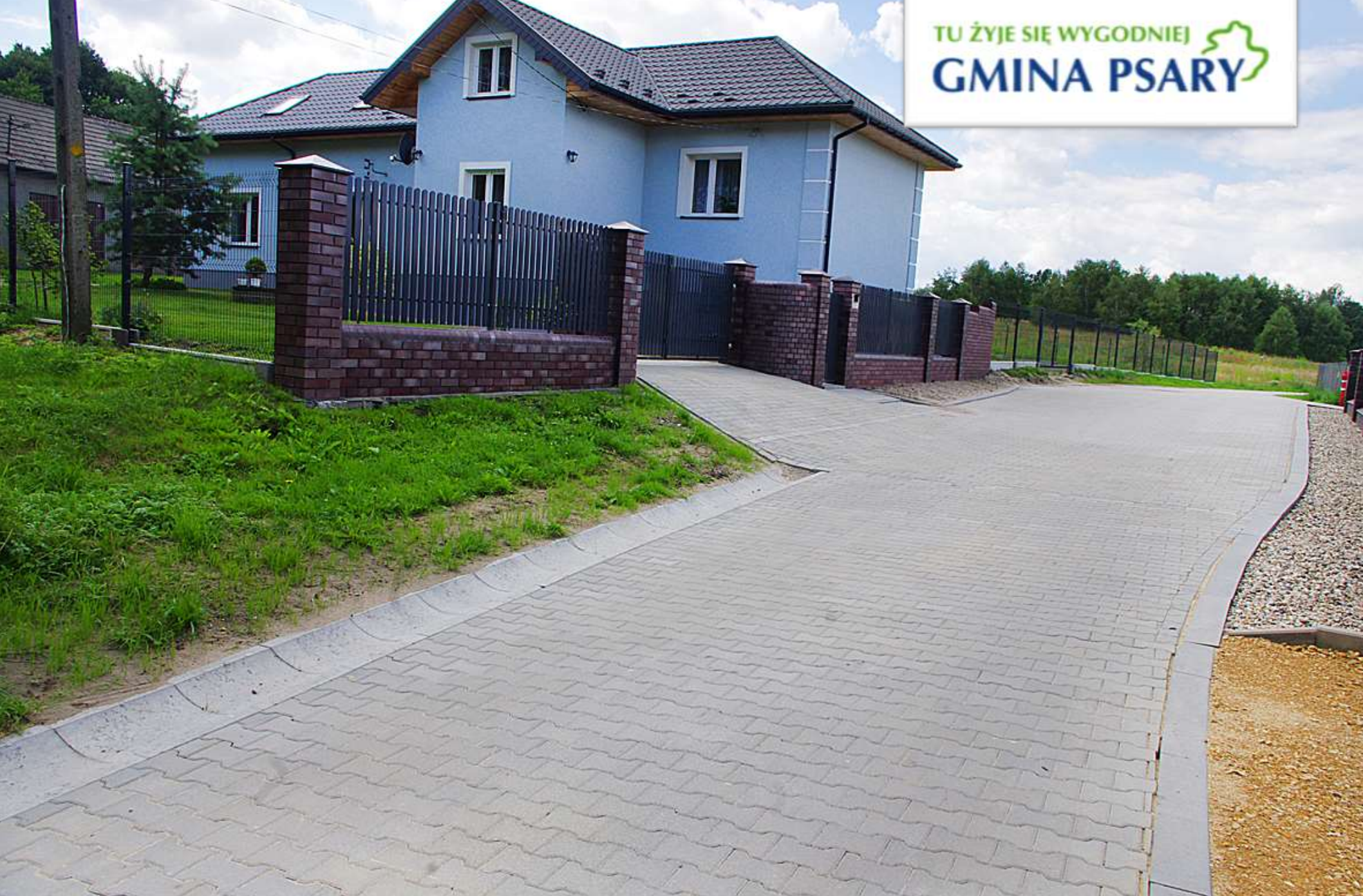
Ulica Strumyczna w Malinowicach po remoncie
