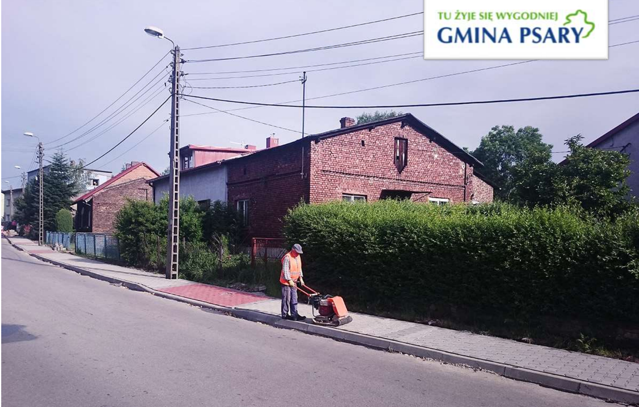
Budowa nowego odcinka chodnika przy ulicy Wiejskiej w Sarnowie
