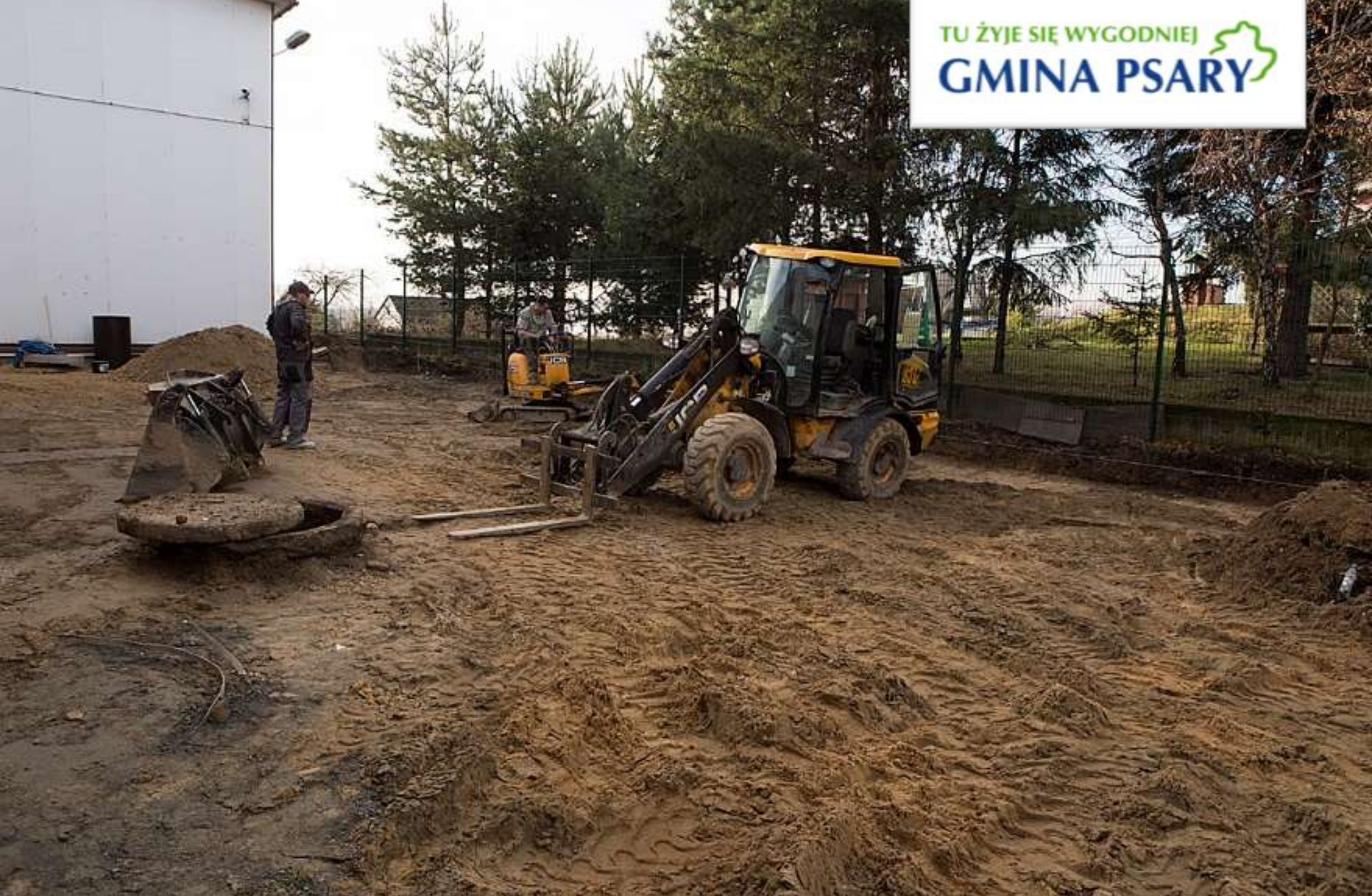
Prace podczas budowy parkingu przy szkole w Sarnowie.
