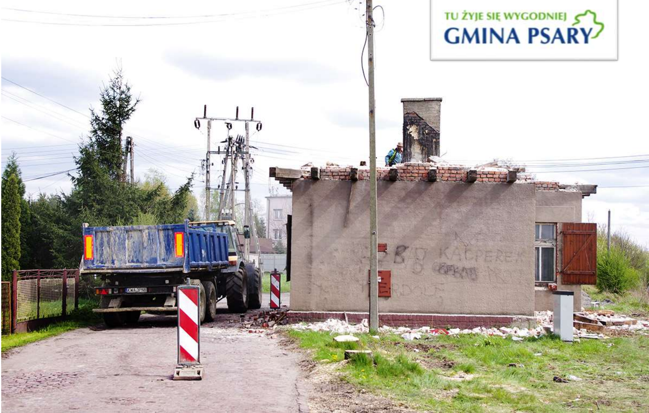
Wyburzanie budynku po byłej stacji kolejowej.
