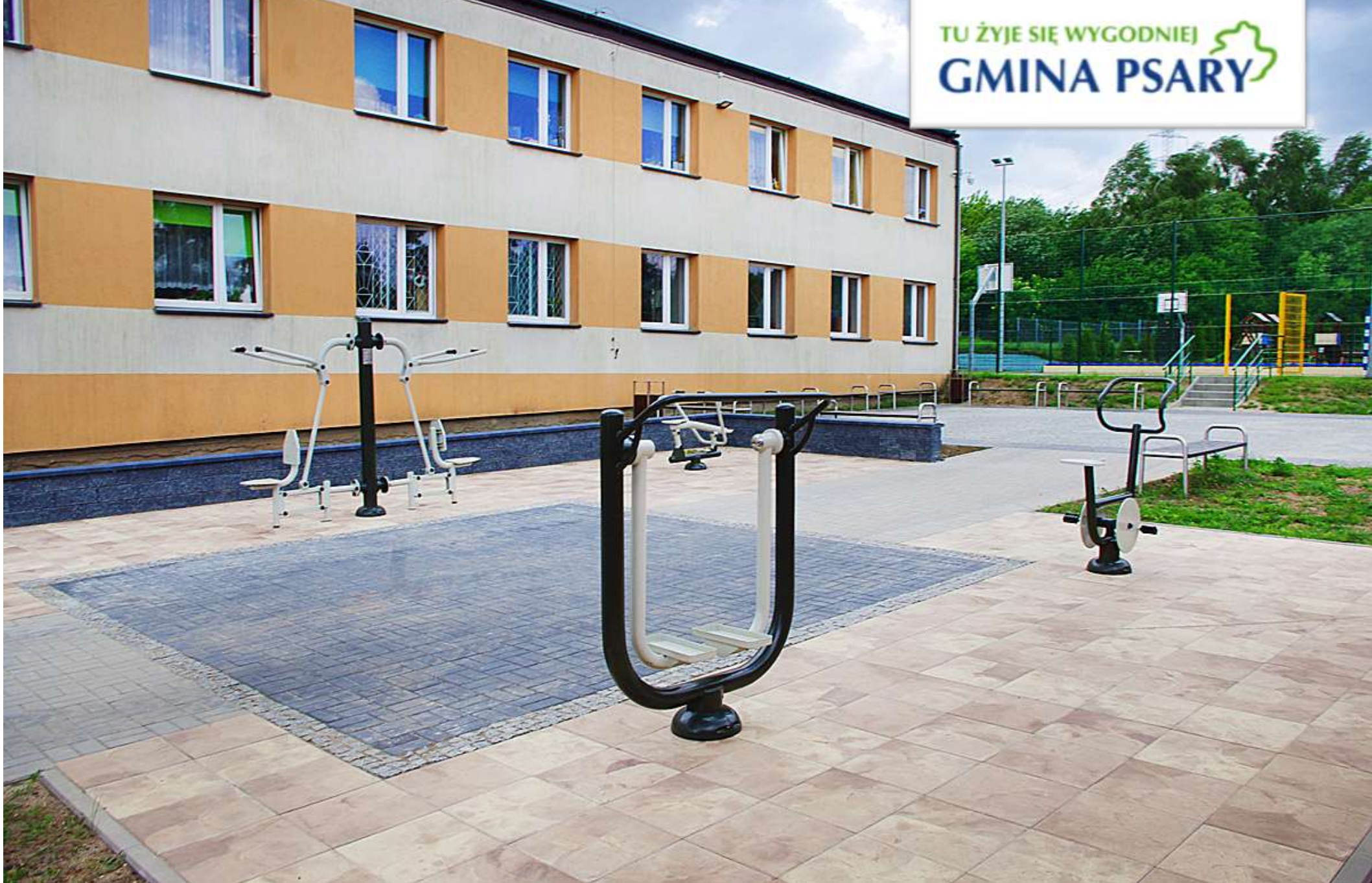
Zagospodarowanie otoczenia przy szkole w Dąbiu.
