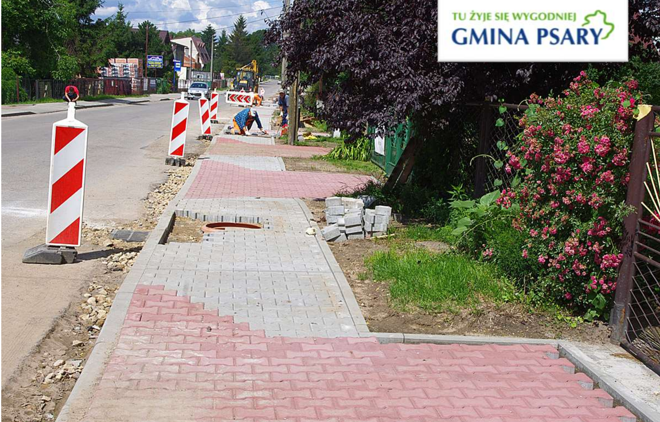
Budowa chodnika przy ulicy Wiejskiej w Psarach
