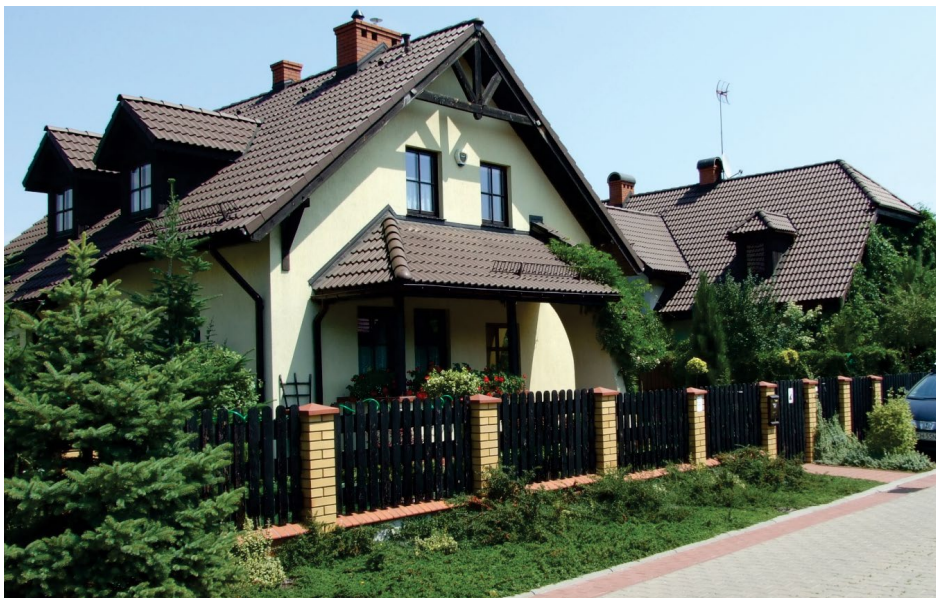
Jeden z domków jednorodzinnych na osiedlu w Malinowicach
