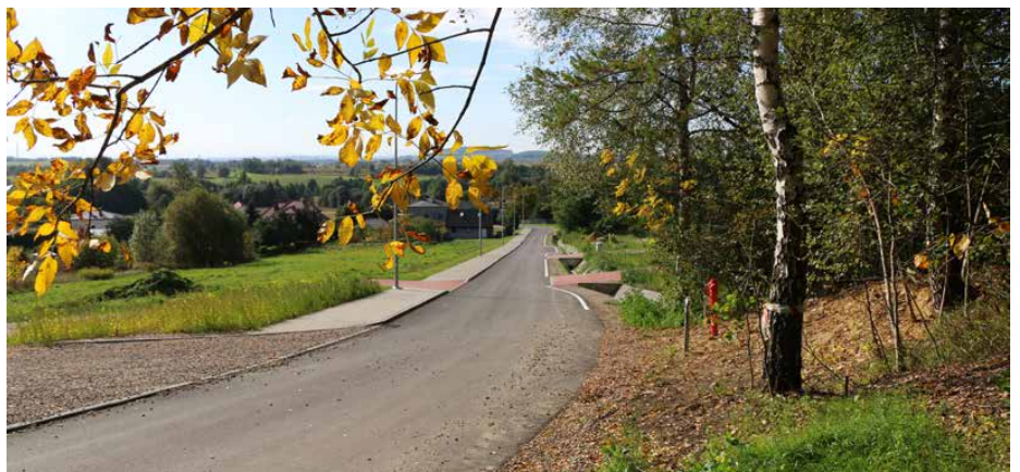
Wyremontowany odcinek drogi Brzękowice Wał
