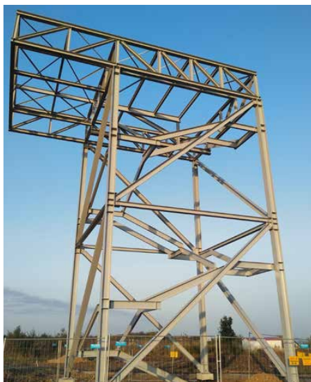
Konstrukcja wieży widokowej w Górze Siewierskiej.
