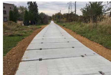
Zbrojone płyty betonowe.
