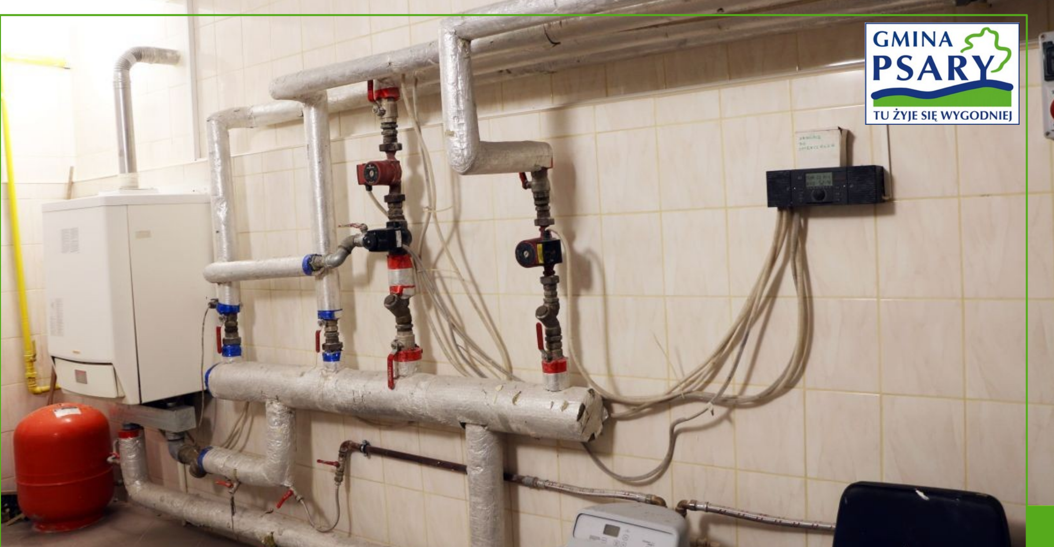
Remont kotłowni w OSP Psary
