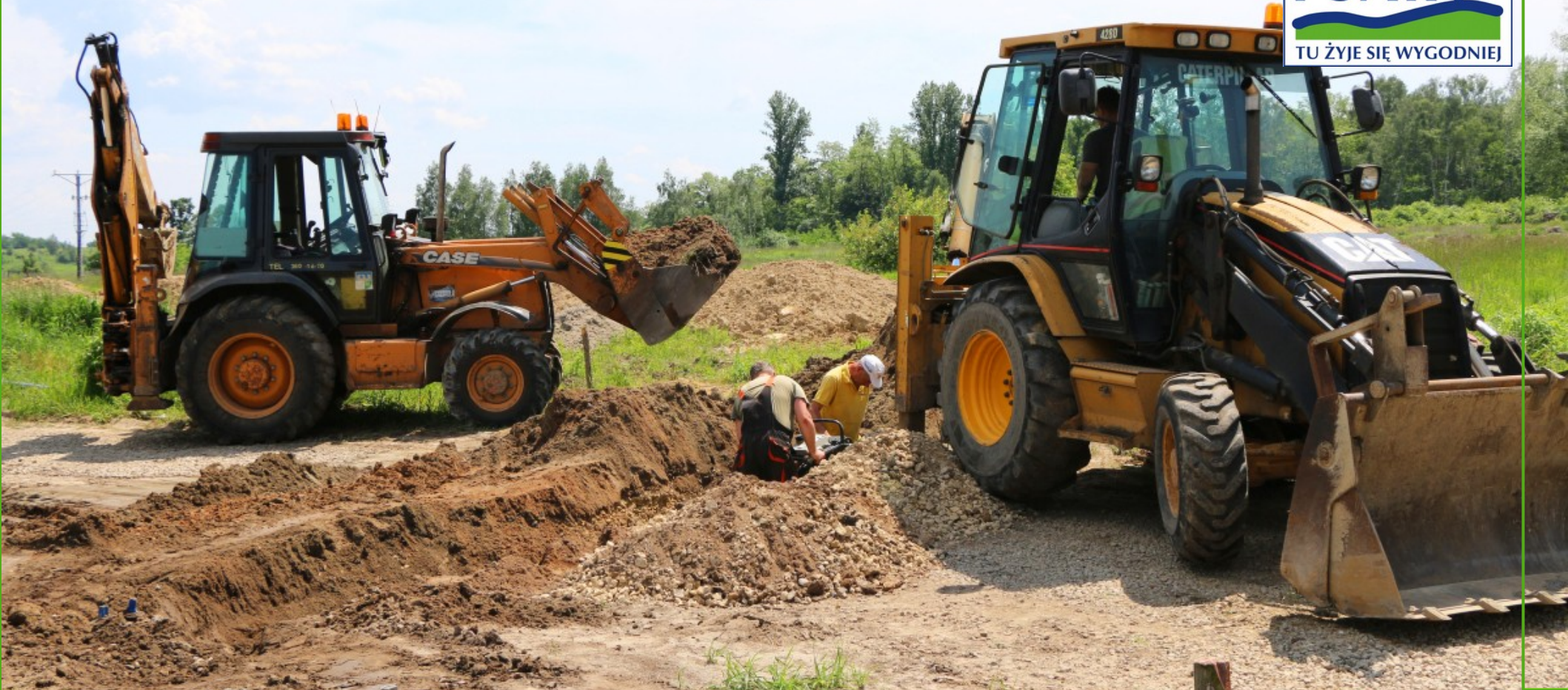
Budowa sieci wodociągowej w Malinowicach
