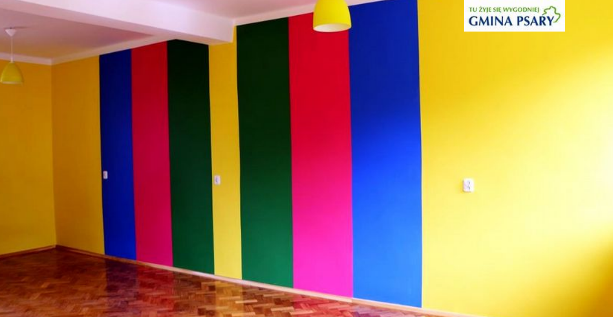
Jedno z pomieszczeń po remoncie
