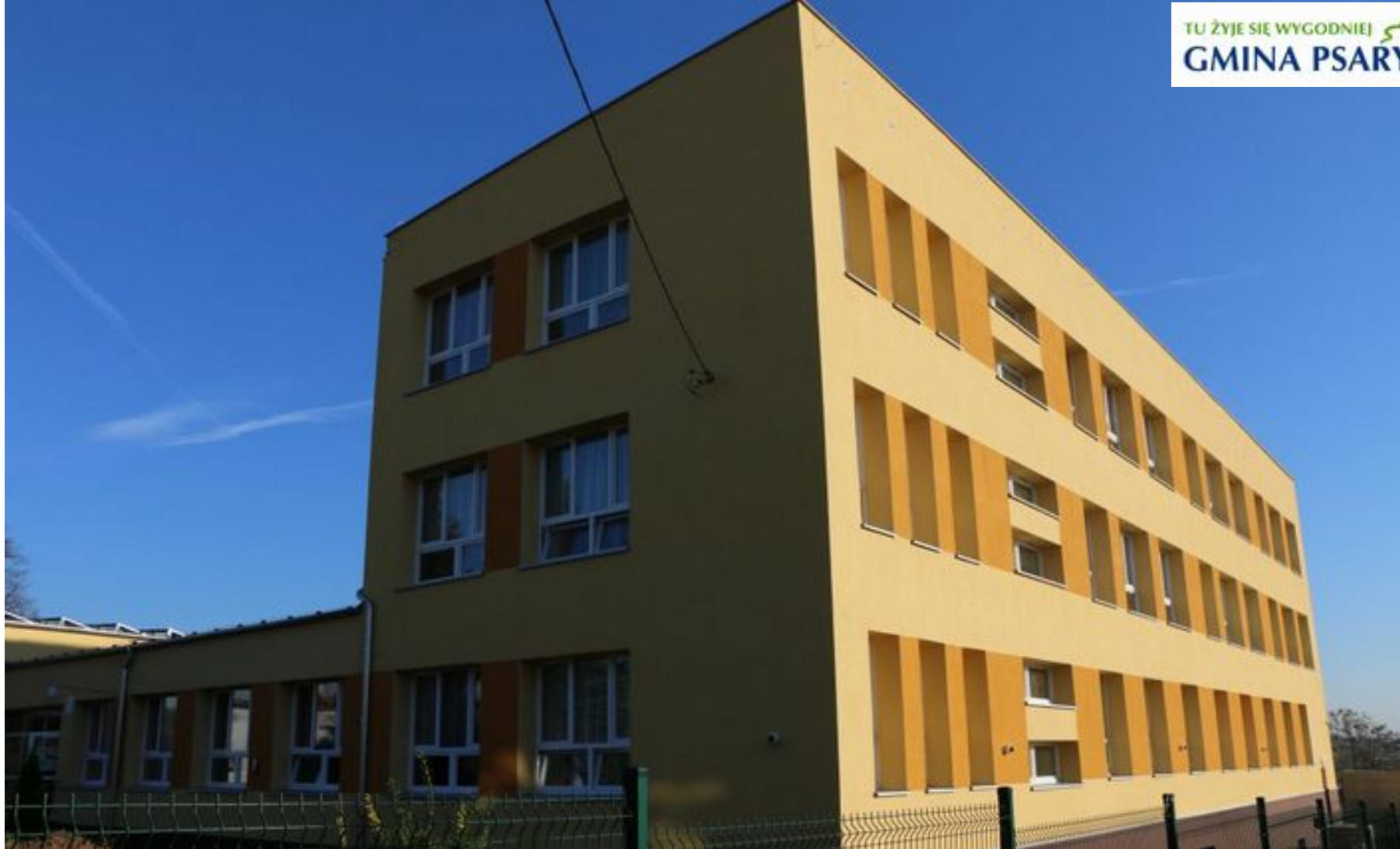
Szkoła po termomodernizacji
