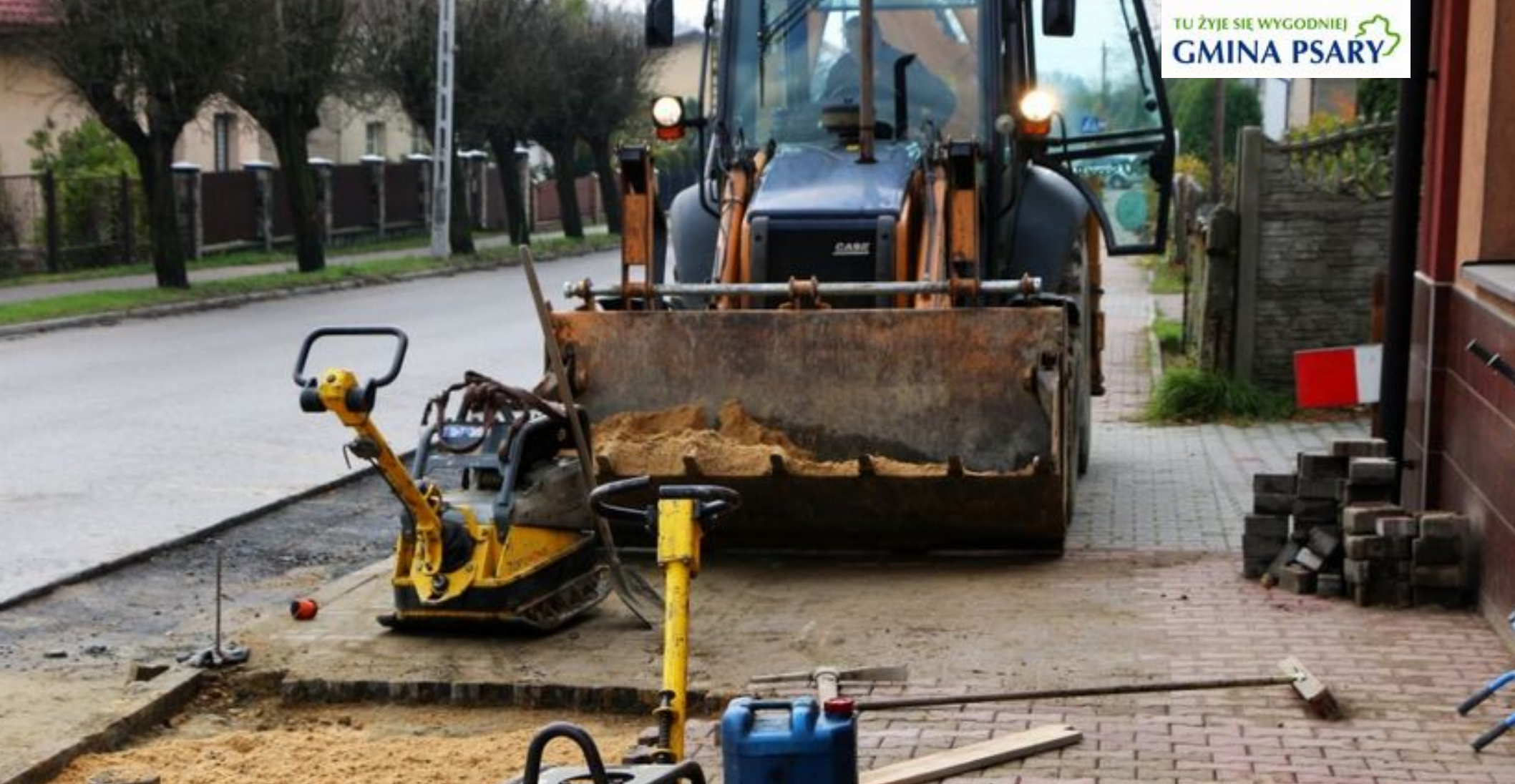
Przebudowa sieci wodociągowej na odcinku ul. Głównej w Sarnowie
