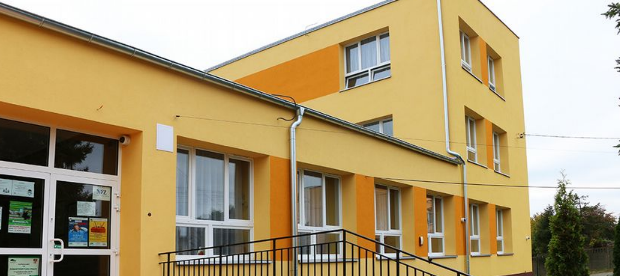
Szkoła po termomodernizacji
