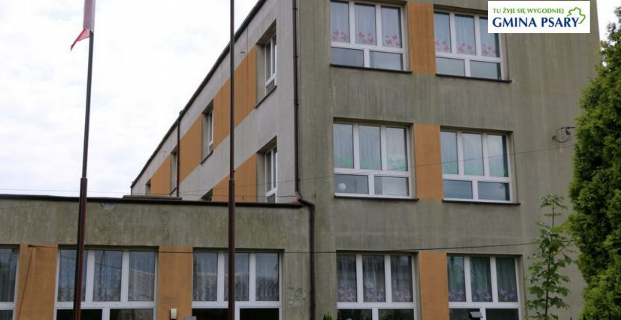
Szkoła przed termomodernizacją
