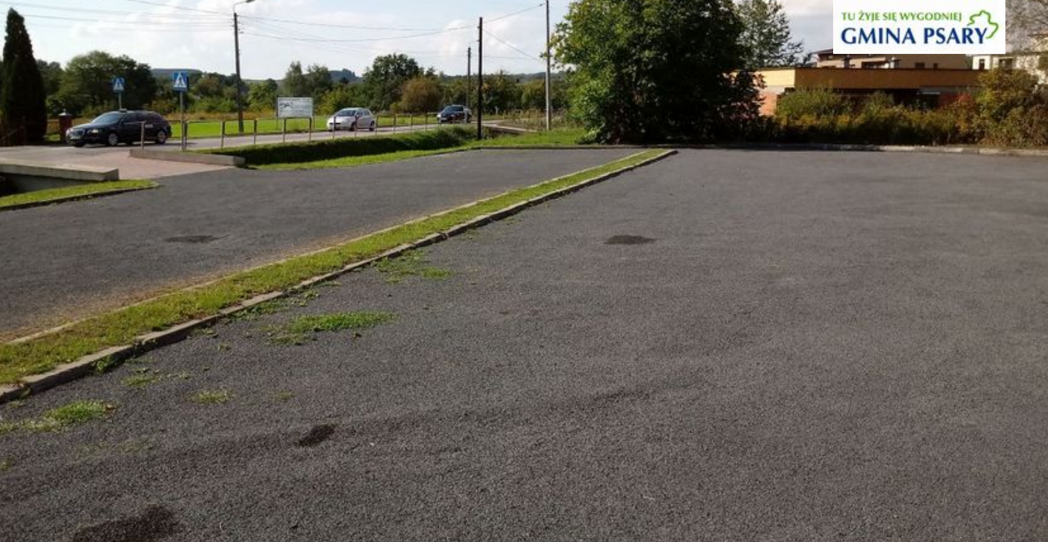
Utwardzony frezem parking na ul. Zwycięstwa w Psarach
