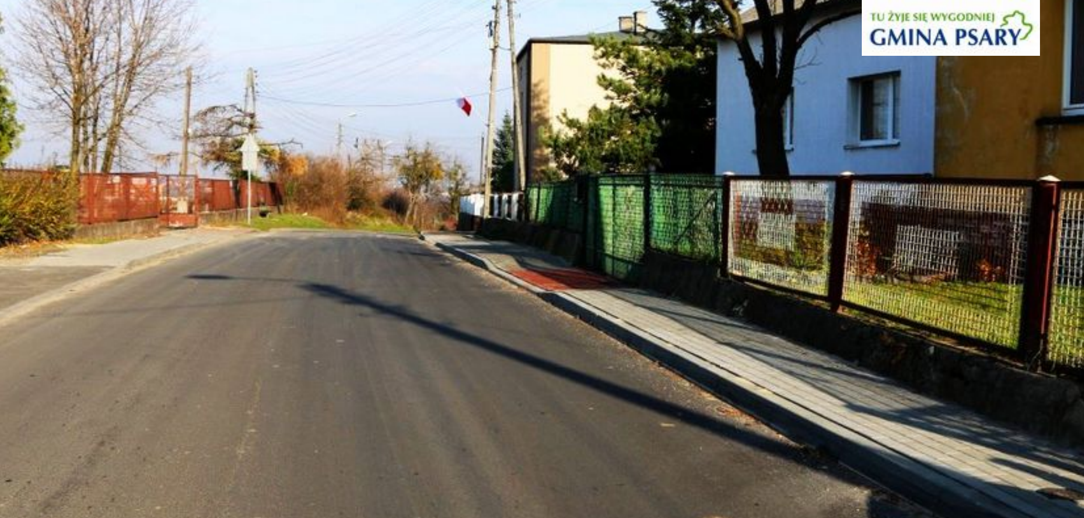
Nowa nawierzchnia wraz z chodnikiem na ul. Szopena w Górze Siewierskiej
