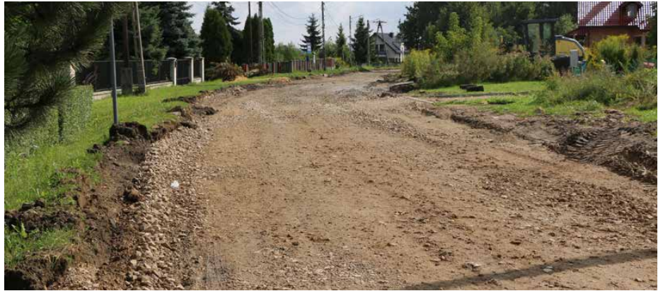
Inwestycja obejmuje przebudowę blisko 410 m jezdni
