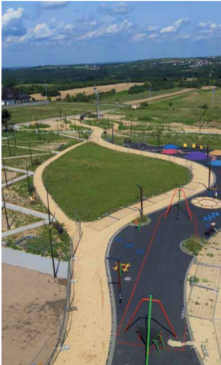
W trakcie II etapu powstają ścieżki edukacyjne
