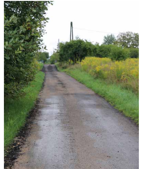
ZGK utwardziło frezem 3 odcinki dróg
