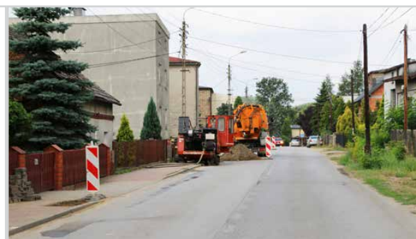
Budowa wodociągu wzdłuż ul. 1 Maja w Strzyżowicach W gminie Psary trwa budowa i wymiana sieci wodociągowej z przyłączami.
