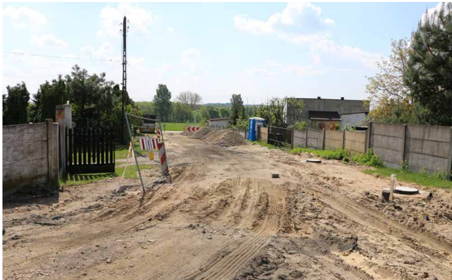
W kwietniu ruszyła przebudowa drogi Brzękowiec Wał
