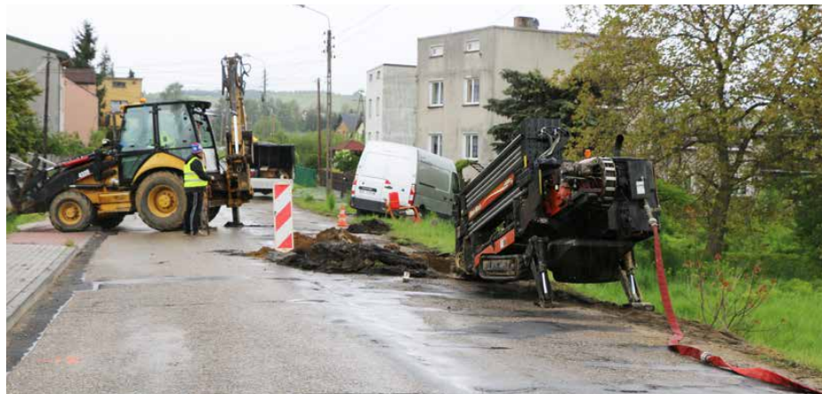
Ruszyła przebudowa sieci wodociągowej na ul. 1 Maja w Strzyżowicach
