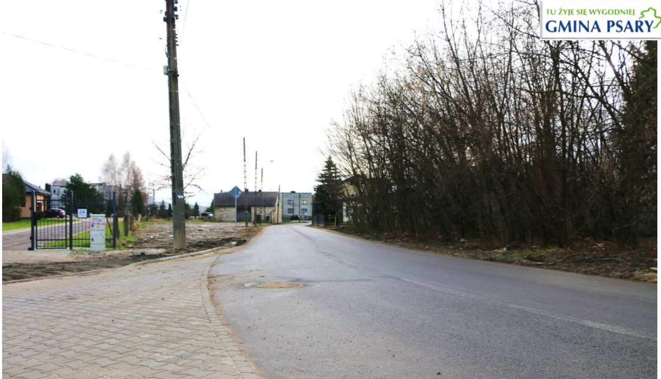
Skrzyżowanie ul. Podwale i ul. Rogoźnickiej po przebudowie.
