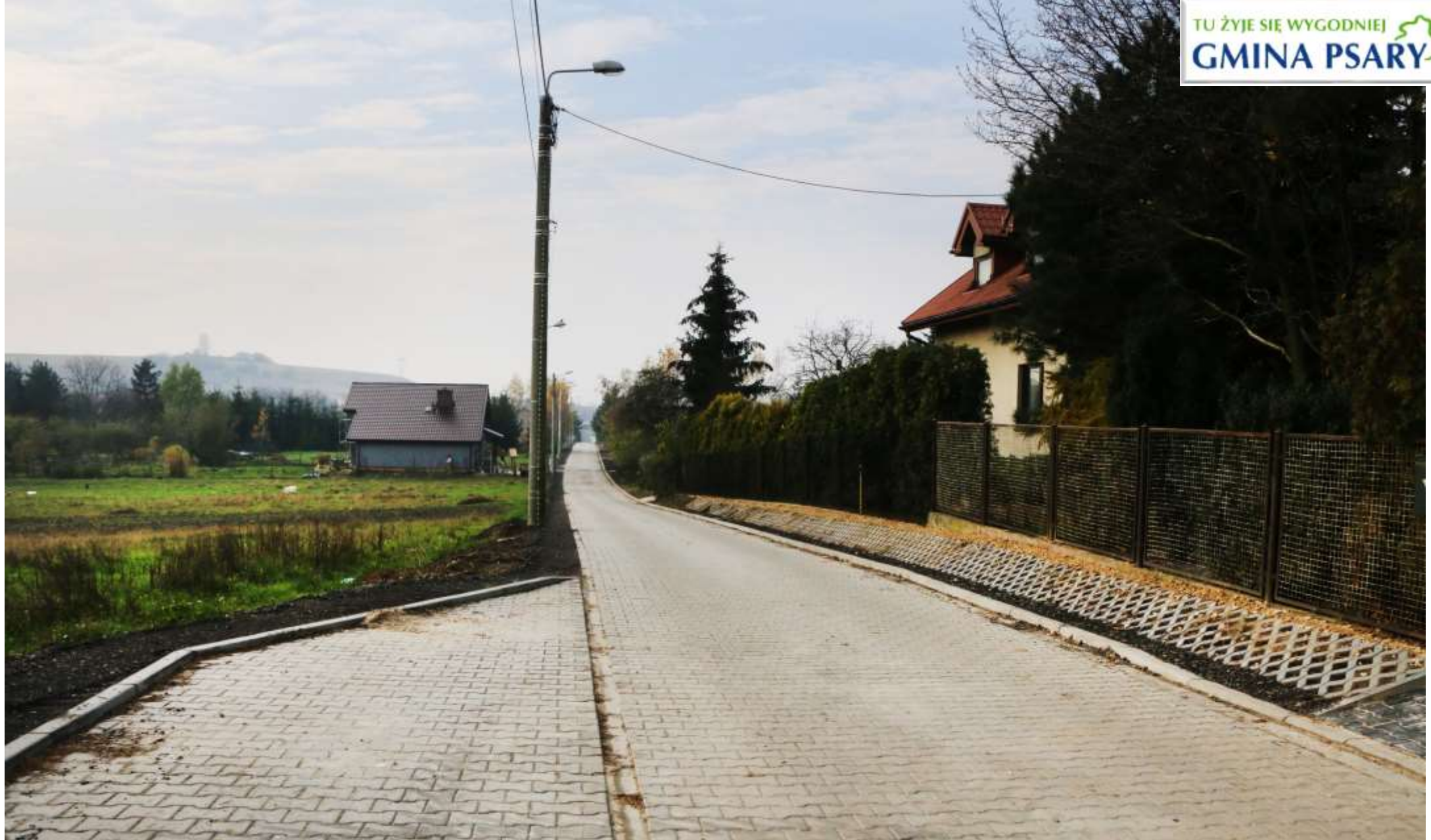
Ulica Wspólna po przebudowie.
