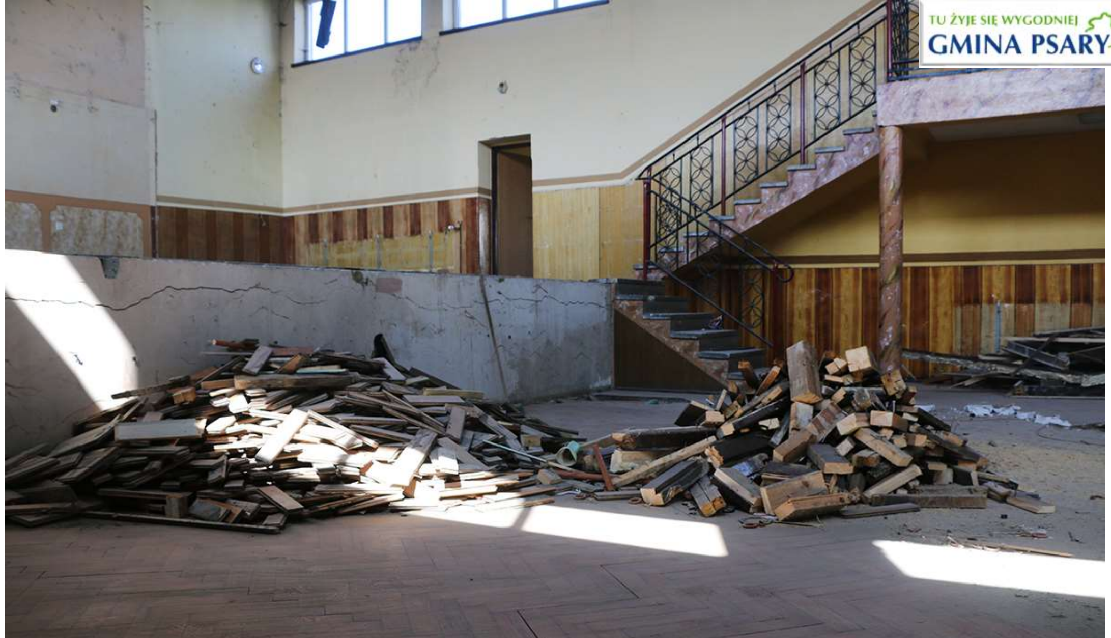
Remont przechodzi scena. Powstanie także nowa posadzka na głównej sali.
