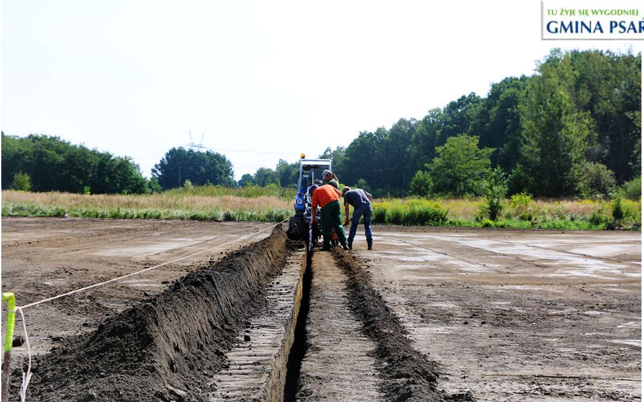
Prace na płycie boiska.
