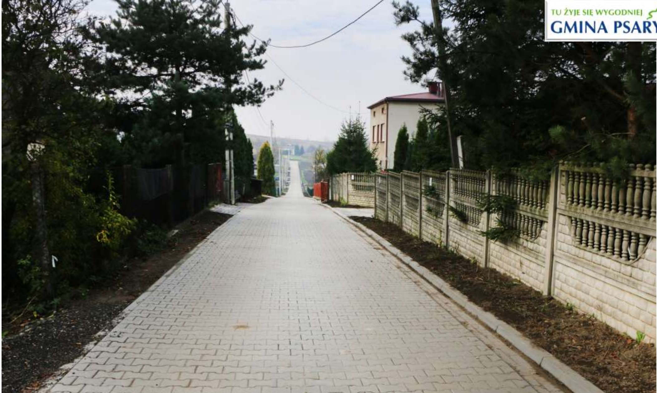
Ulica Wspólna po przebudowie.
