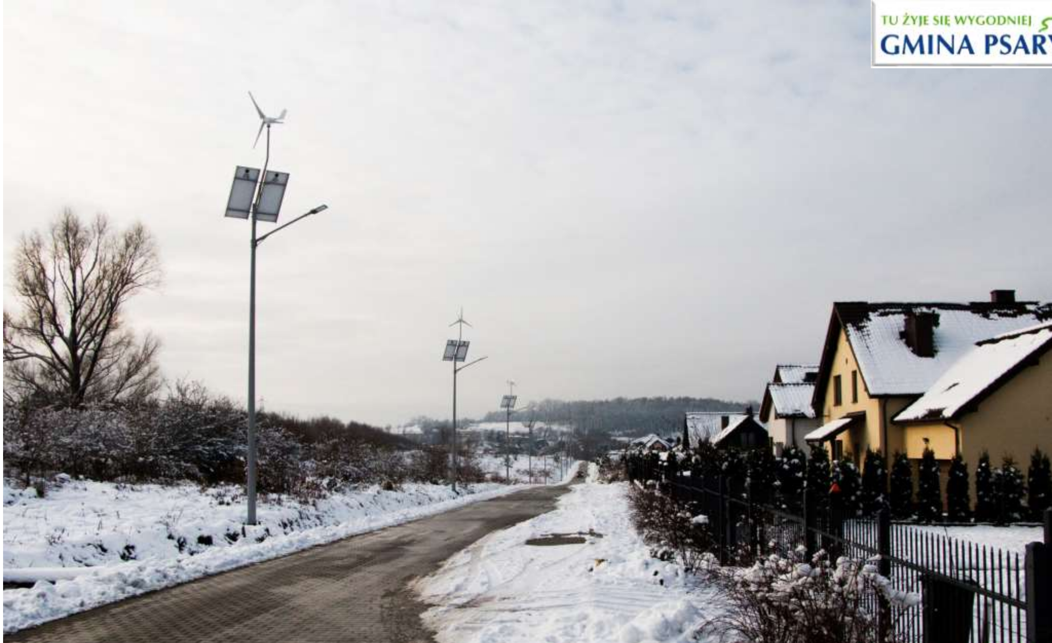
Oświetlenie hybrydowe na ul. Irysów w Psarach.
