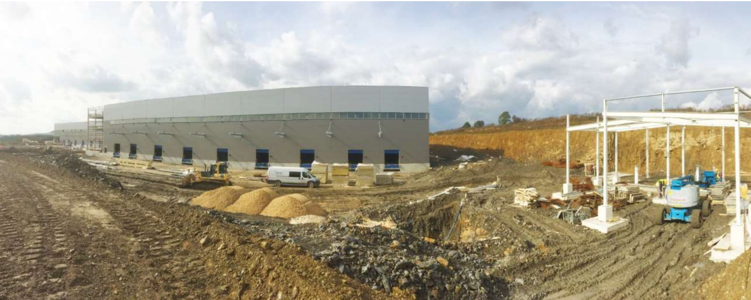
Budowa centrum logistycznego FM Logistic w Sarnowie.
