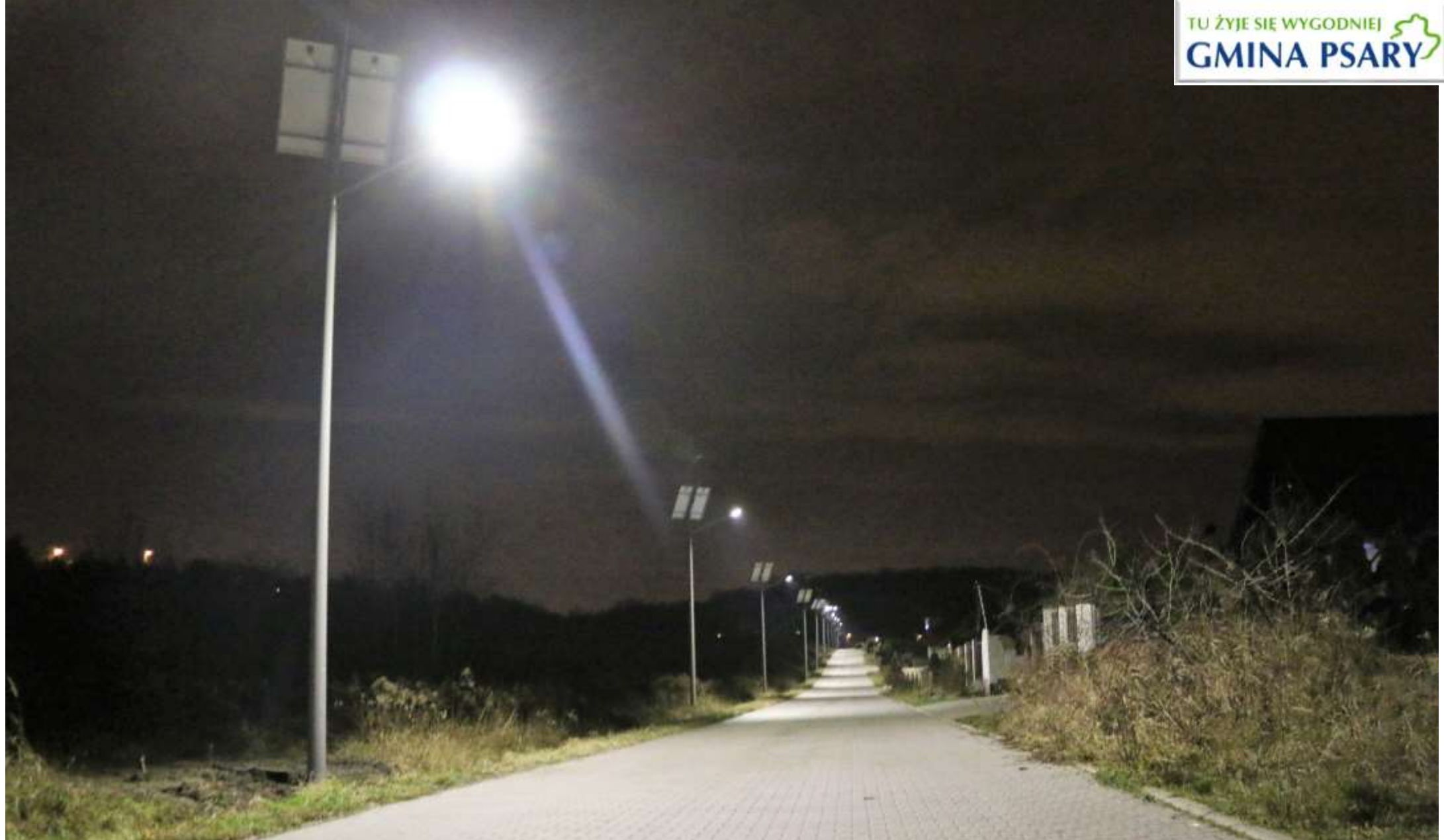
Oświetlenie hybrydowe na ul. Irysów w Psarach.
