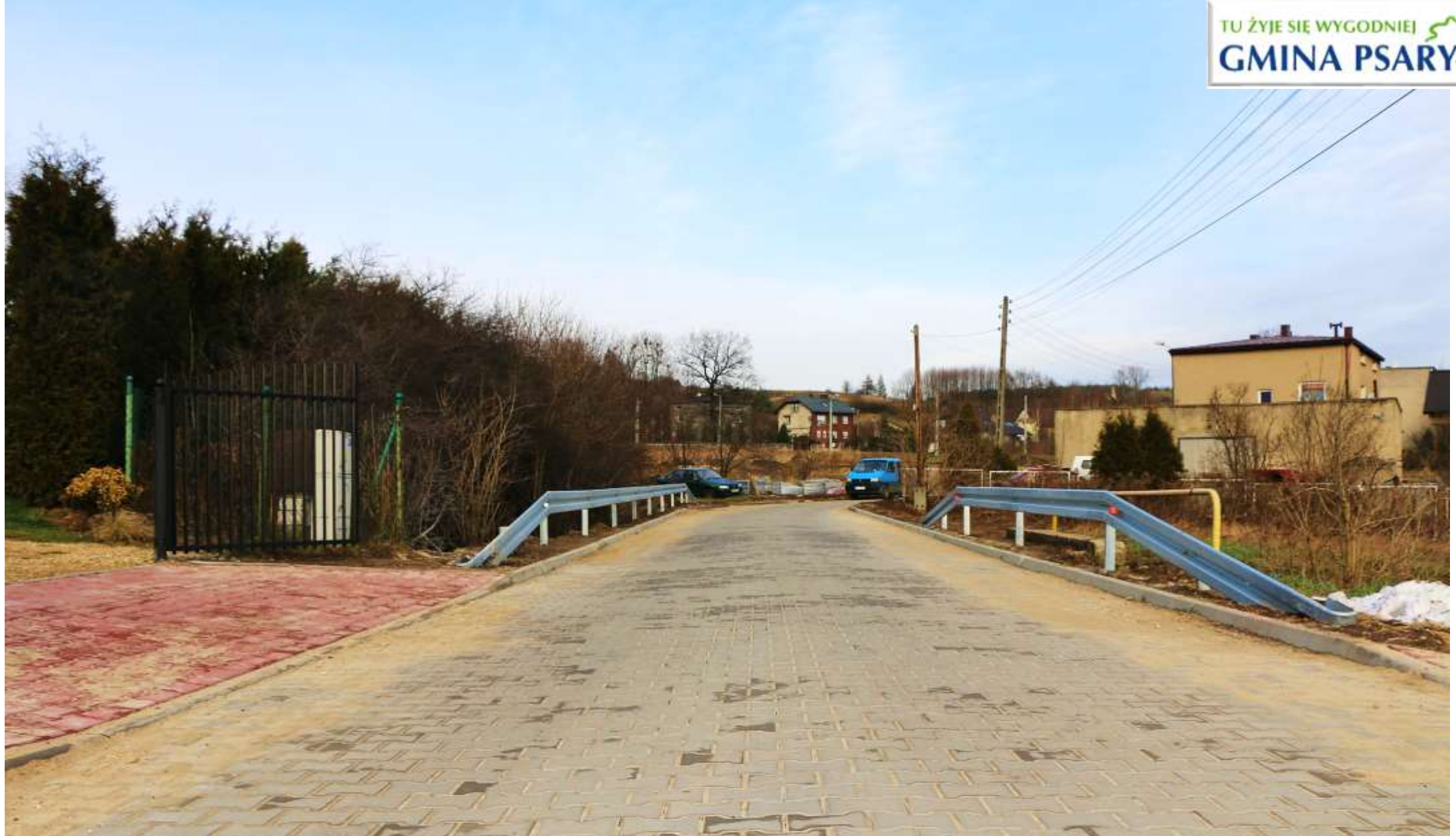
Ulica Podwale po przebudowie.
