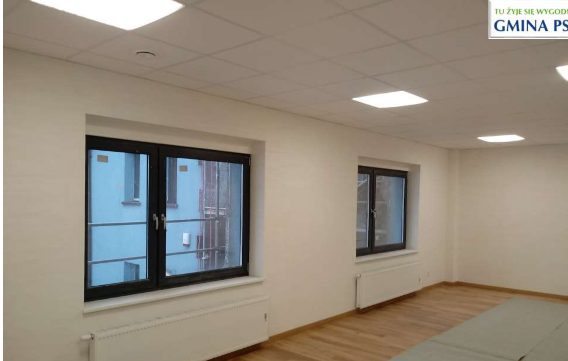
Wyremontowane pomieszczenia na I piętrze.
