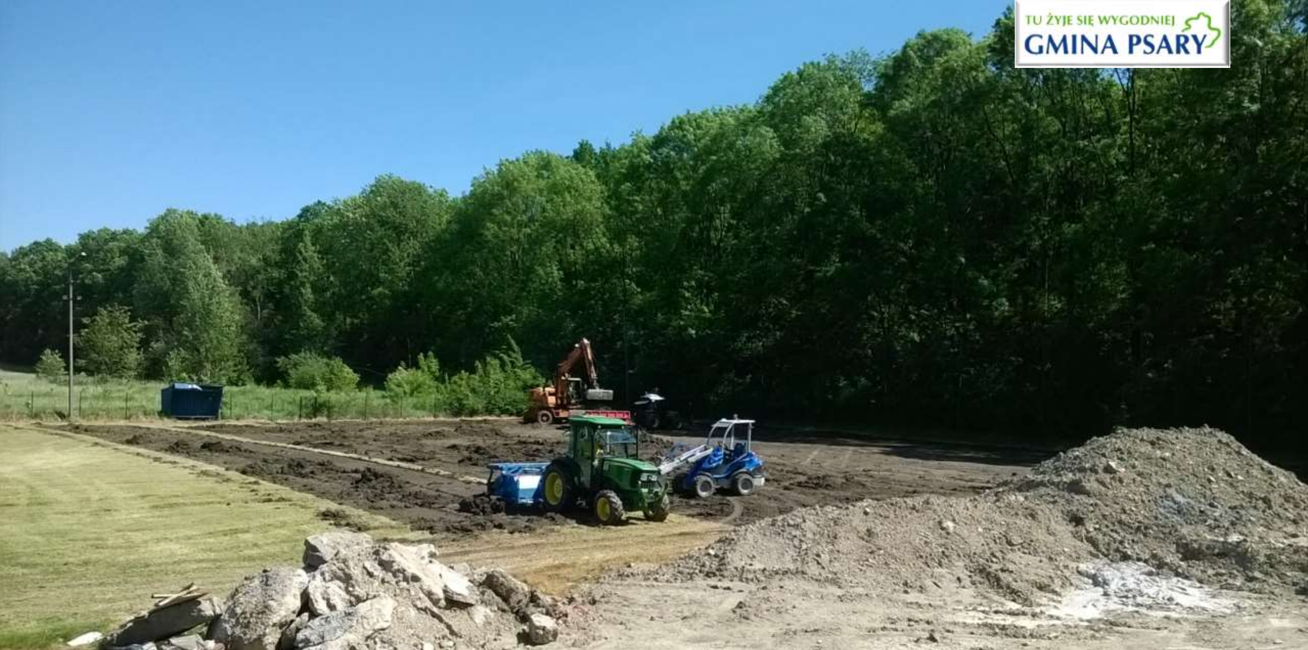
Prace przy budowie drenażu.
