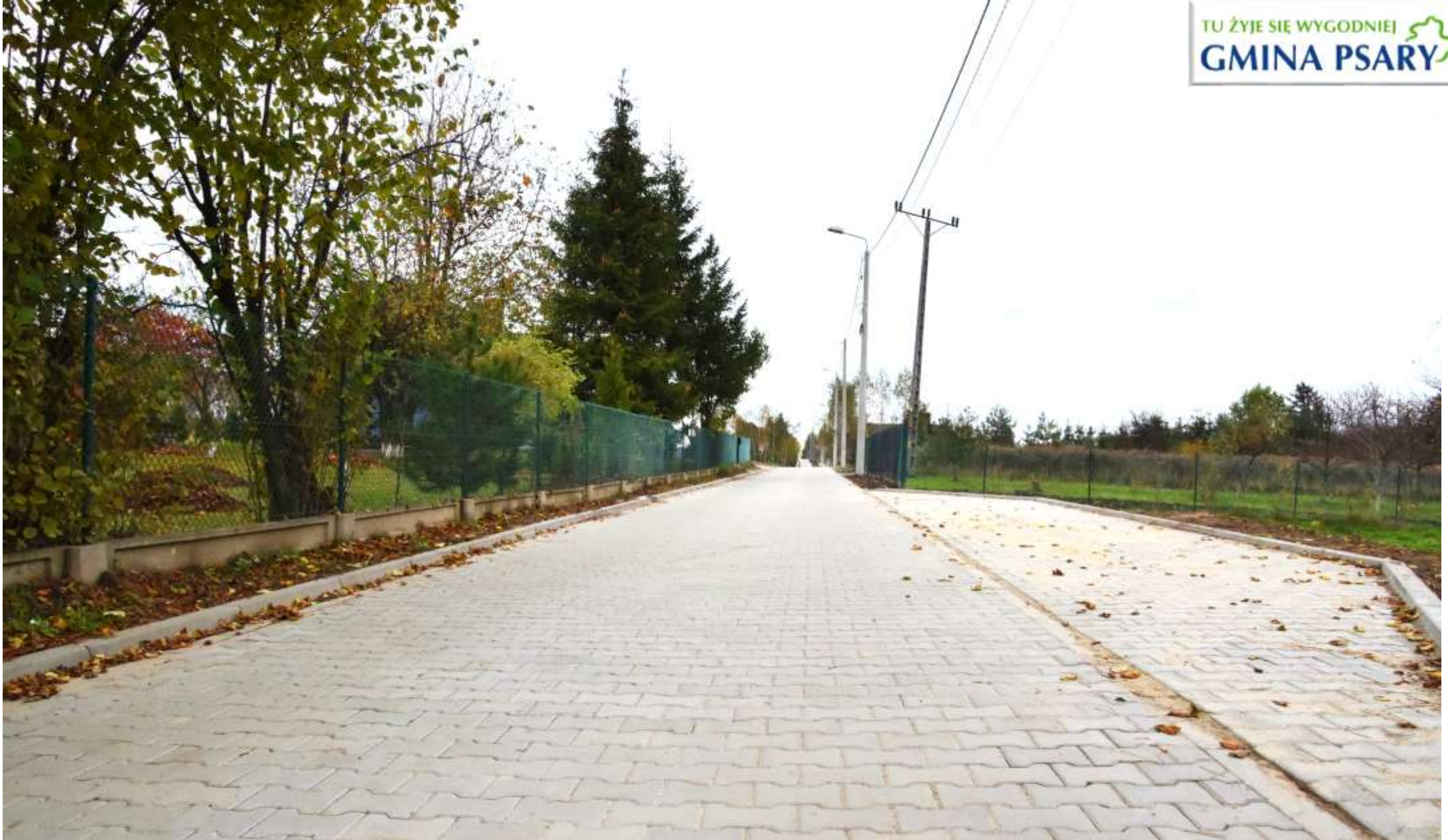
Ulica Wspólna po przebudowie.
