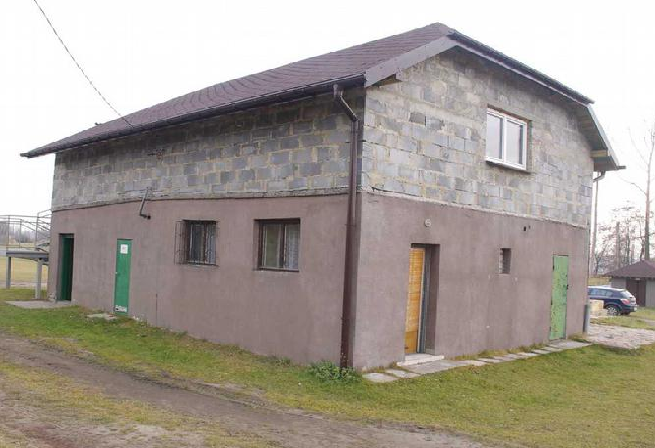
Budynek przed remontem i wykonaniem nowej elewacji szatni.
