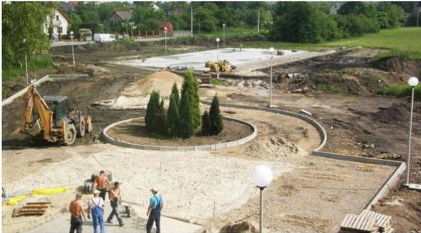
Budowa kolejnego kompleksu sportowego w Psarach, foto: materiały promocyjne/UG Psary
