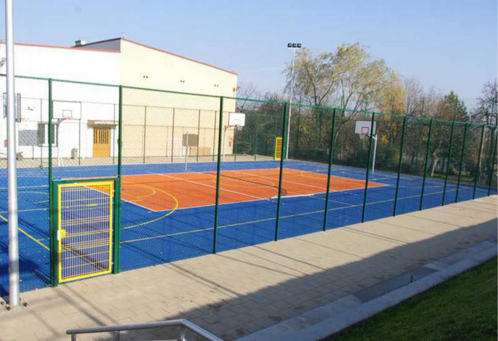
Poliuretanowe boisko do siatkówki i koszykówki wybudowane w ramach „Orlika”.
