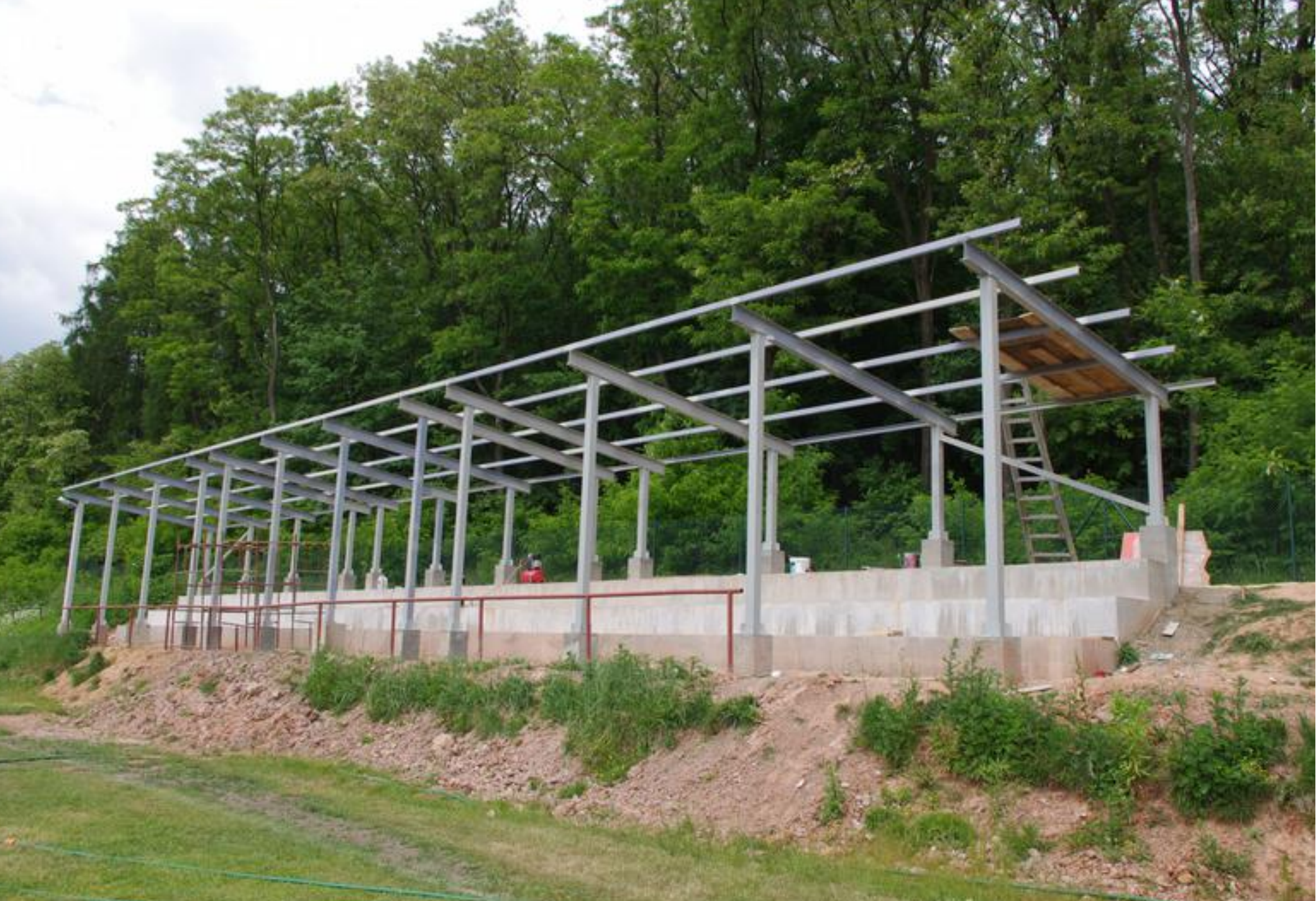
W trakcie budowy zadaszonej trybuny stadionu w Brzękovicach Dolnych.
