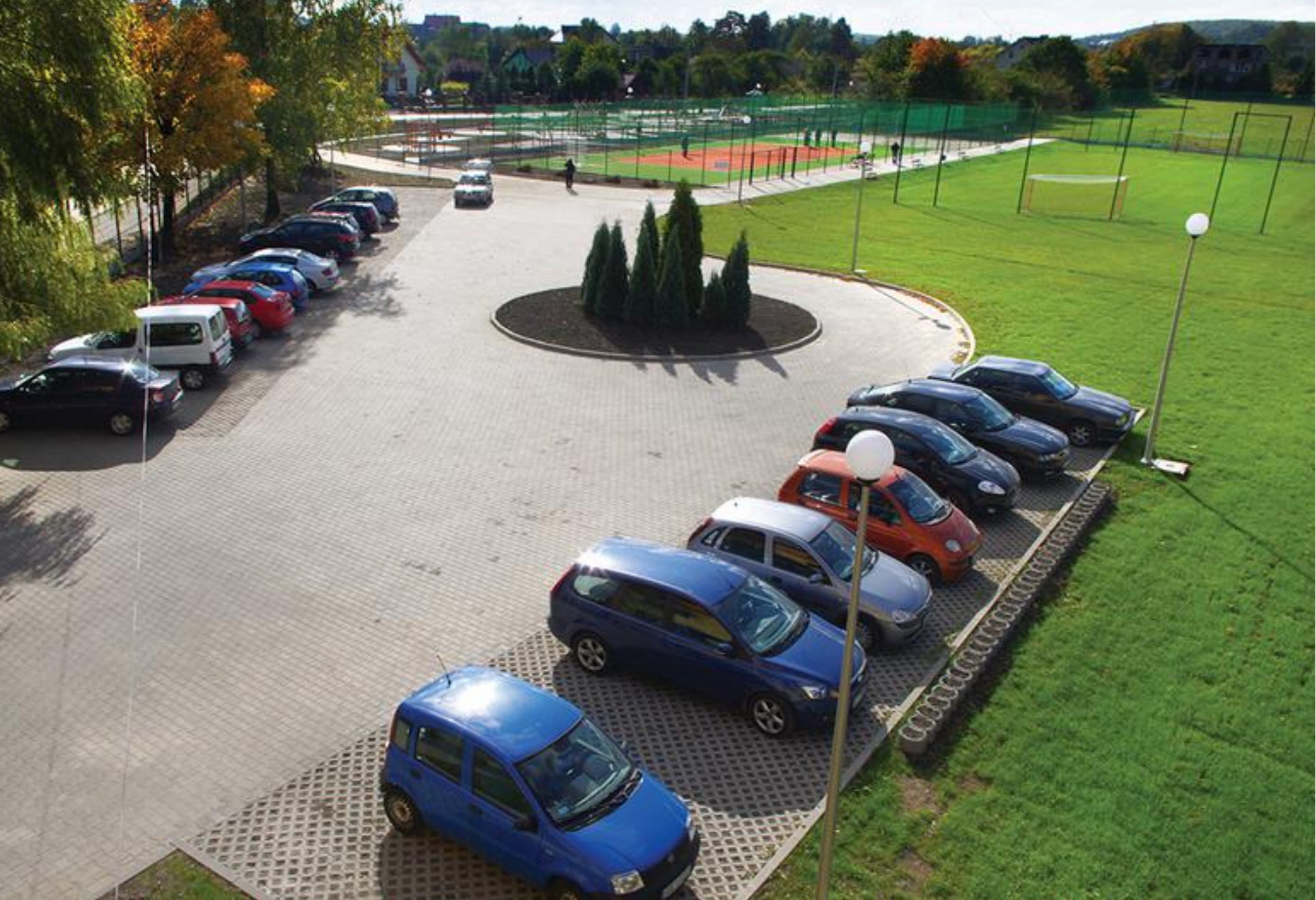
Widok na nowy parking oraz zespół boisk po zakończeniu prac.
