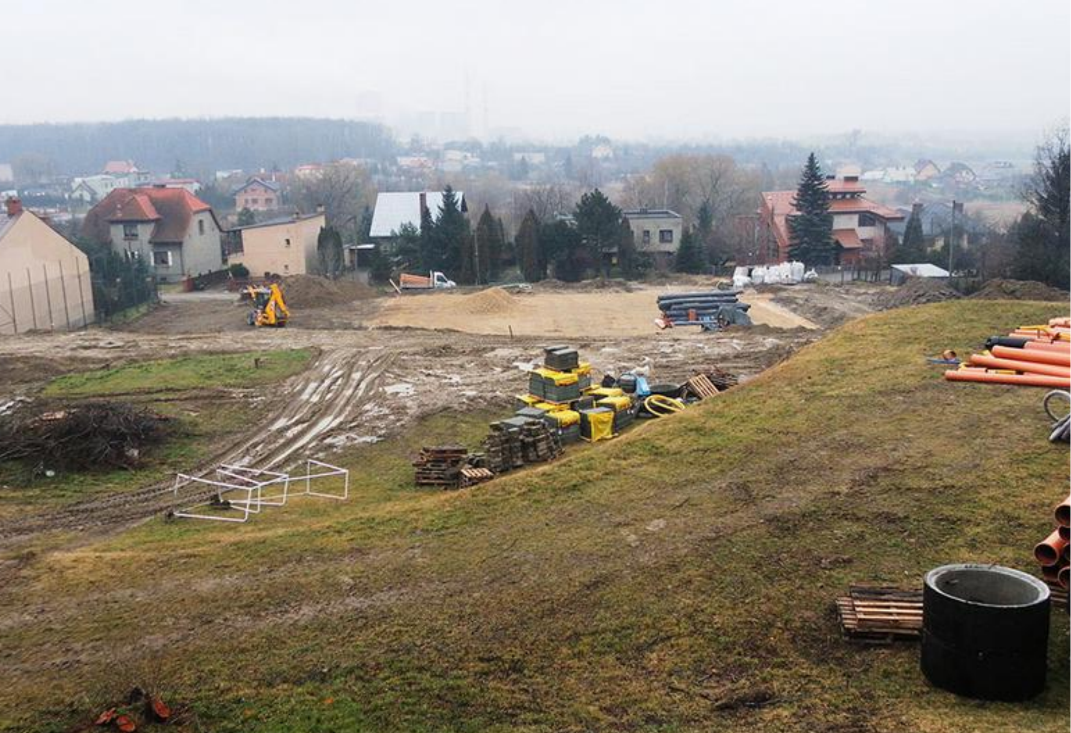
W trakcie prac przy szkole w Sarnowie.
