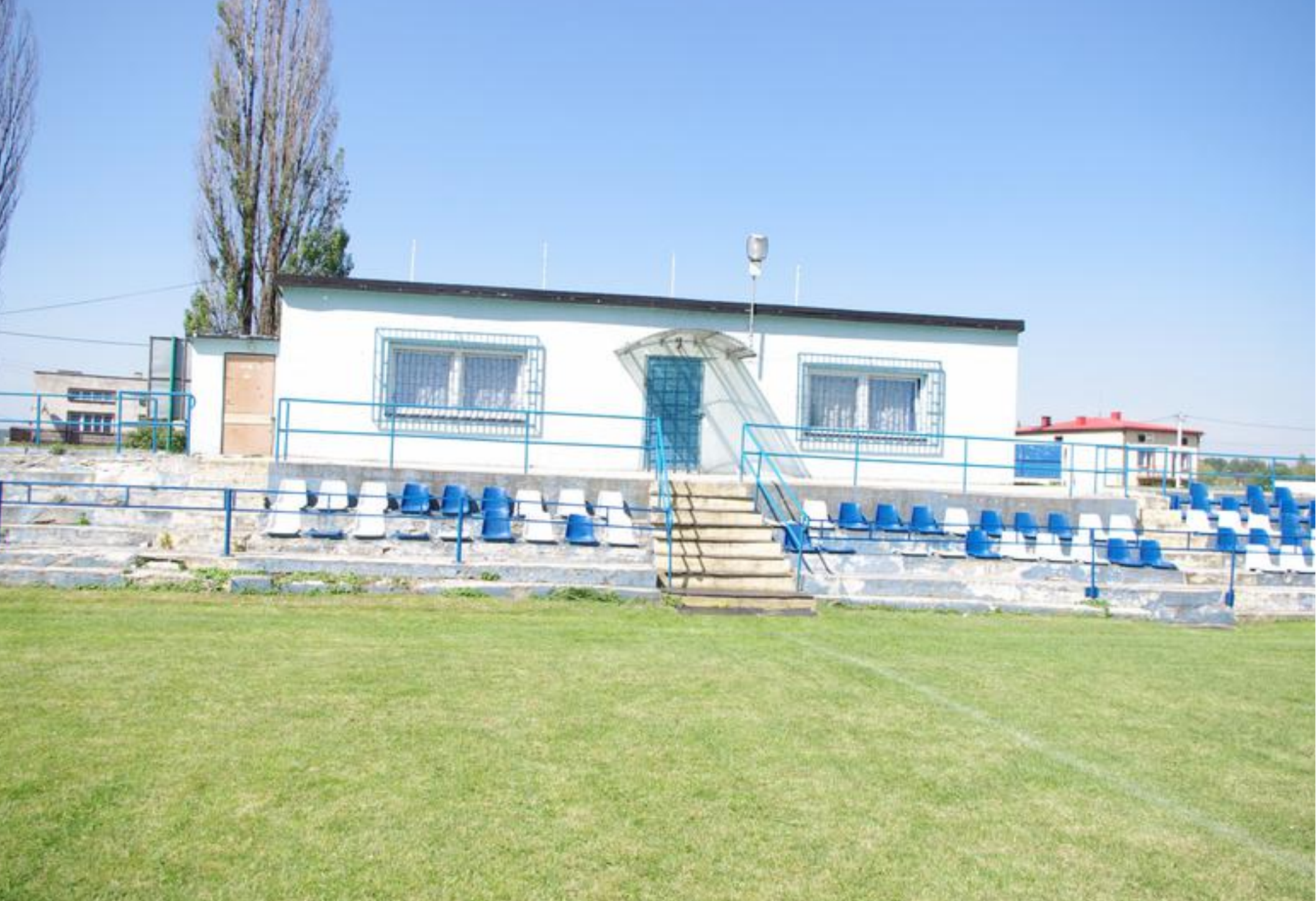
Szatnia piłkarska wraz z trybuną w Sarnowie przeznaczone do wyburzenia.
