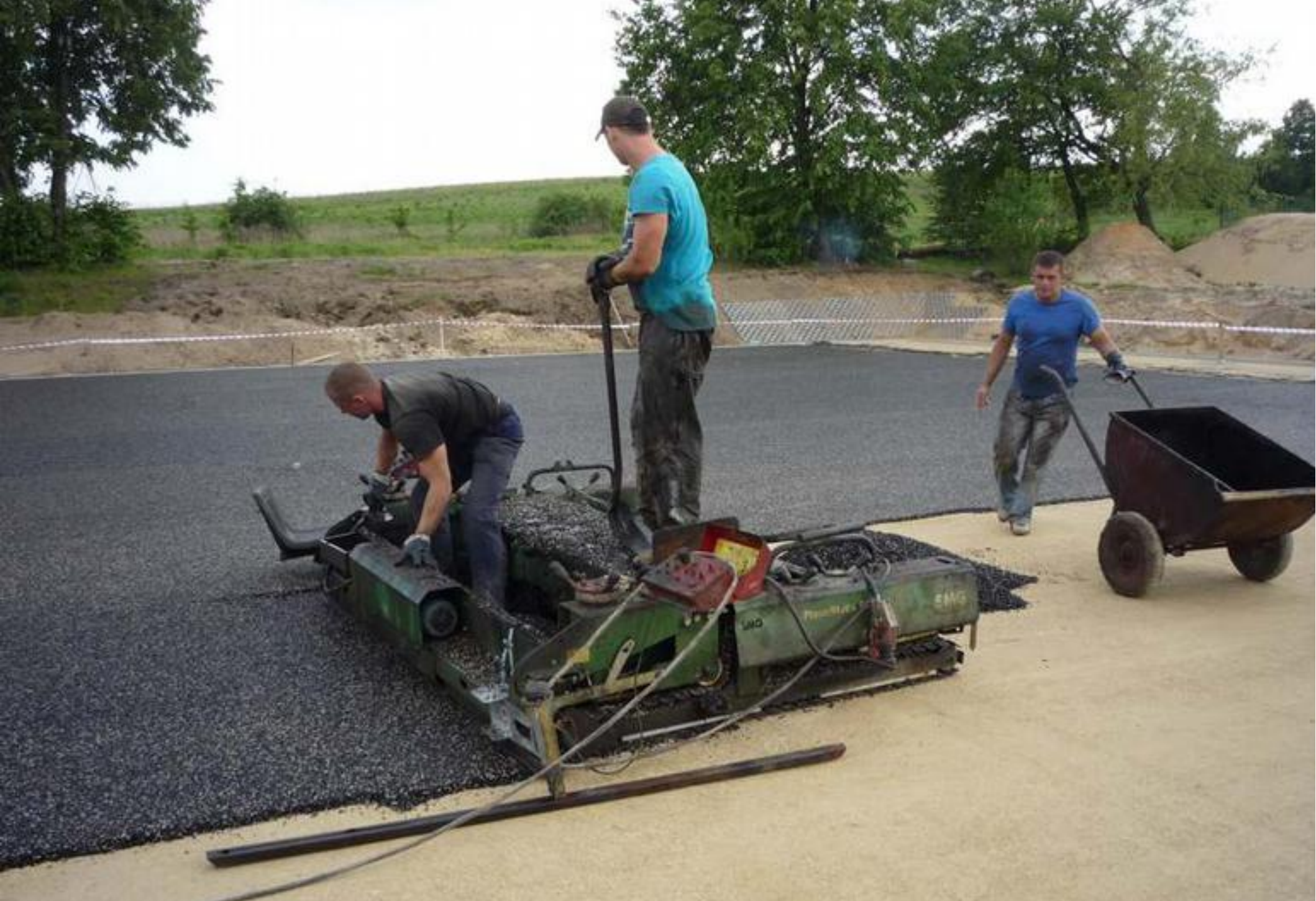
Prace przy budowie boiska wielofunkcyjnego w Malinowicach.
