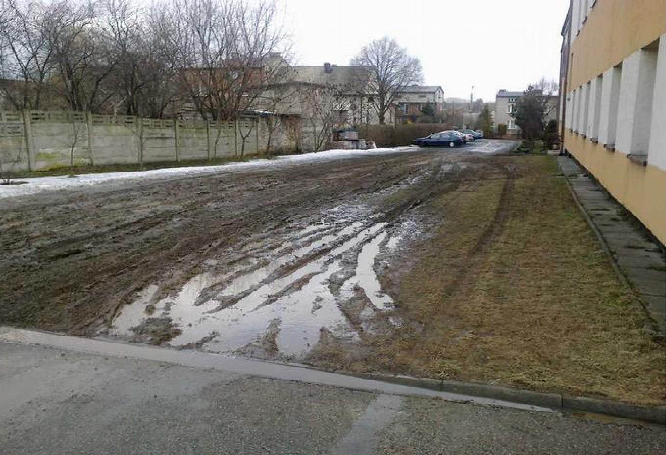
Miejsca postojowe przed budową kompleksu boisk.
