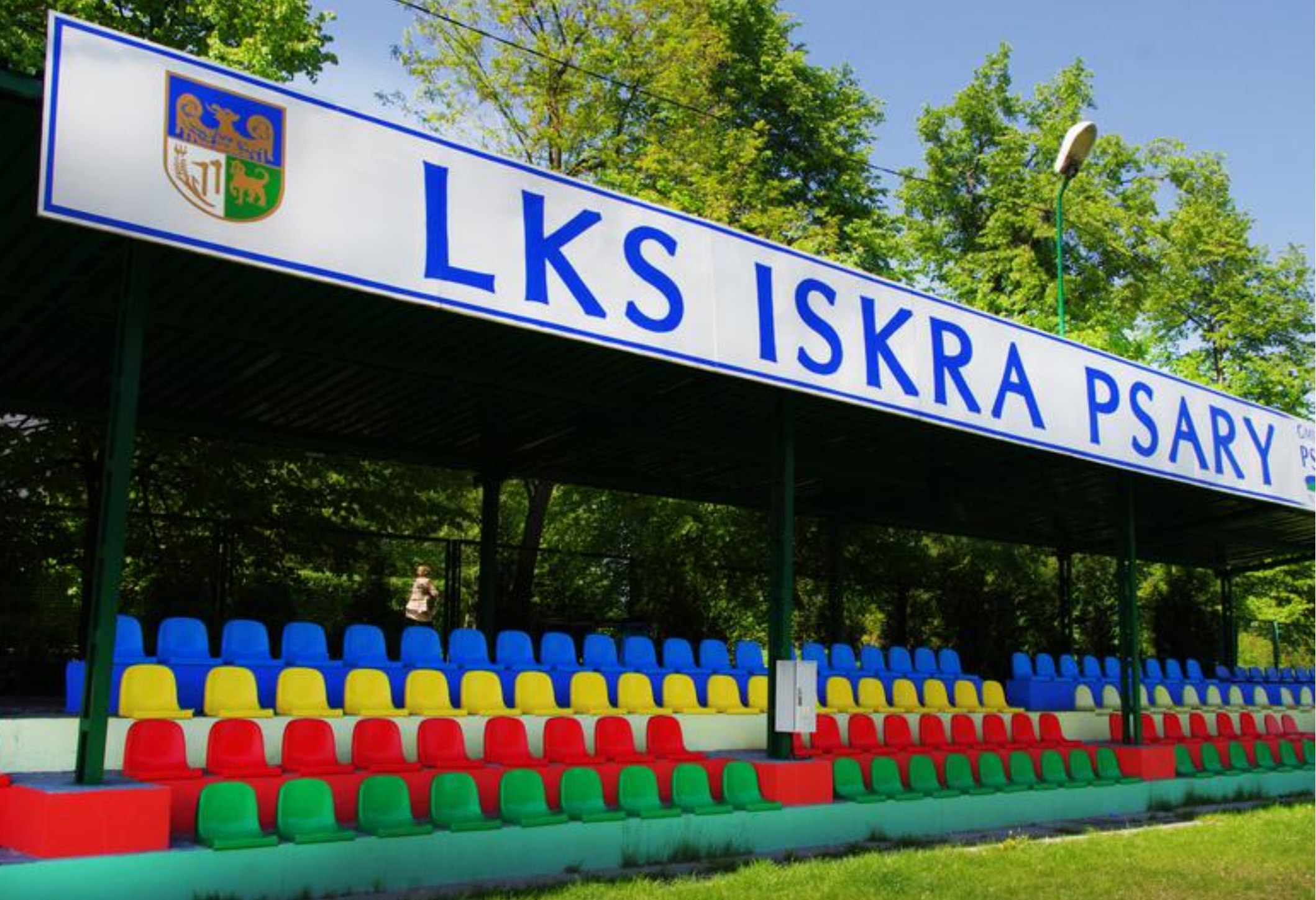
Trybuna stadionu w Psarach po remoncie.
