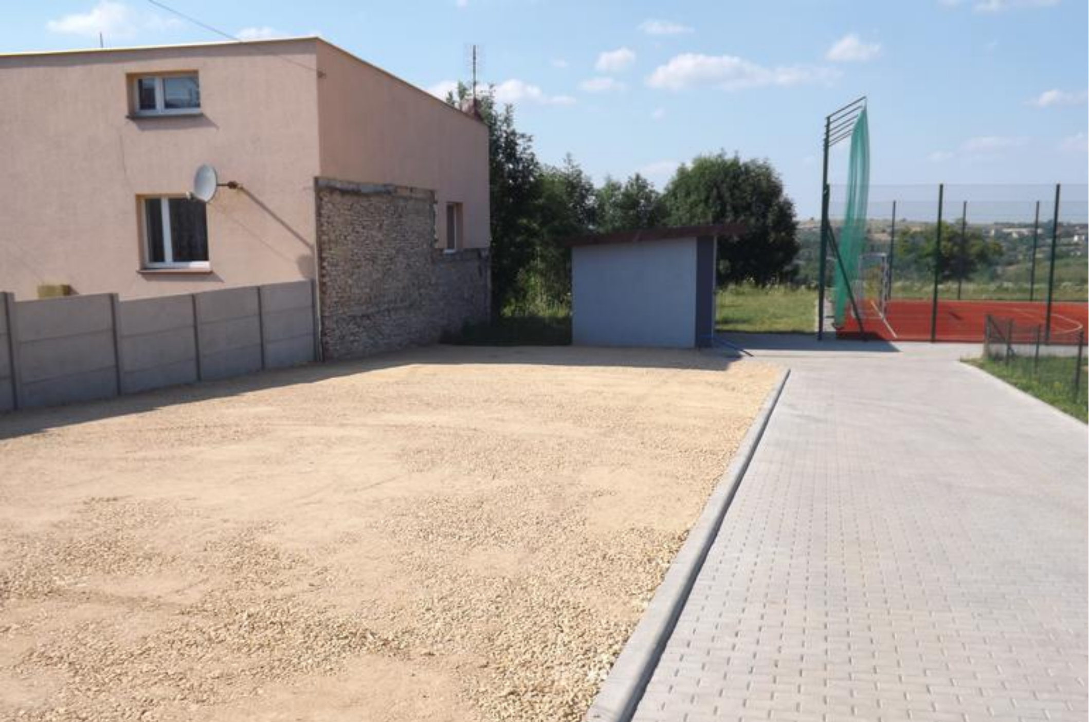
Nowa droga dojazdowa do boiska i budynku magazynowego wraz z parkingiem z kruszywa w Górze Siewierskiej
