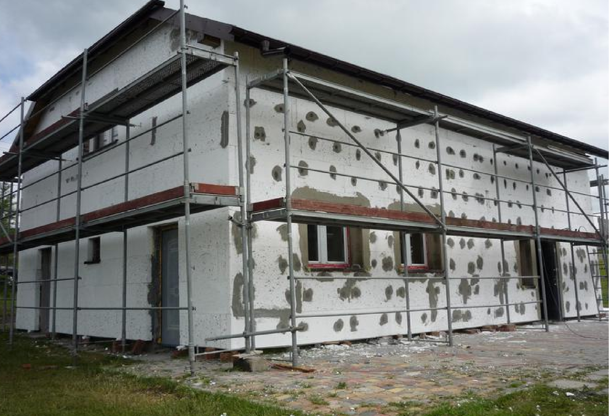
W trakcie prac budowlanych na budynku w Strzyżowicach.
