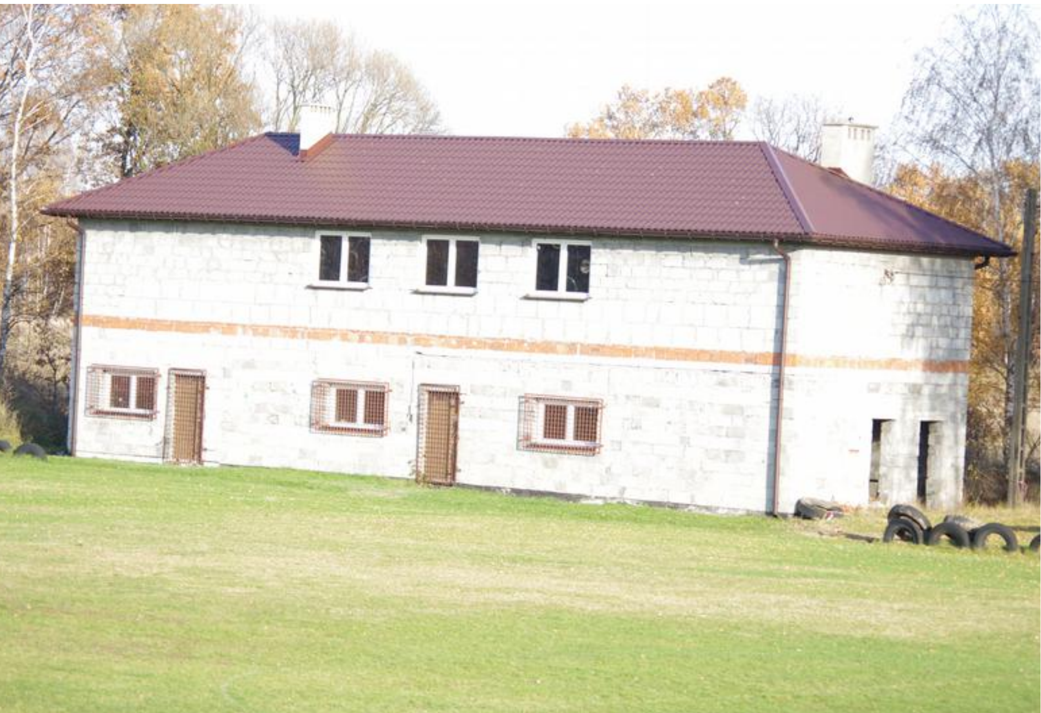
Budynek szatni sportowej w Preczowie przed pracami wykończeniowymi.
