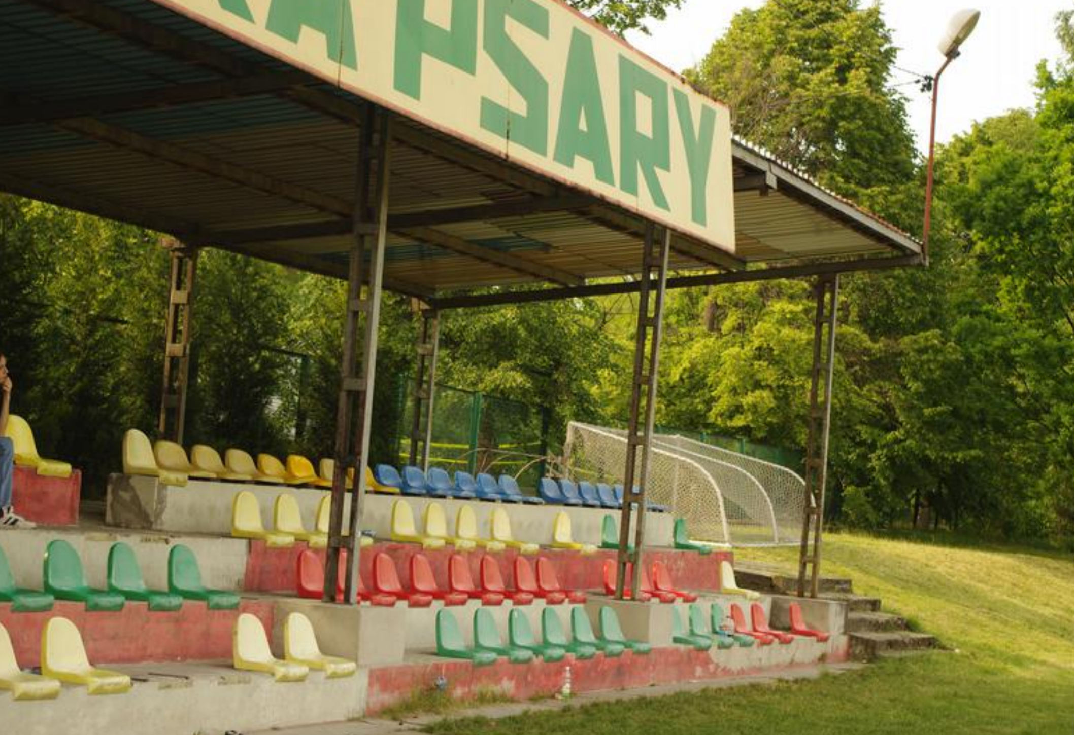
Trybuna LKS Iskra Psary przed wykonaniem prac remontowych.
