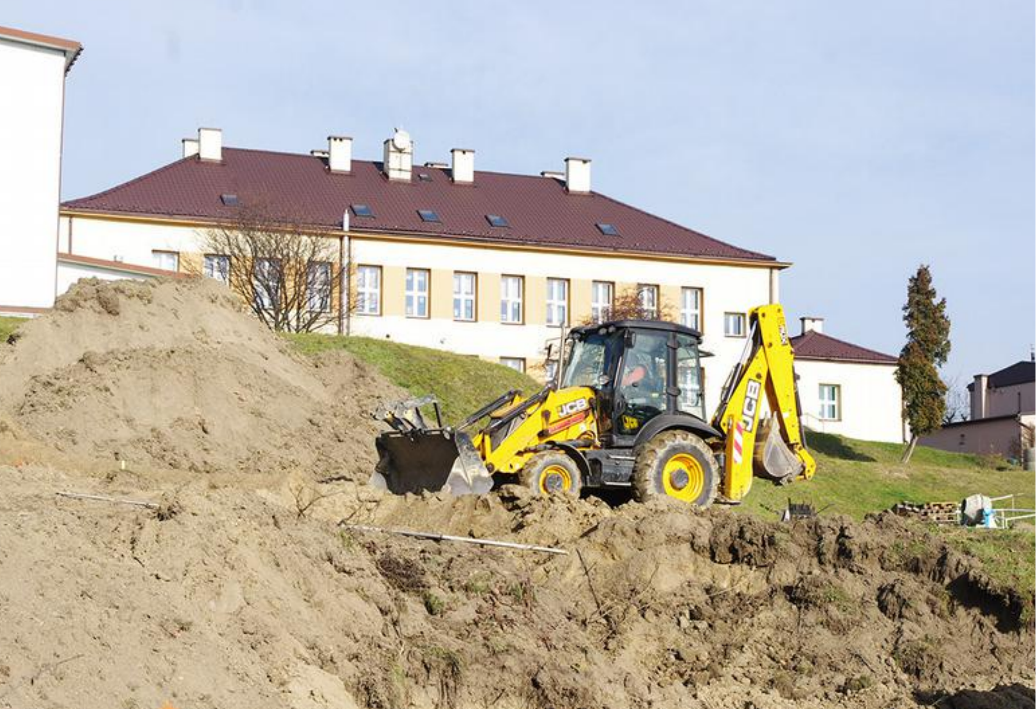
Początek prac przy szkole w Sarnowie, październik 2013 r.
