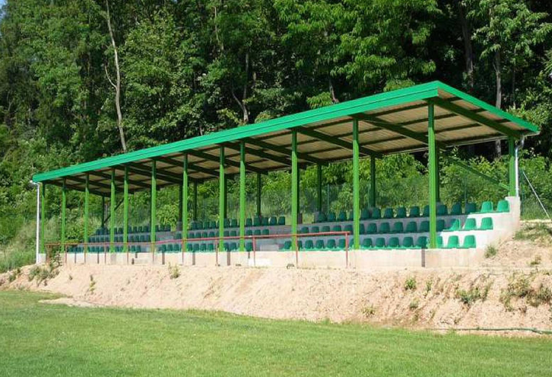
Wykonana zadaszona trybuna w Brzękowicach Dolnych.
