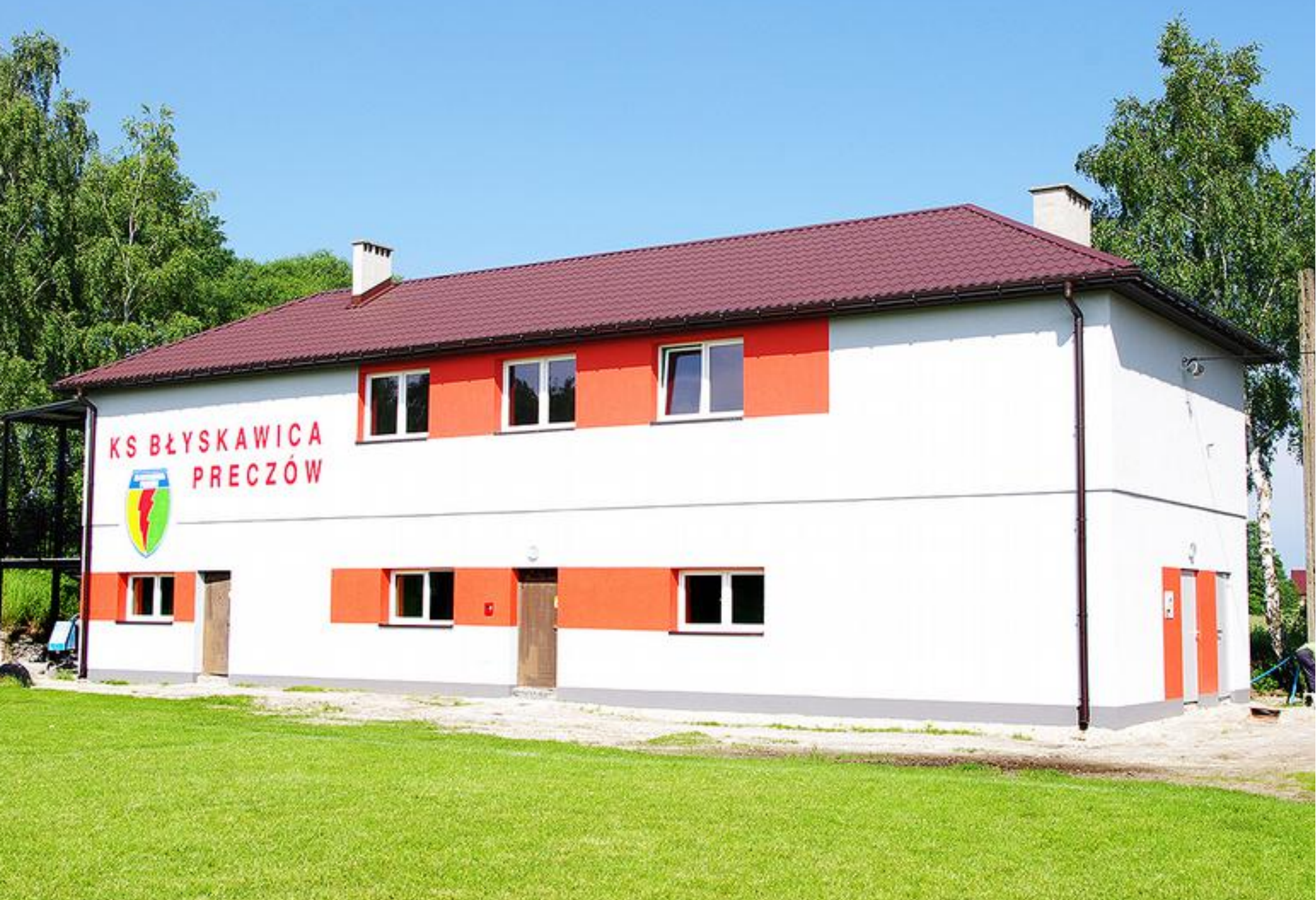
Budynek w Preczowie po zakończeniu prac.
