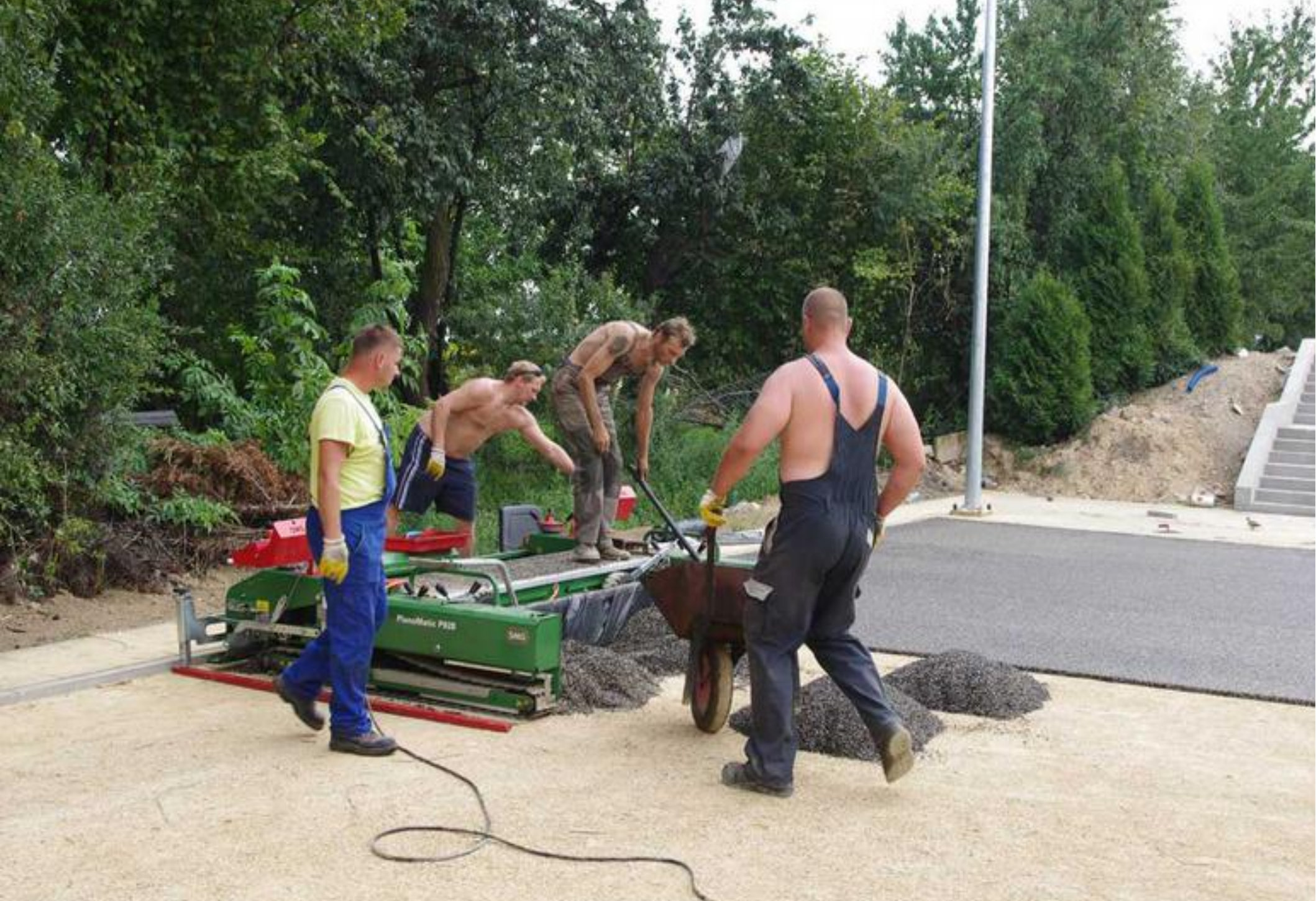
W trakcie prac nad kompleksem boisk „Orlik 2012” w Psarach.
