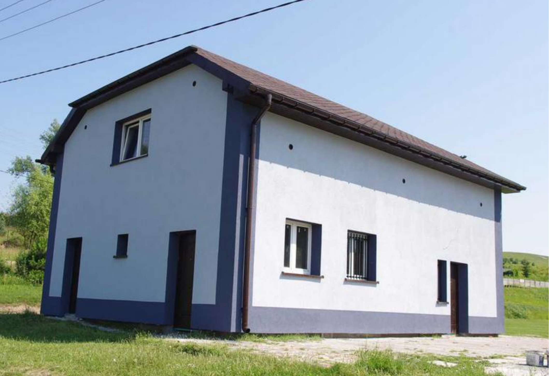
Budynek szatni sportowej po remoncie i z nową elewacją.
