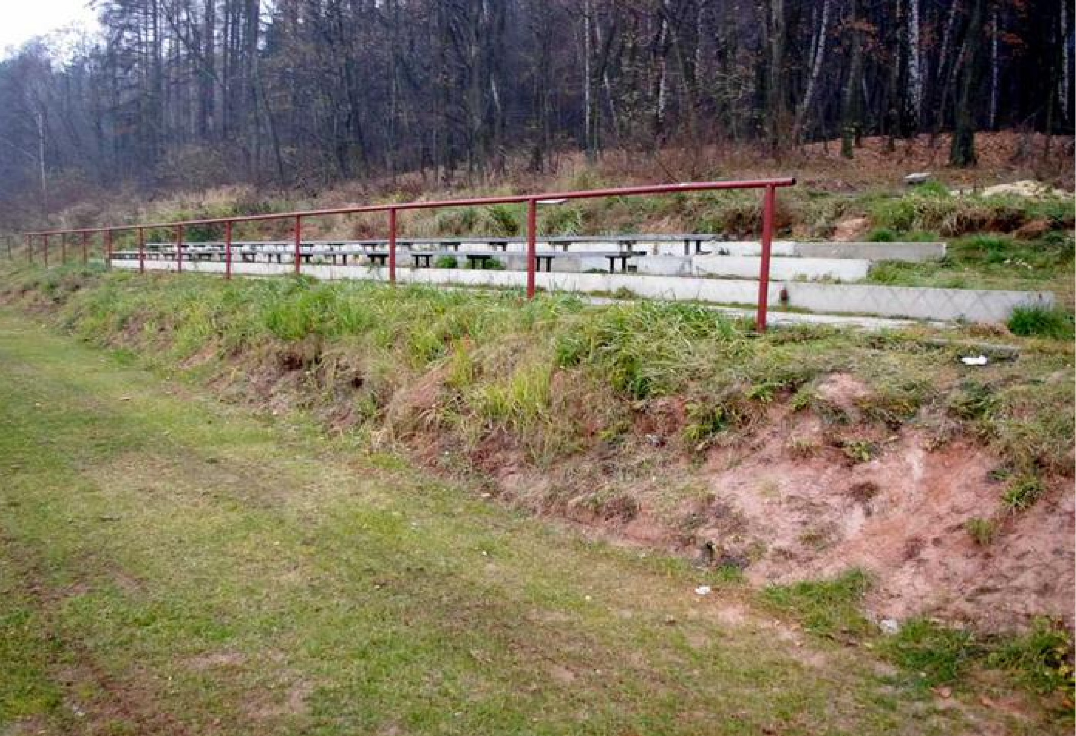
Stan przed przystąpieniem do prac budowlanych.
