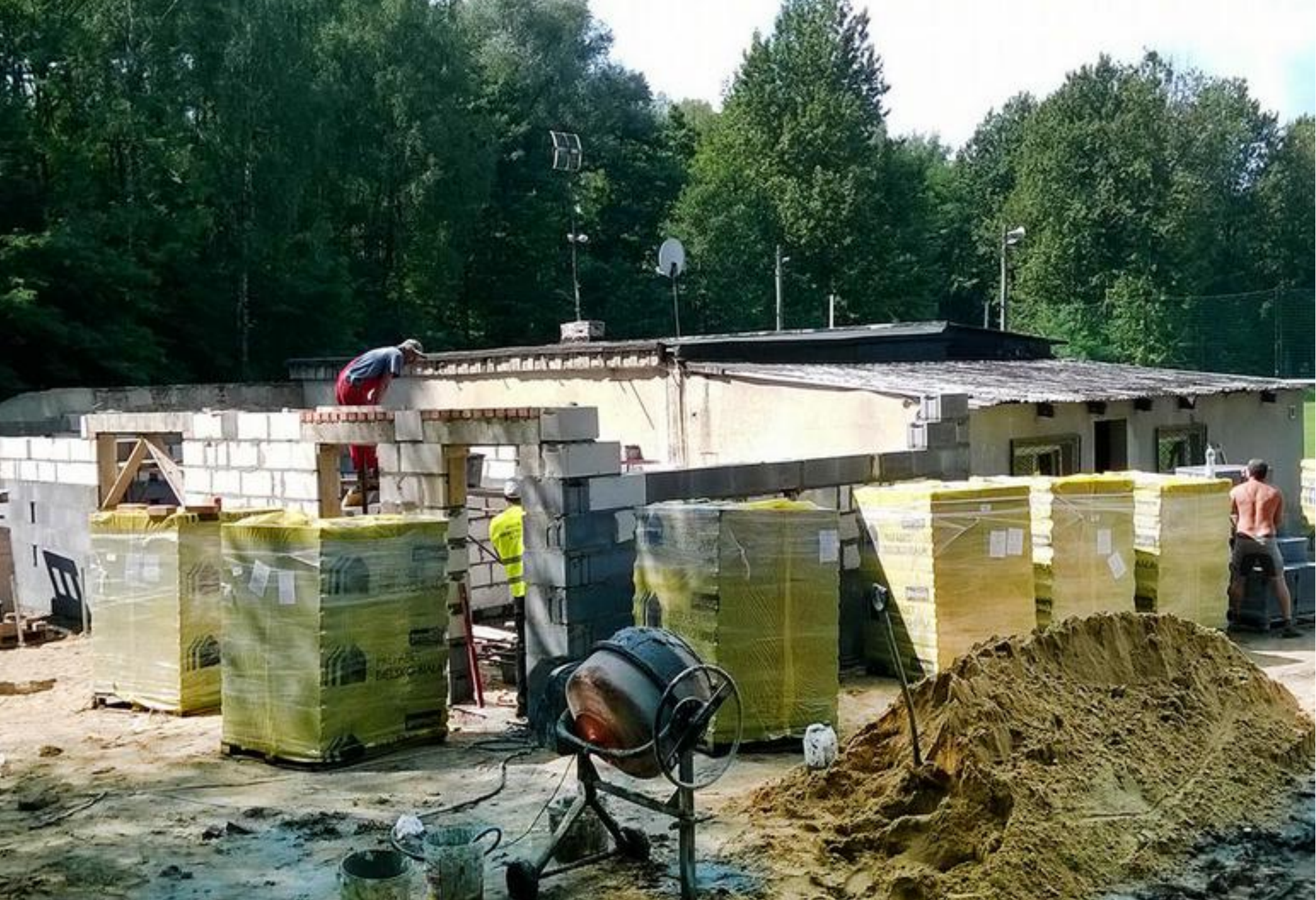
Prace nad rozbudową szatni KS Góra Siewierska – wrzesień 2014 r.
