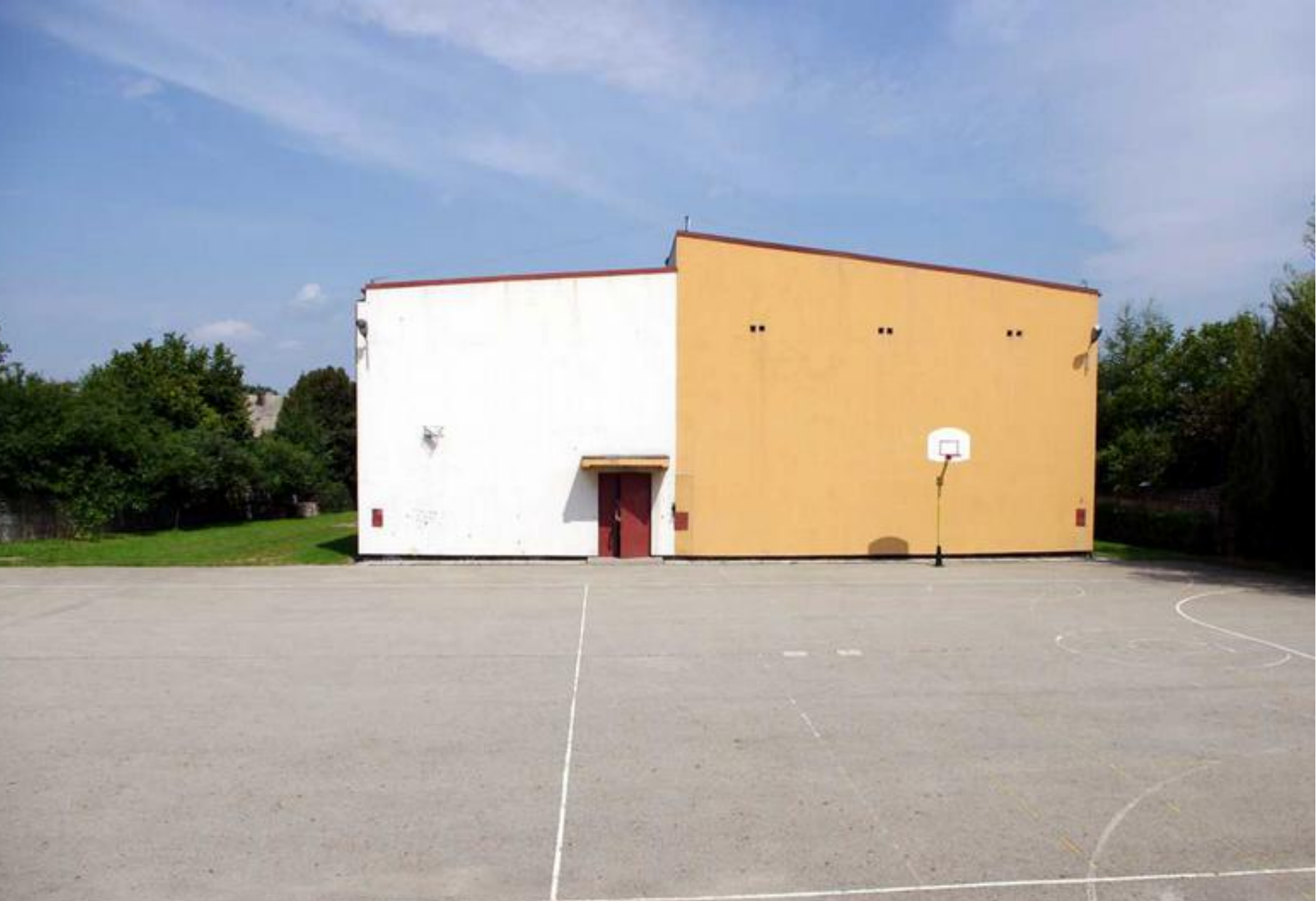
Stan przed powstaniem kompleksu boisk „Orlik 2012” w Psarach.
