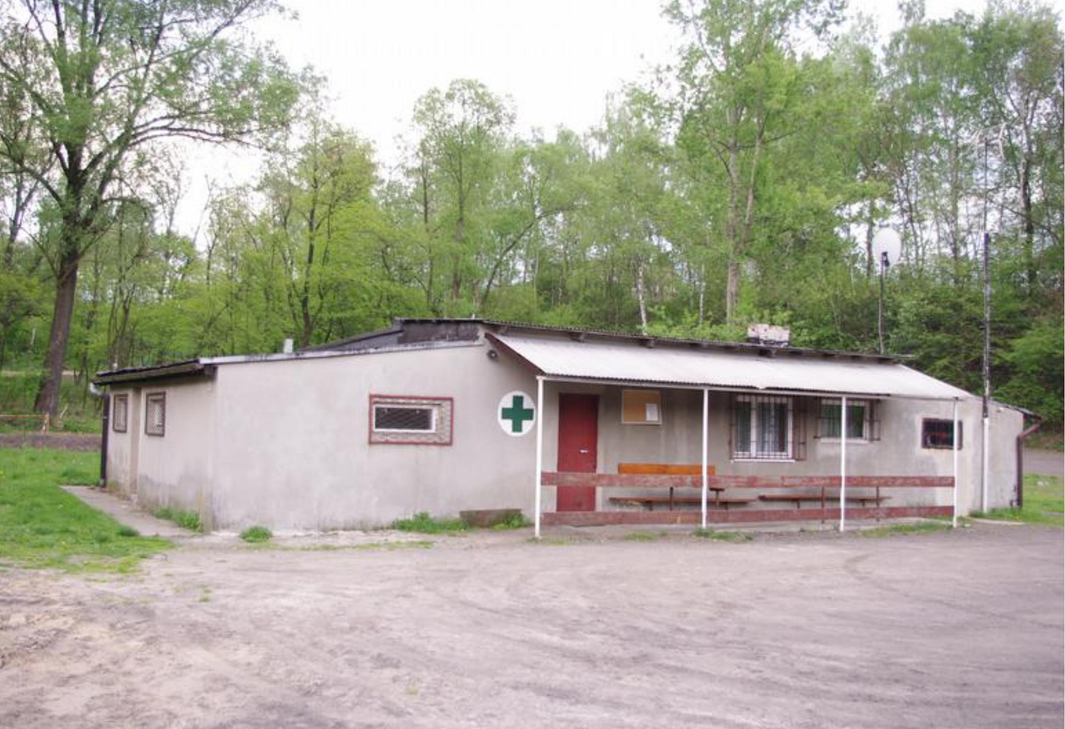
Budynek szatni KS Góra Siewierska – stan obecny.
