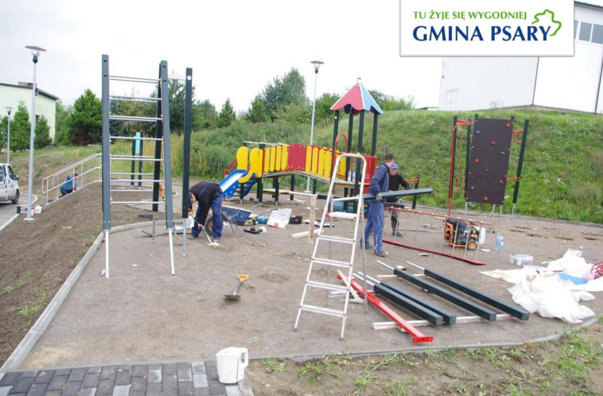
Prace nad budową kompleksu sportowo-rekreacyjnego w Sarnowie.
