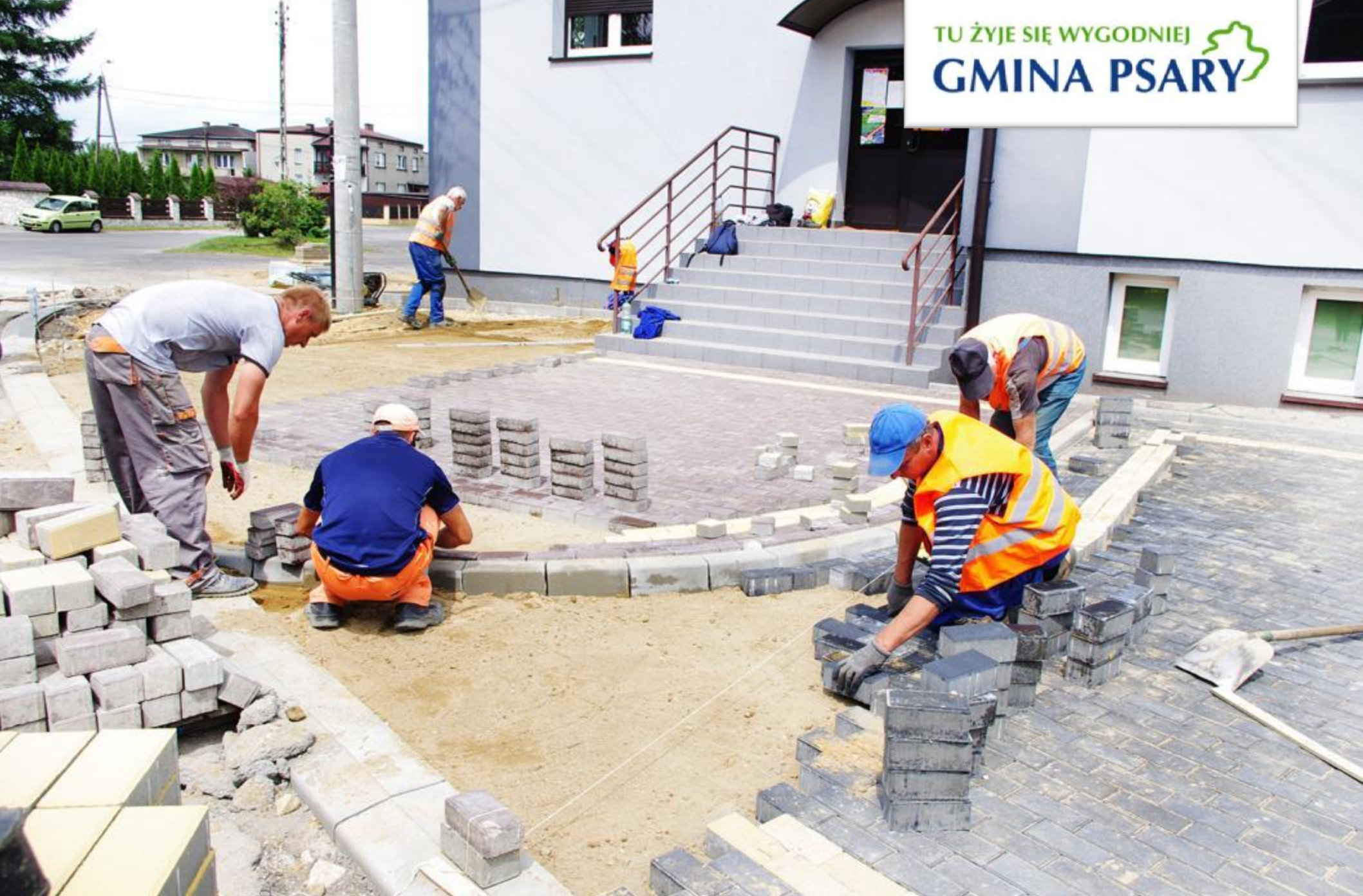
Parking przy remizie OSP Preczów w trakcie remontu.
