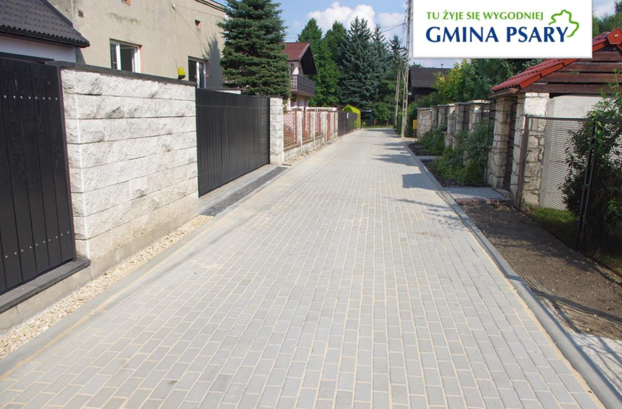
Ulica Zielona w Preczowie z nową nawierzchnią.
