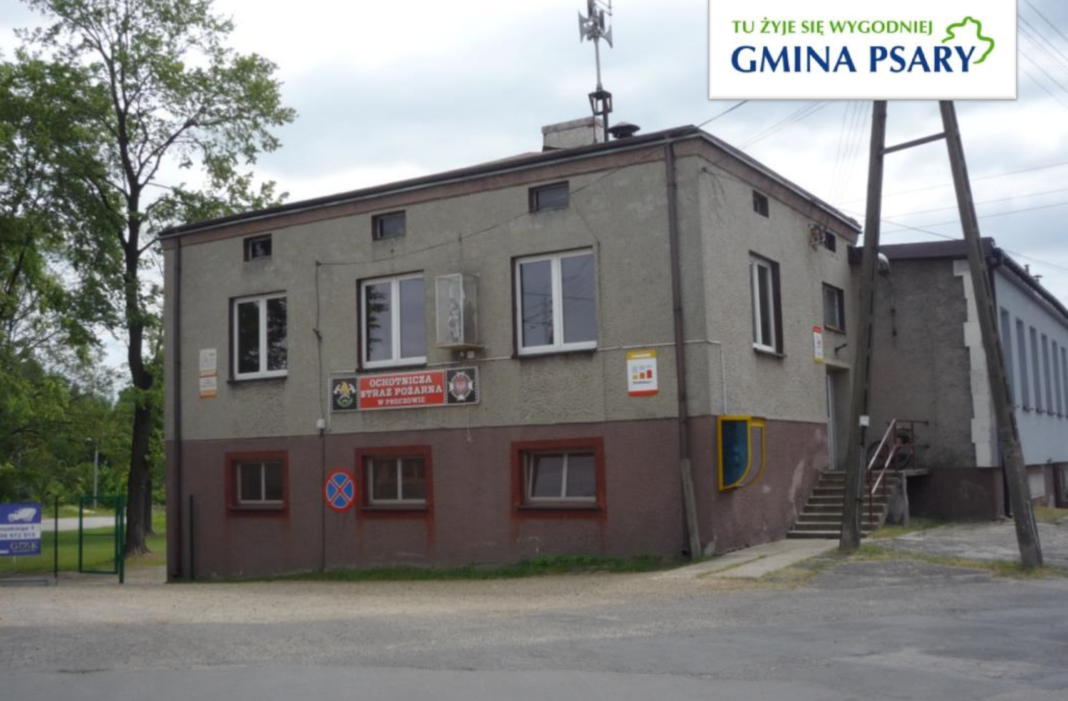
Parking i budynek remizy OSP Preczów przed remontem.
