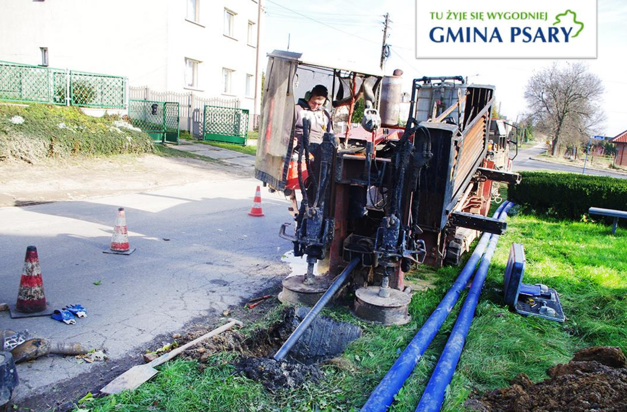
Budowa wodociągu na ul. Belnej w Strzyżowicach.
