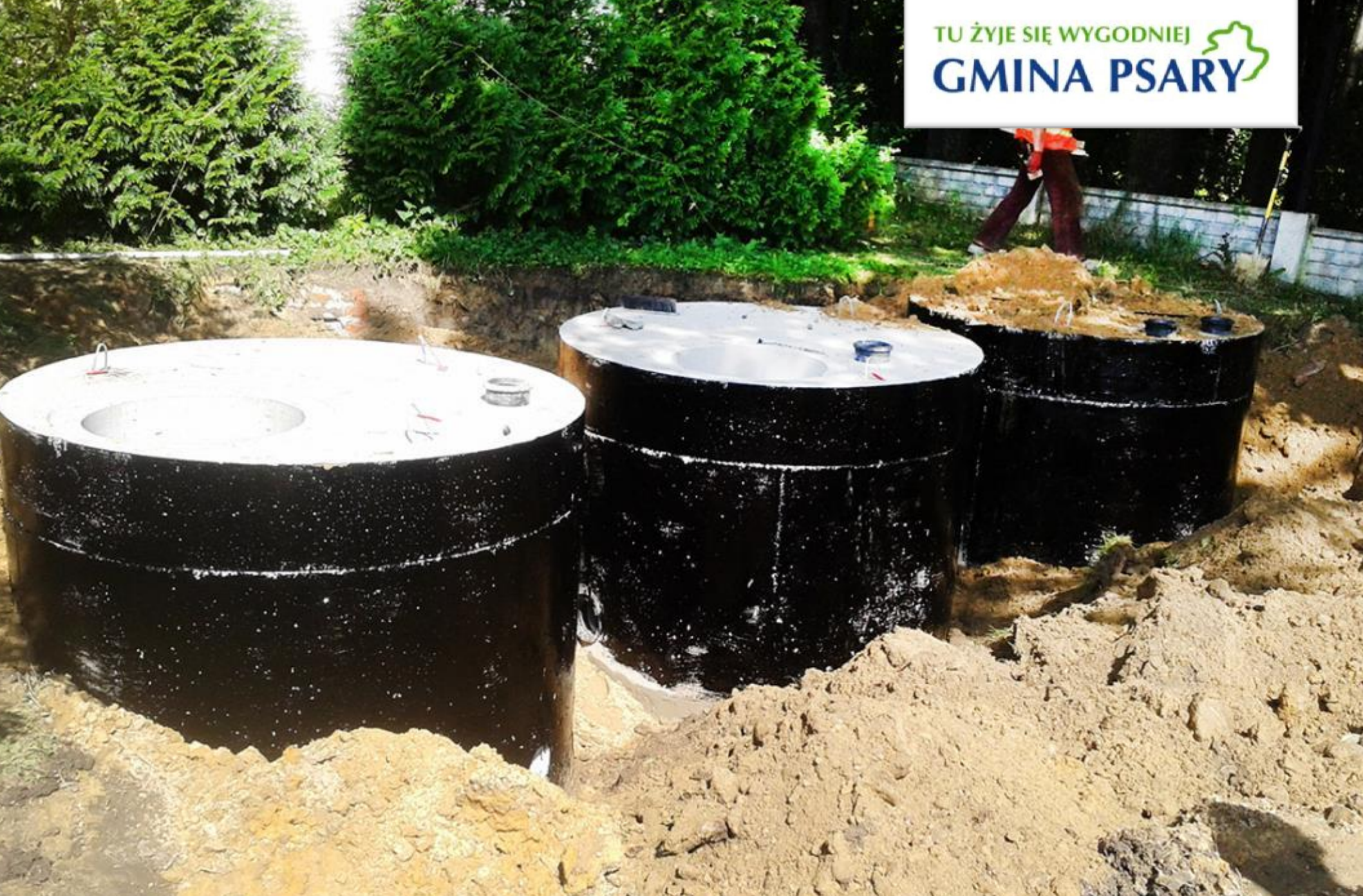
Budowa przybiektowej oczyszczalni przy szkole w Gródkowie.
