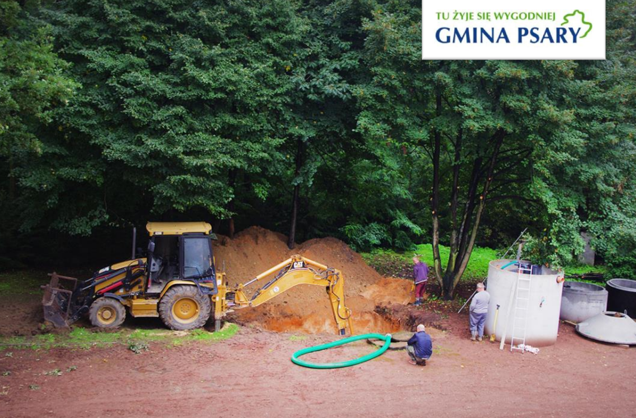
Budowa przyobiektowej oczyszczalni ścieków przy Urzędzie w Psarach.
