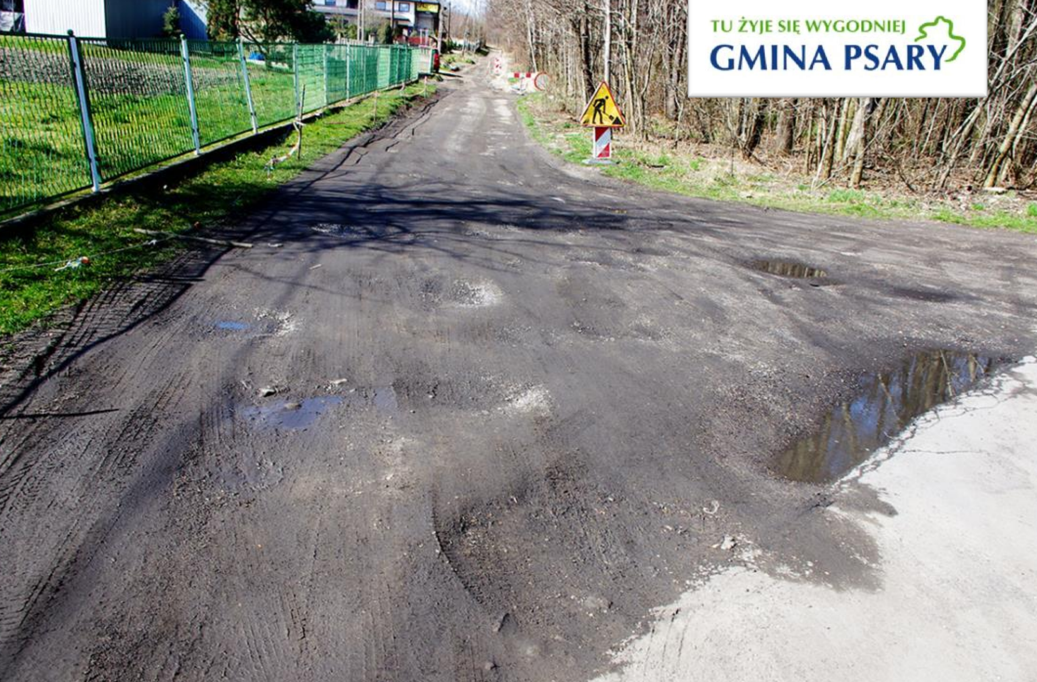
Ulica Spokojna w Gródkowie przed remontem.
