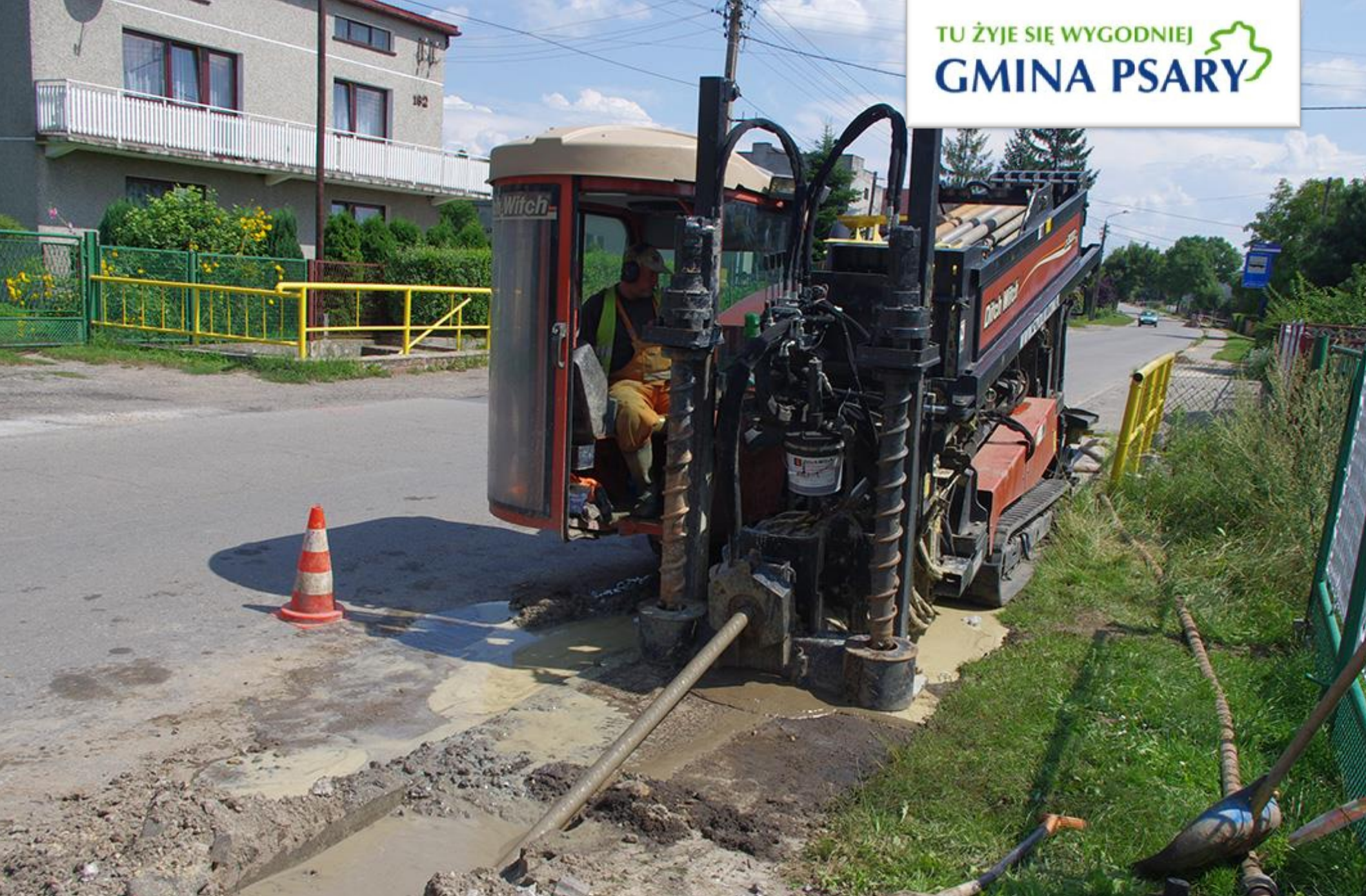
Budowa wodociągu przy ulicy Wiejskiej w Psarach.
