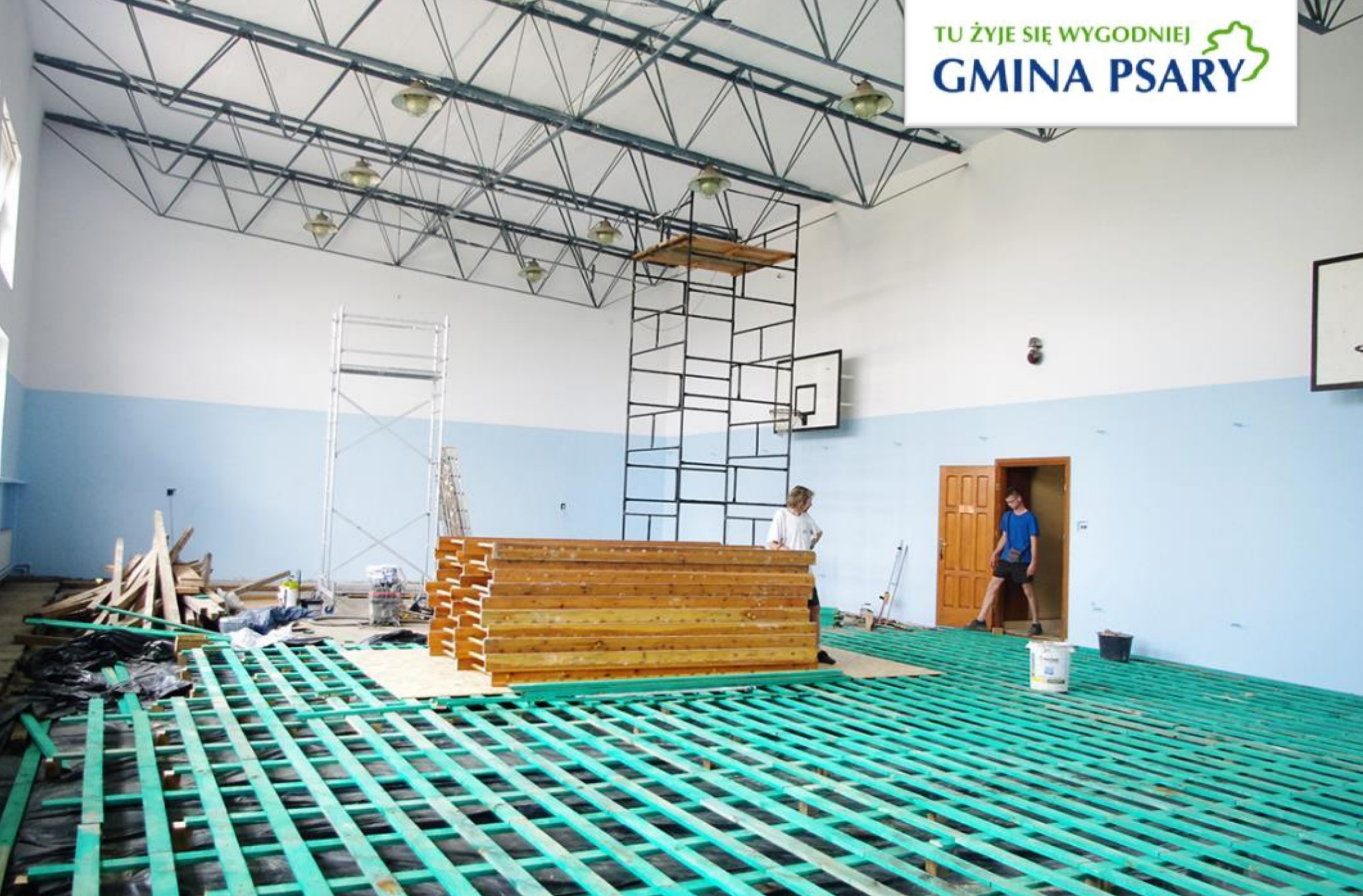
Sala gimnastyczna w SP Strzyżowice w trakcie remontu.
