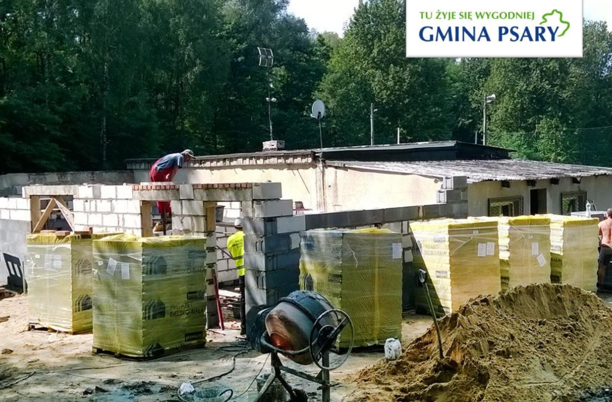
Prace nad rozbudową szatni piłkarskiej w Górze Siewierskiej.
