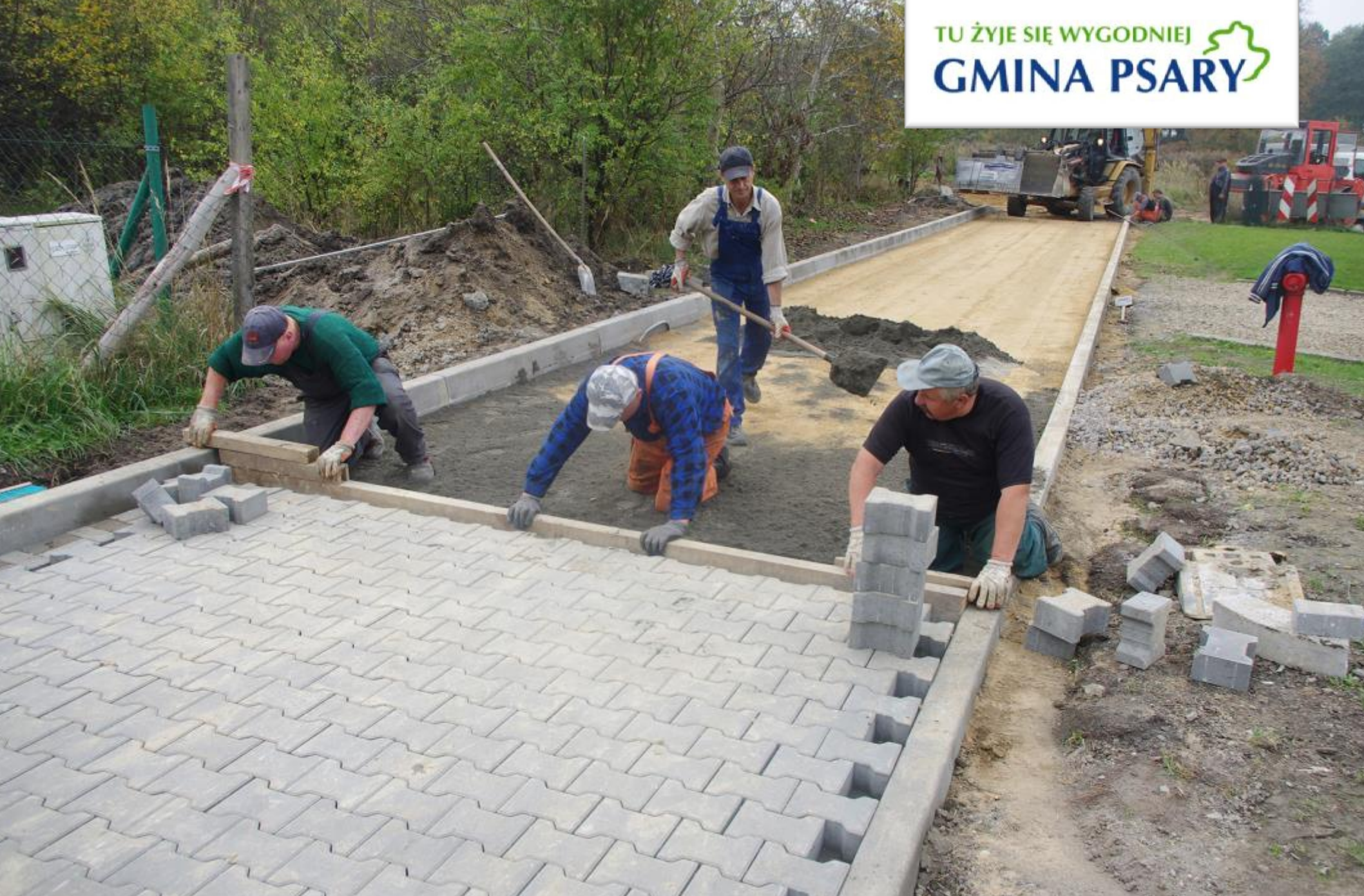
Ulica Boczna w Strzyżowicach w trakcie remontu.
