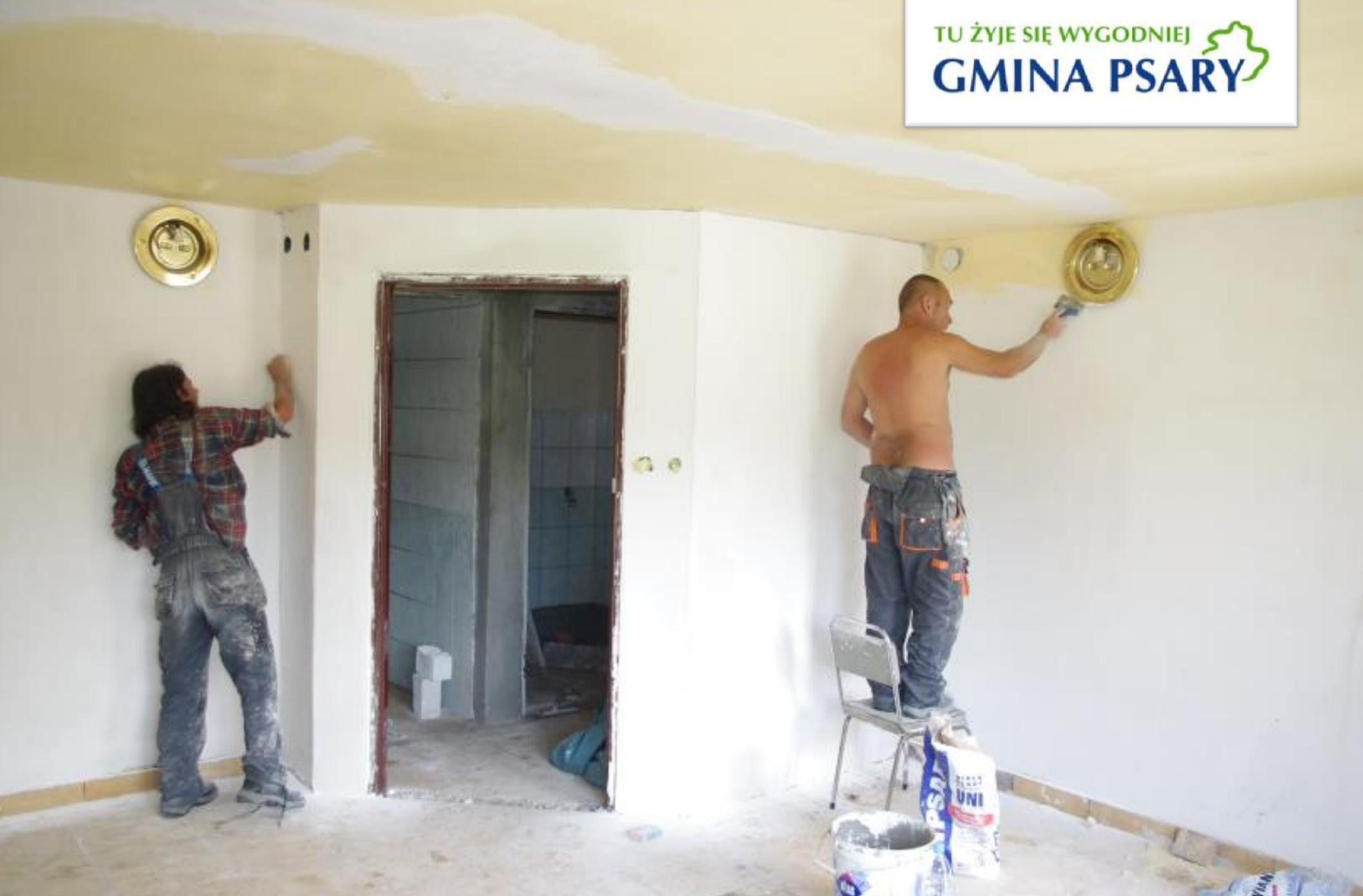
Prace remontowe w szatni Iskry Psary.
