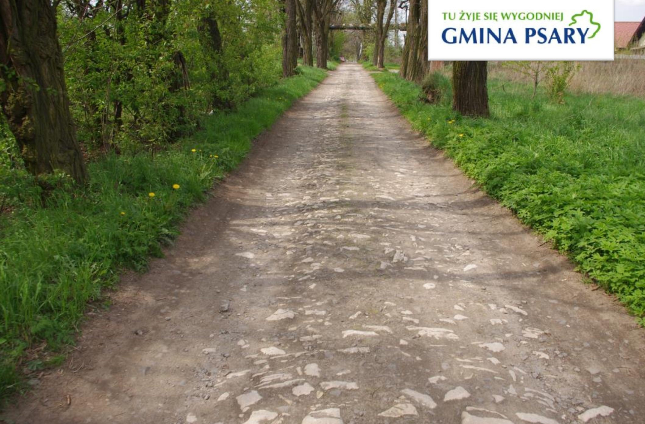
Ulica Parkowa w Sarnowie przed remontem.
