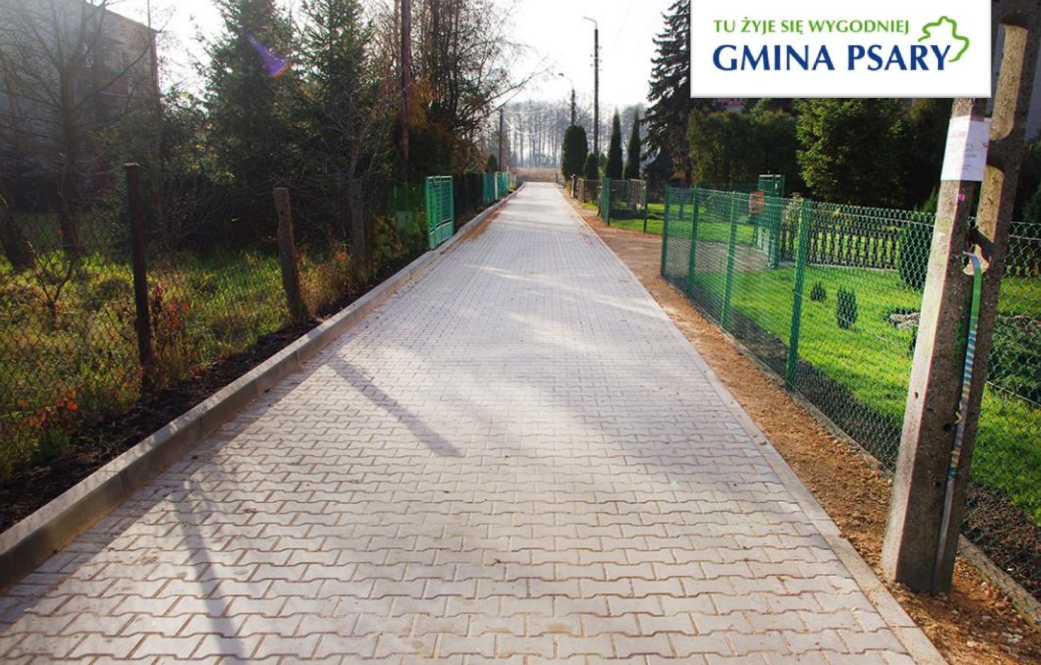
Ulica Boczna w Strzyżowicach po remoncie. Wartość prac: 299 562,74 zł.
