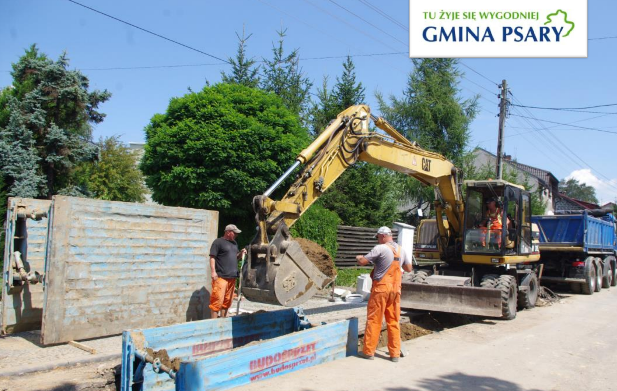
Budowa chodnika z odwodnieniem na powiatowej części ul. Belnej w Strzyżowicach.
