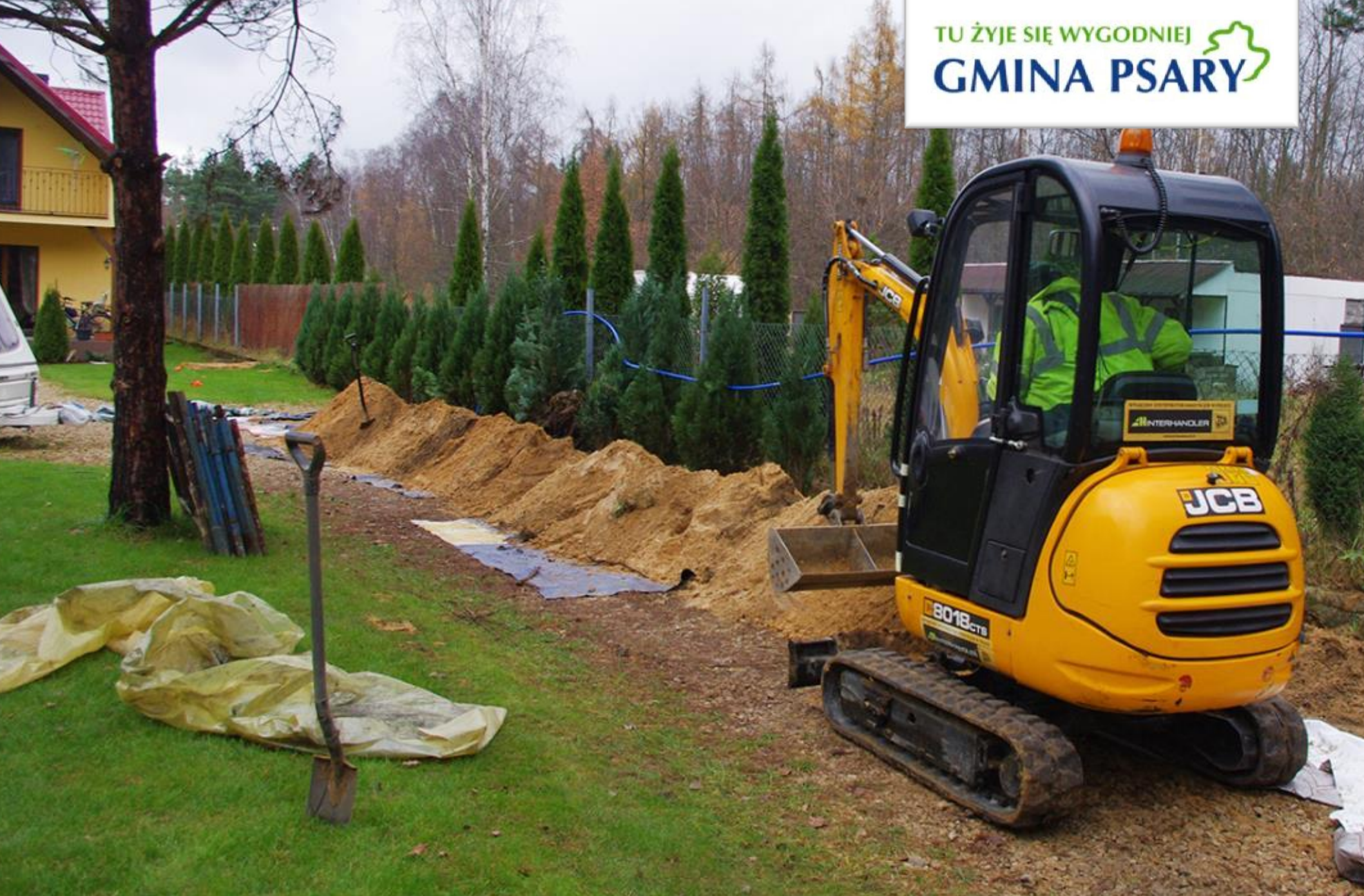
Budowa wodociągu przy ulicy Sosnowej w Preczowie.
