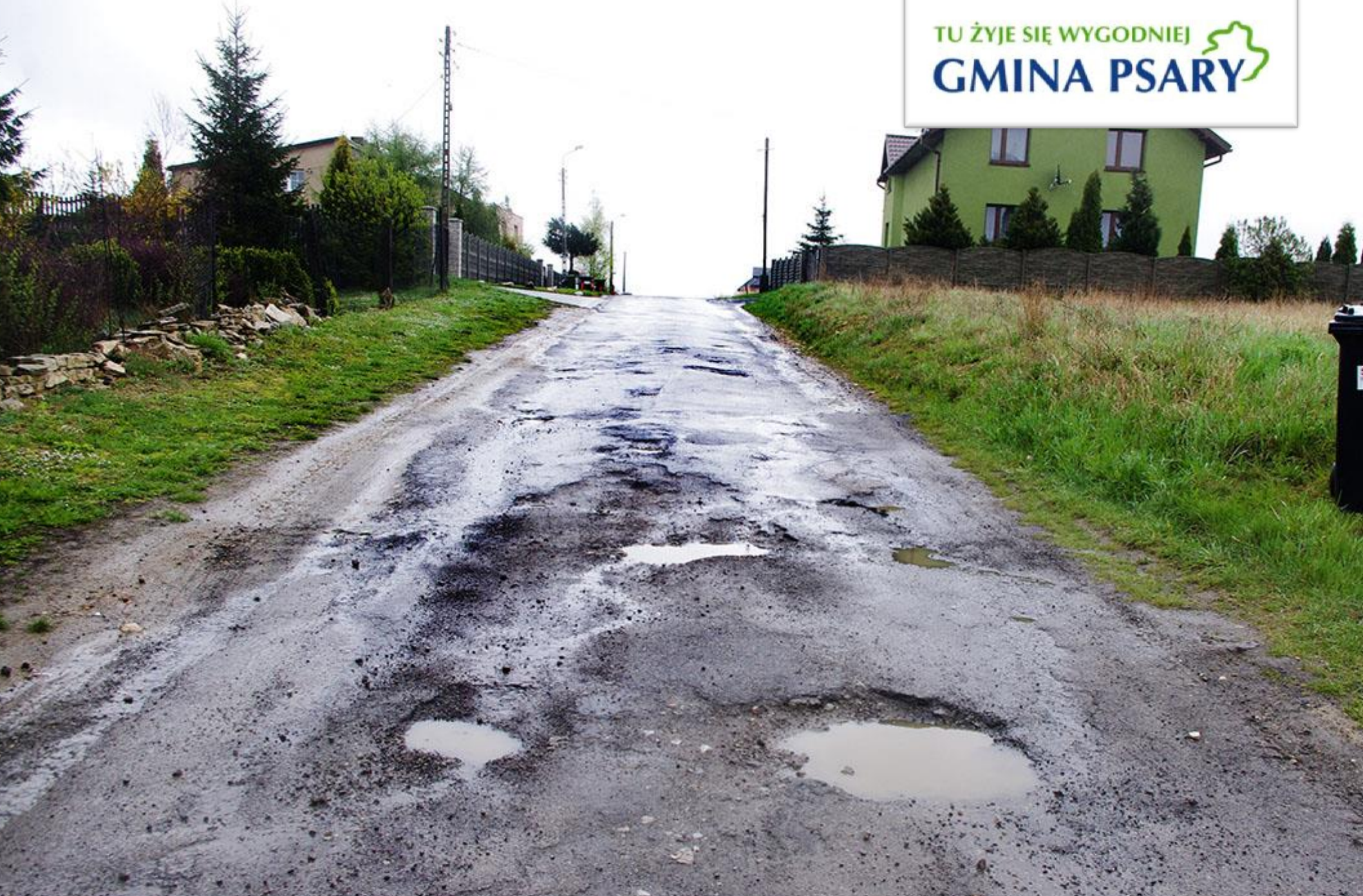
Ulica Kościuszki w Górze Siewierskiej przed remontem.
