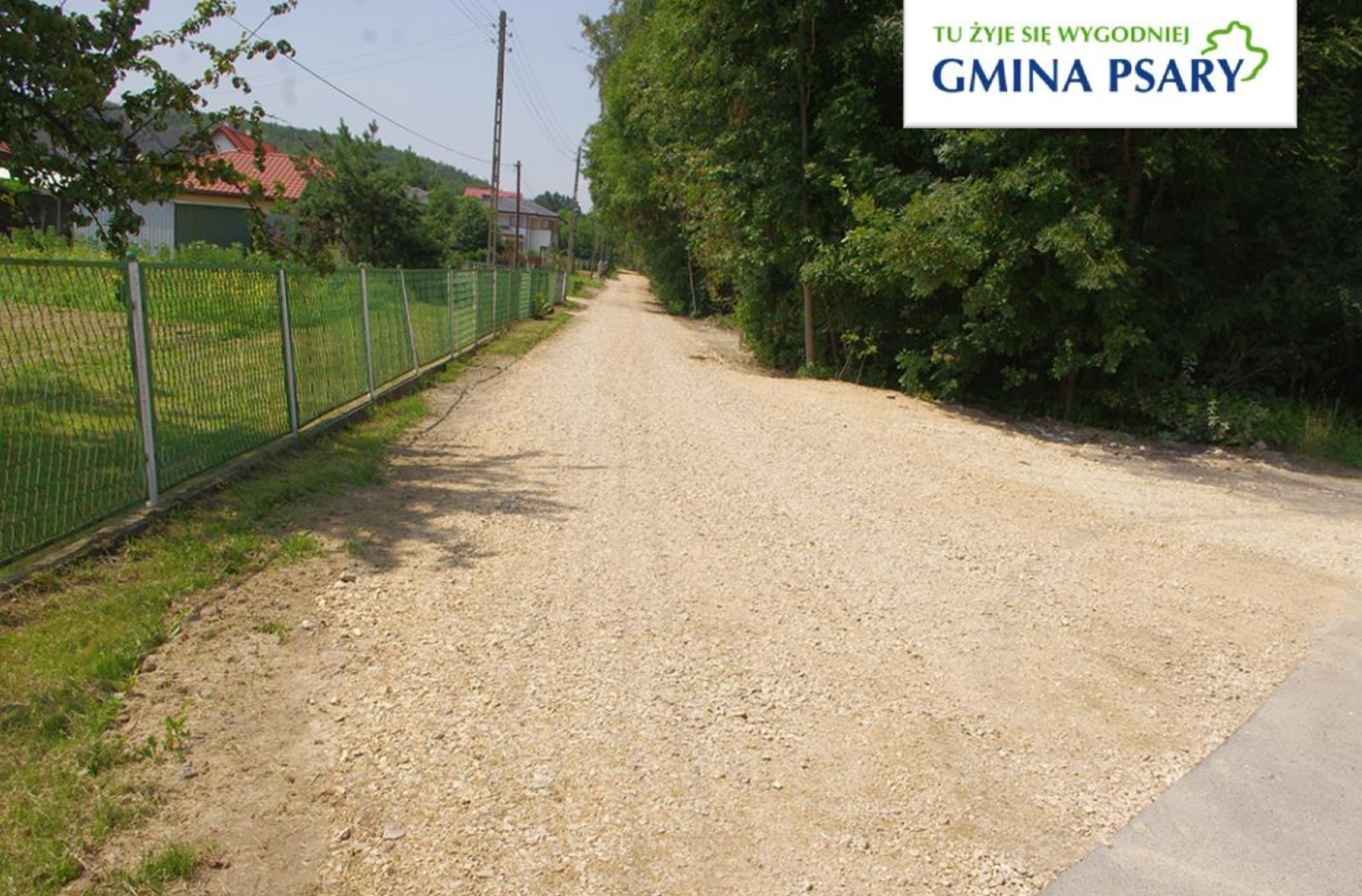
Ulica Spokojna w Gródkowie po remoncie.
