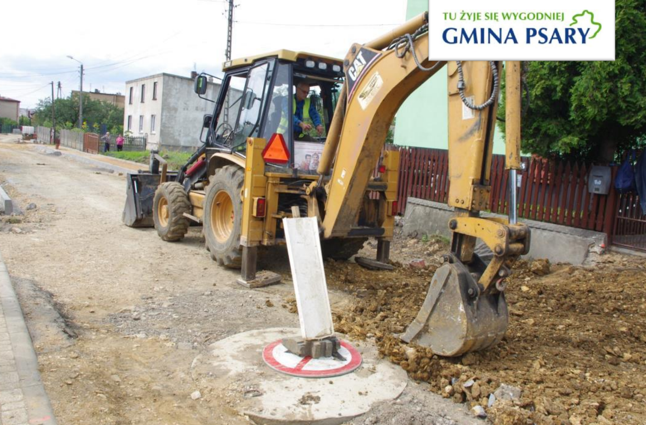
Ulica Kościuszki w Górze Siewierskiej w trakcie remontu.
