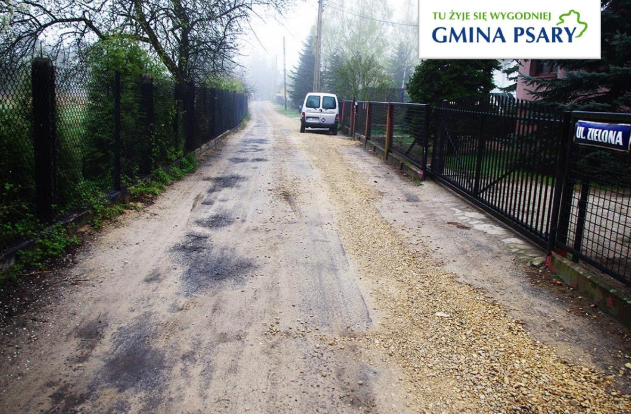
Ulica Zielona w Preczowie przed remontem.
