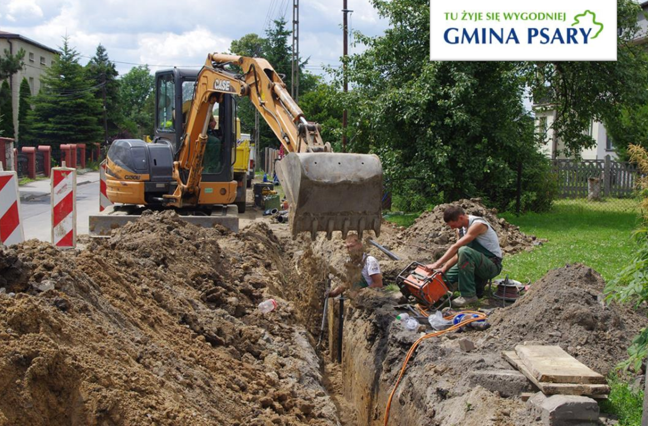
Budowa wodociągu w Malinowicach.
