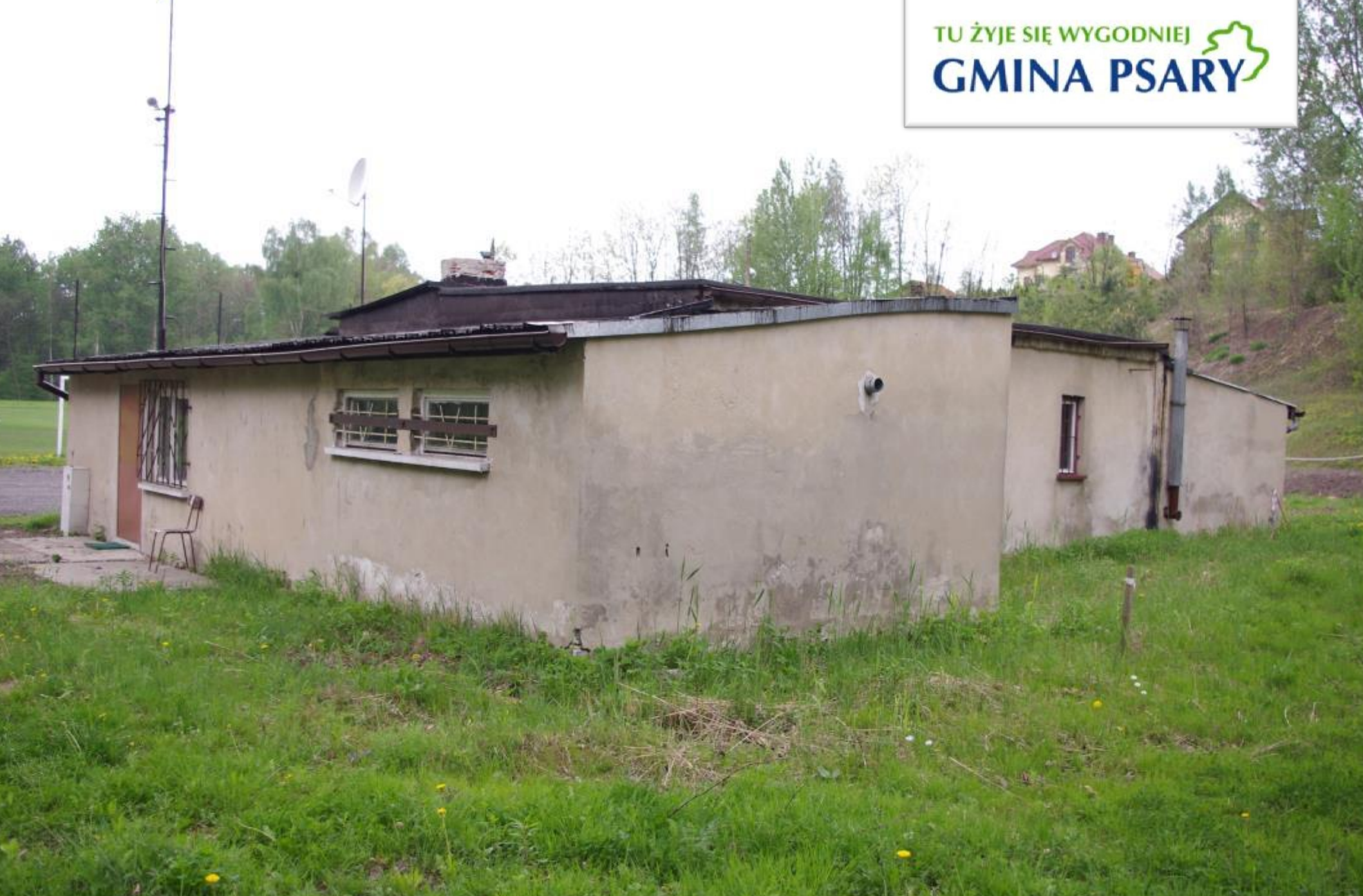
Szatnia piłkarska w Górze Siewierskiej przed rozbudową.
