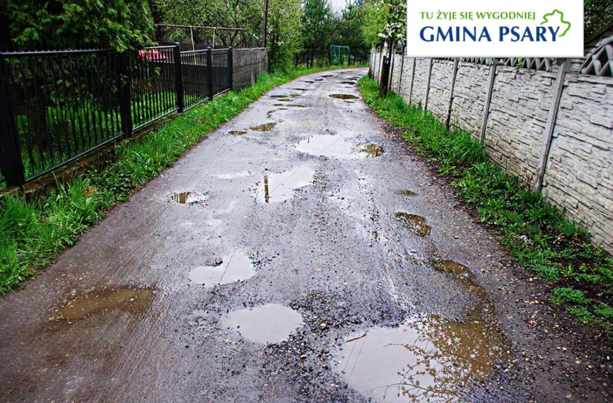
Ulica Boczna w Strzyżowicach przed remontem.
