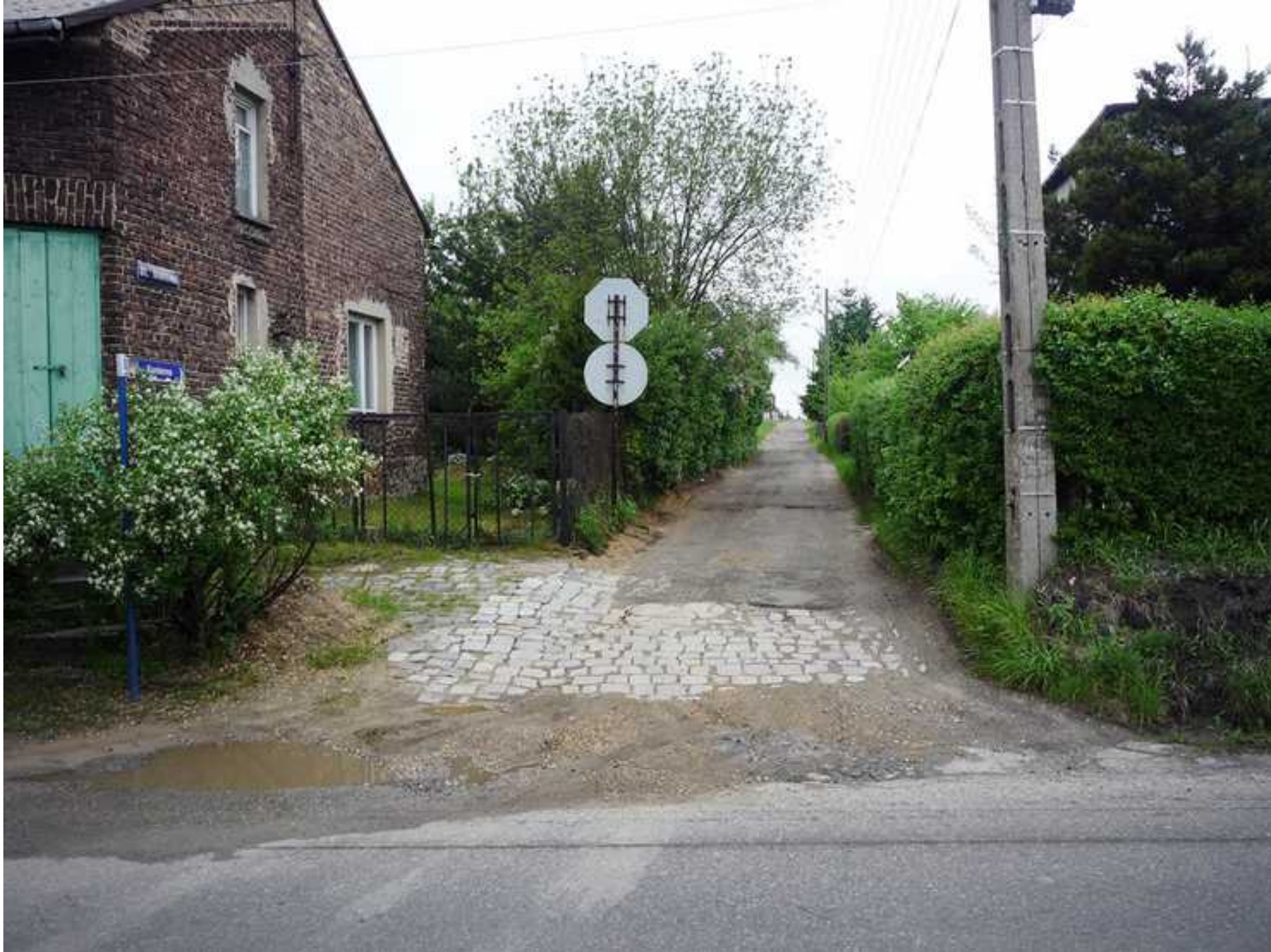
Ulica Kamienna w Sarnowie przed remontem
