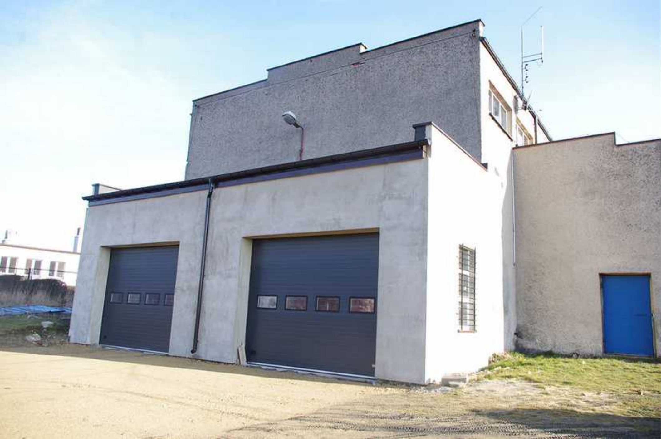
Garaże w OSP Góra Siewierska po rozbudowie
