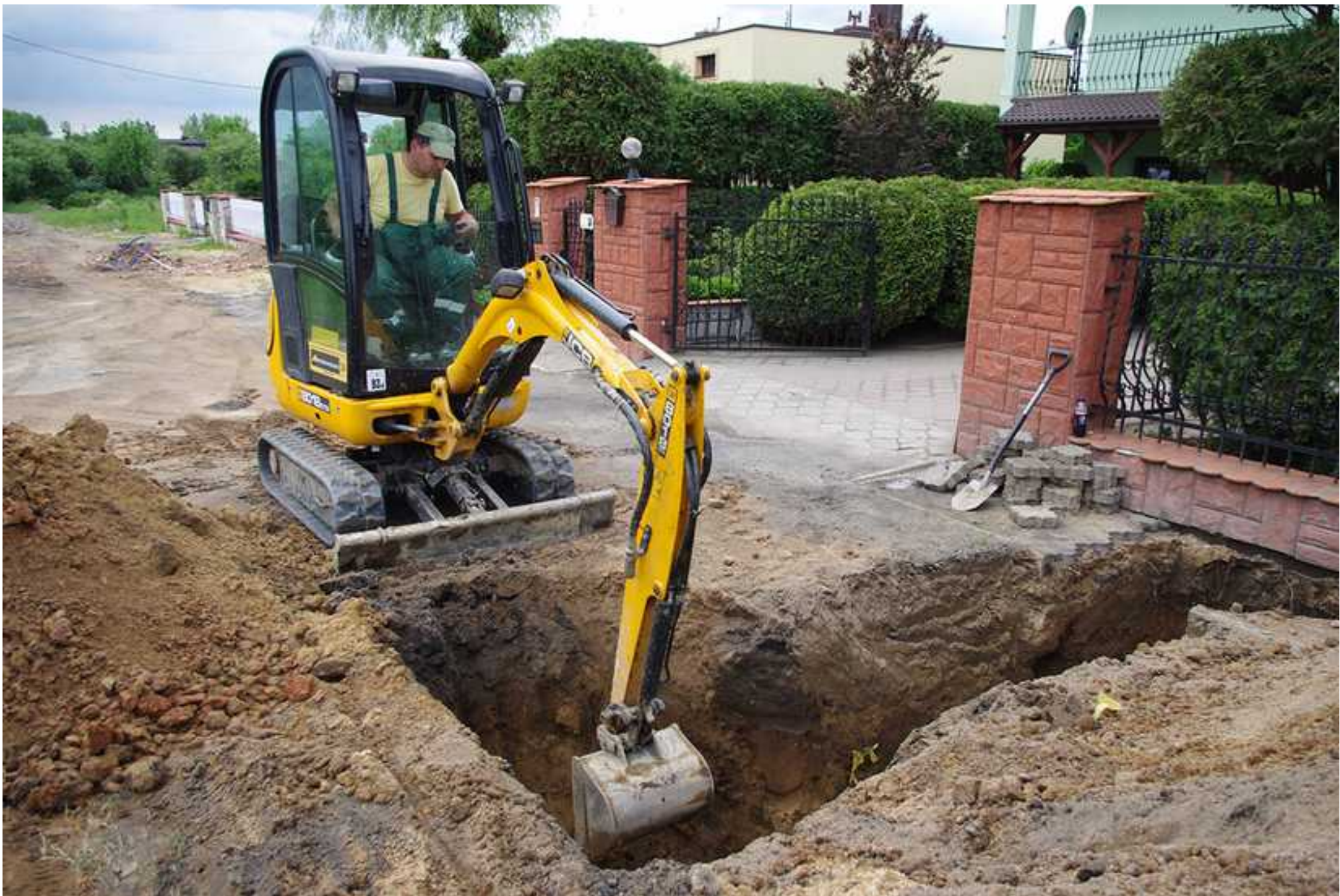
Prace na ulicy Kamiennej w Sarnowie
