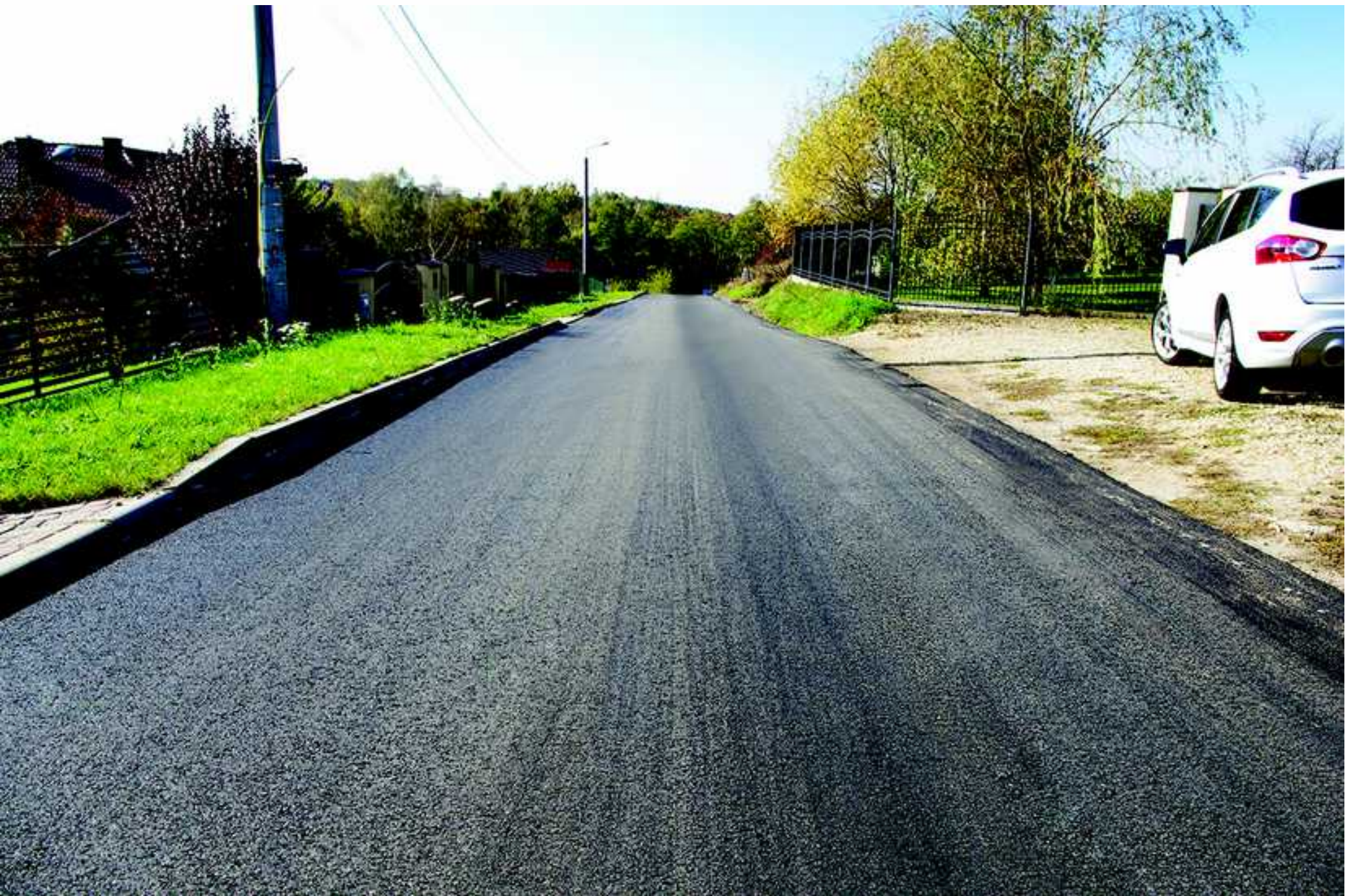
Ulica Górna w Górze Siewierskiej po remoncie
