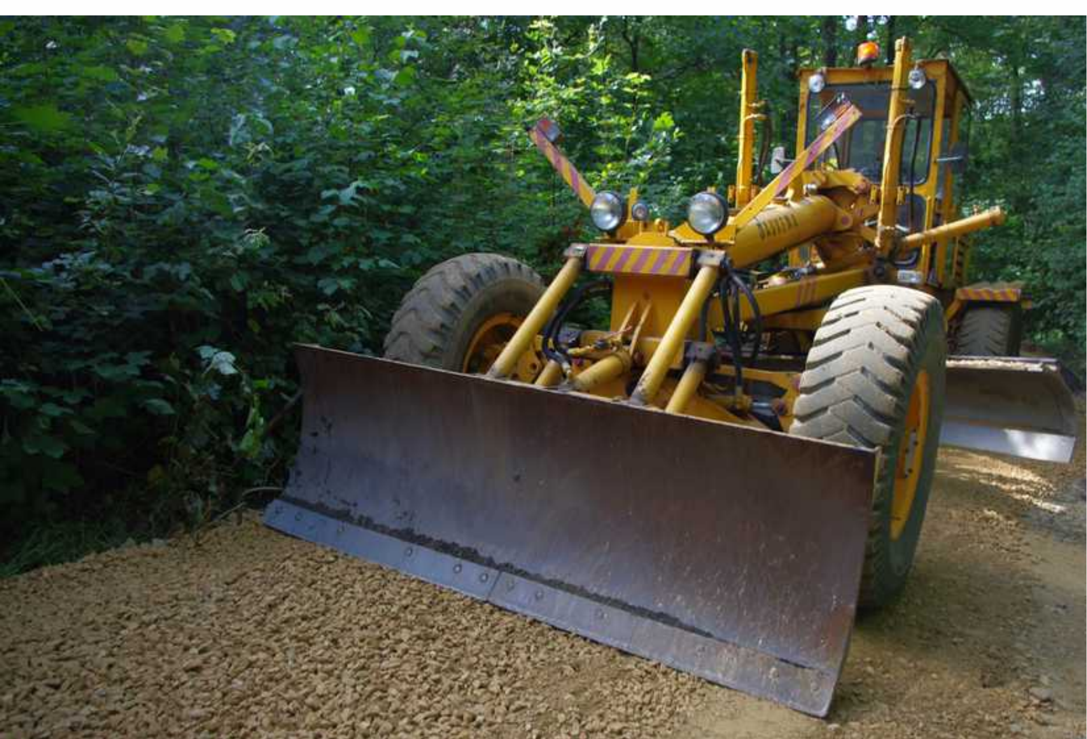
Prace na ulicy Leśnej w Gródkowie
