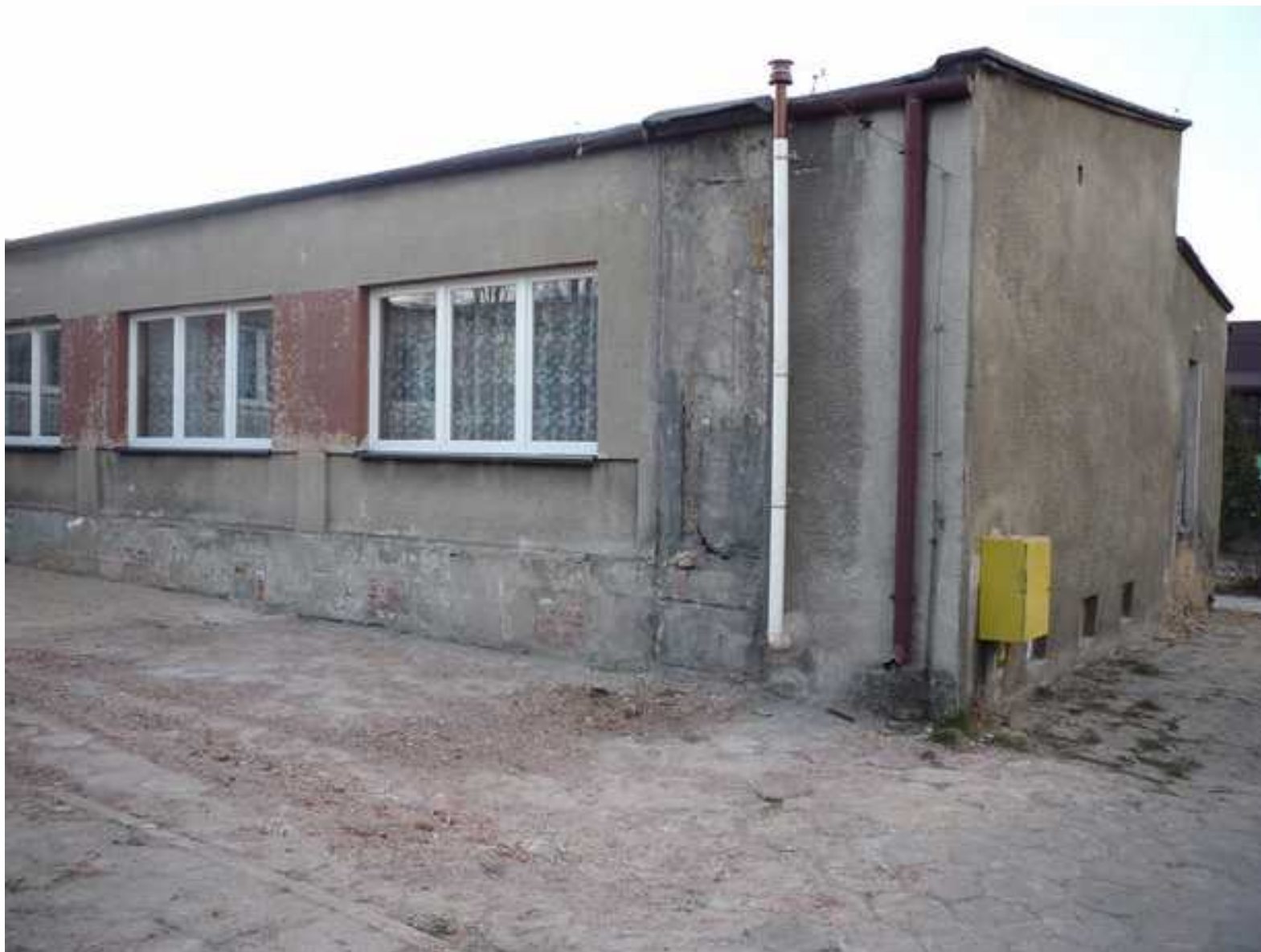
Budynek byłej szkoły w Malinowicach przed termomodernizacją
