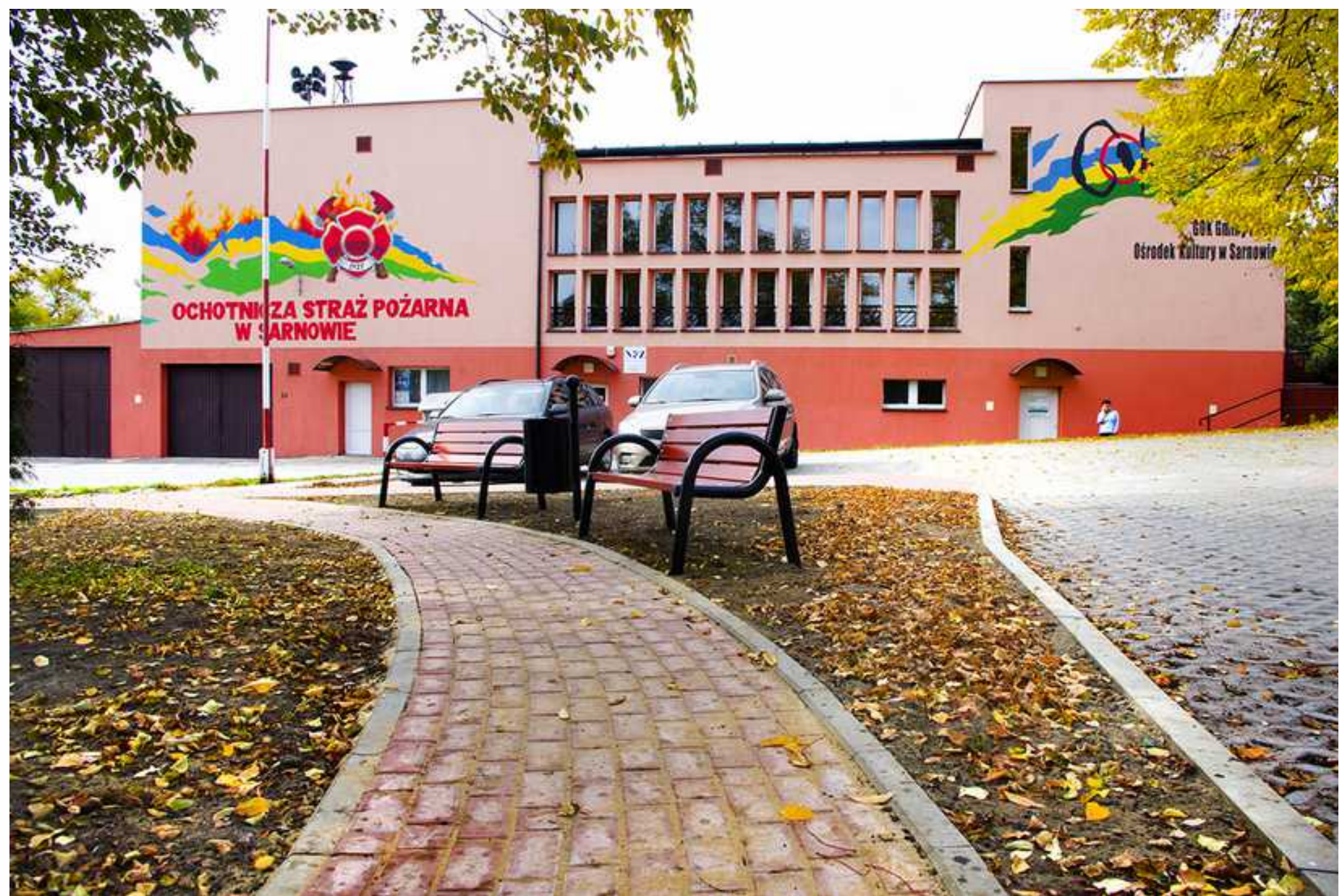
Zmodernizowany plac przy budynku OSP w Sarnowie
