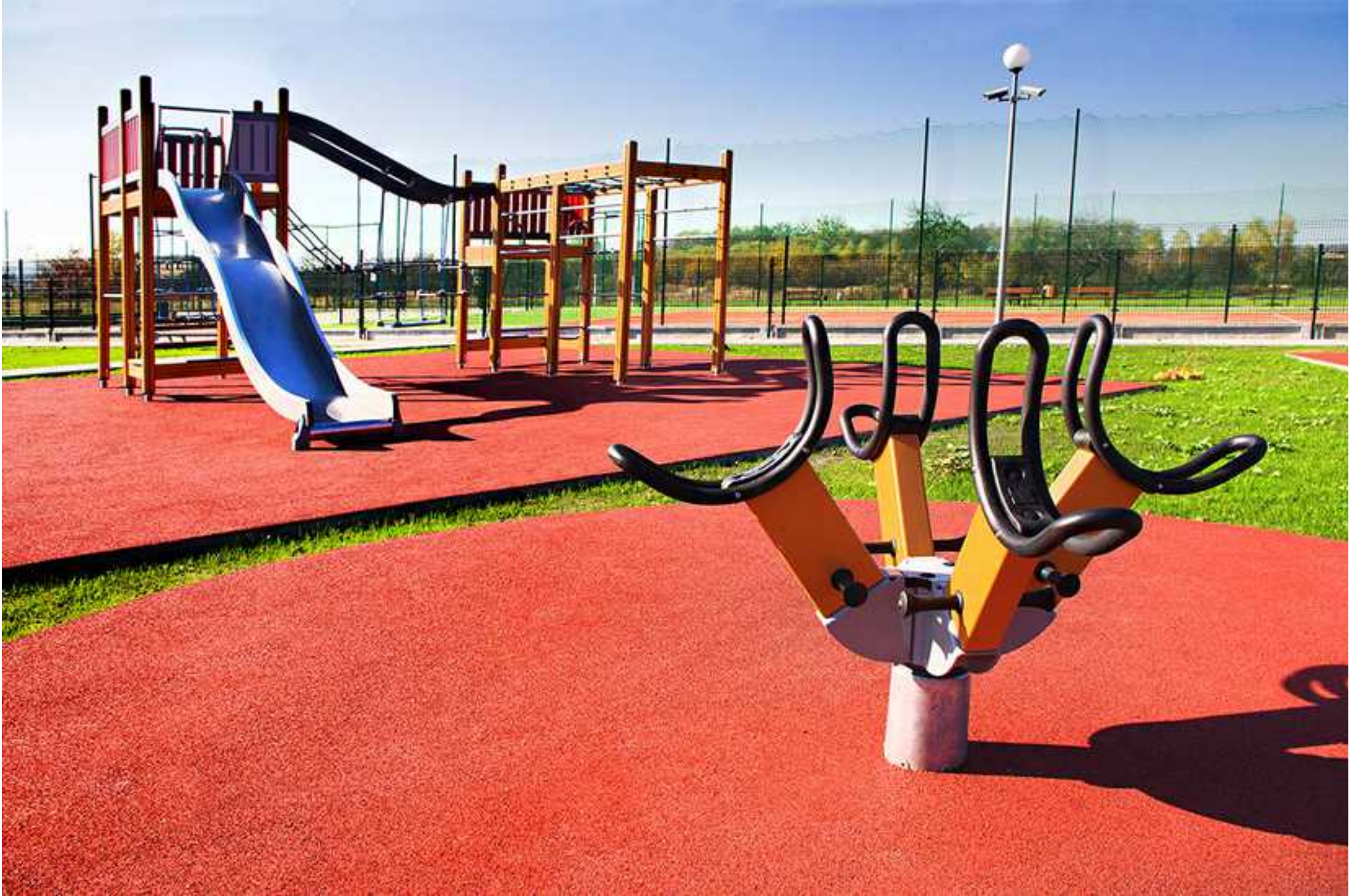
Wykonany kompleks sportowo-rekreacyjny za OPS w Psarach
