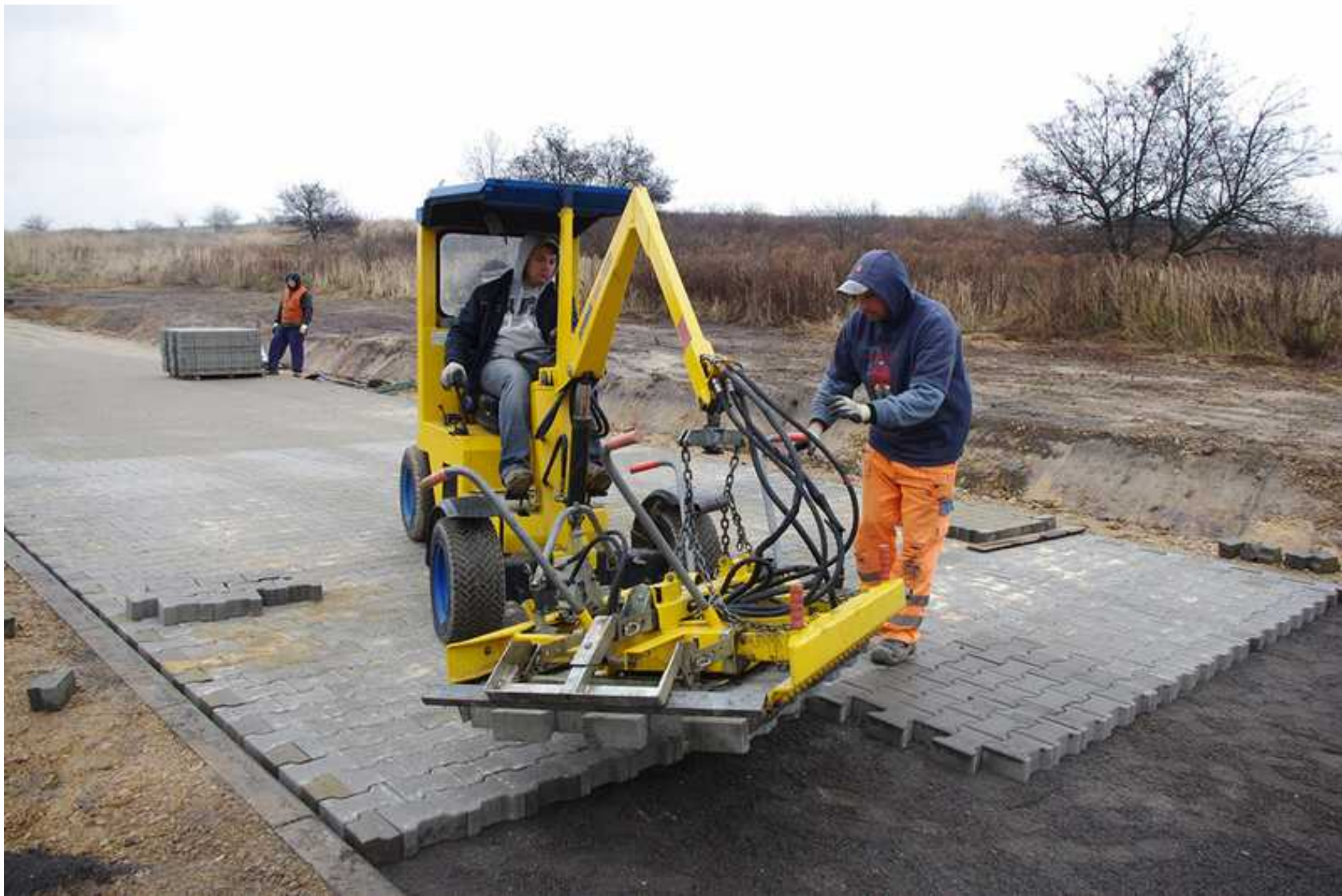
Ulica Irysów w Psarach w trakcie prac remontowych
