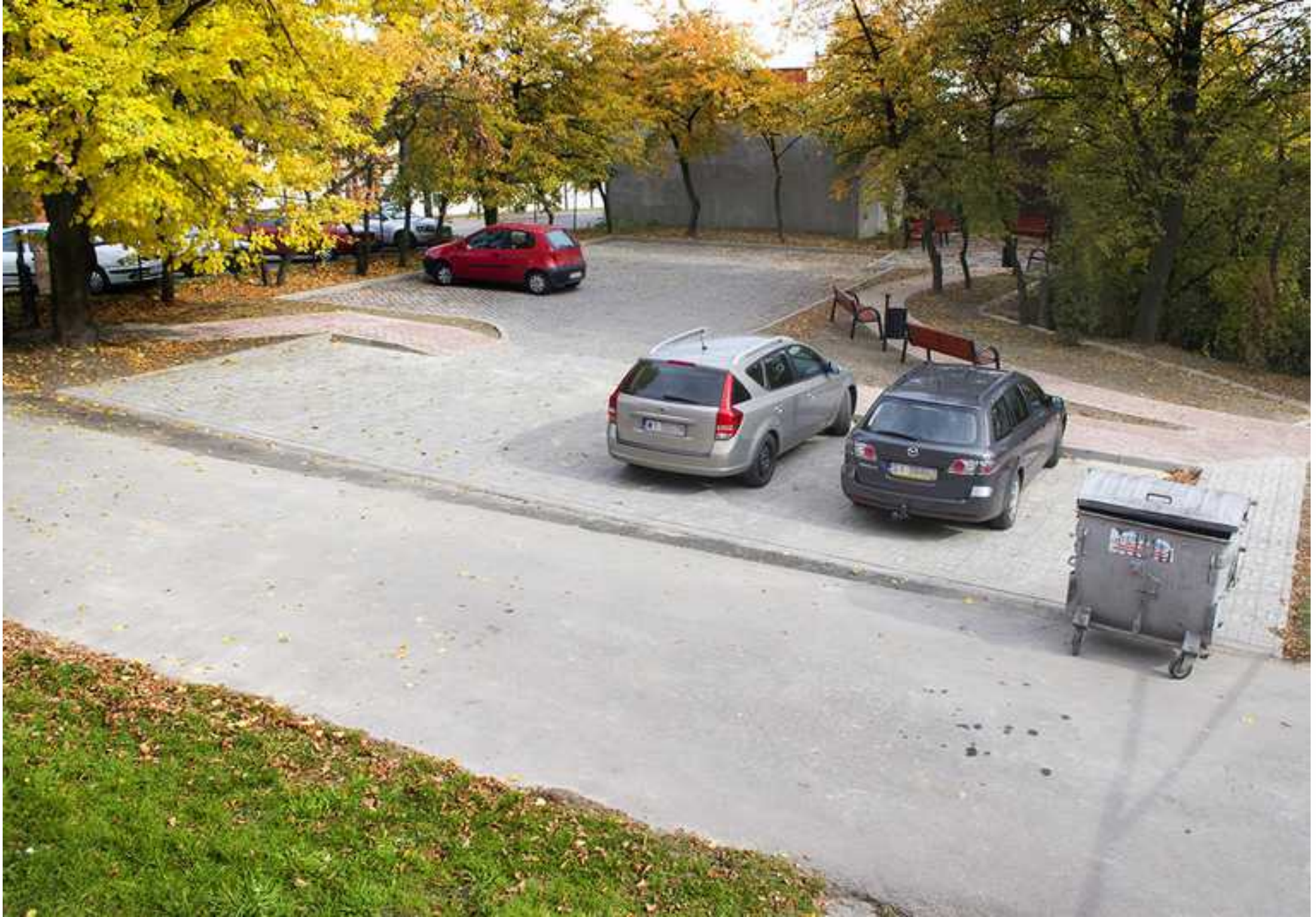
Zmodernizowany plac przy budynku OSP w Sarnowie
