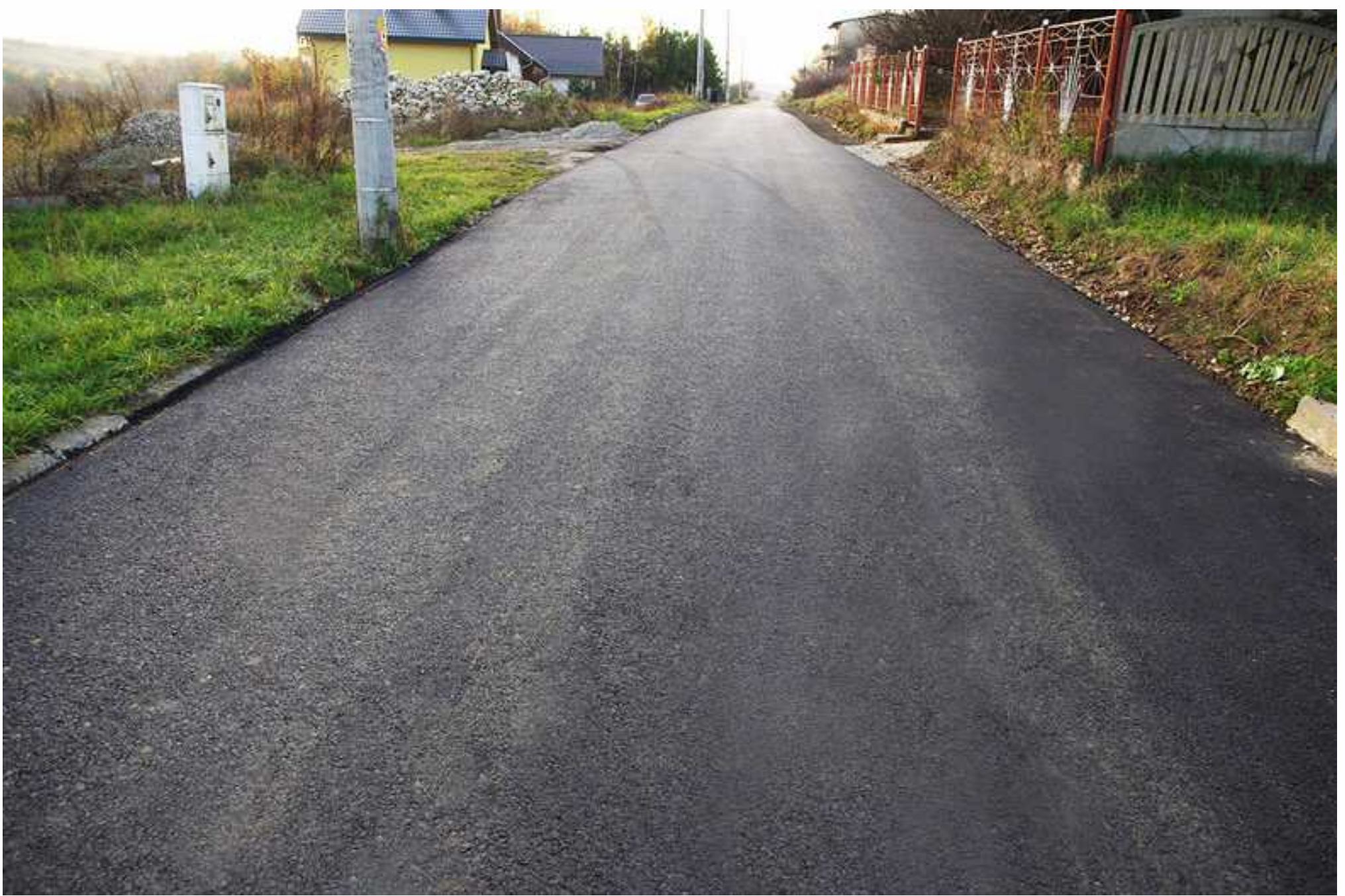
Ulica Górna w Górze Siewierskiej po remoncie
