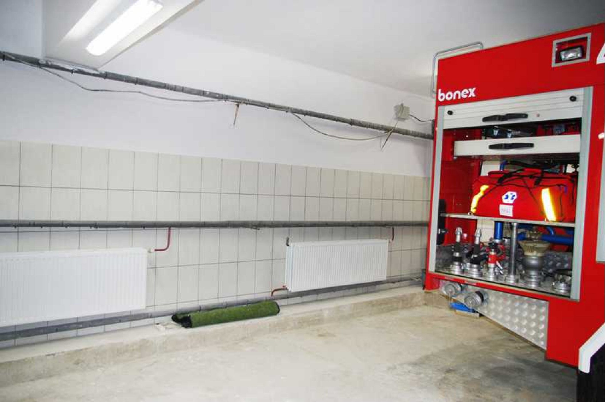
W garażu OSP w Górze Siewierskiejna ścianach położono płytki
