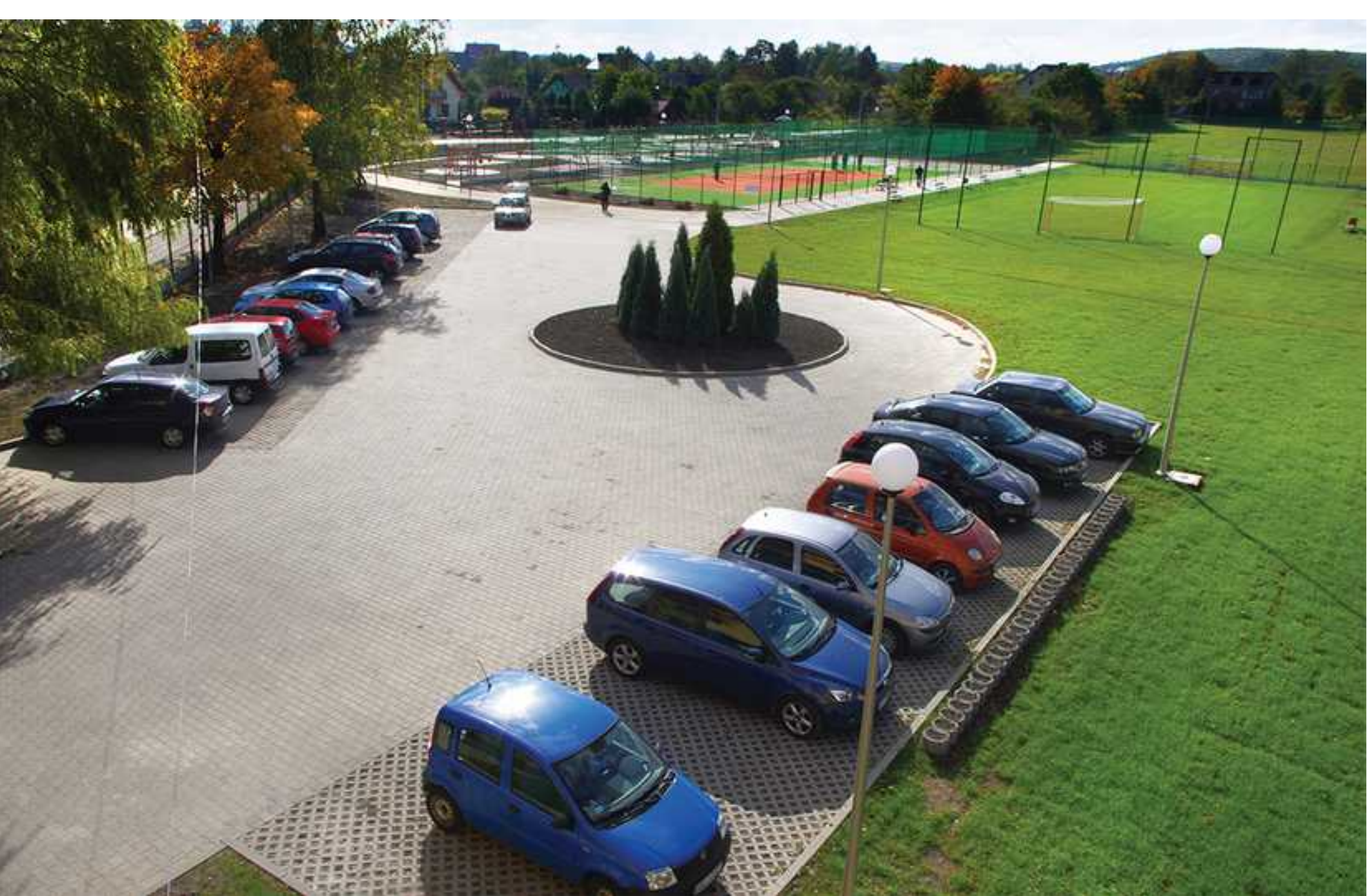
Wykonany kompleks sportowo-rekreacyjny za OPS w Psarach
