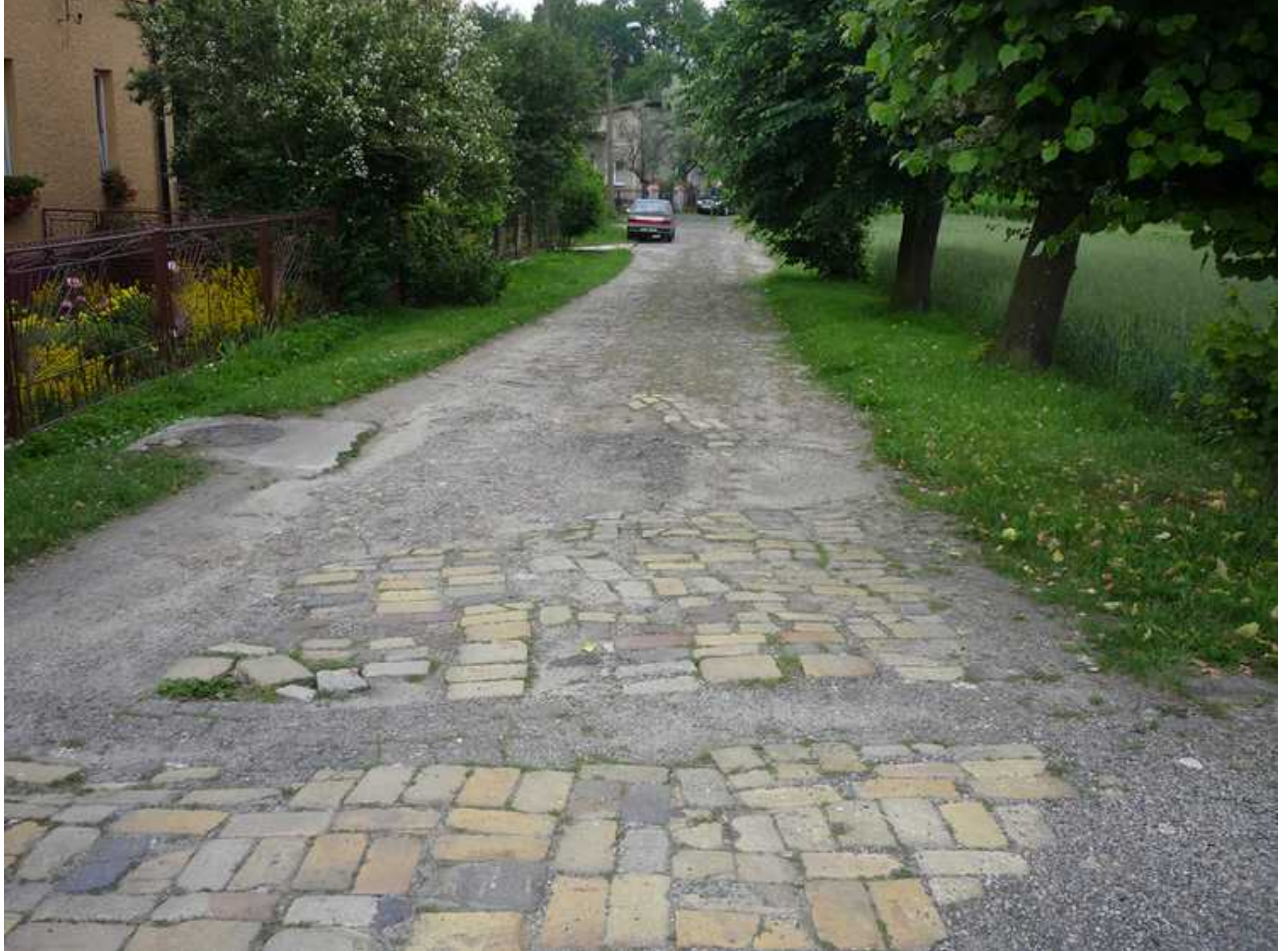
Ulica Dojazdowa w Gródkowie przed remontem
