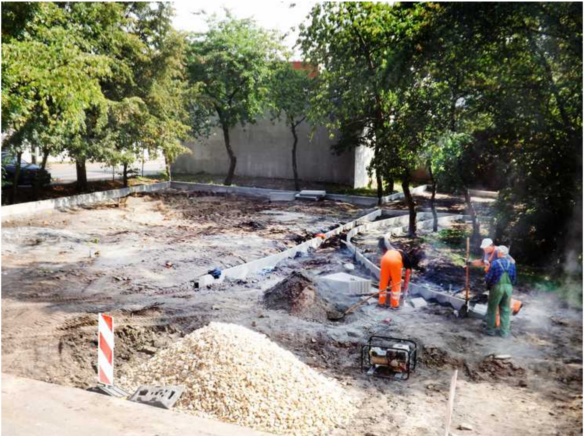
Prace nad zagospodarowaniem terenu przy budynku OSP w Sarnowie
