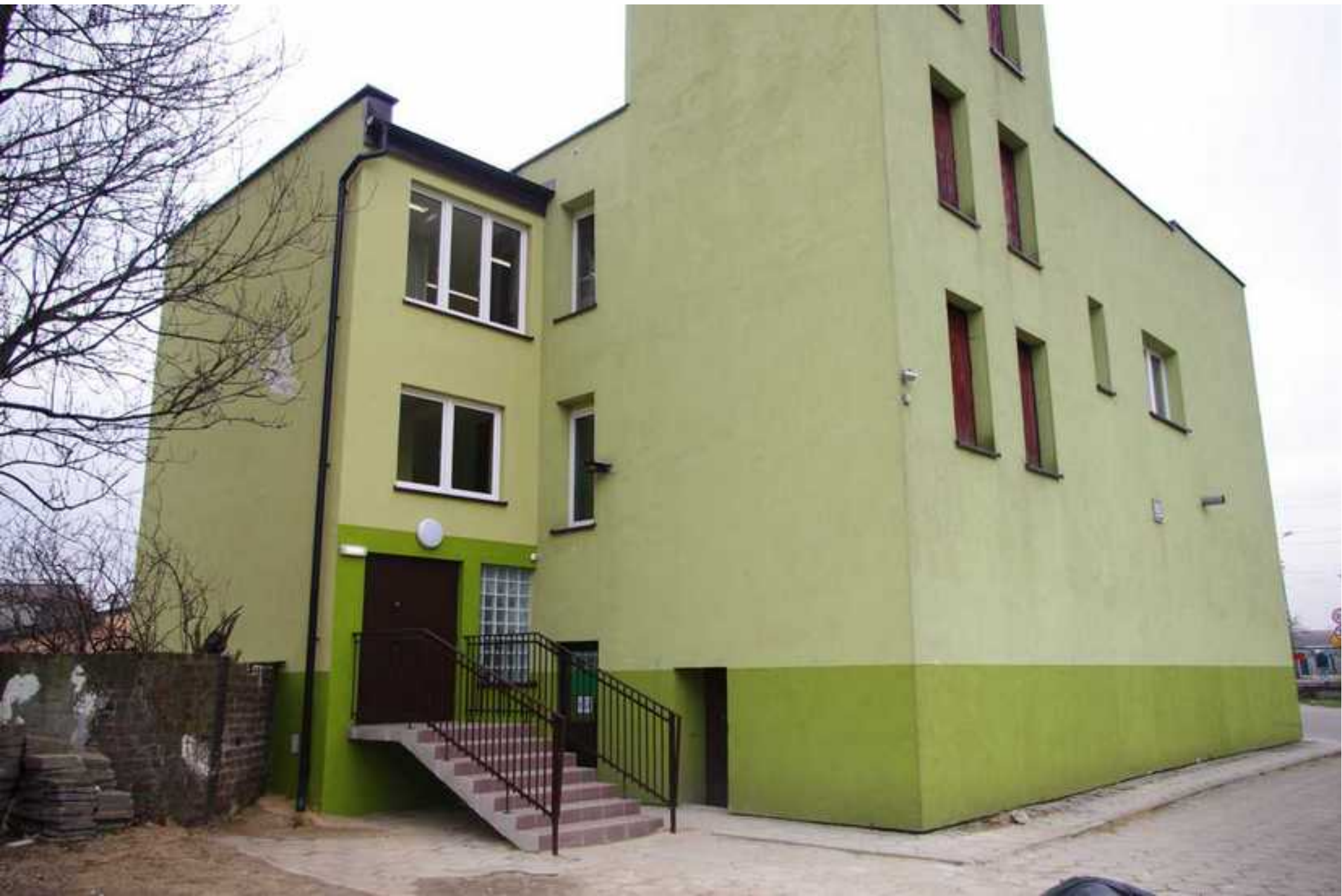
Biblioteka w Psarach po zakończeniu prac budowlanych
