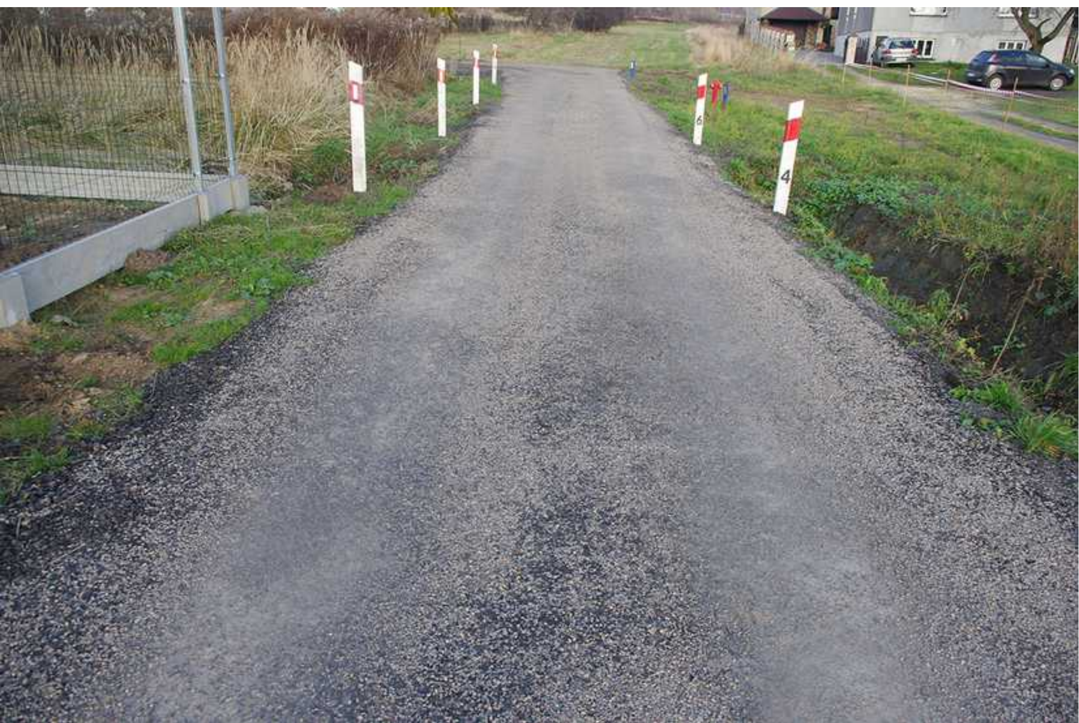
Ulica Szosowa w Strzyżowicach po remoncie
