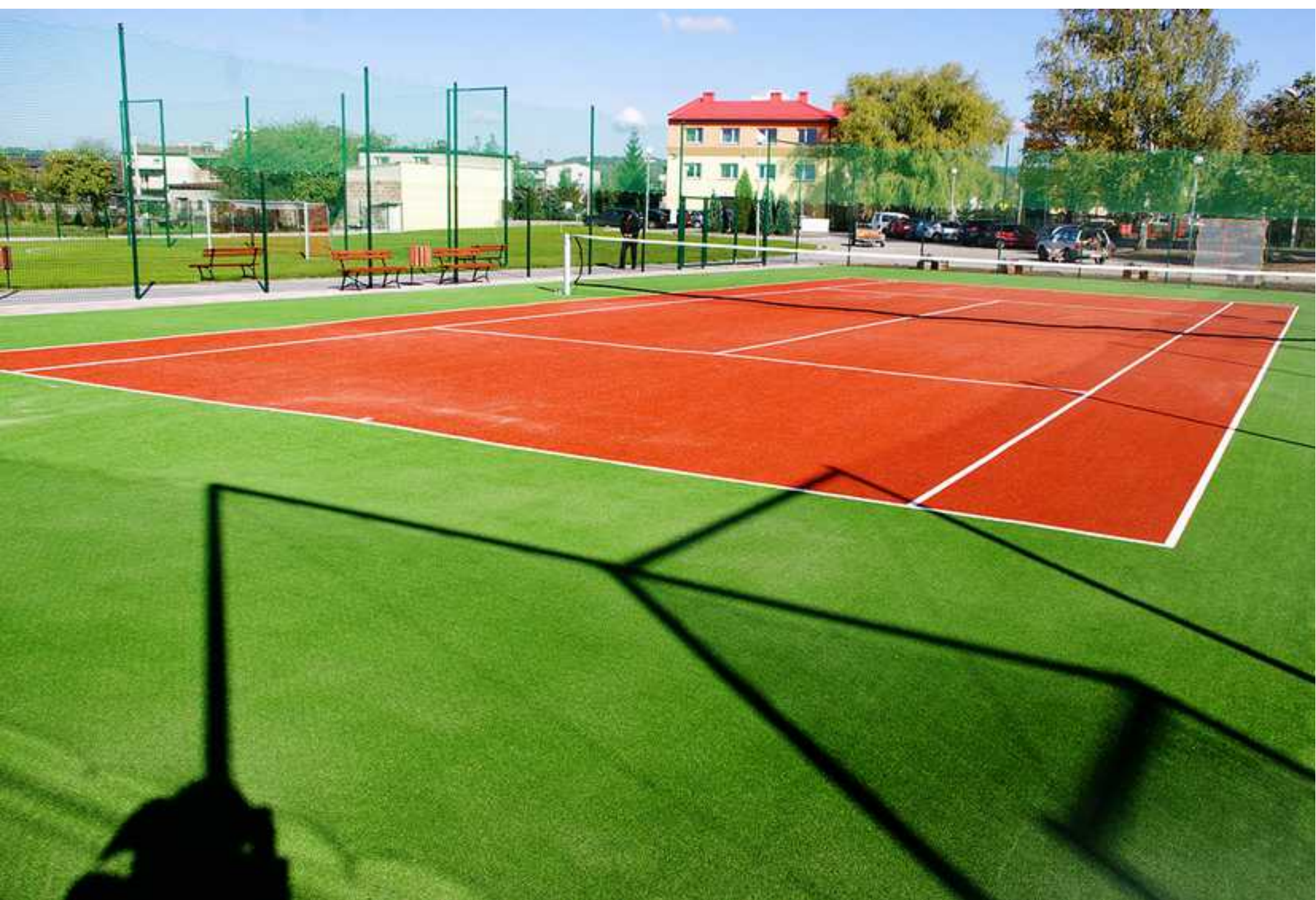
Wykonany kompleks sportowo-rekreacyjny za OPS w Psarach
