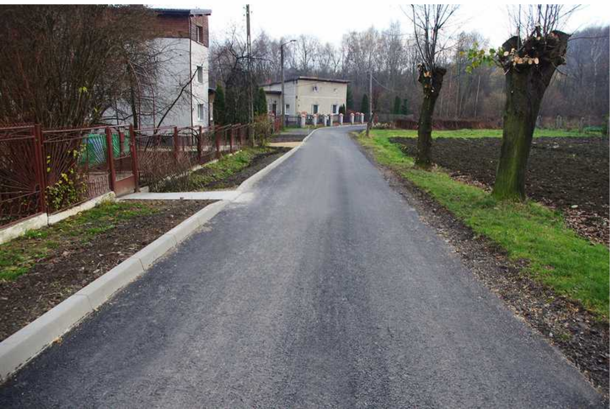
Ulica Dojazdowa w Gródkowie po remoncie
