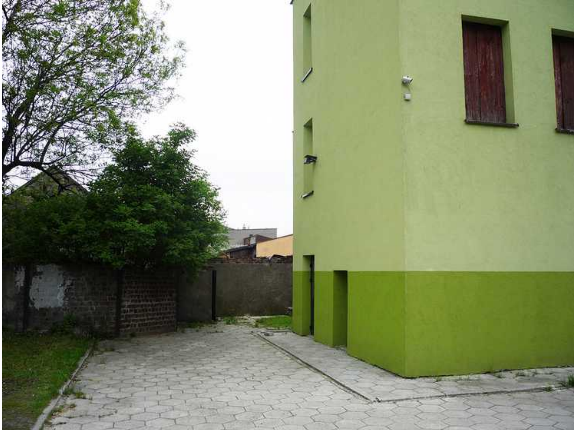
Biblioteka w Psarach przed rozbudową
