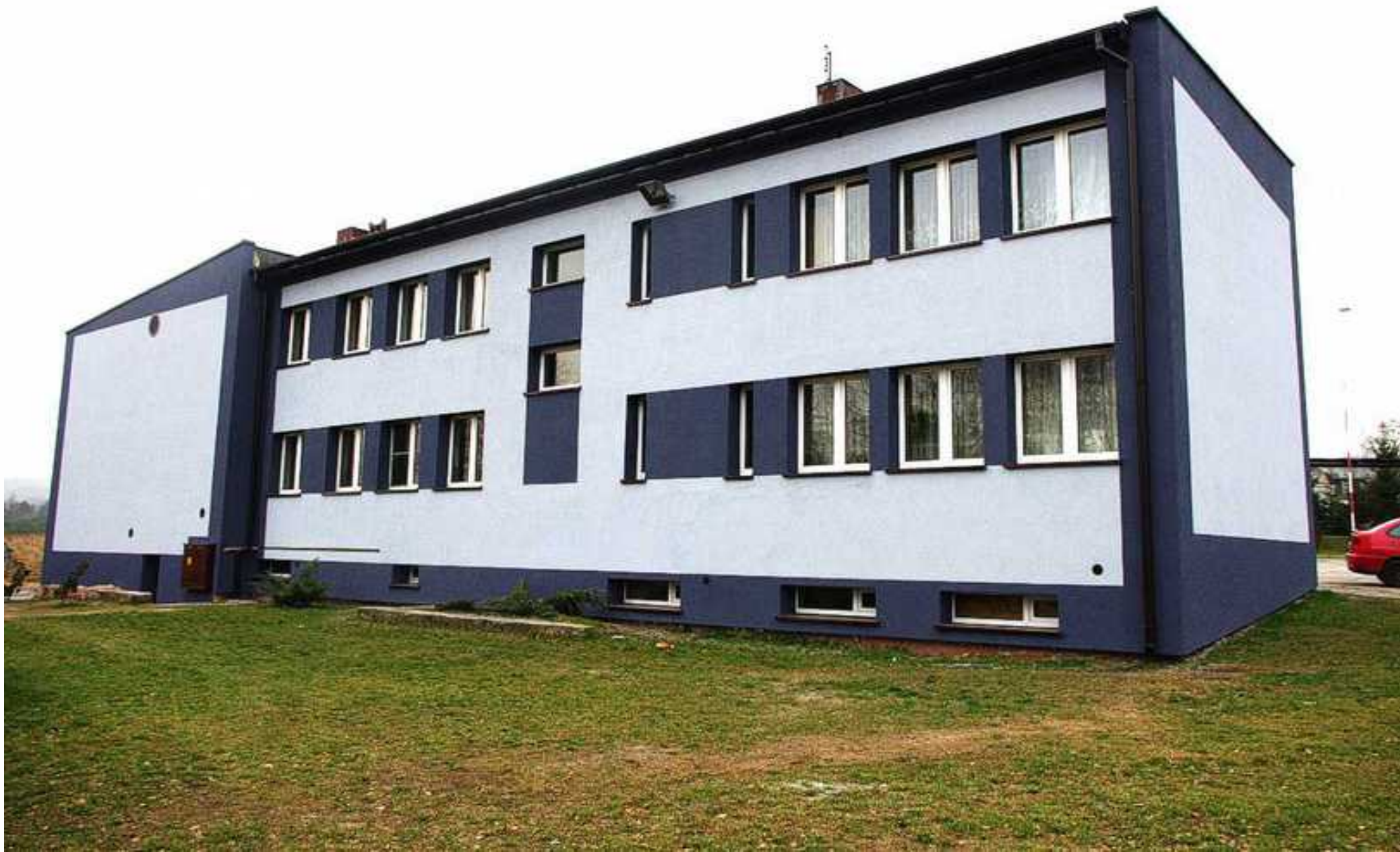
Wykonana termomodernizacja budynku OSP w Dąbiu
