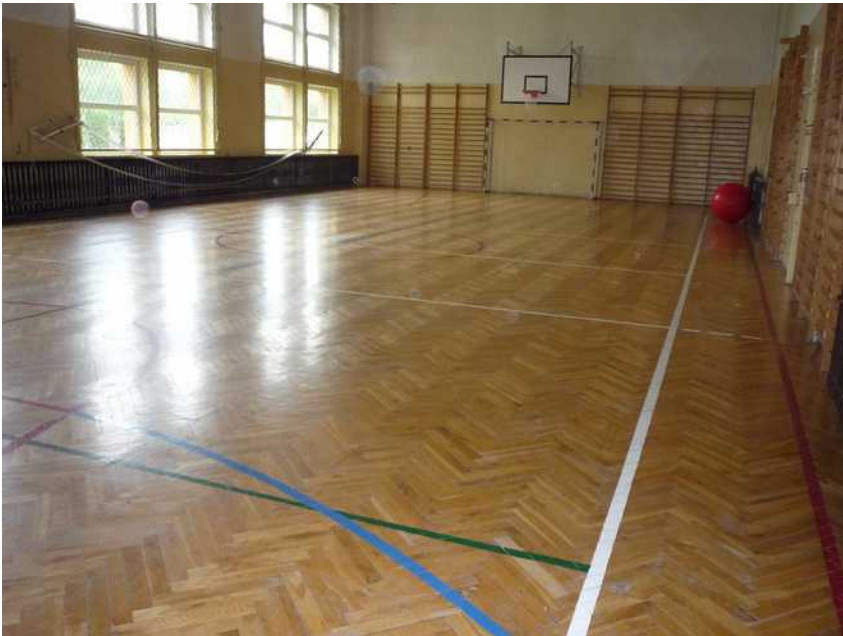
Sala gimnastyczna w Dąbiu przed wymianą podłogi
