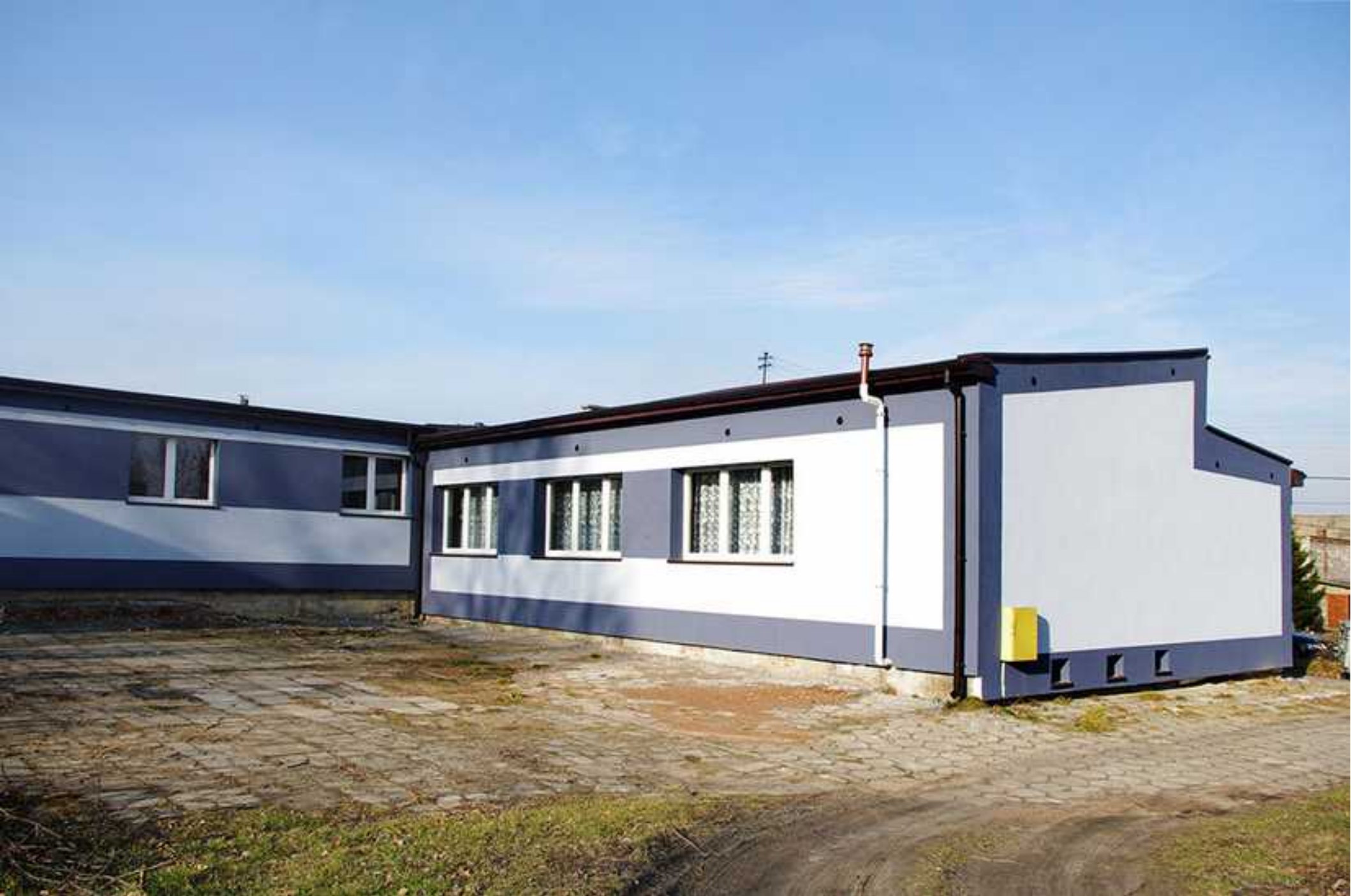
Budynek byłej szkoły w Malinowicach po termomodernizacji
