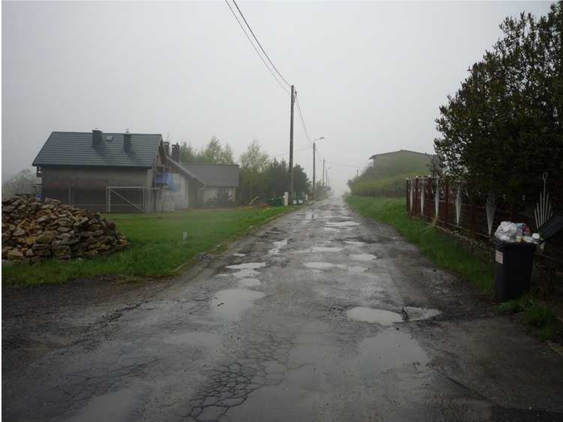
Ulica Górna w Górze Siewierskiej przed remontem
