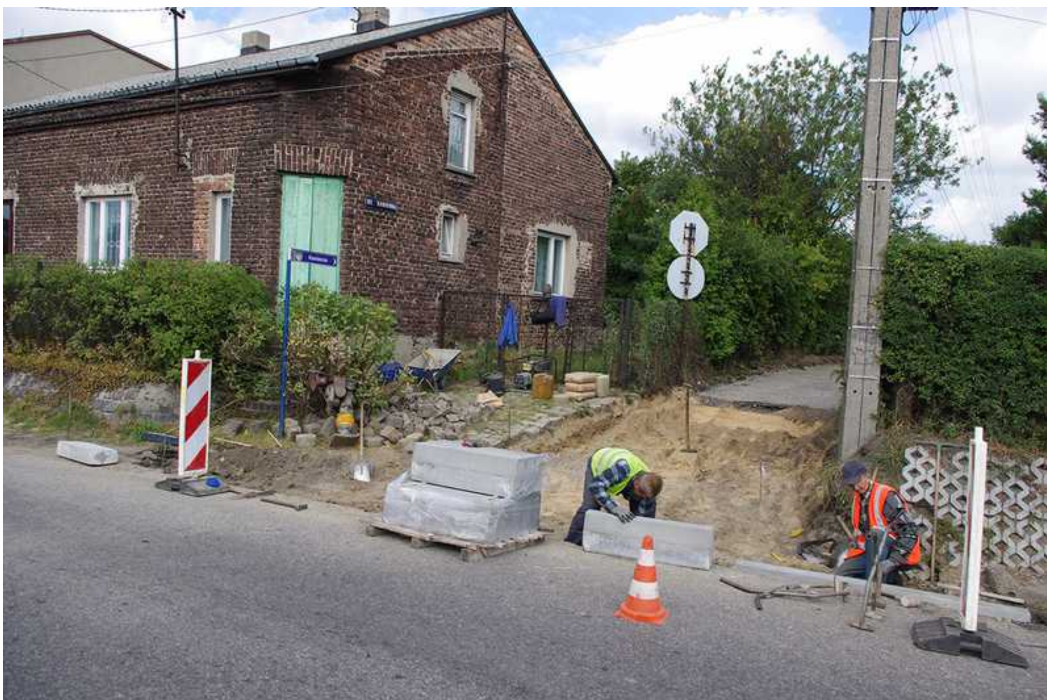
Ulica Kamienna w Sarnowie w trakcie prac
