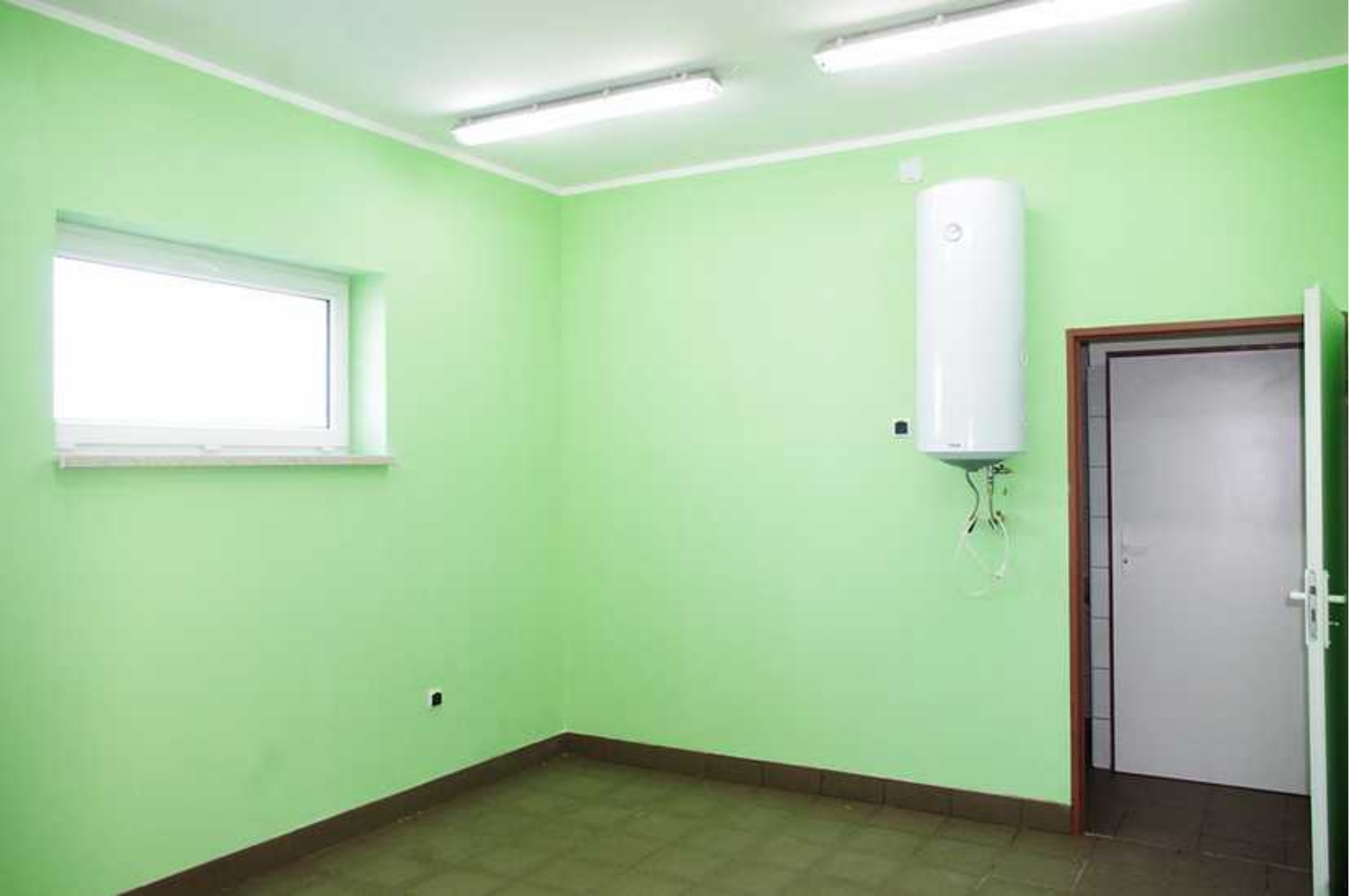
Wnętrze szatni Błyskawicy Preczów po remoncie
