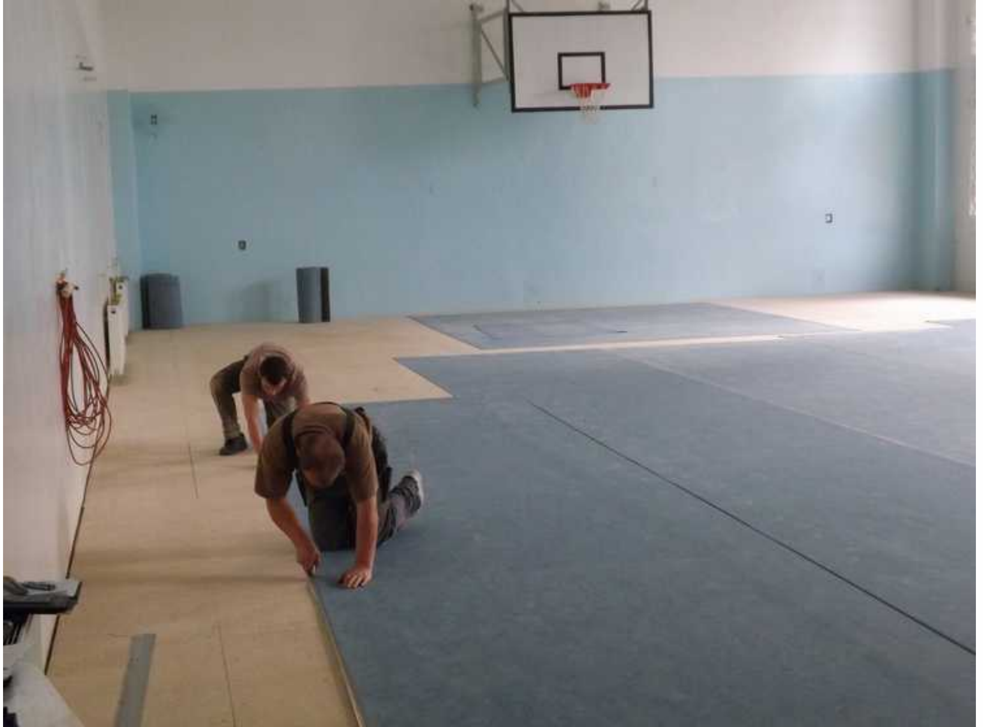
Prace nad wymianą podłogi na sali gimnastycznej w Dąbiu
