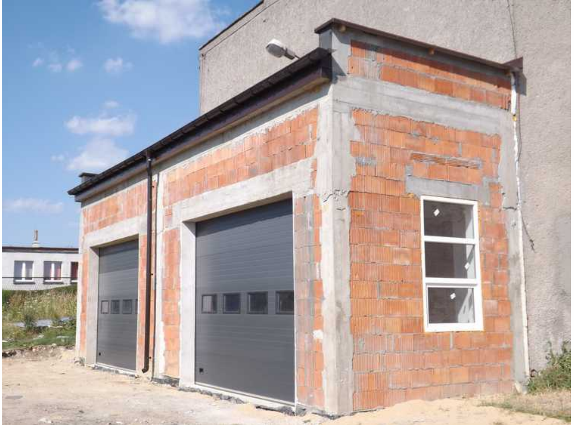
Garaże w budynku OSP w Górze Siewierskiej w trakcie rozbudowy
