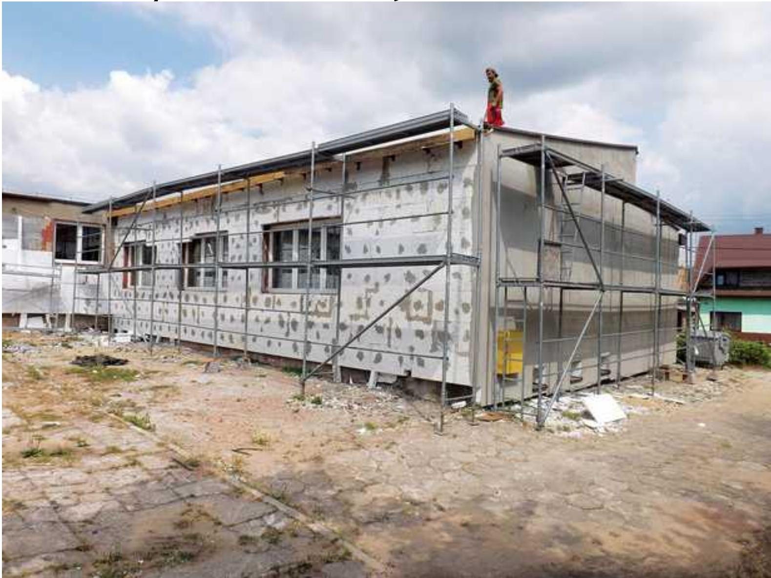
Budynek byłej szkoły w Malinowicach podczas prac
