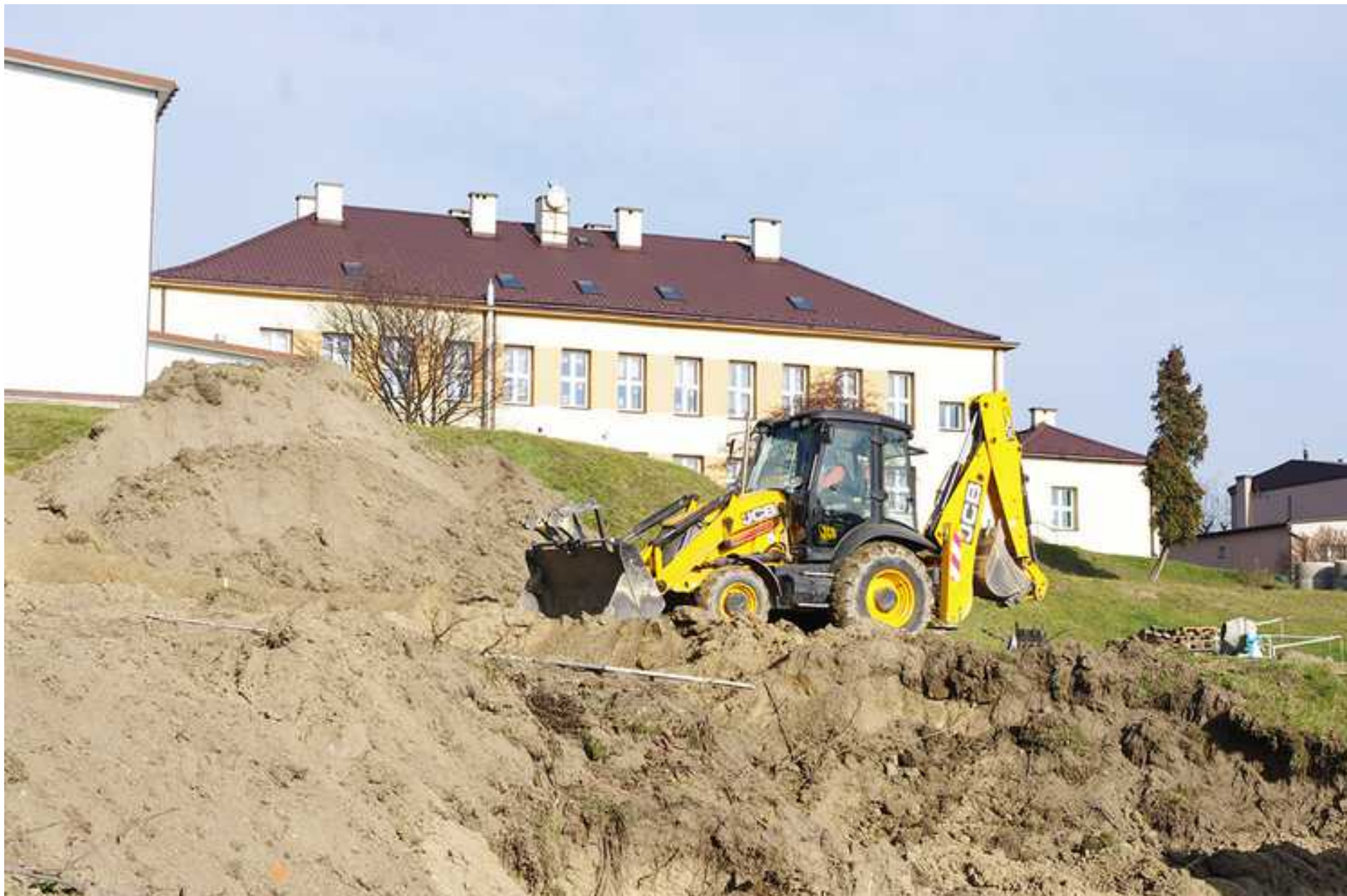
Prace nad zagospodarowaniem terenu za Szkołą Podstawową w Sarnowie
