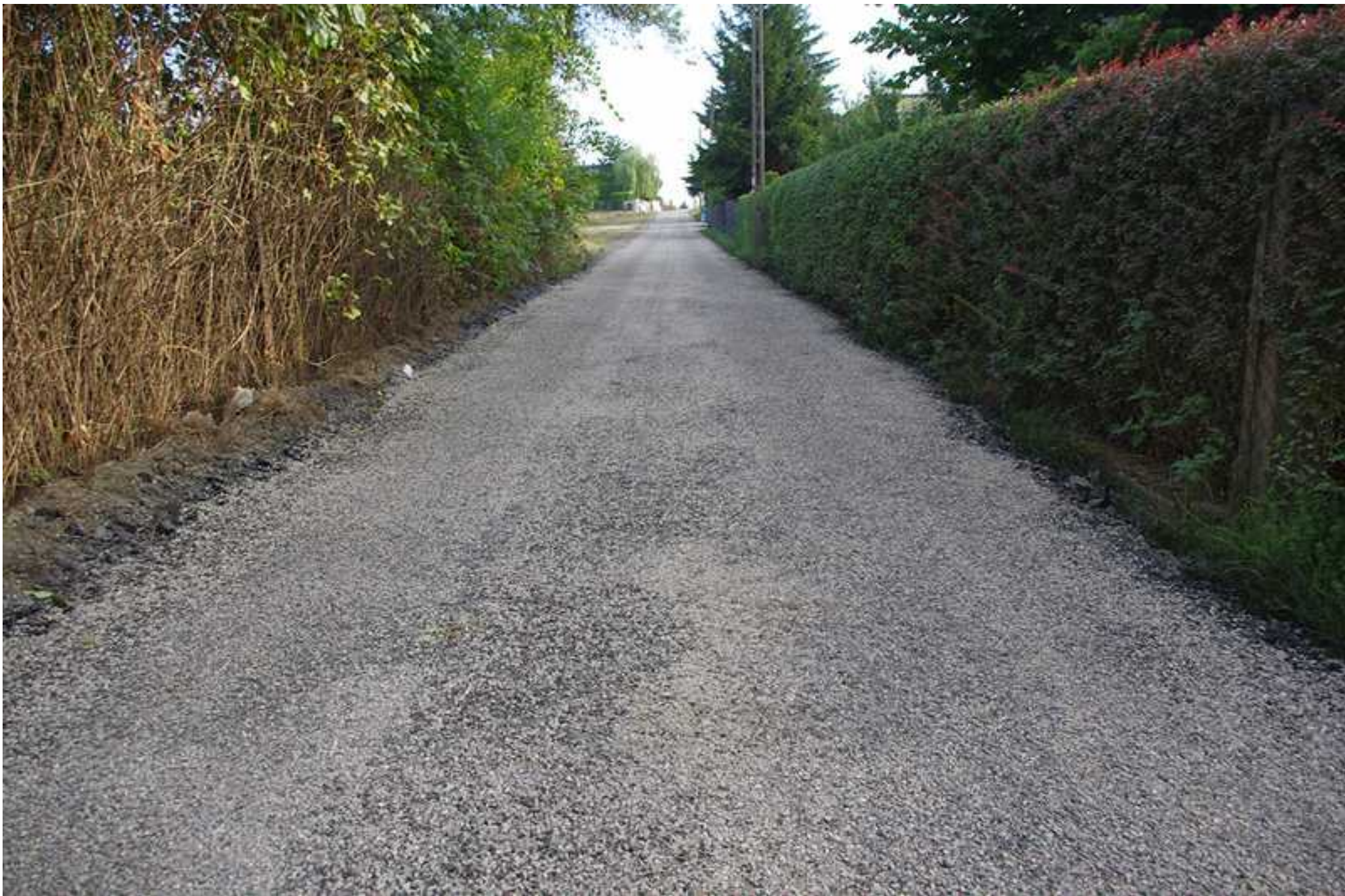
Ulica Kamienna w Sarnowie po remoncie
