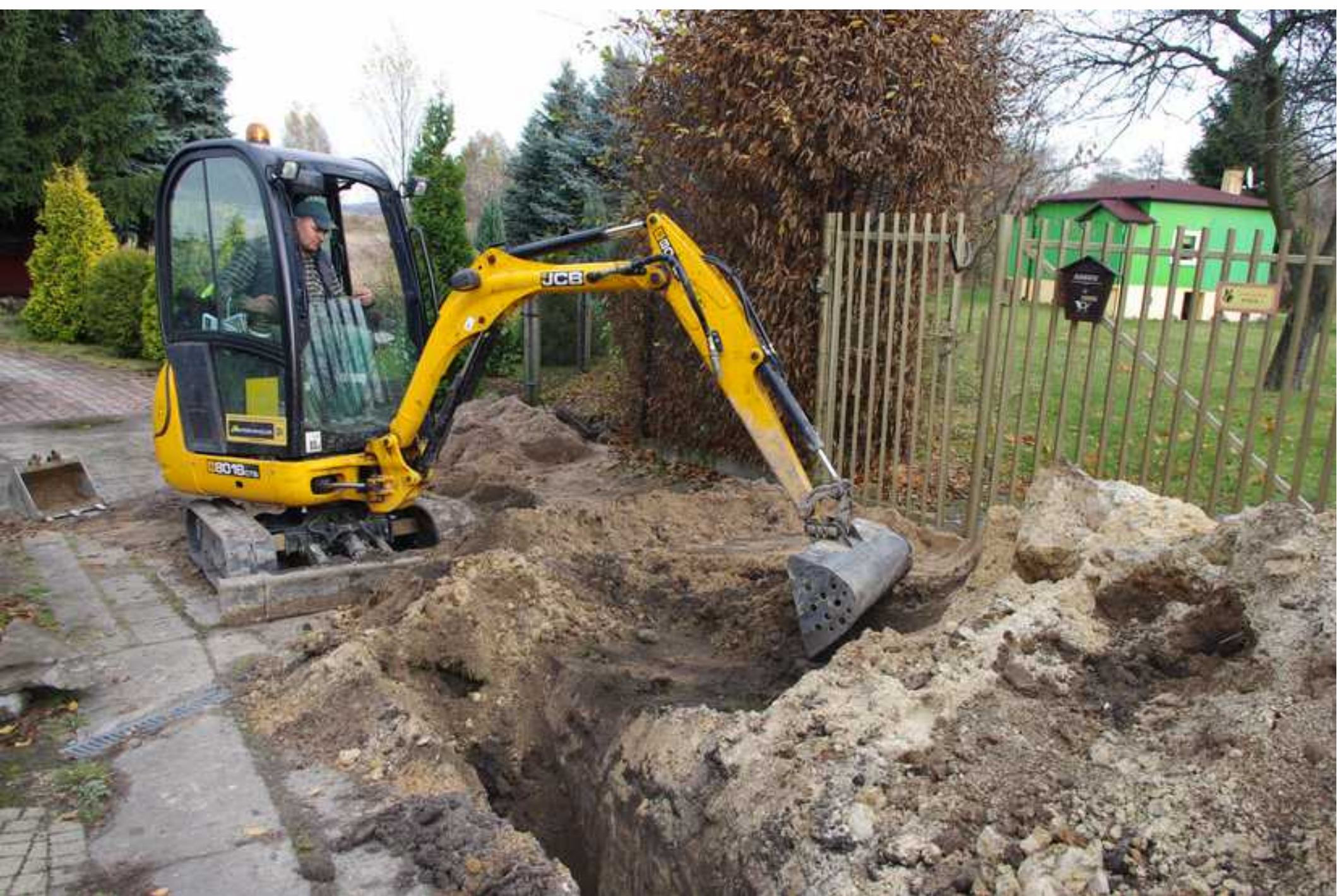
Prace na ulicy Zielonej w Preczowie
