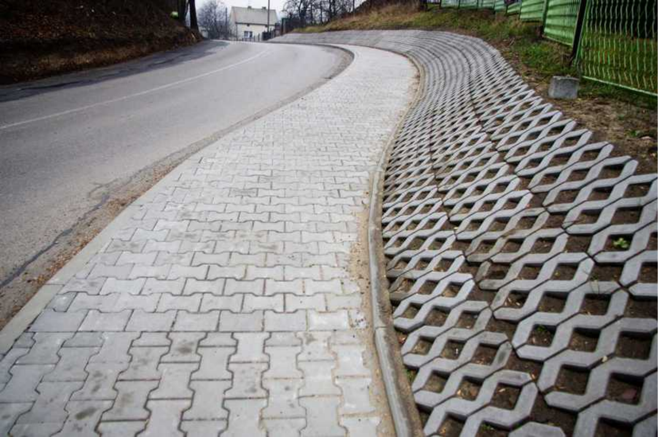
Gotowy chodnik przy ulicy Wiejskiej w Malinowicach
