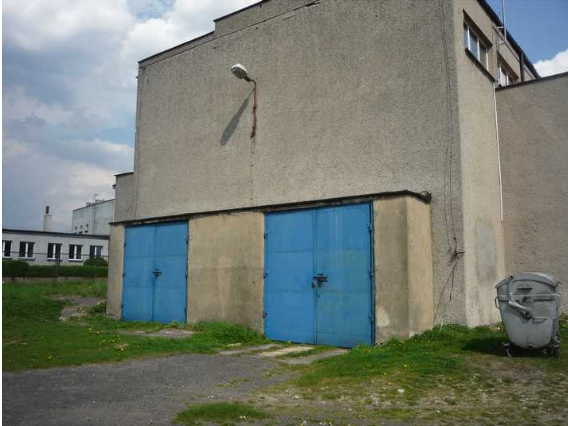
Garaże w budynku OSP w Górze Siewierskiej przed rozbudową
