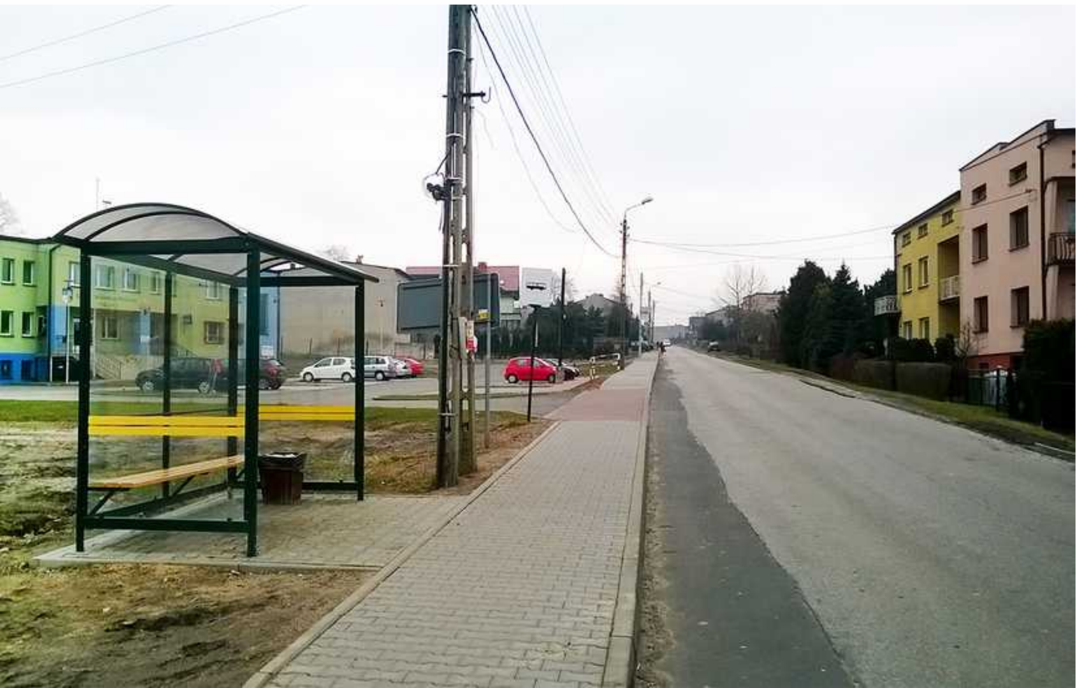
Nowa wiata przystankowa oraz chodnik przy ulicy Belnej w Strzyżowicach
