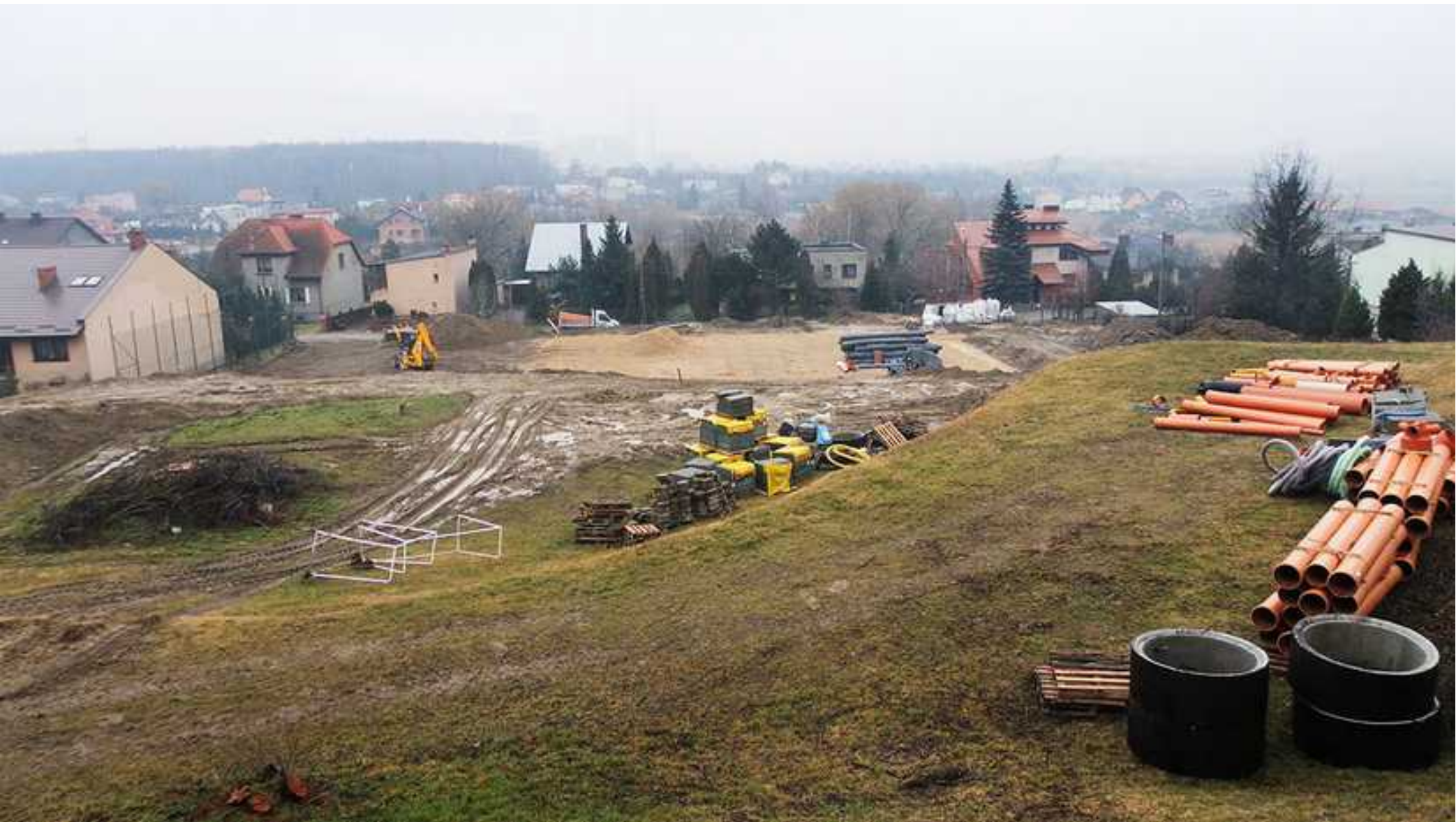
Prace nad zagospodarowaniem terenu za Szkołą Podstawową w Sarnowie
