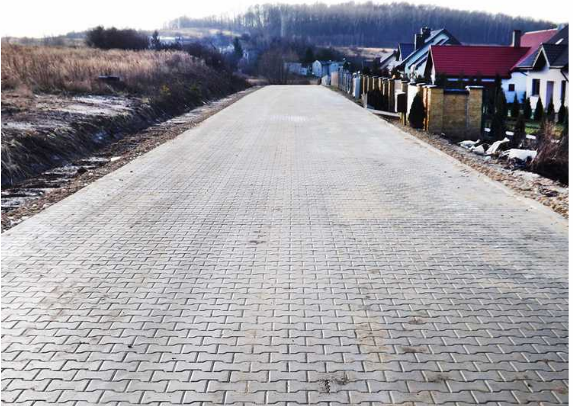
Ulica Irysów w Psarach po remoncie
