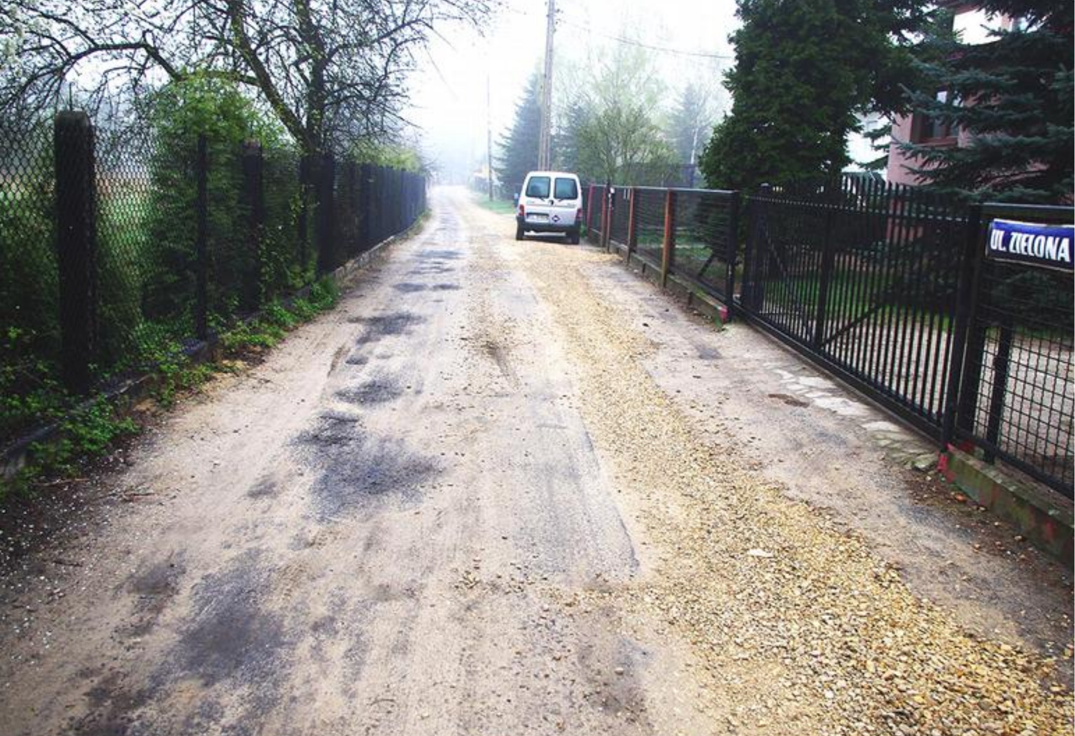
Ulica Zielona w Preczowie przed rozpoczęciem inwestycji.
