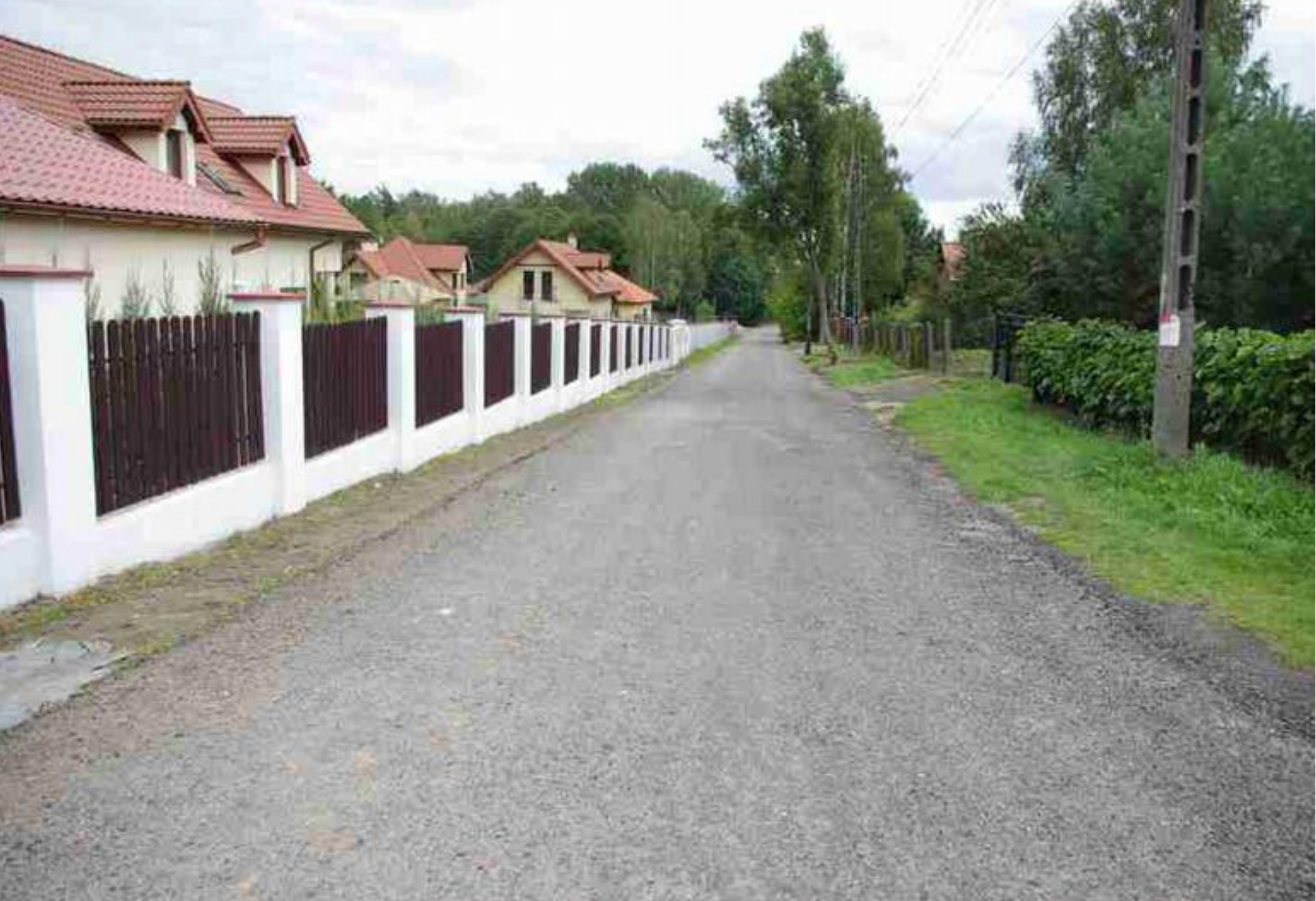
Ulica Wschodnia w Gródkowie po wykonaniu prac.
