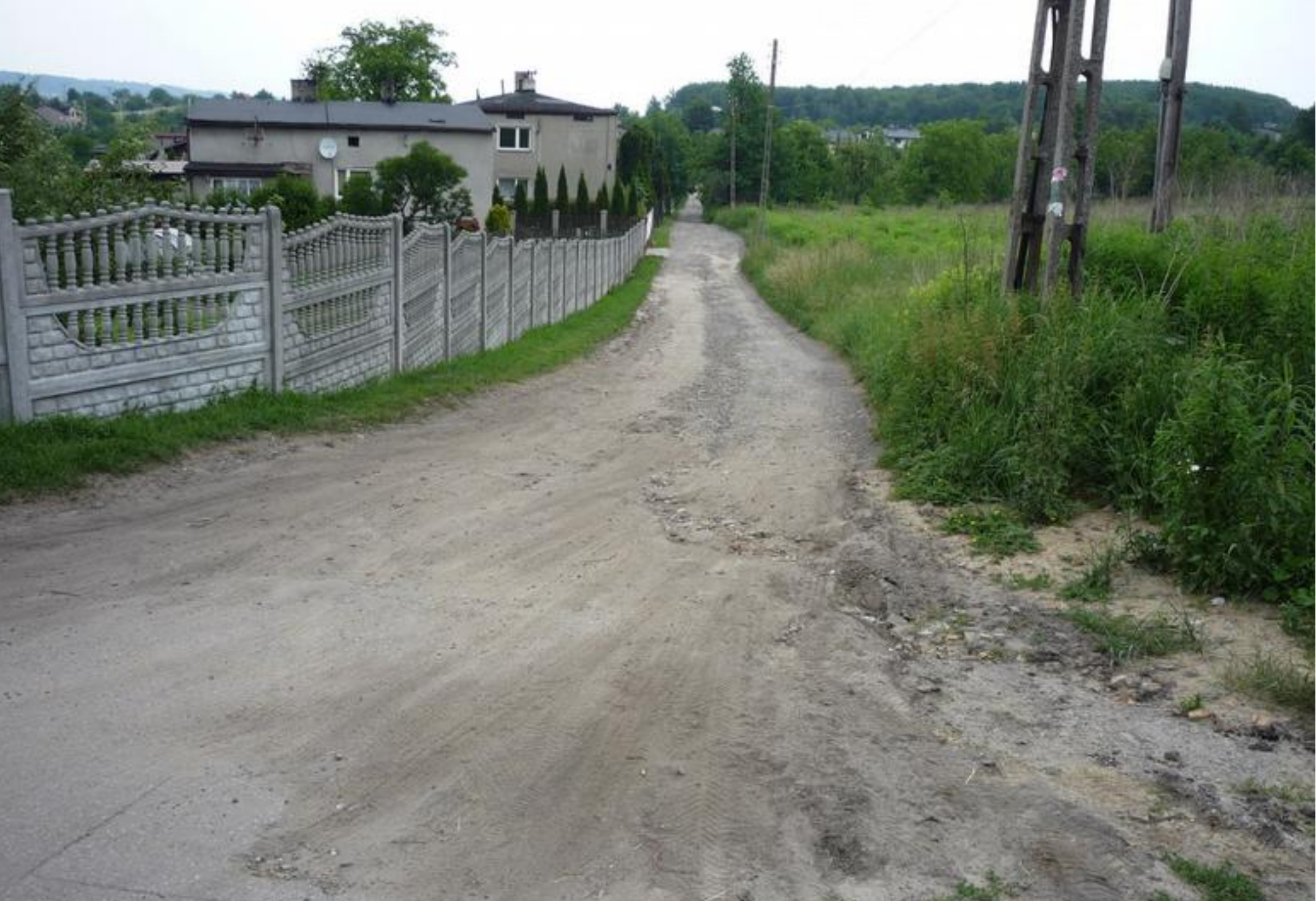
Ulica Kwiatowa w Gródkowie przed pracami remontowymi.
