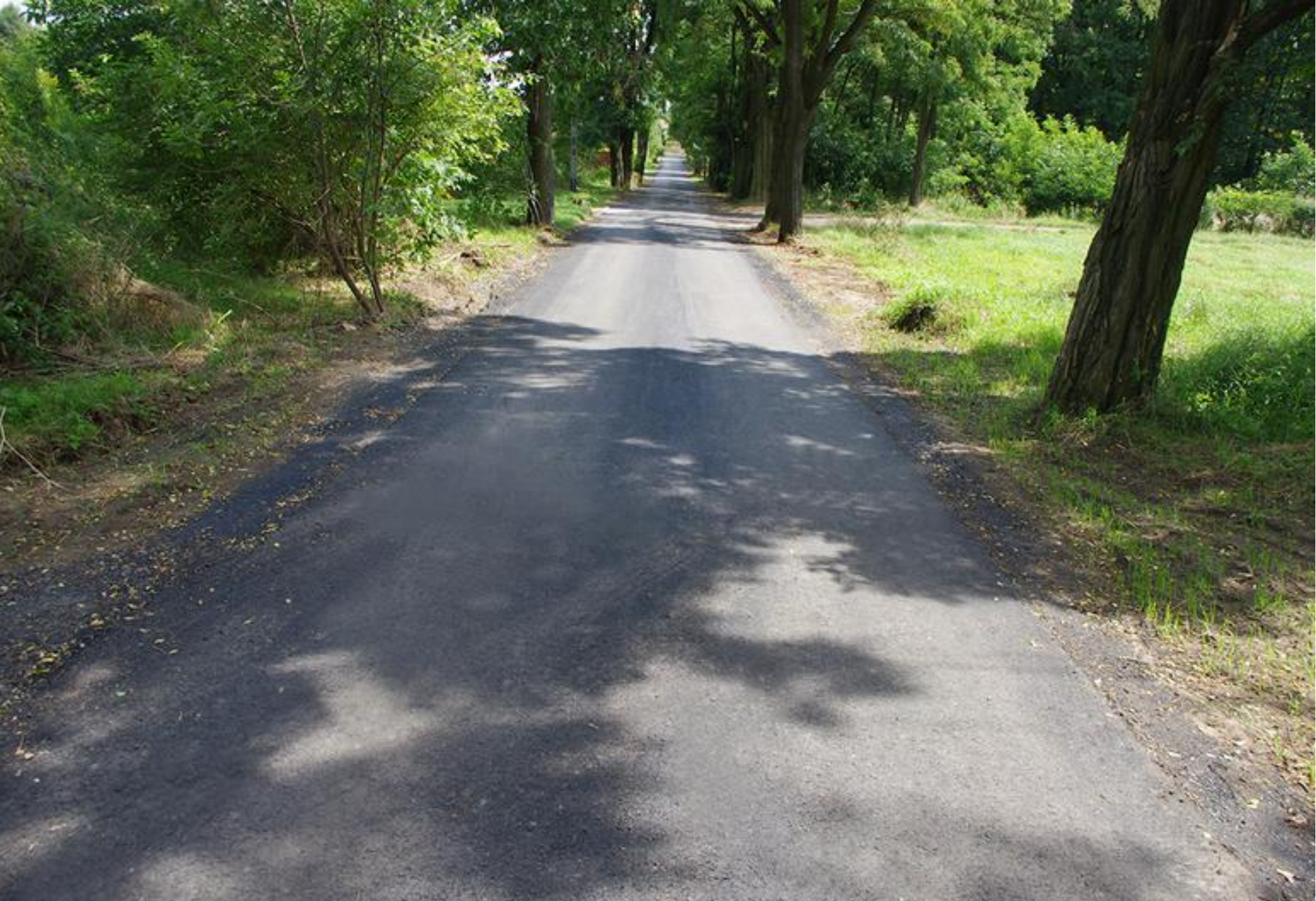
Nowa nakładka asfaltowa na ul. Parkowej.
