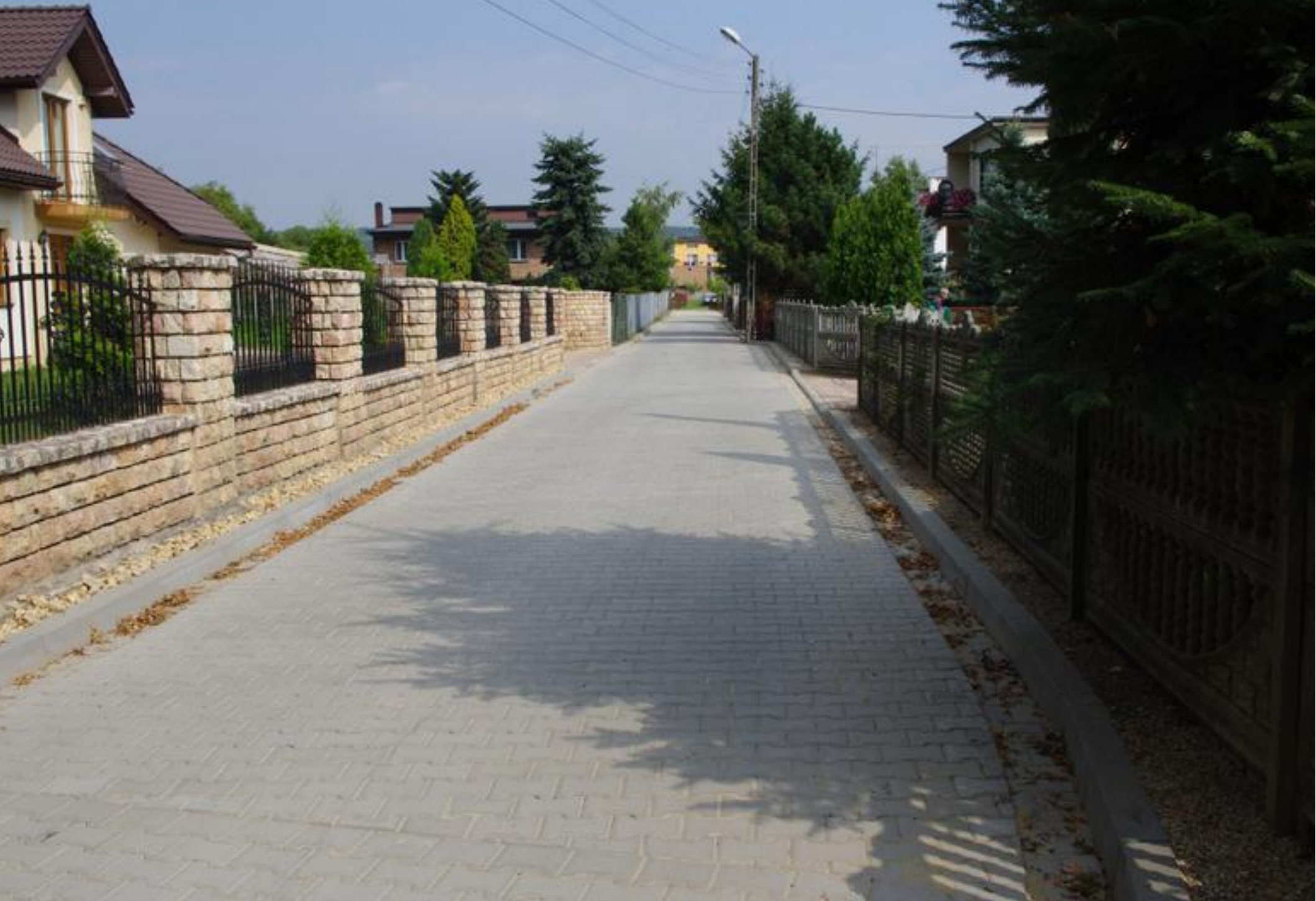
Ulica Reymonta po zakończeniu prac.
