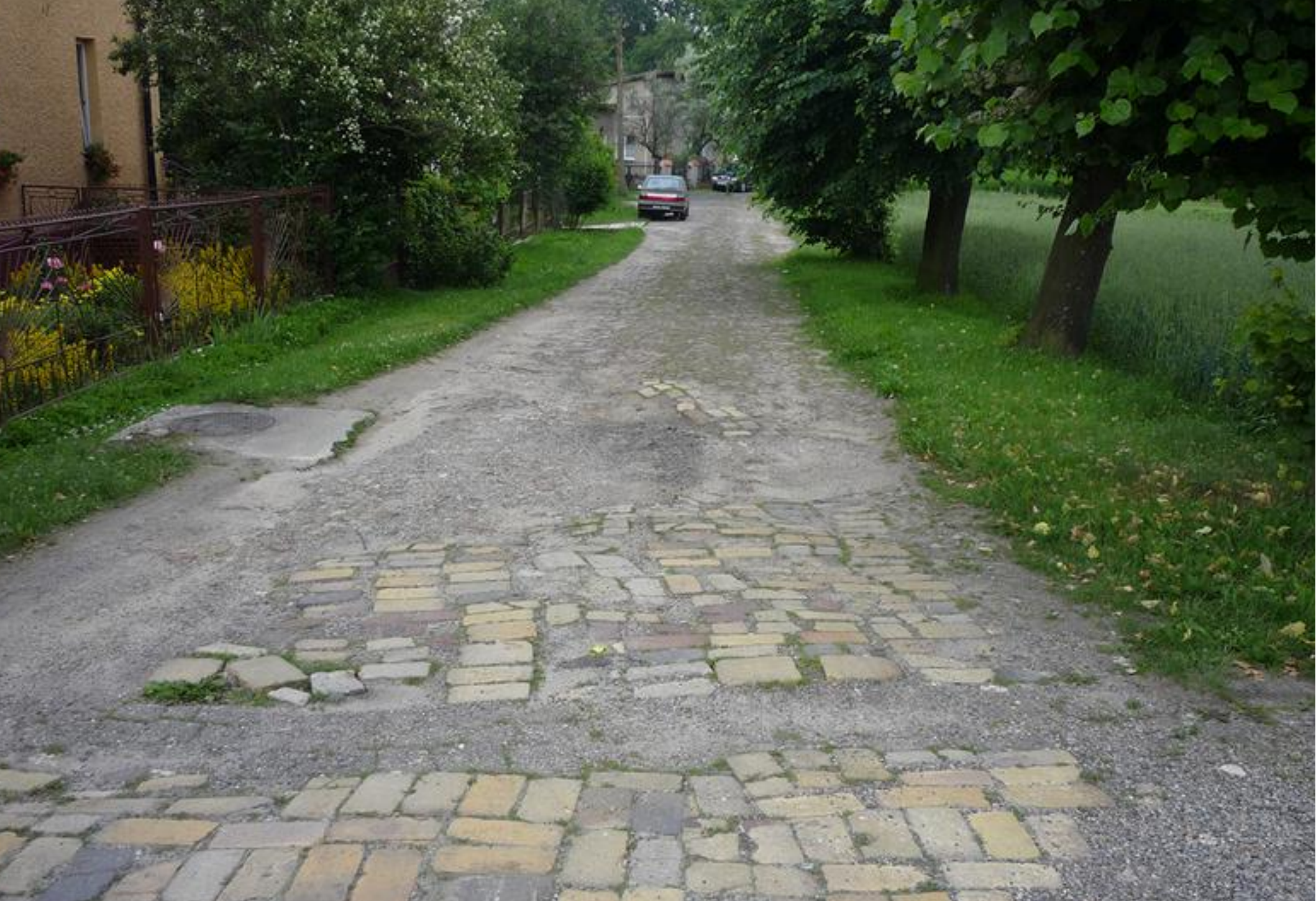
Ulica Dojazdowa w Gródkowie przed remontem.
