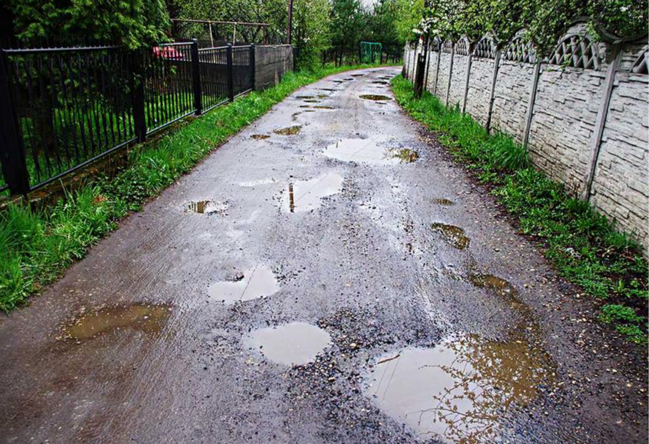
Ulica Bocznej w Strzyżowicach przed rozpoczęciem inwestycji.
