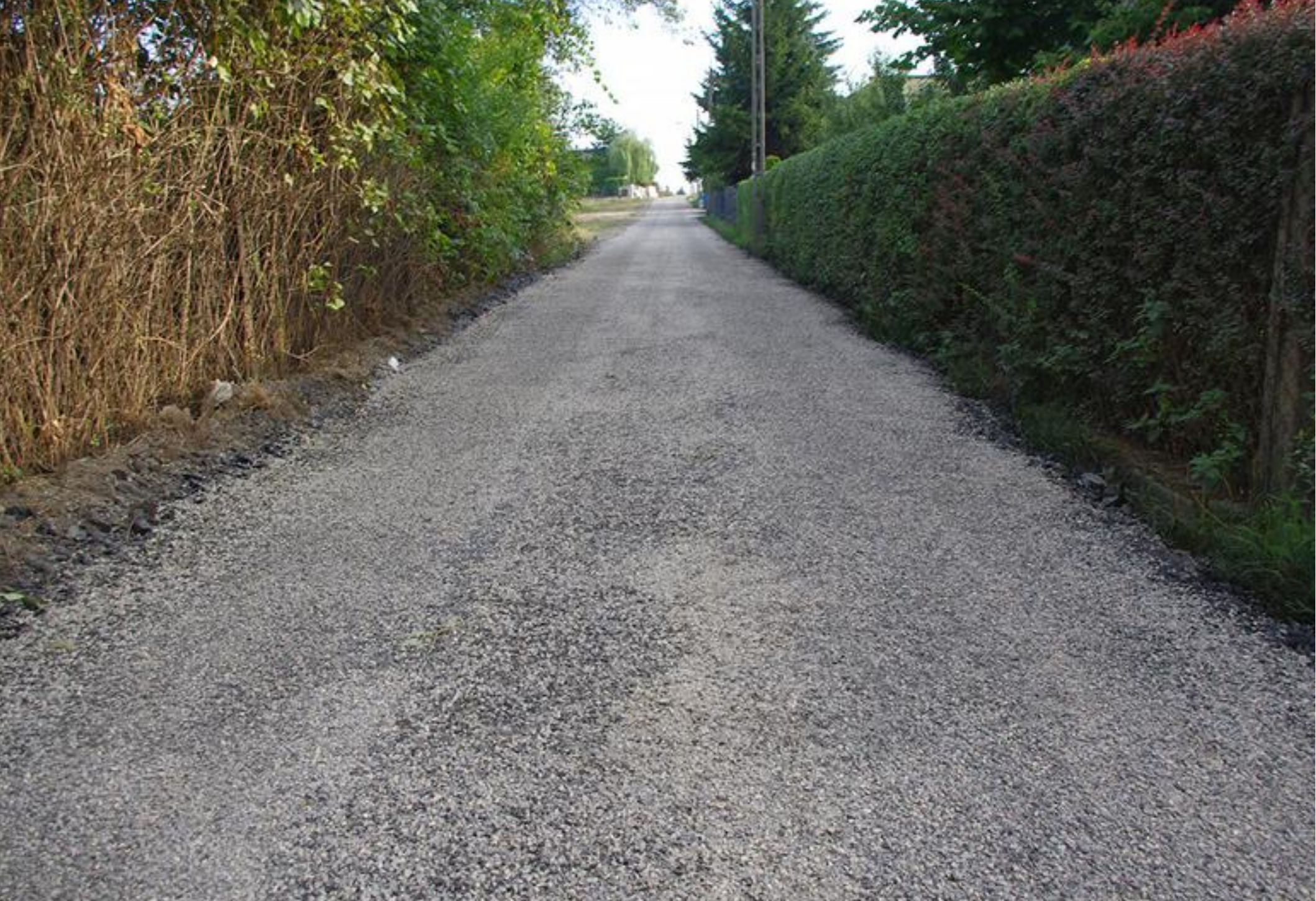
Ulica Kamienna w Sarnowie po zakończeniu remontu.
