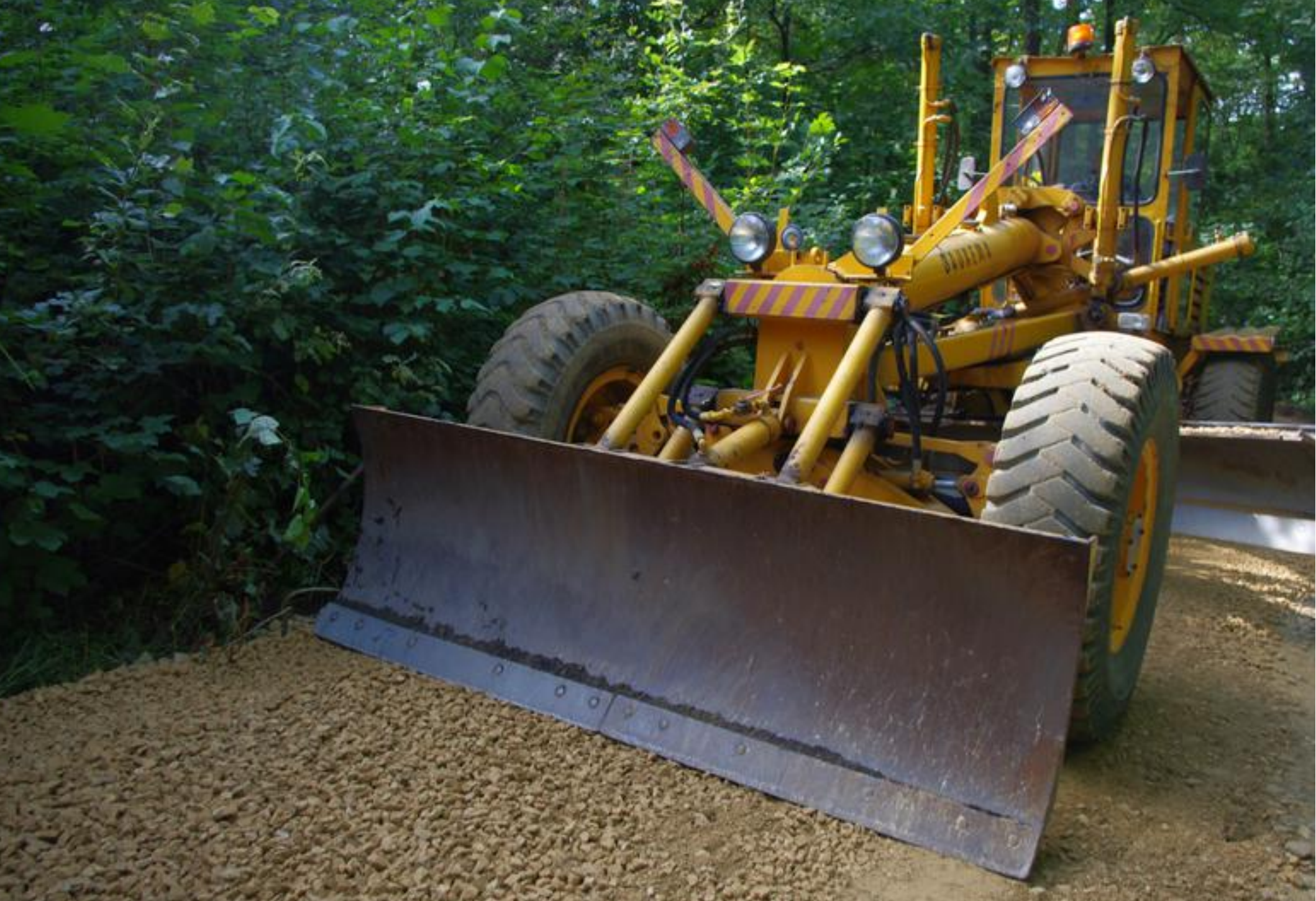
Prace na ulicy Leśnej w Gródkowie.
