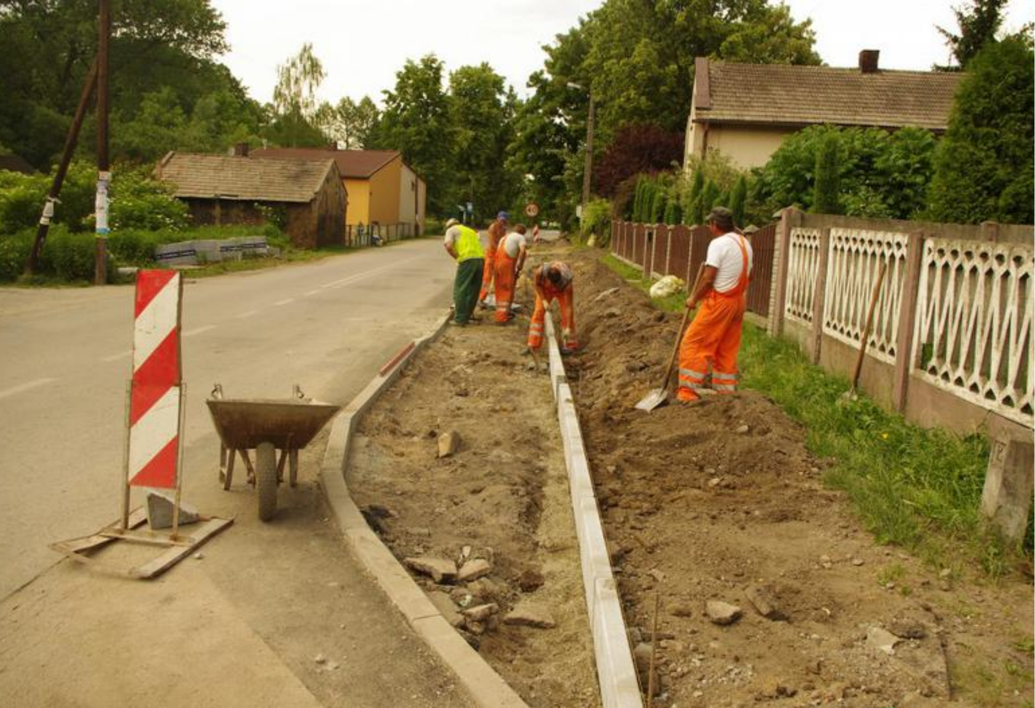
Prace przy budowie chodnika przy ulicy Wiejskiej w Malinowicach.
