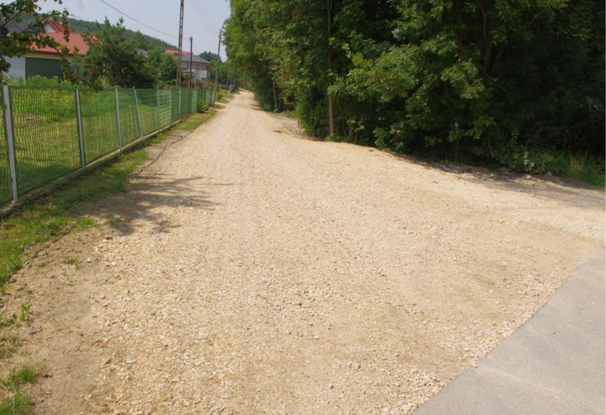
Utwardzona kruszywem ulica Spokojna w Gródkowie.
