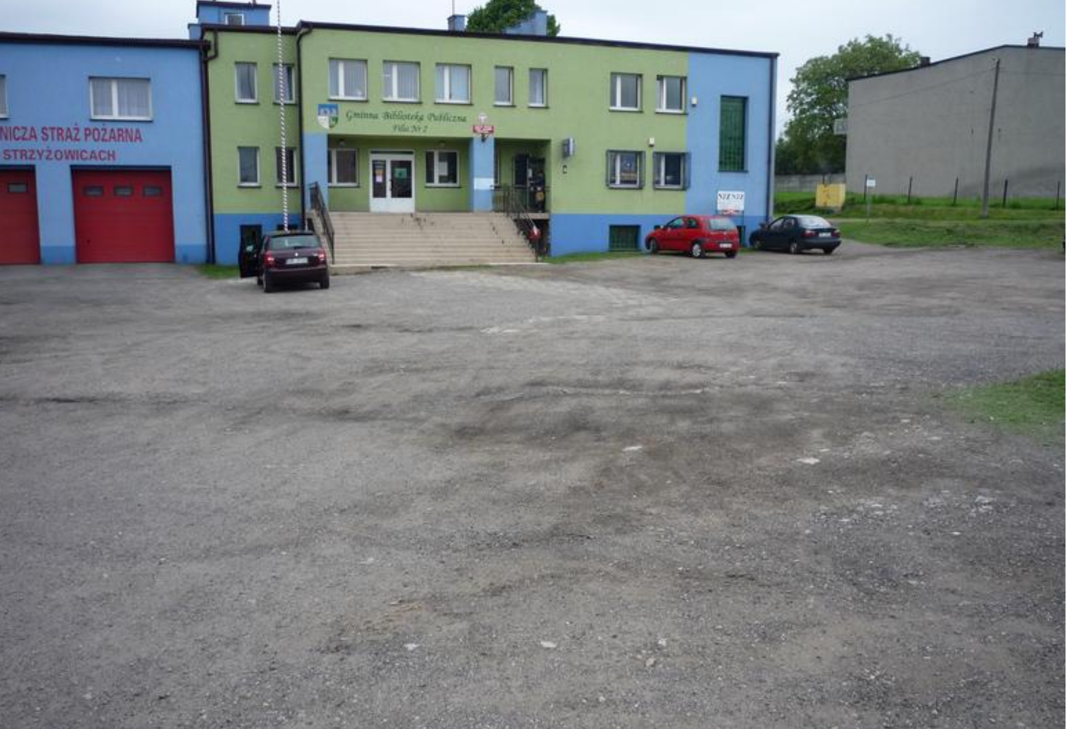
Plac przed remizą OSP w Strzyżowicach przed zagospodarowaniem.
