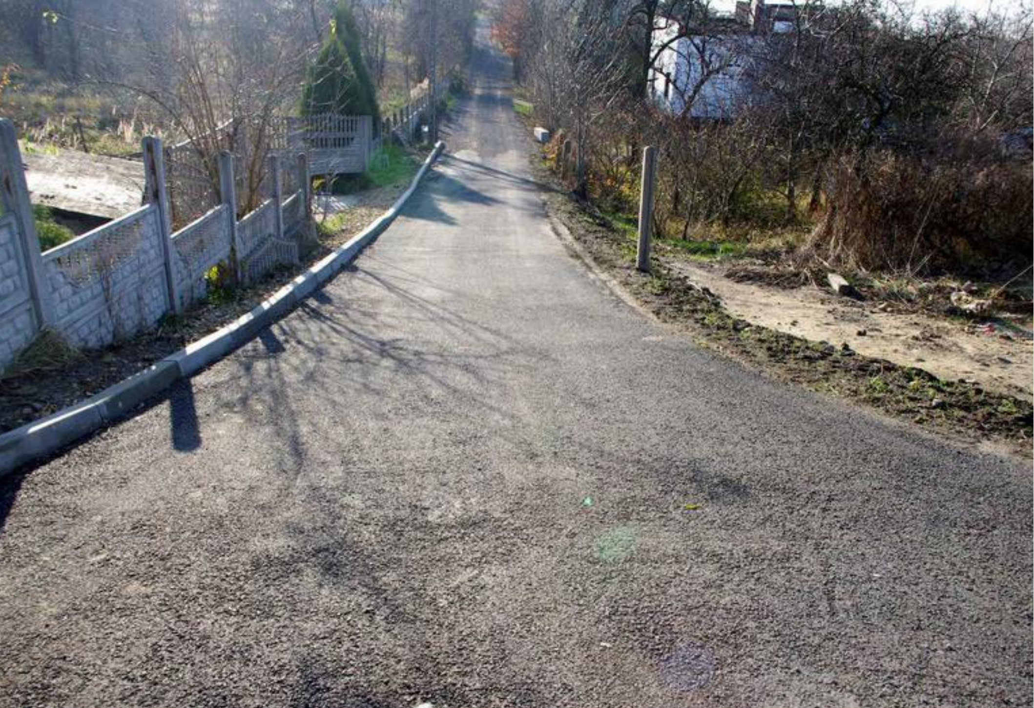
Ulica Kwiatowa w Gródkowie po wykonaniu prac.
