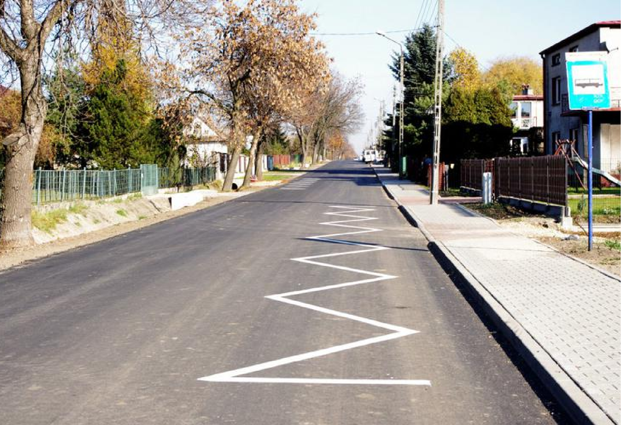
Ulica Graniczna po przebudowie.
