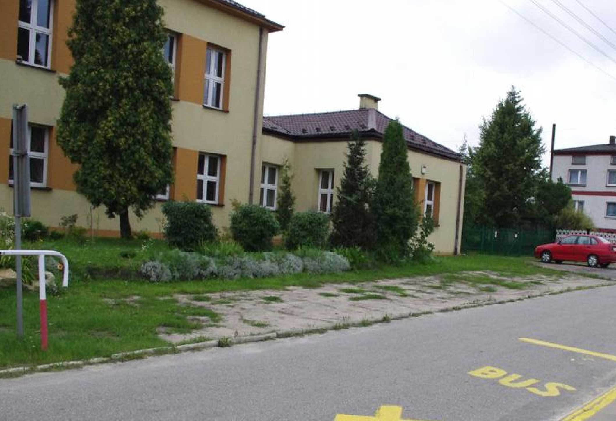
Przed modernizacją parkingu przy szkole w Sarnowie.
