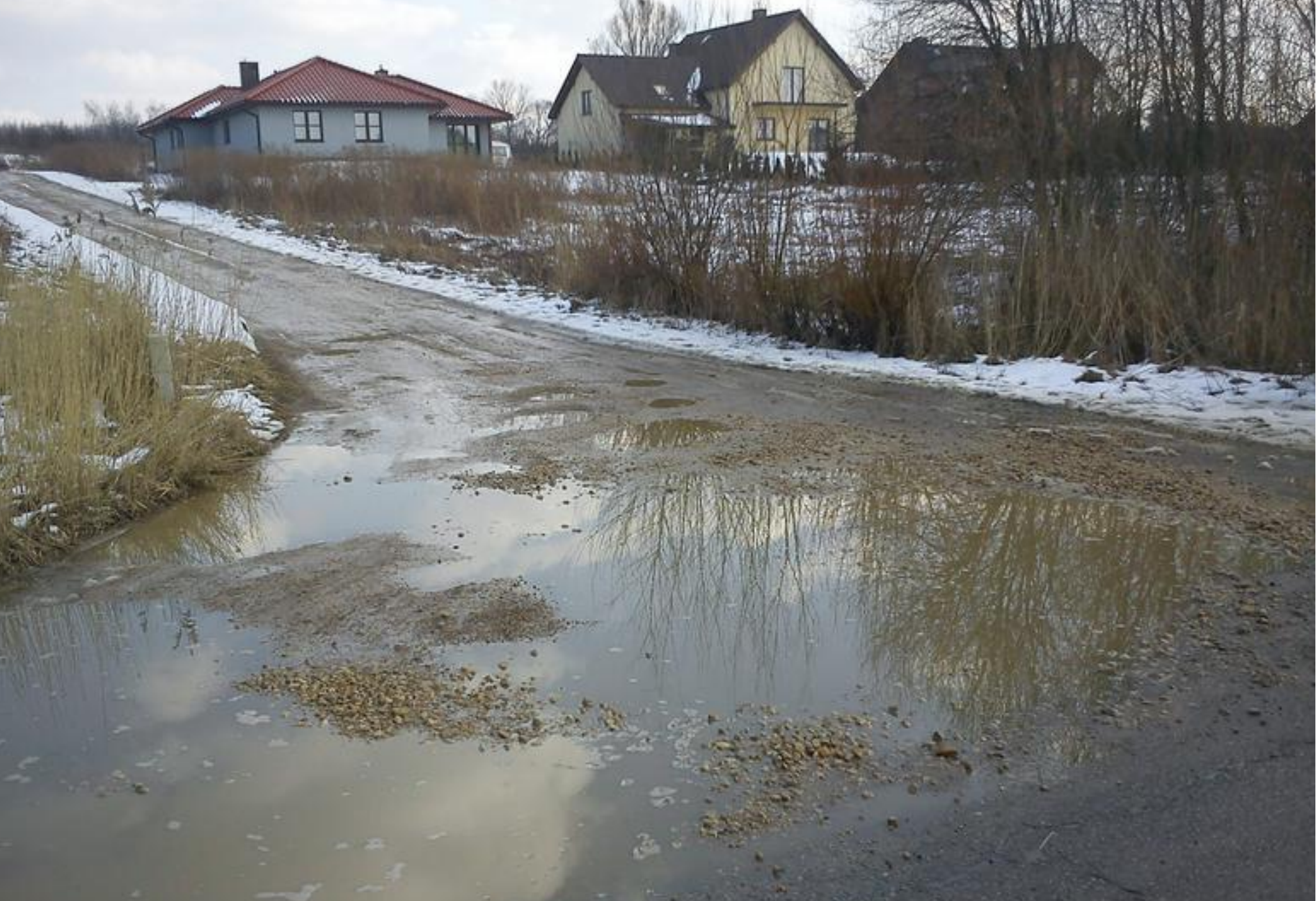
Ulica Irysów w Psarach przed rozpoczęciem inwestycji.
