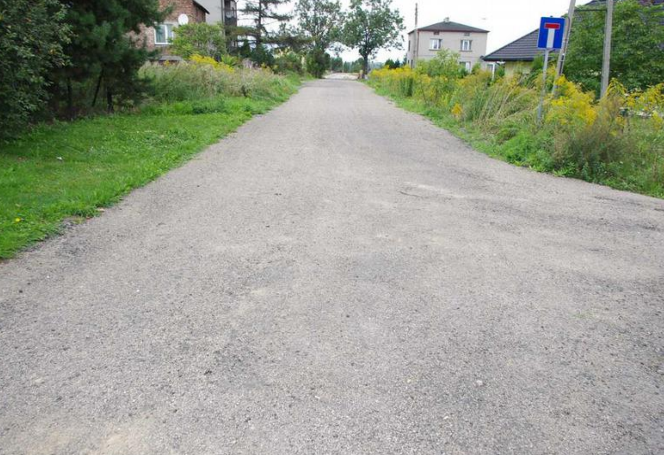
Ulica Jasna w Sarnowie po utwardzeniu.
