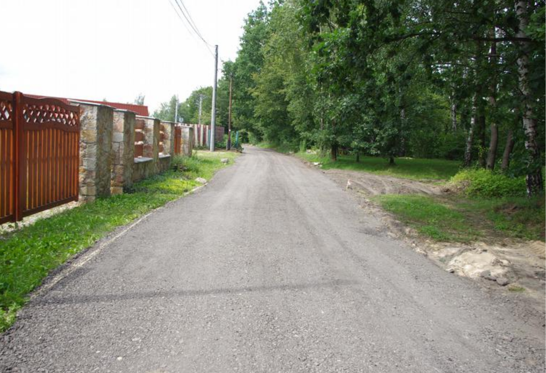
Ulica Jaworowa w Preczowie po utwardzeniu.
