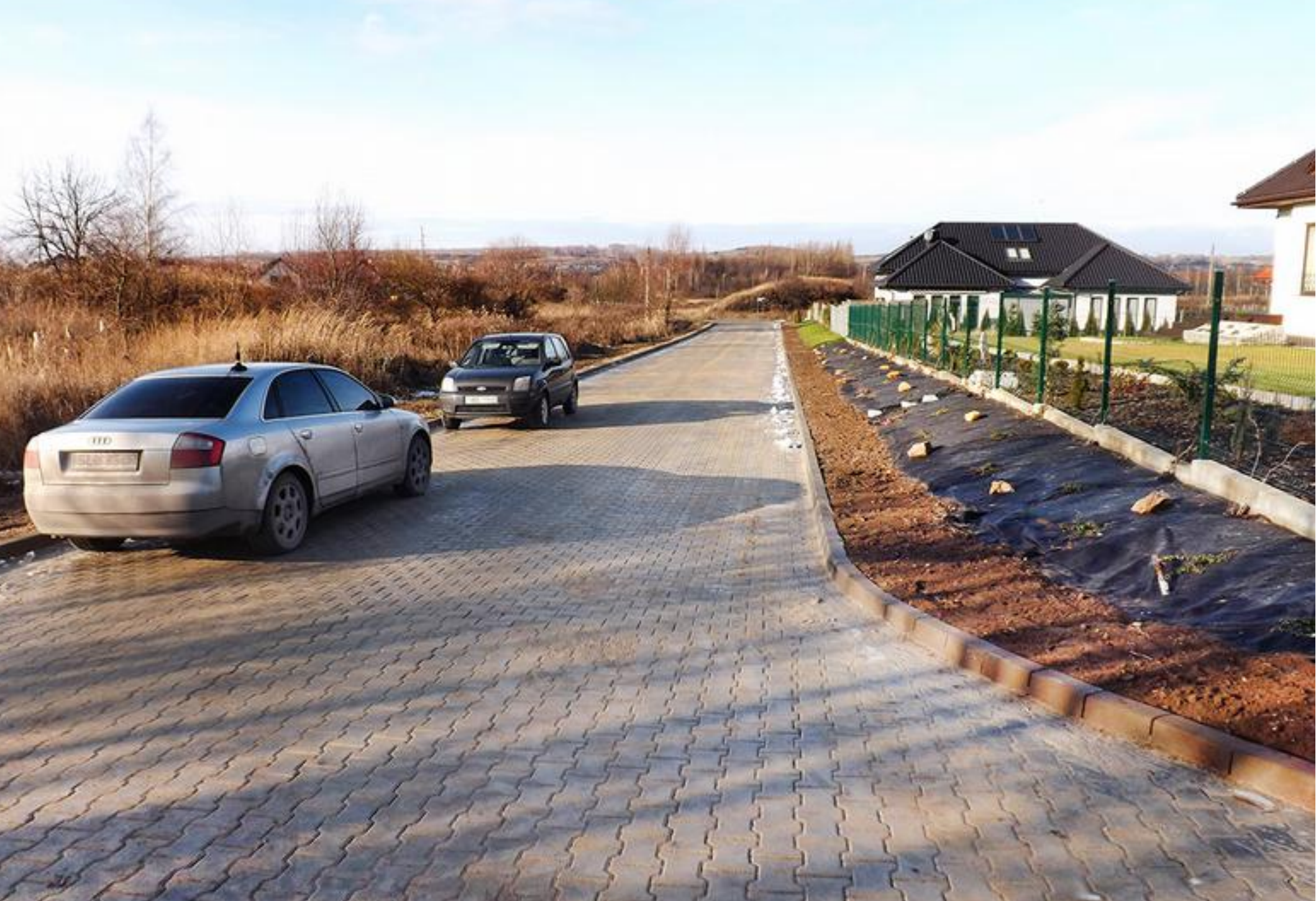
Ulica Irysów po zakończeniu prac.
