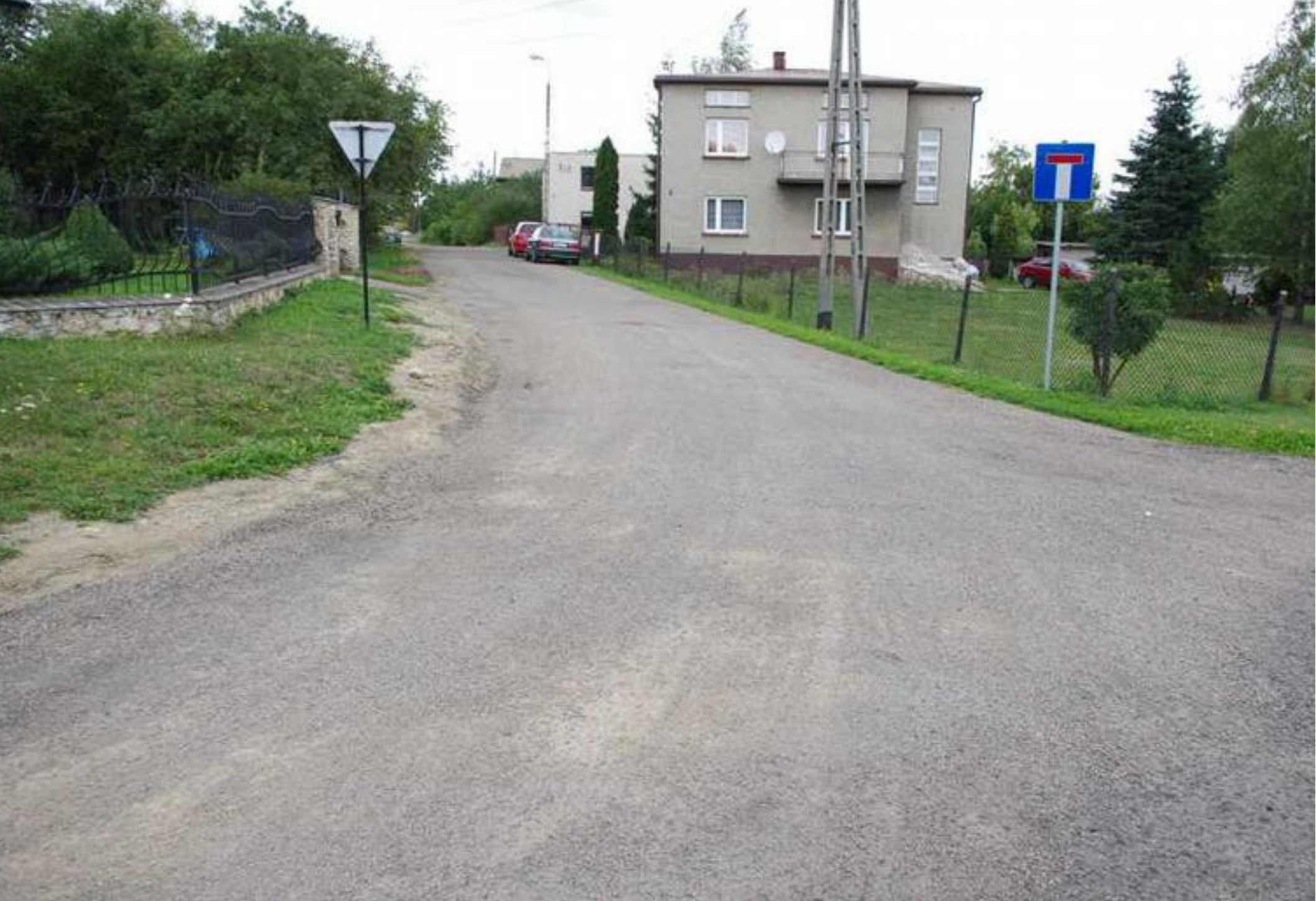
Ulica Źródłana w Sarnowie po zakończeniu prac remontowych.
