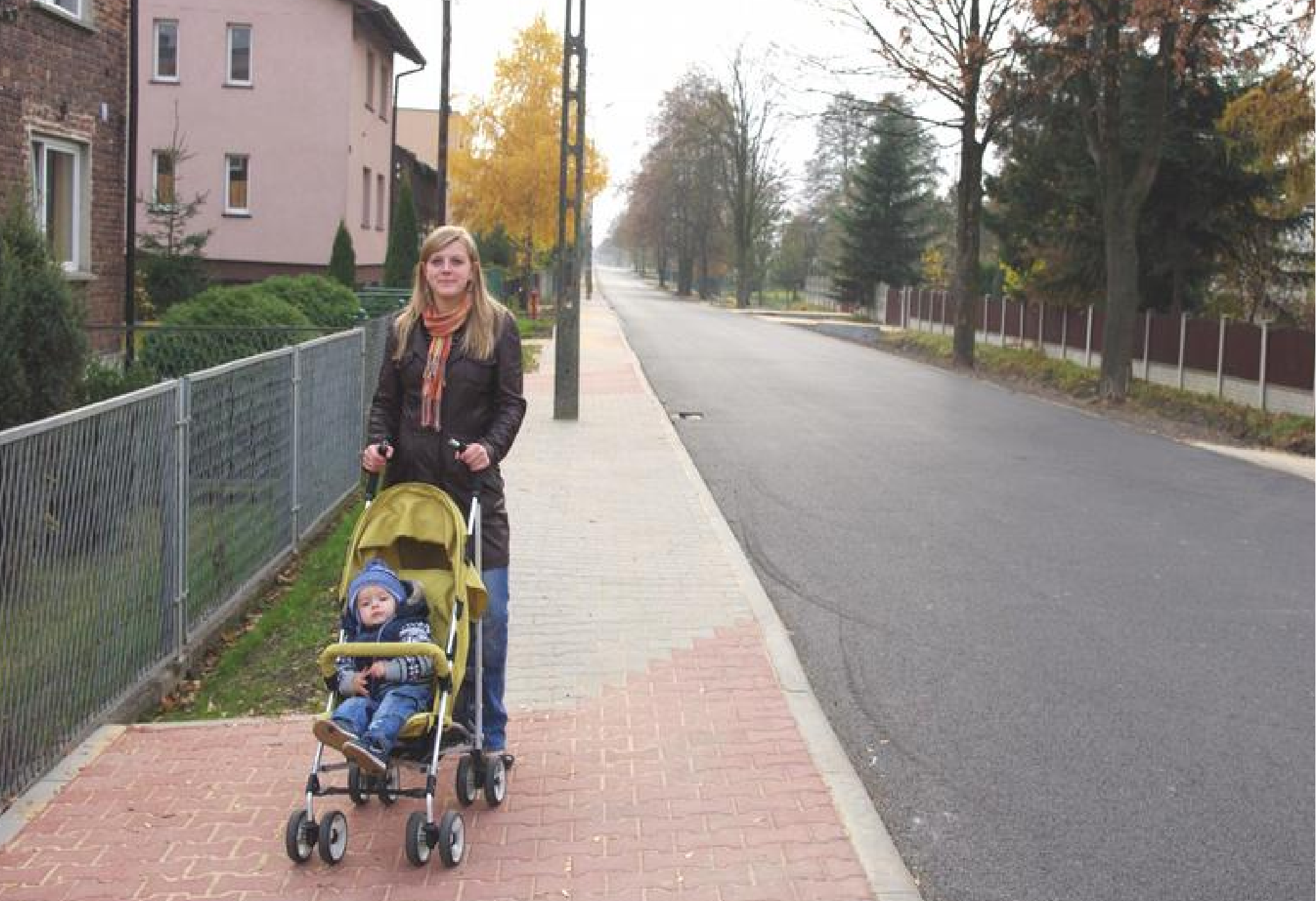
Ulica Graniczna po przebudowie.
