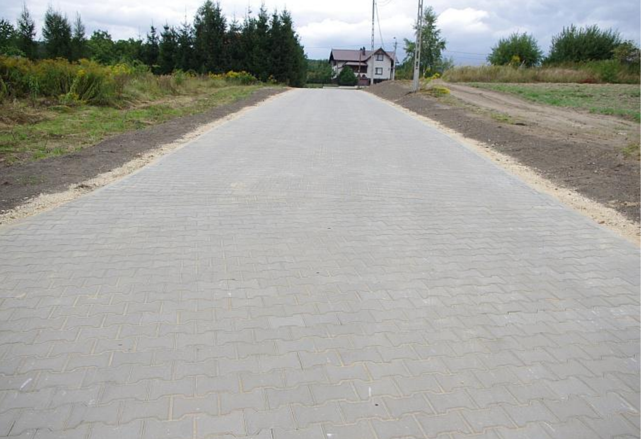
Ulica Belna w Strzyżowicach po zakończeniu prac.
