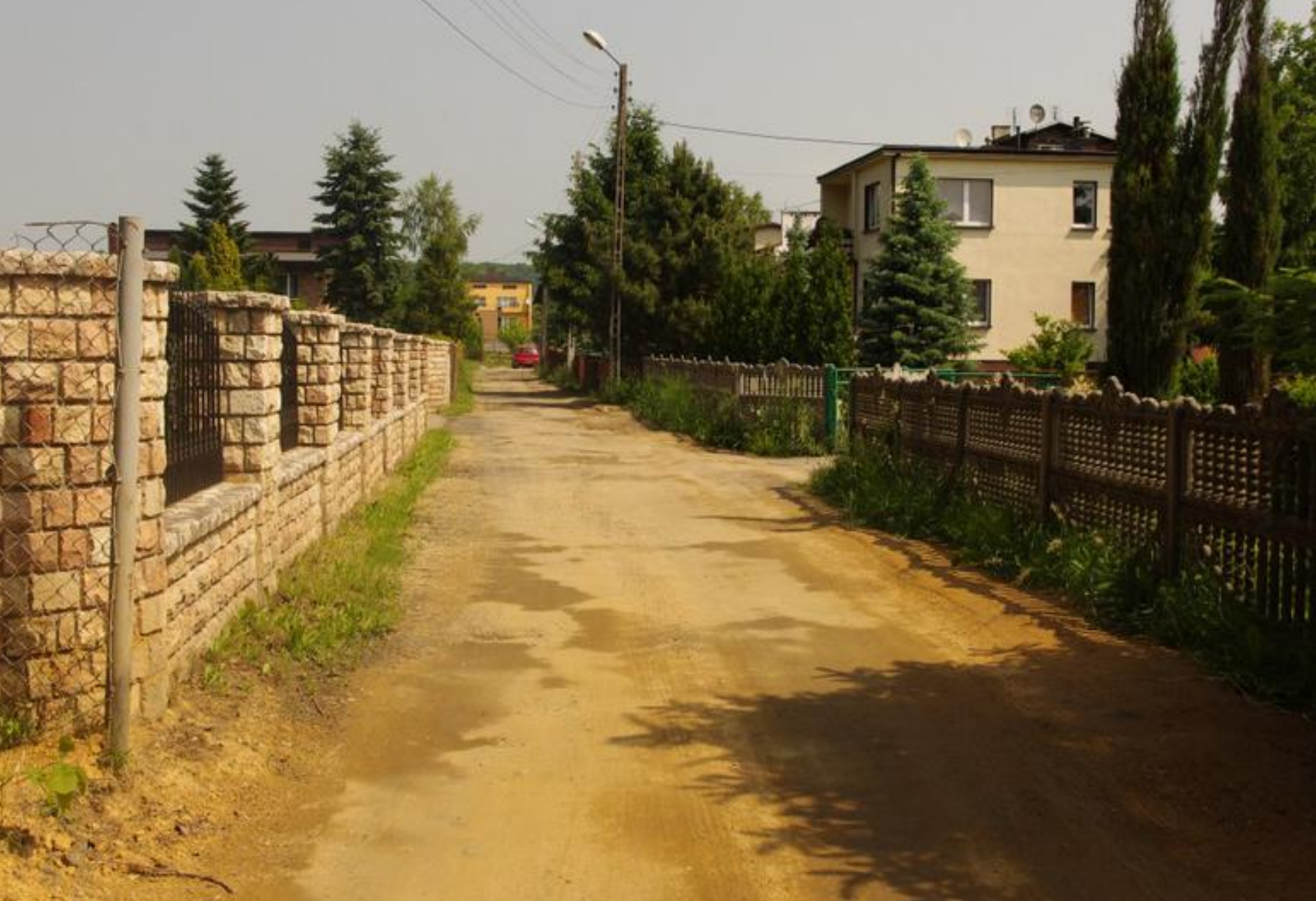
Ulica Reymonta przed remontem.
