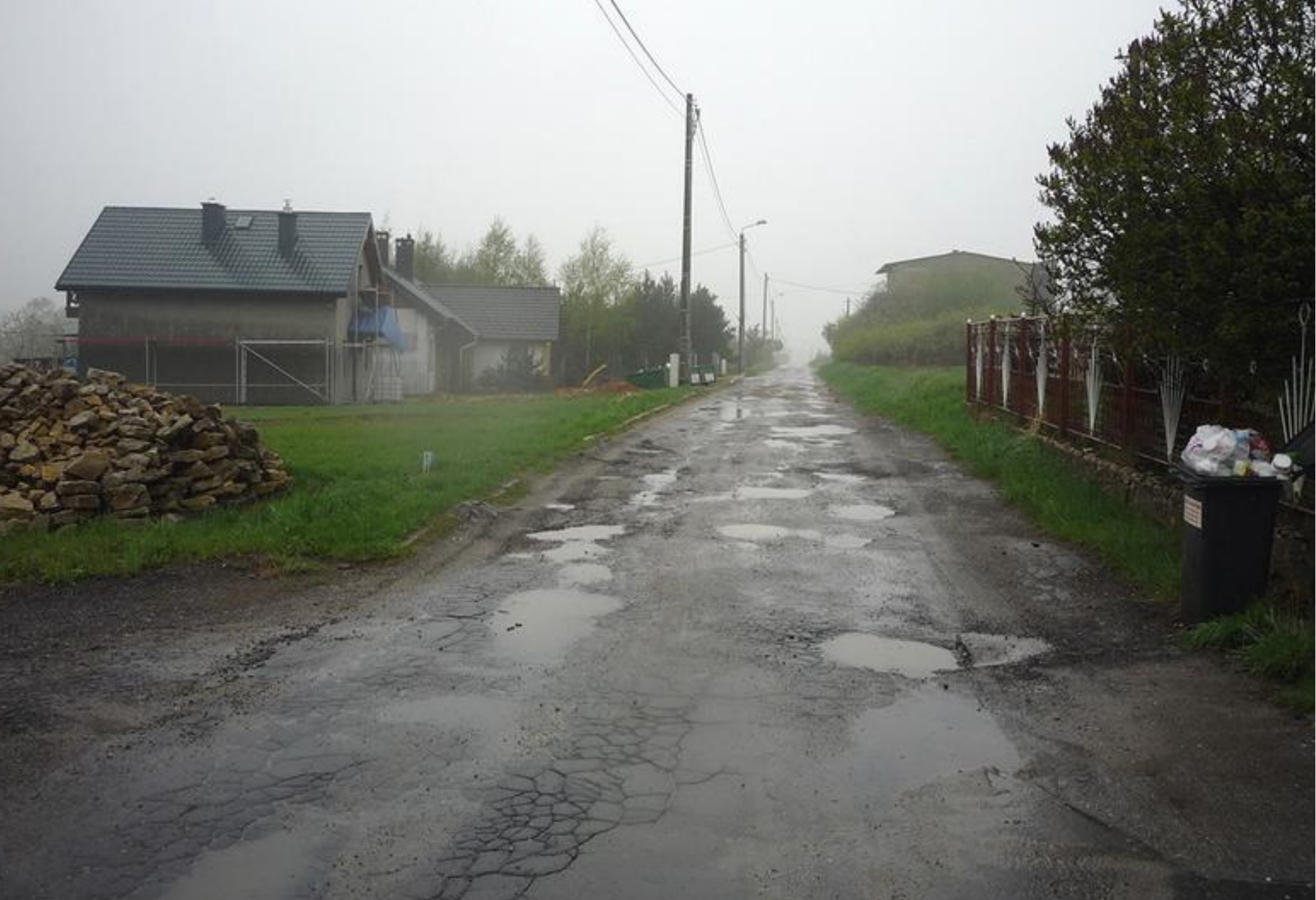
Ulica Górna w Górze Siewierskiej przed remontem.
