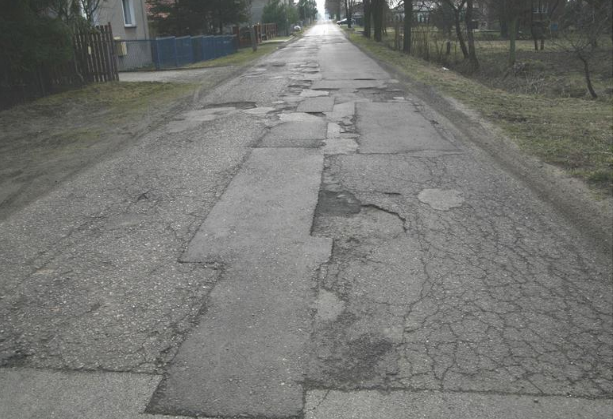
Ulica Graniczna przed remontem.
