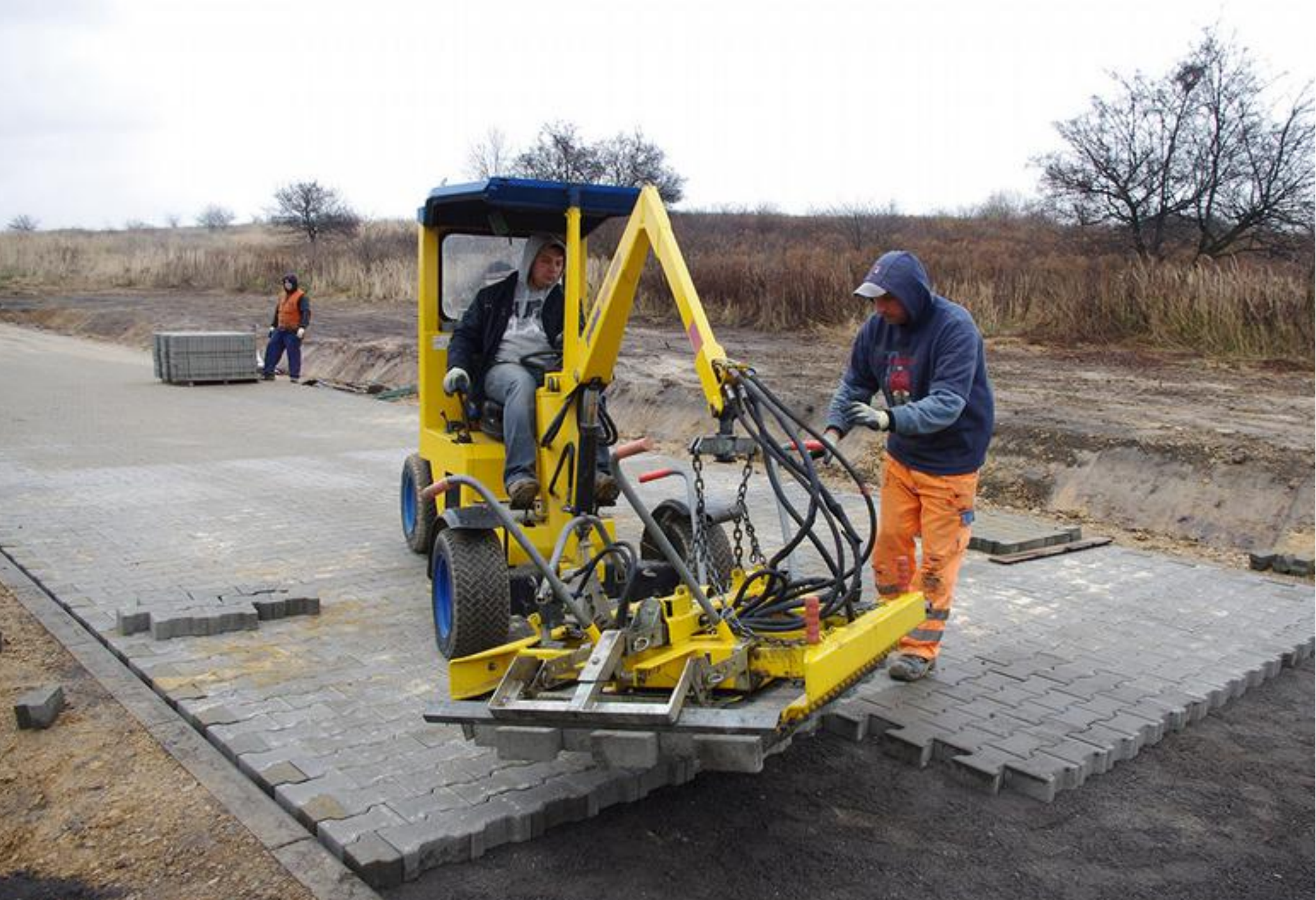
Ulica Irysów w Psarach w trakcie remontu.
