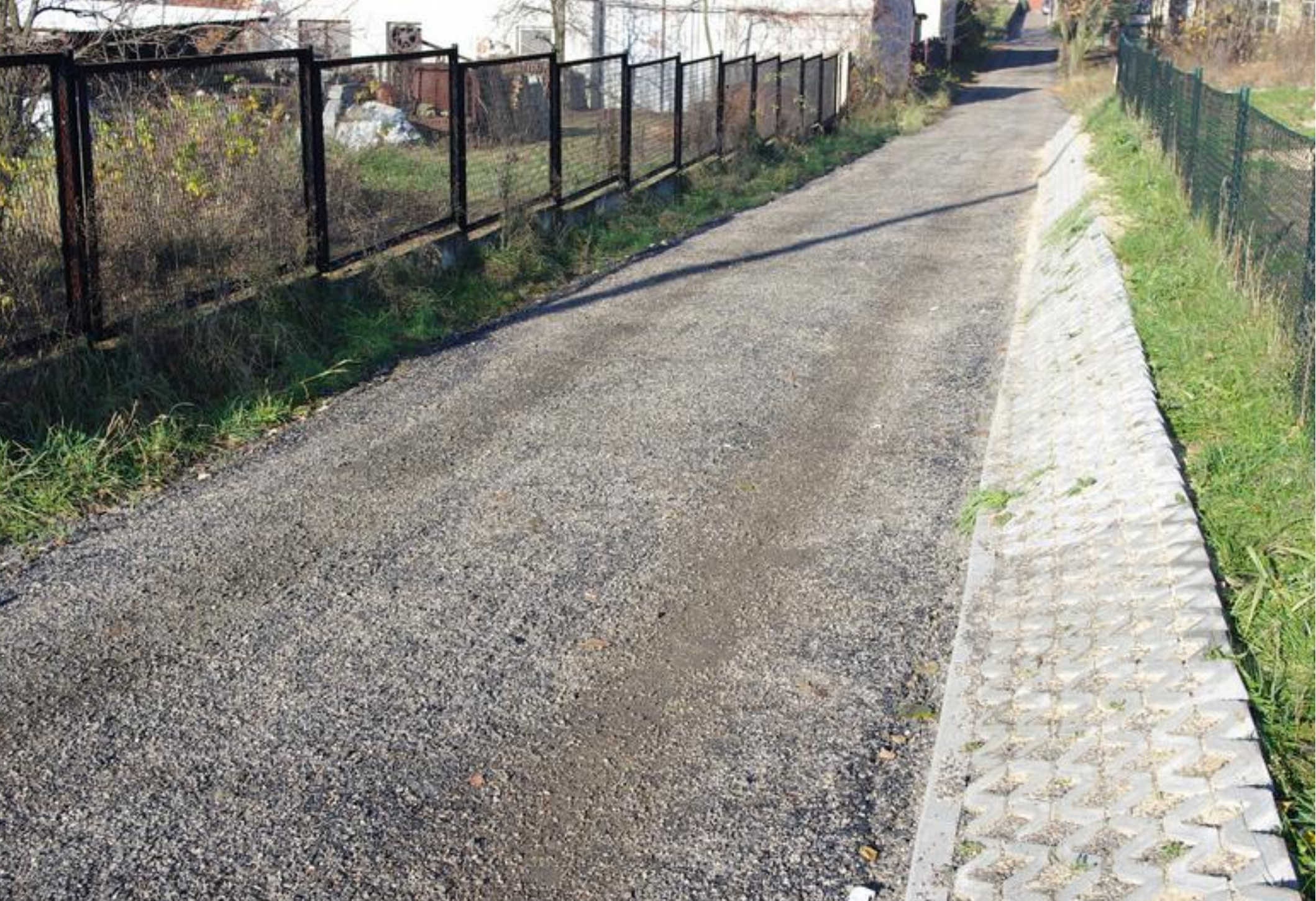
Droga prowadząca do boiska wielofunkcyjnego w Goląszy Górnej po remoncie.
