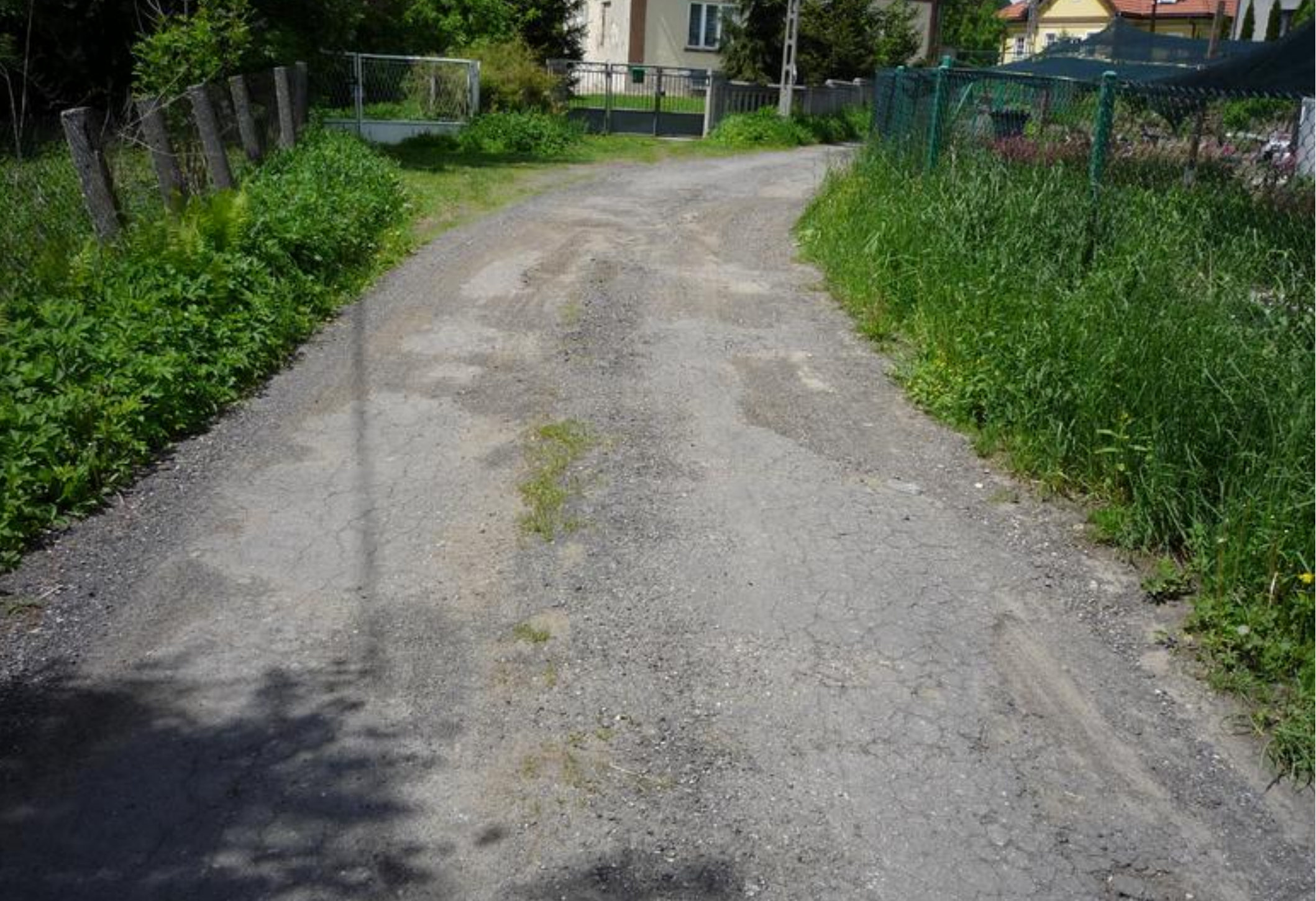
Ulica Ogrodowa w Strzyżowicach przed remontem.
