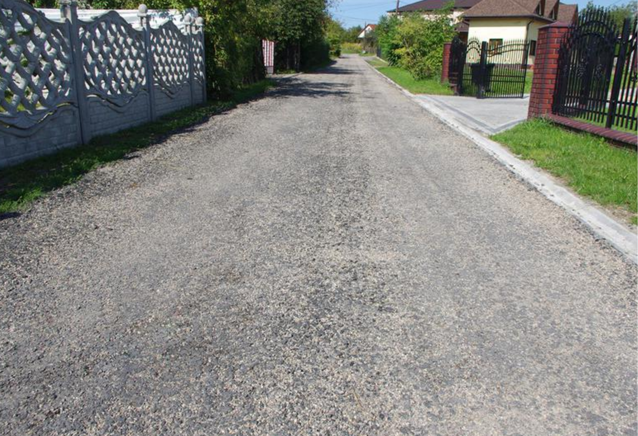
Ulica Browarna w Sarnowie po zakończeniu remontu.
