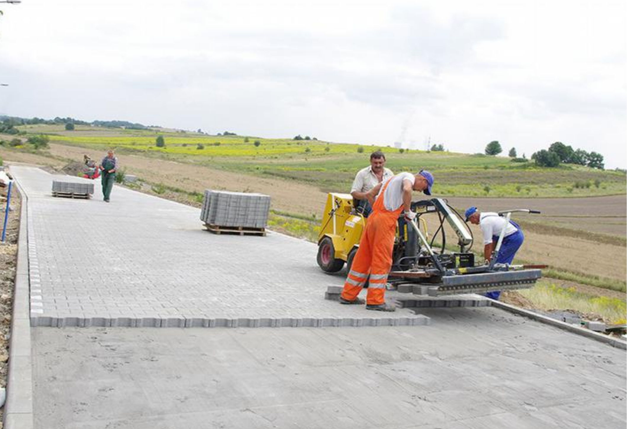
Ulica Belna w trakcie remontu.
