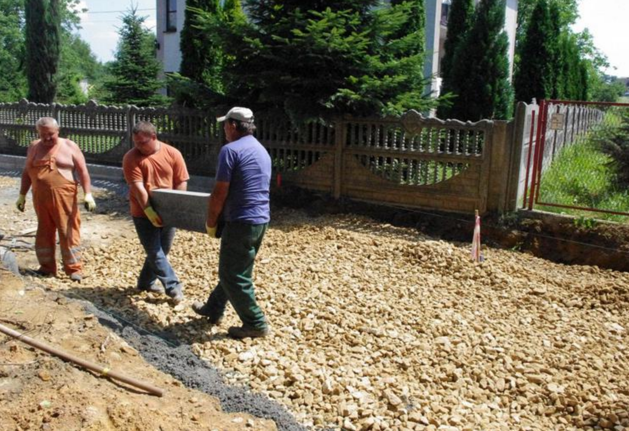
Inwestycja na ul. Reymonta w Psarach podczas realizacji.
