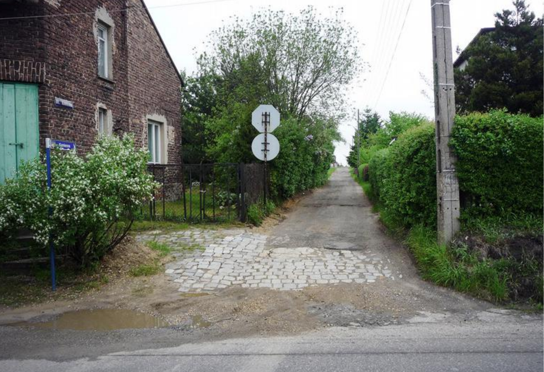
Ulica Kamienna w Sarnowie przed remontem.
