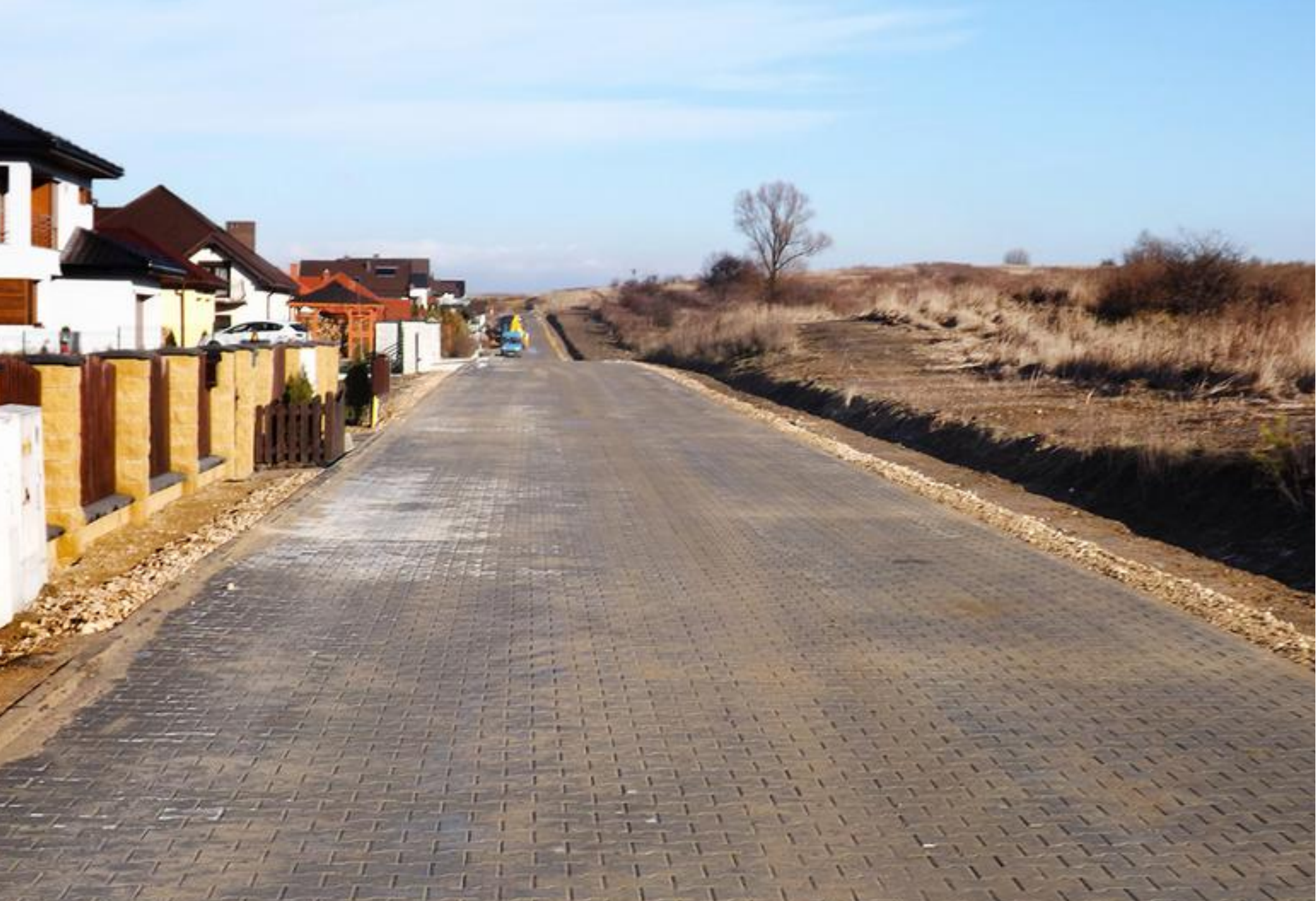
Ulica Irysów po zakończeniu prac.
