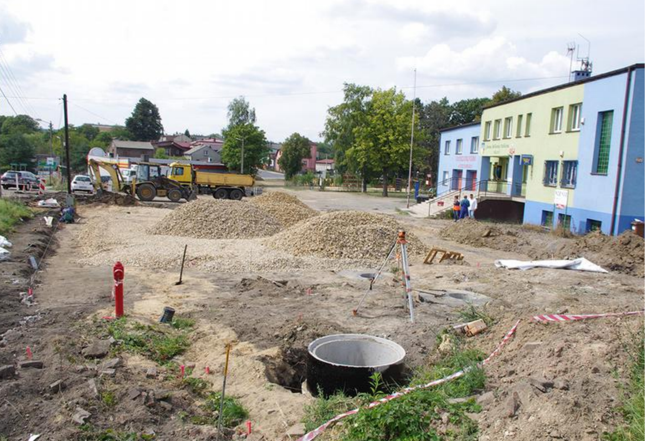
W trakcie prac nad modernizacją placu przed remizą OSP w Strzyżowicach.
