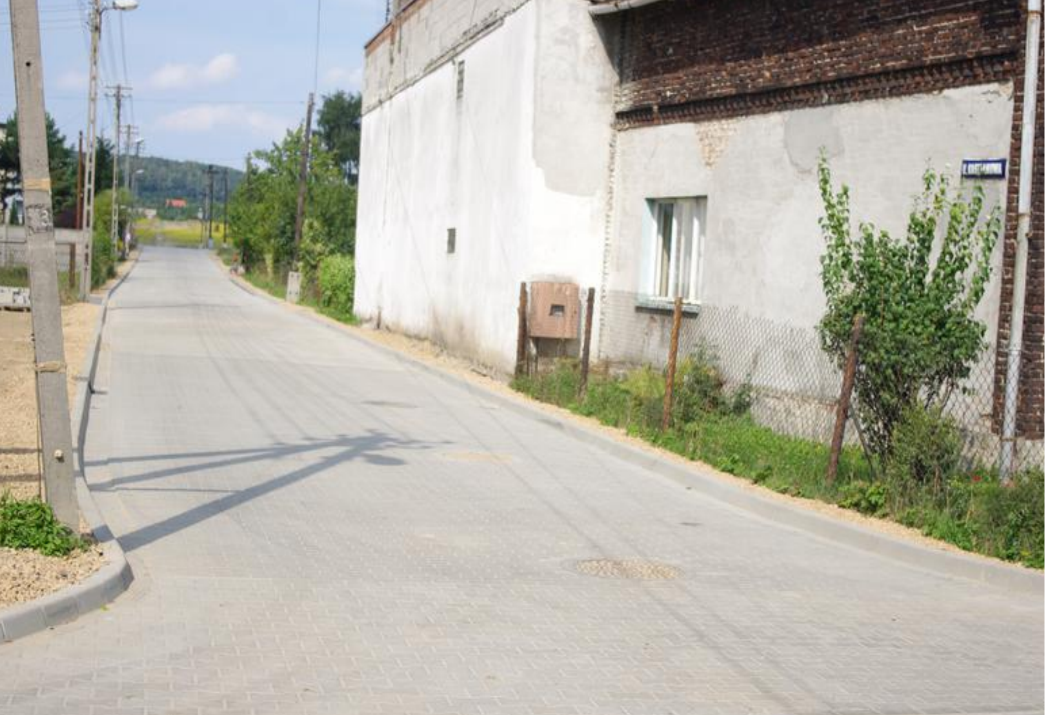
Ulica Kasztanowa po zakończeniu prac.
