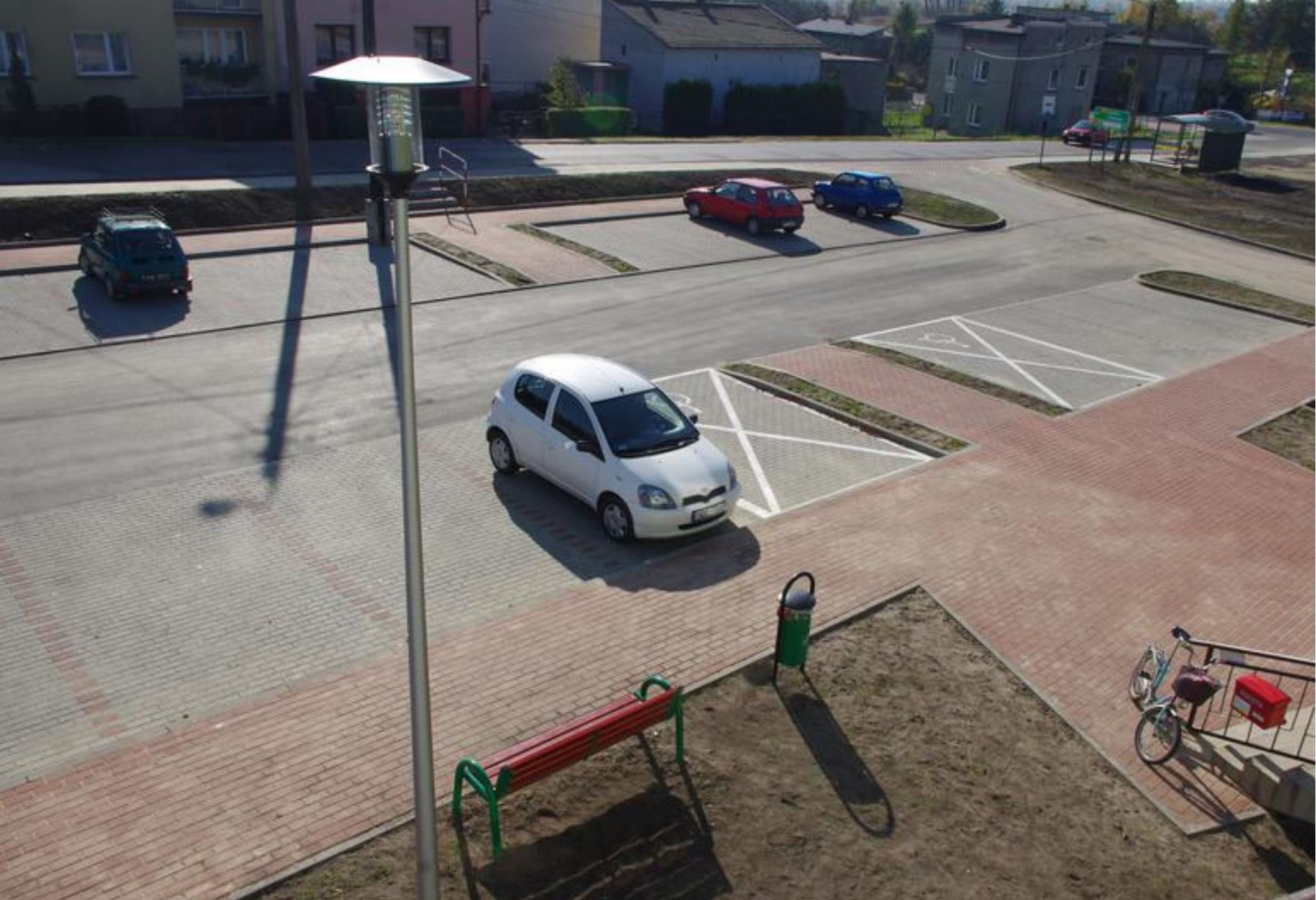
Plac przed remizą OSP w Strzyżowicach po zakończeniu prac.
