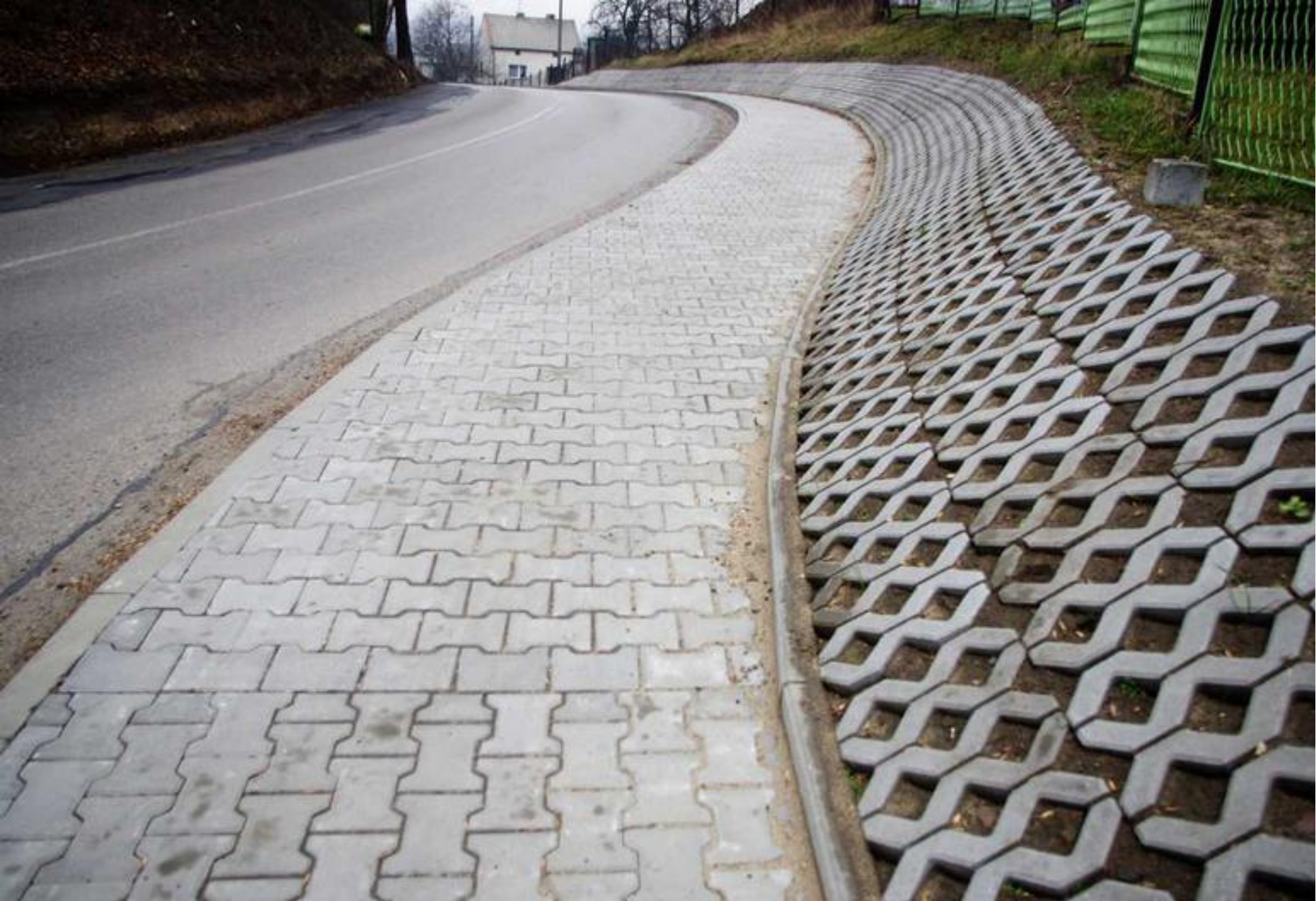
Gotowy chodnik przy ulicy Wiejskiej w Malinowicach.
