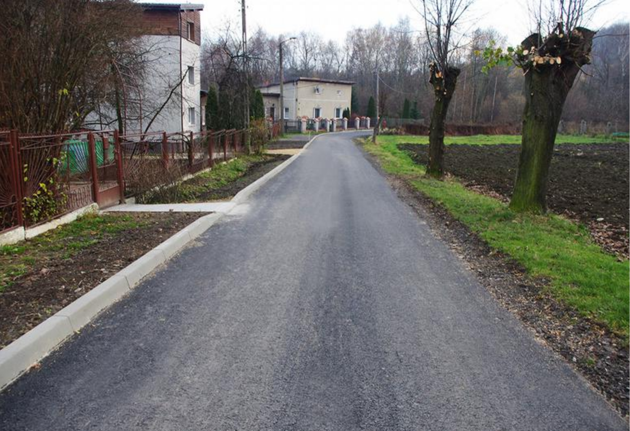
Nowa nakładka na Dojazdowej w Gródkowie.
