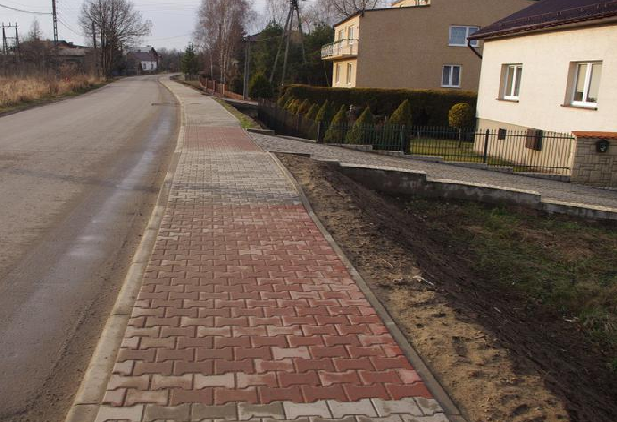
Chodnik przy ulicy Wiejskiej w Sarnowie po zakończeniu prac.
