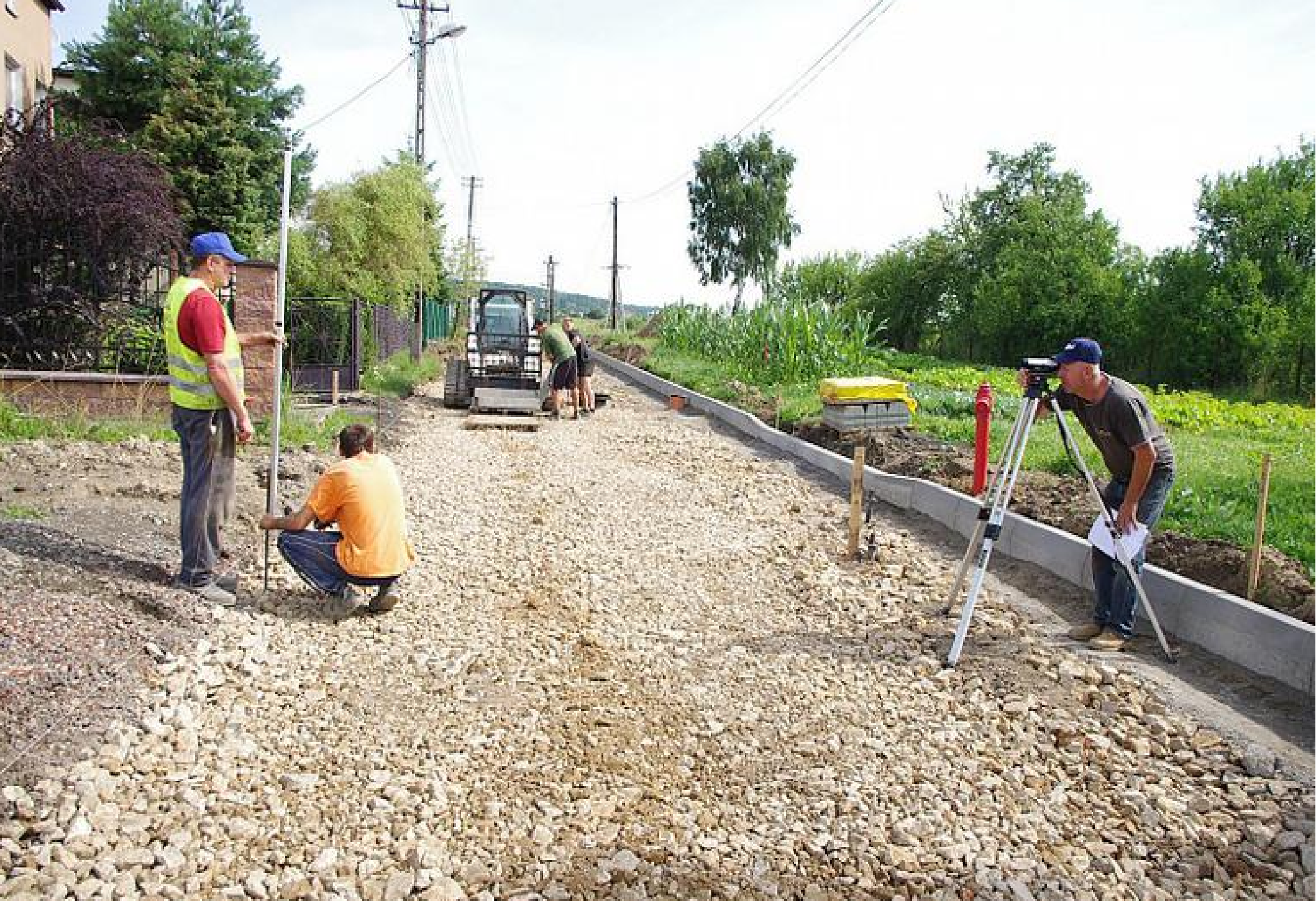
Ulica Kasztanowa w Psarach w trakcie remontu.
