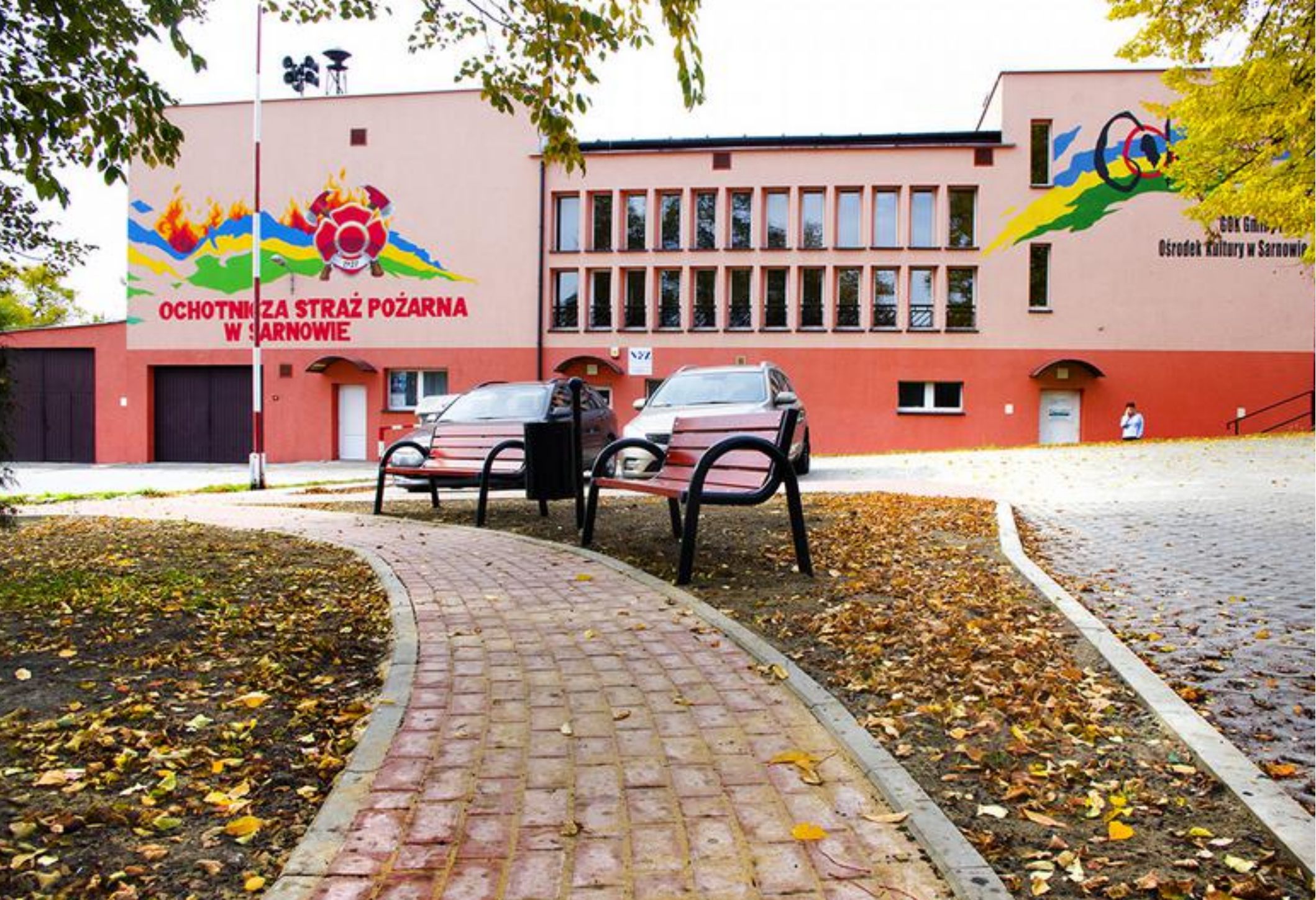
Zmodernizowany plac przy OSP w Sarnowie.
