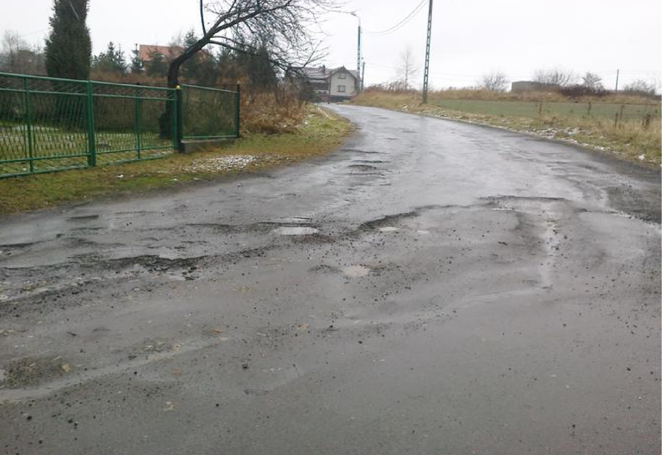
Ulica Belna w Strzyżowicach przed rozpoczęciem inwestycji.
