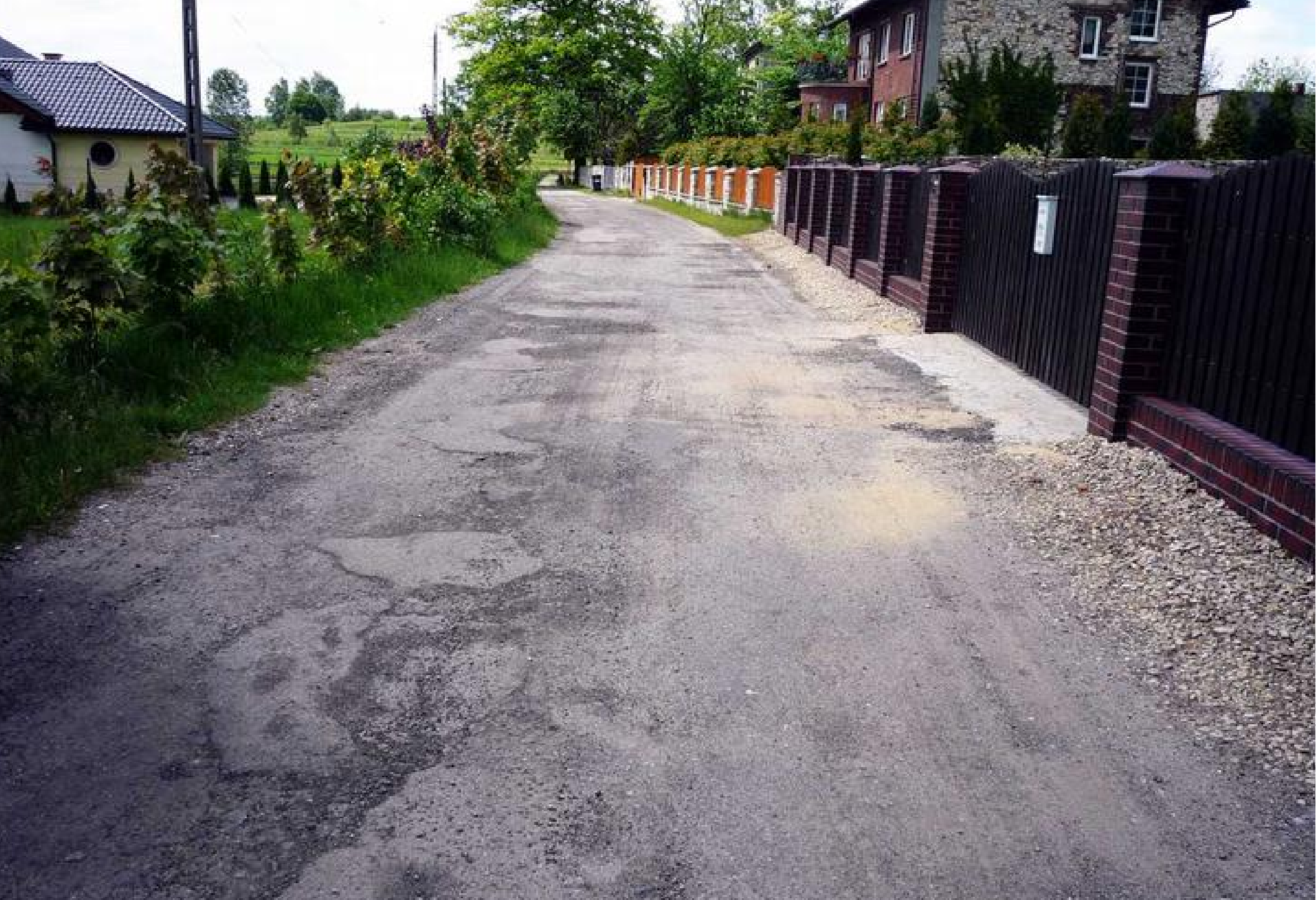
Ulica Podwale w Strzyżowicach przed remontem.
