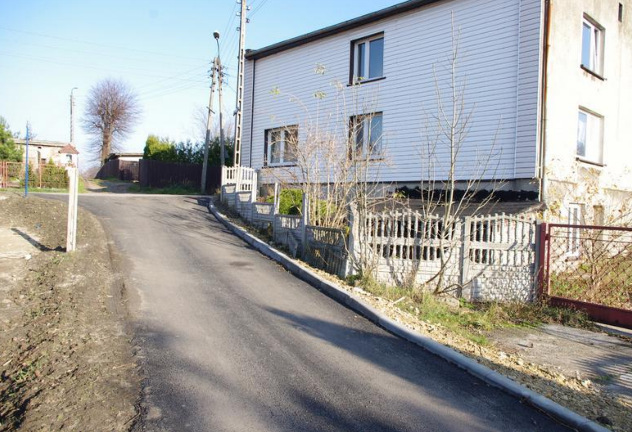
Ulica Kwiatowa w Gródkowie po wykonaniu prac.
