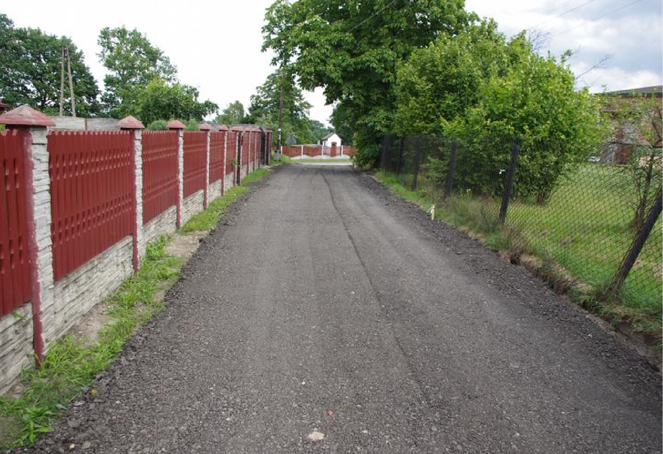
Ulica Brzeźna w Preczowie po zakończeniu remontu.
