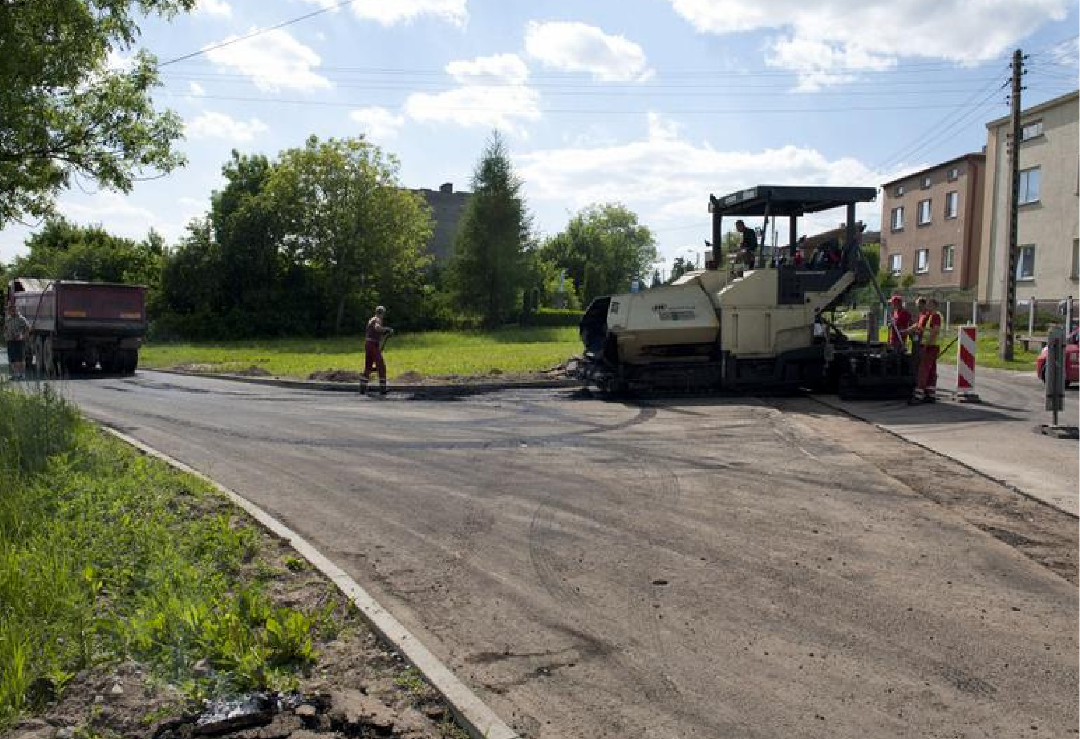
Ulica Graniczna w trakcie remontu.
