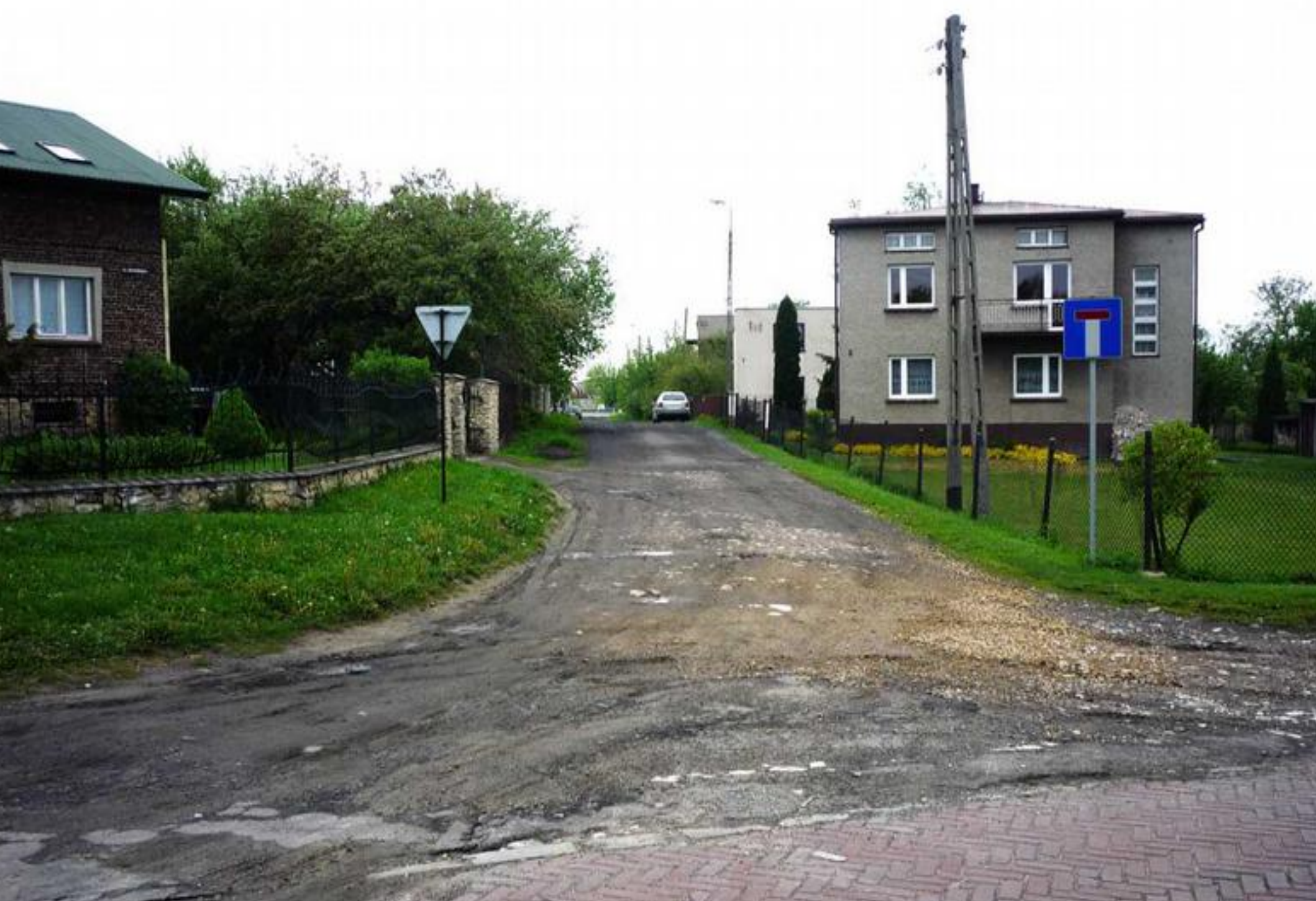
Ulica Źródłana w Sarnowie przed remontem.
