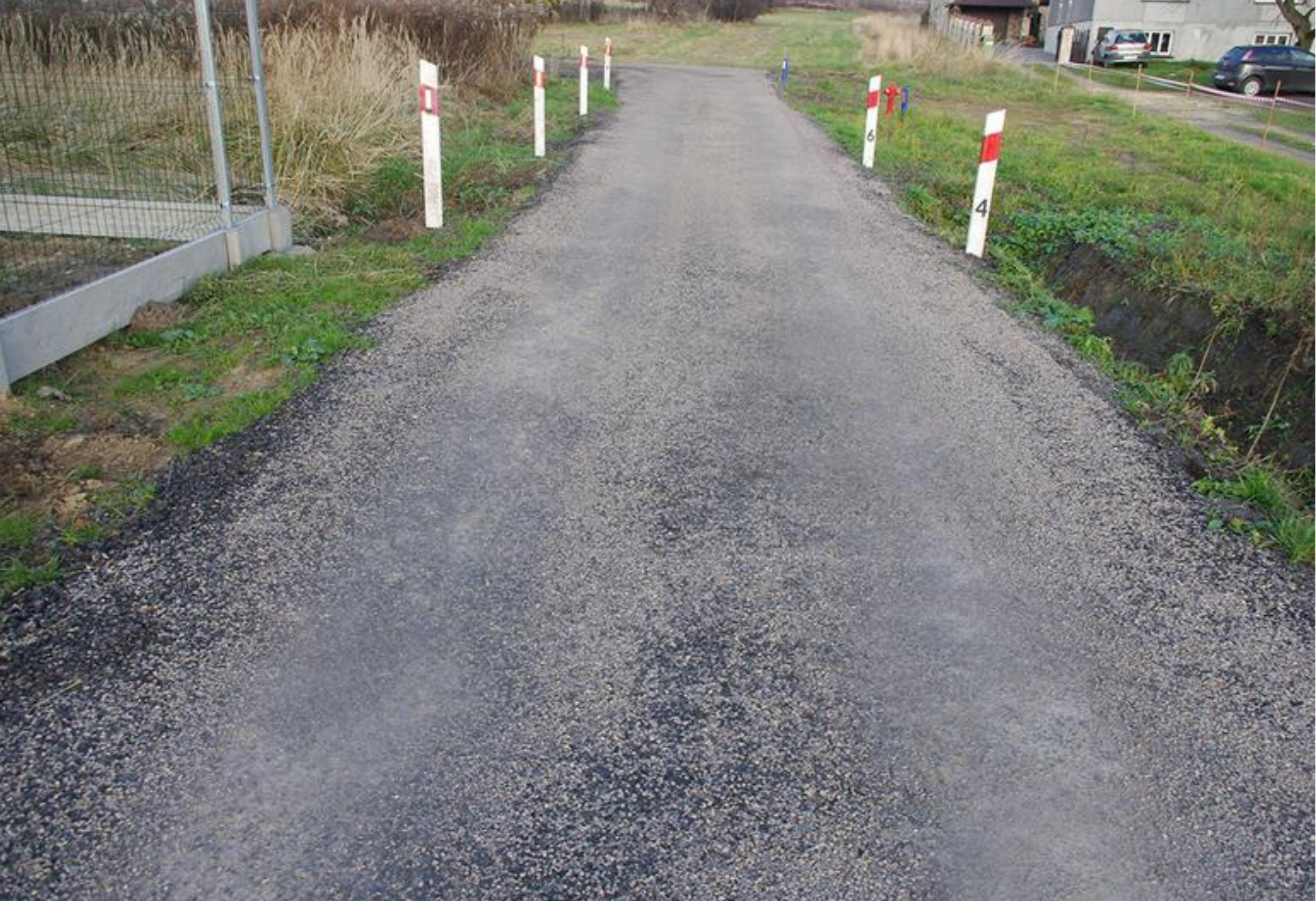
Ulica Szosowa w Strzyżowicach po zakończeniu remontu.
