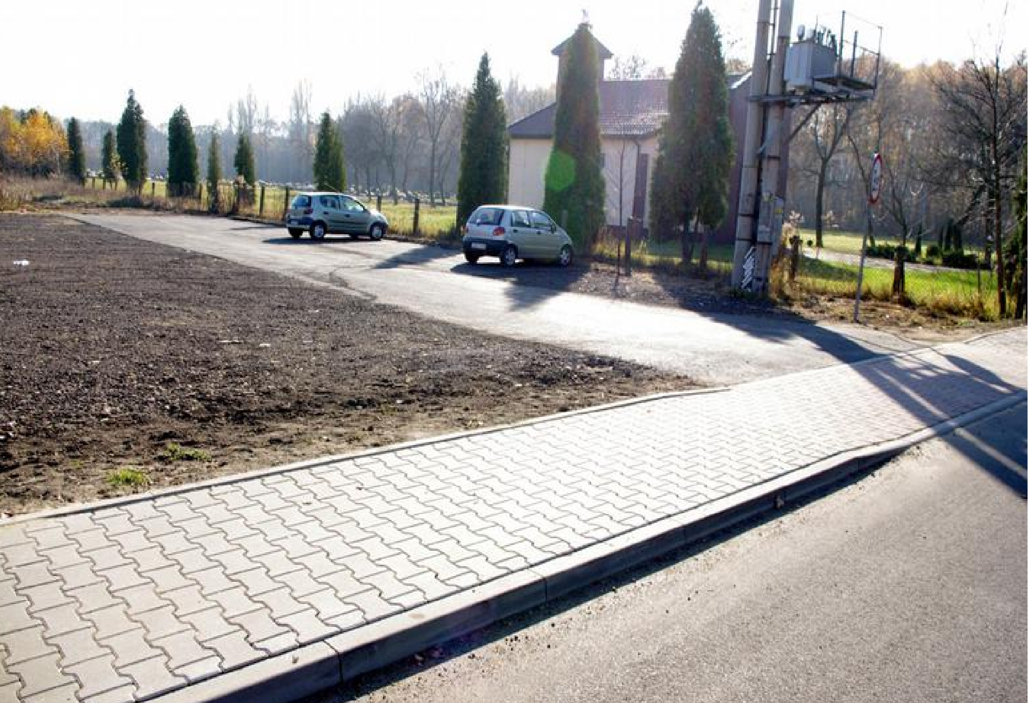
Ulica Graniczna po przebudowie.
