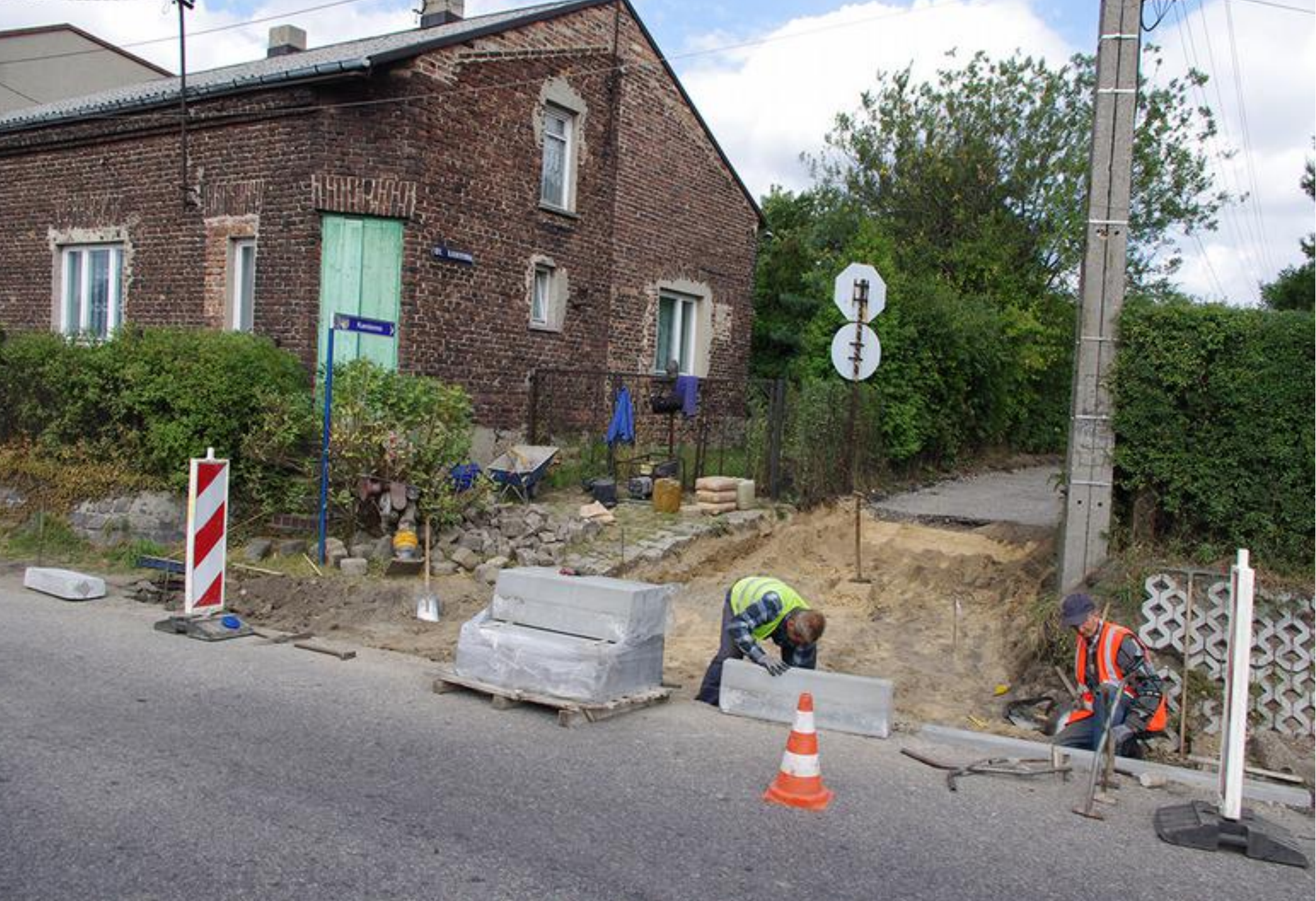
Ulica Kamienna w Sarnowie w trakcie prac.
