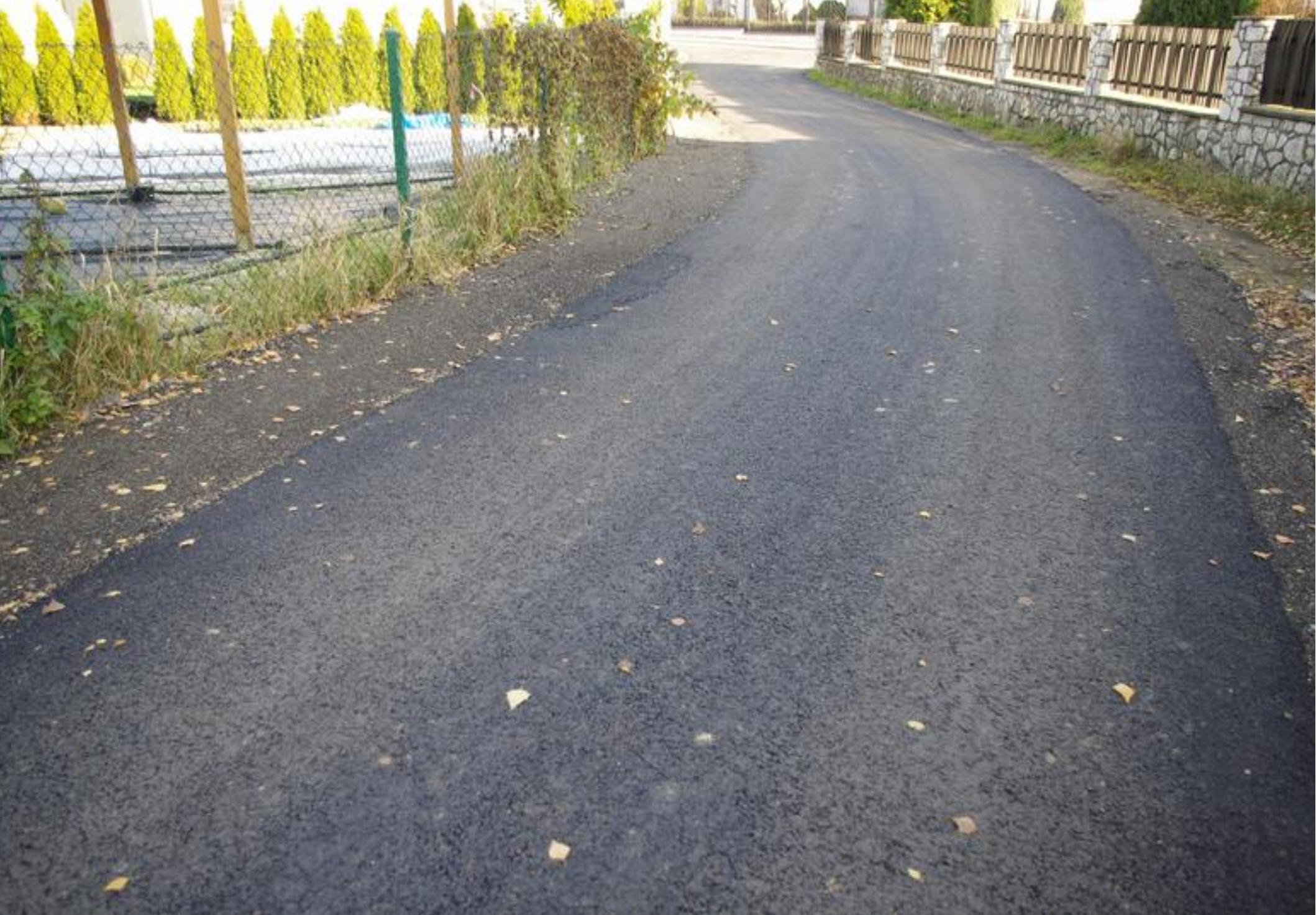
Ulica Ogrodowa z nową nakładką asfaltową.
