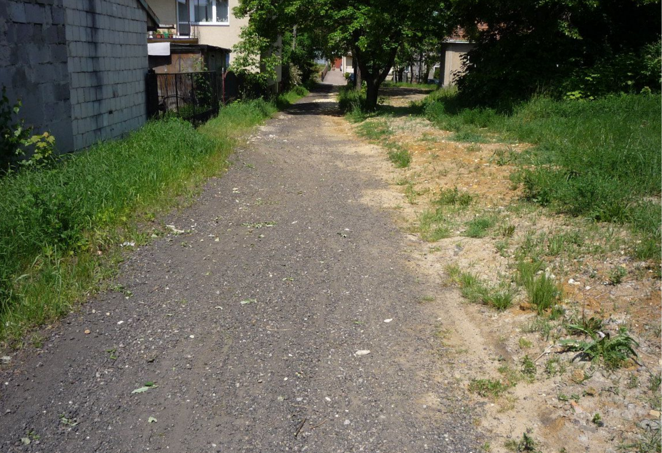
Droga prowadząca do boiska wielofunkcyjnego w Goląszy Górnej przed remontem.
