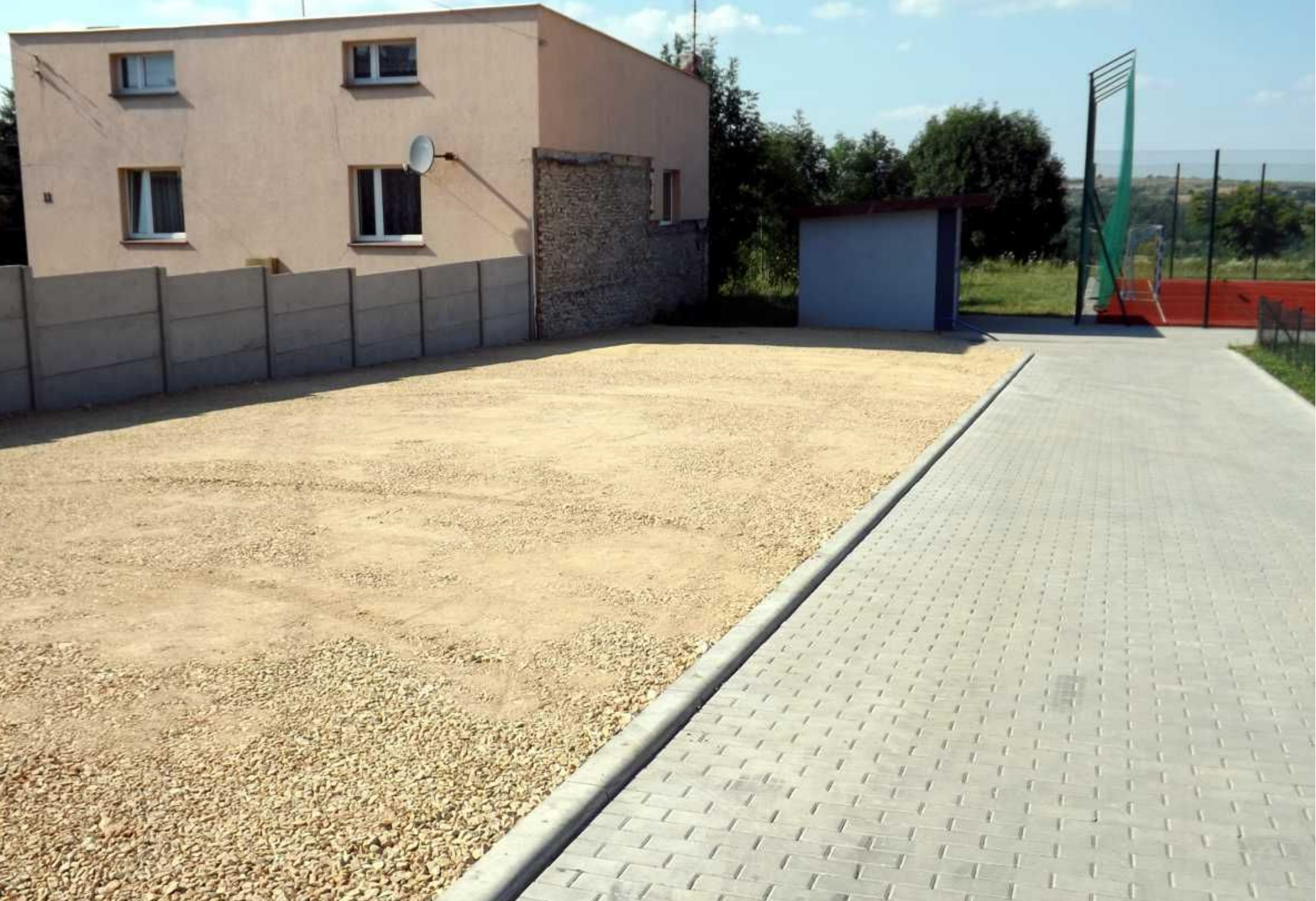
Parking przy boisku wielofunkcyjnym w Górze Siewierskiej.
