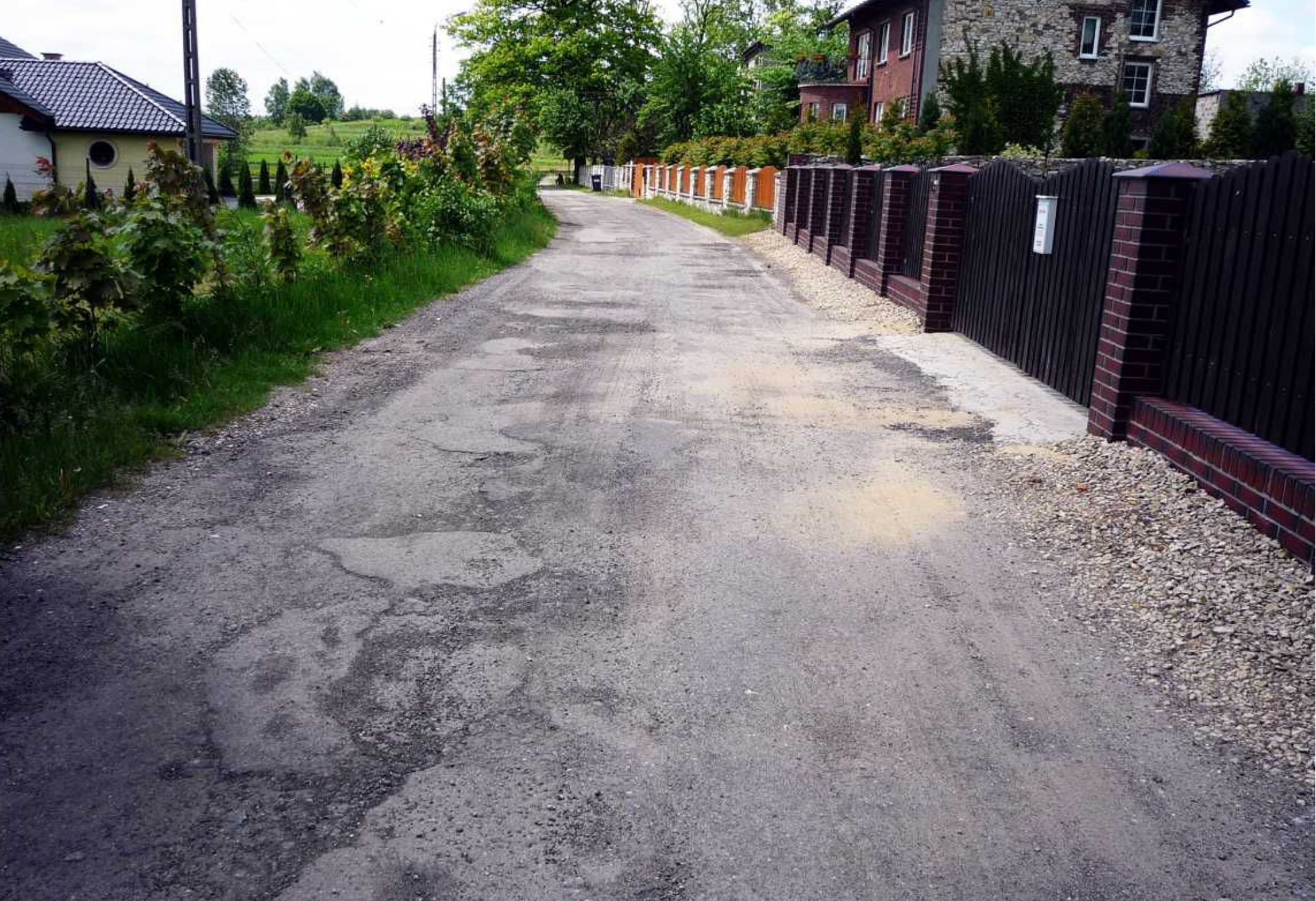
Ulica Podwale w Strzyżowicach przed remontem.
