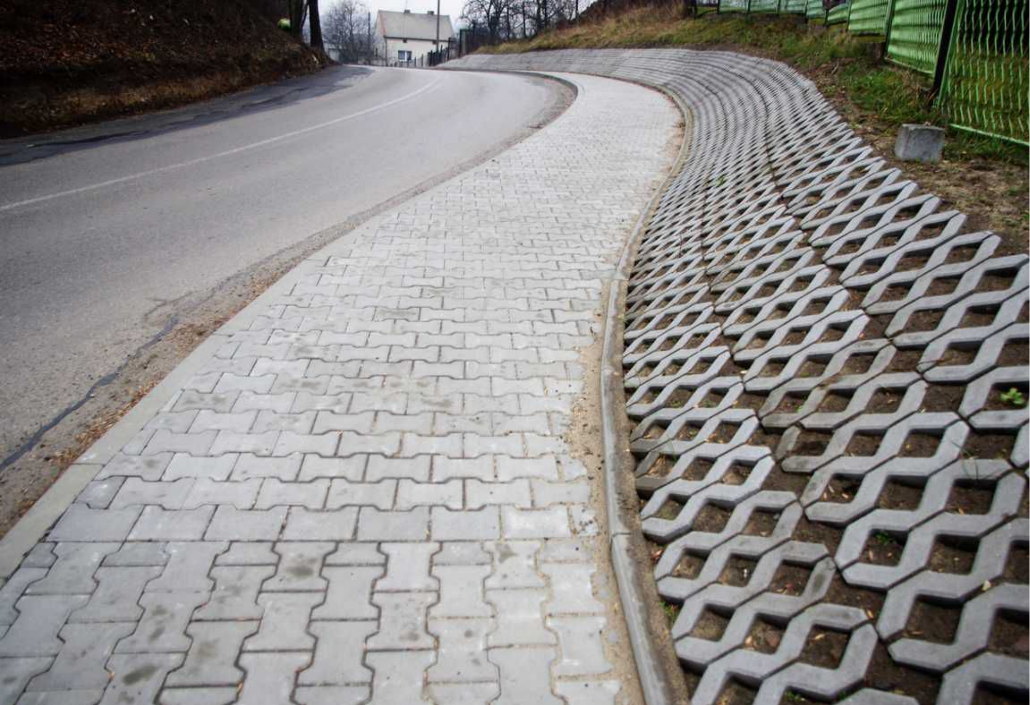
Gotowy chodnik przy ulicy Wiejskiej w Malinowicach.
