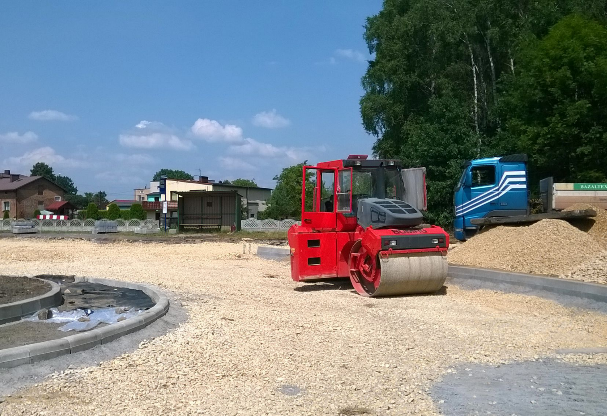
W trakcie budowy pętli autobusowej w Malinowicach.
