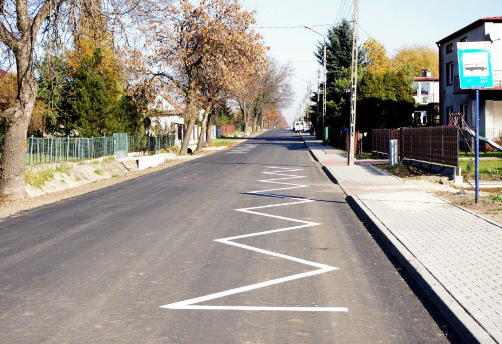
Ulica Graniczna po przebudowie.
