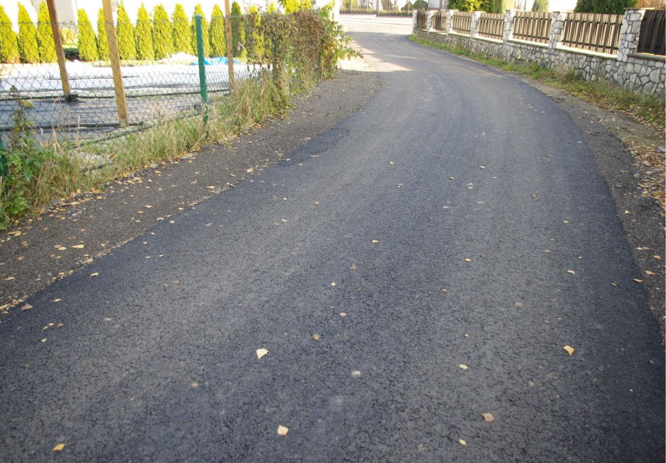
Ulica Ogrodowa z nową nakładką asfaltową.
