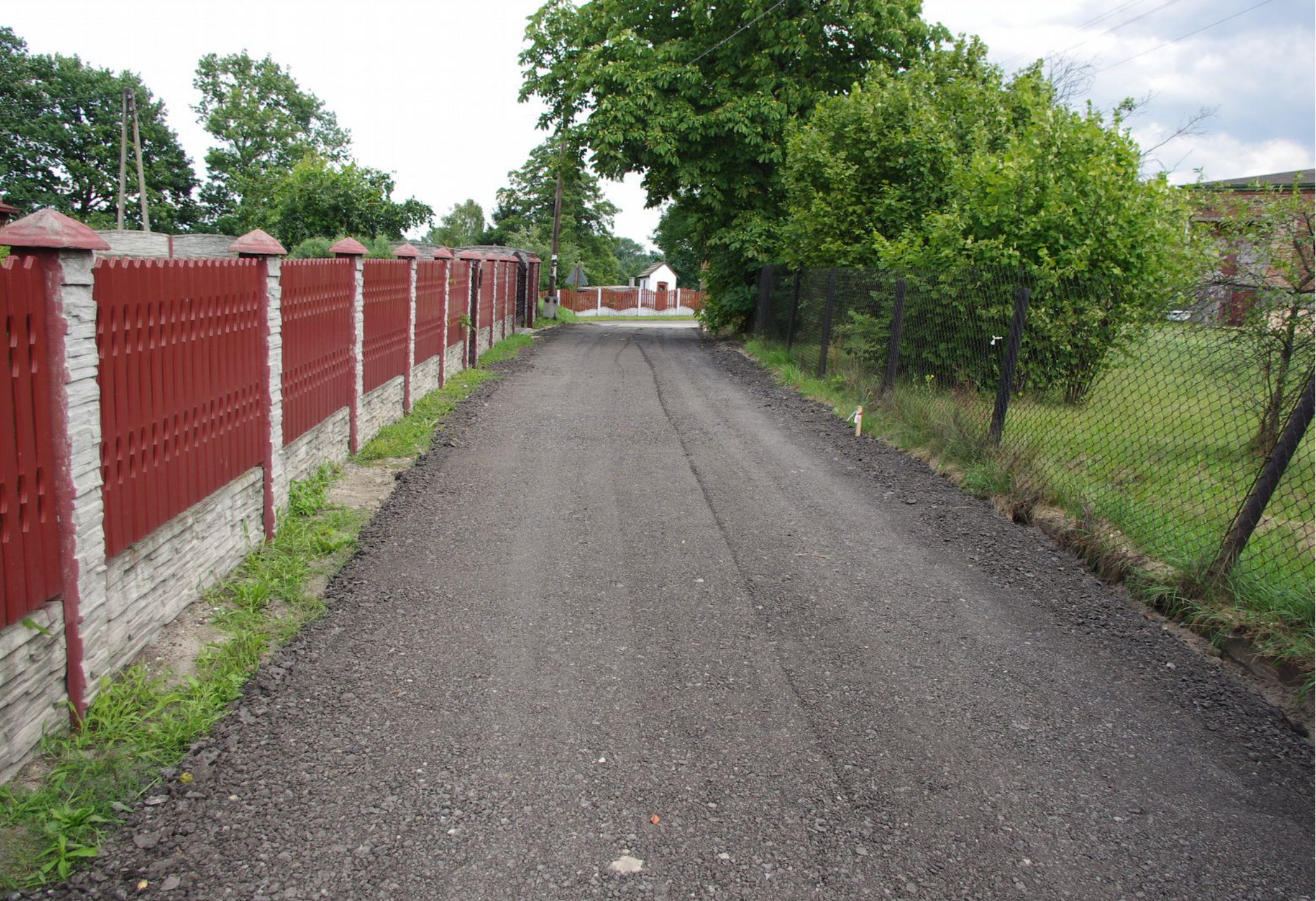
Ulica Brzeźna w Preczowie po zakończeniu remontu.
