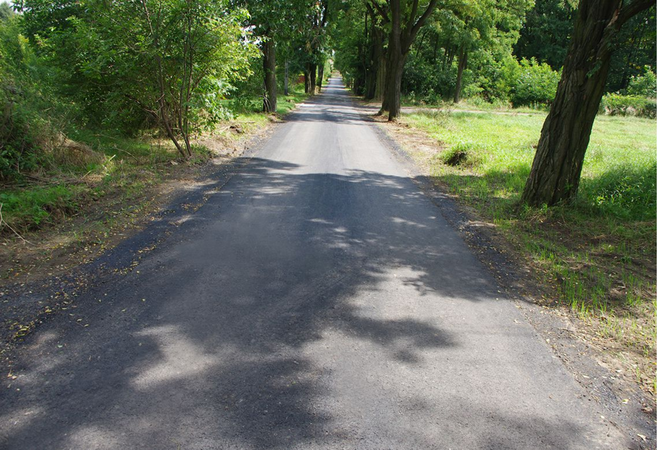
Nowa nakładka asfaltowa na ul. Parkowej.
