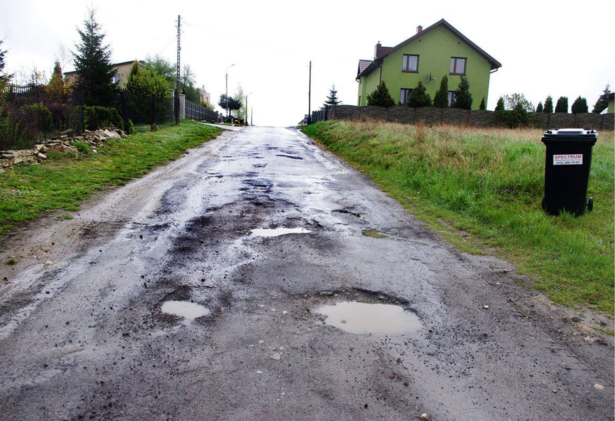
Ulica Kościuszki w Górze Siewierskiej przed rozpoczęciem inwestycji.
