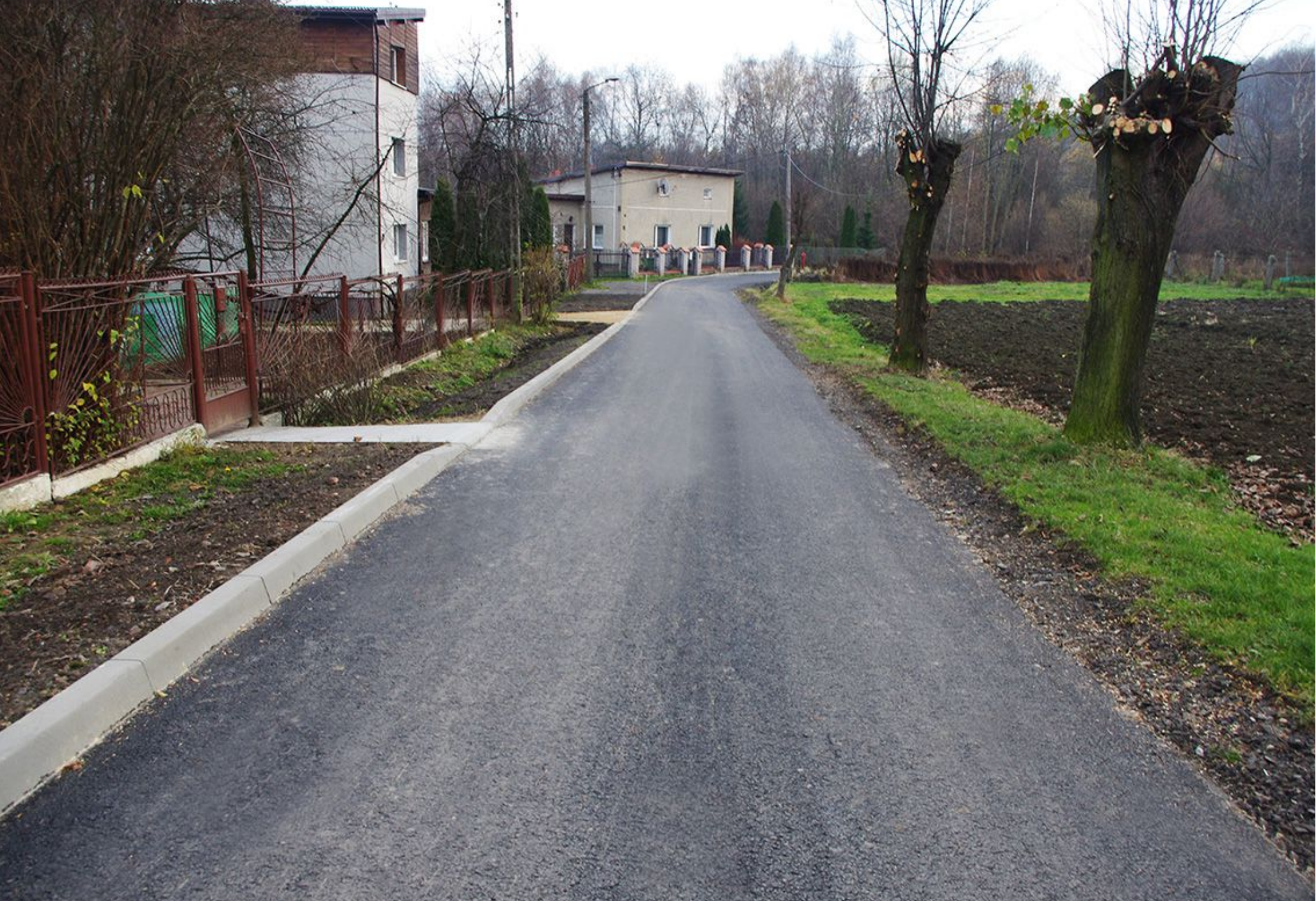
Nowa nakładka na Dojazdowej w Gródkowie.
