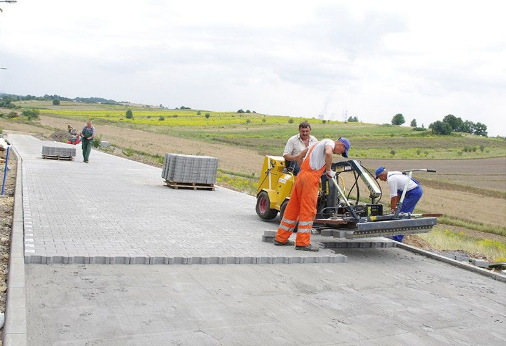
Ulica Belna w trakcie remontu.
