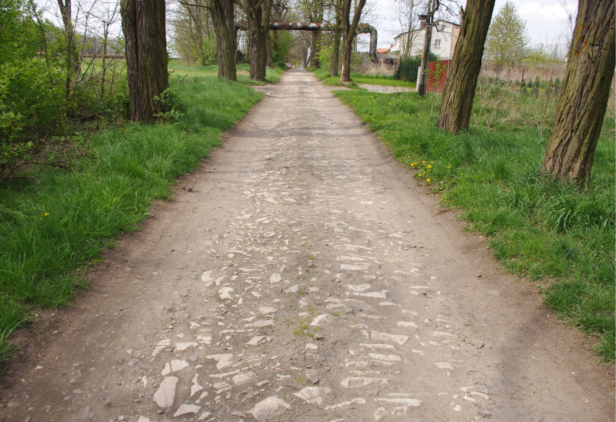
Przed wykonaniem nakładki asfaltowej na ul. Parkowej.
