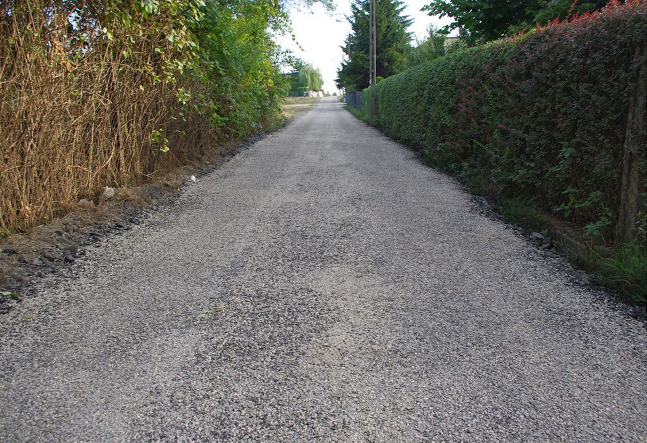
Ulica Kamienna w Sarnowie po zakończeniu remontu.
