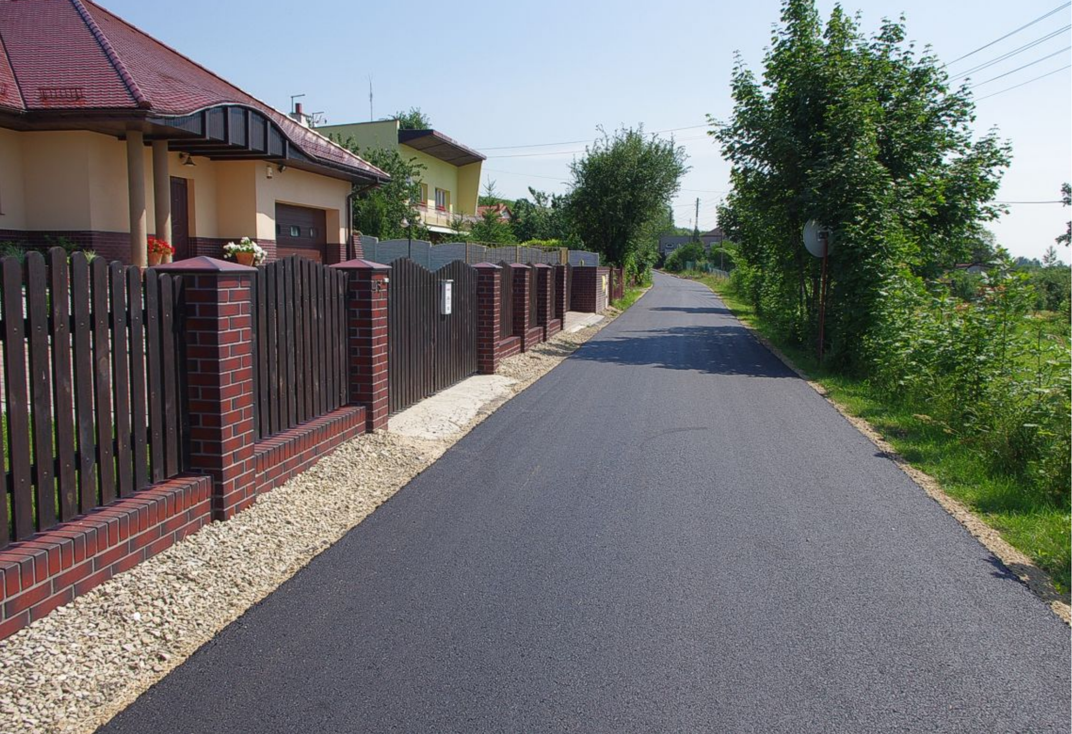
Nowa nakładka na ulicy Podwale w Strzyżowicach.
