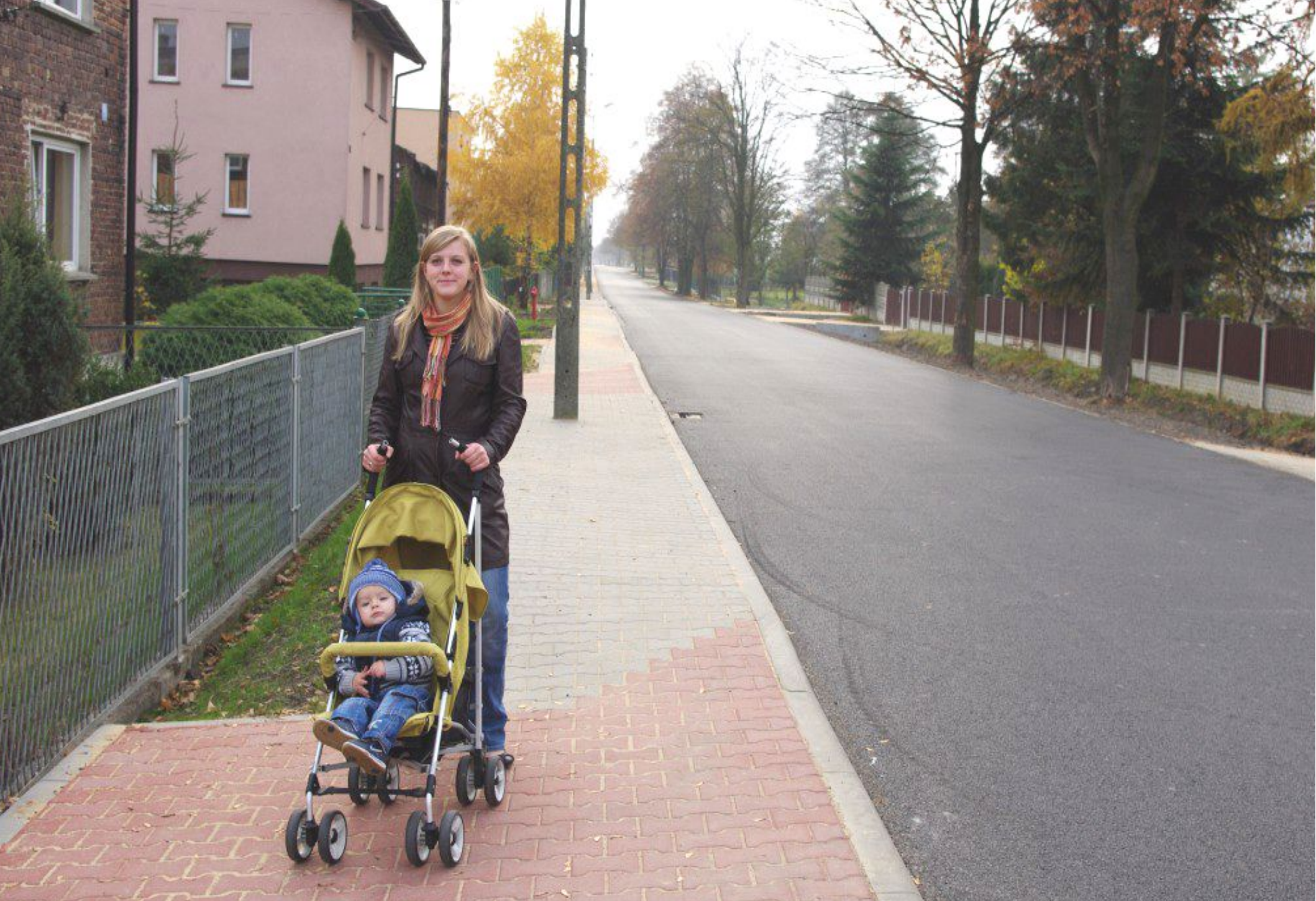
Ulica Graniczna po przebudowie.
