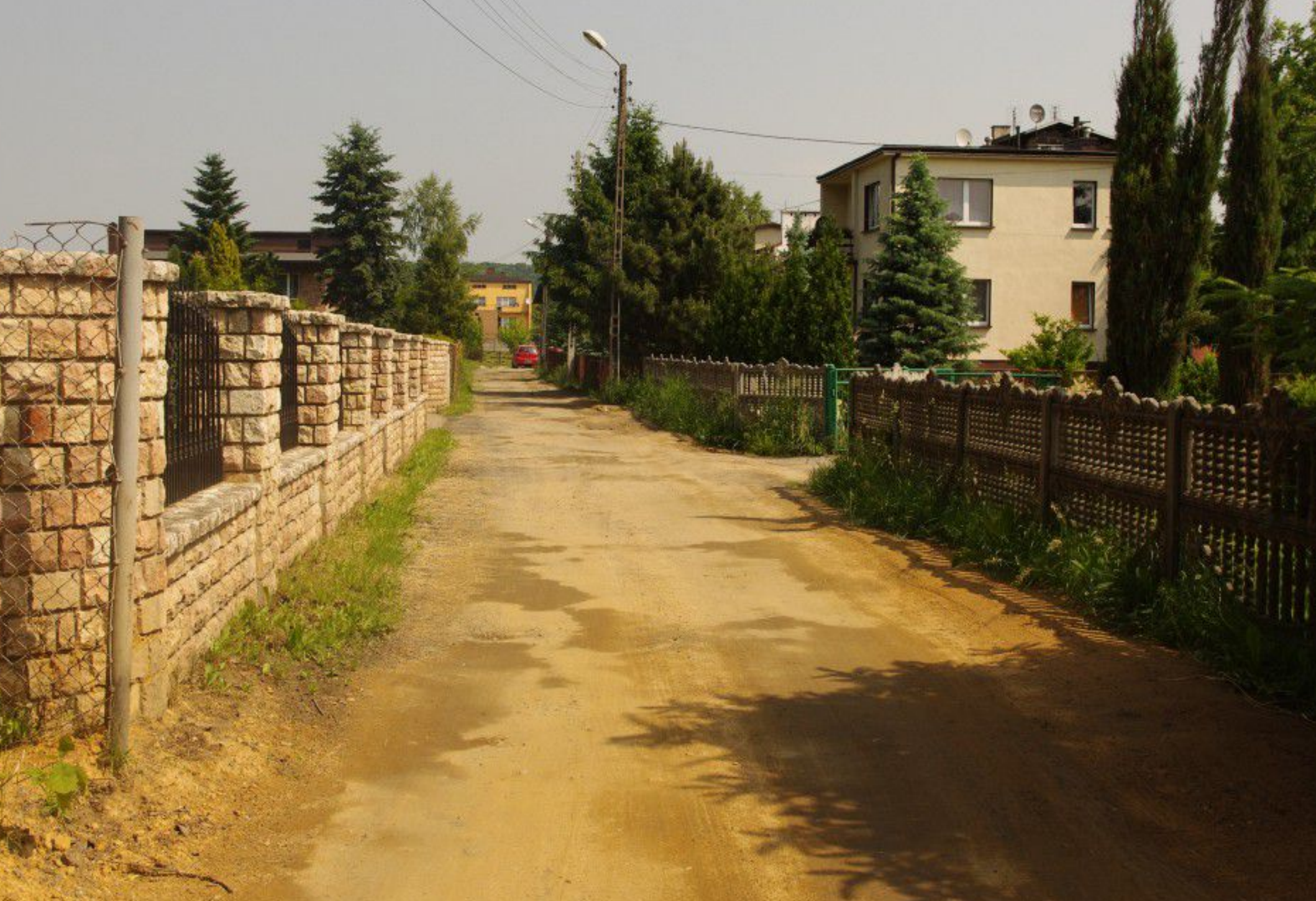
Ulica Reymonta przed remontem.
