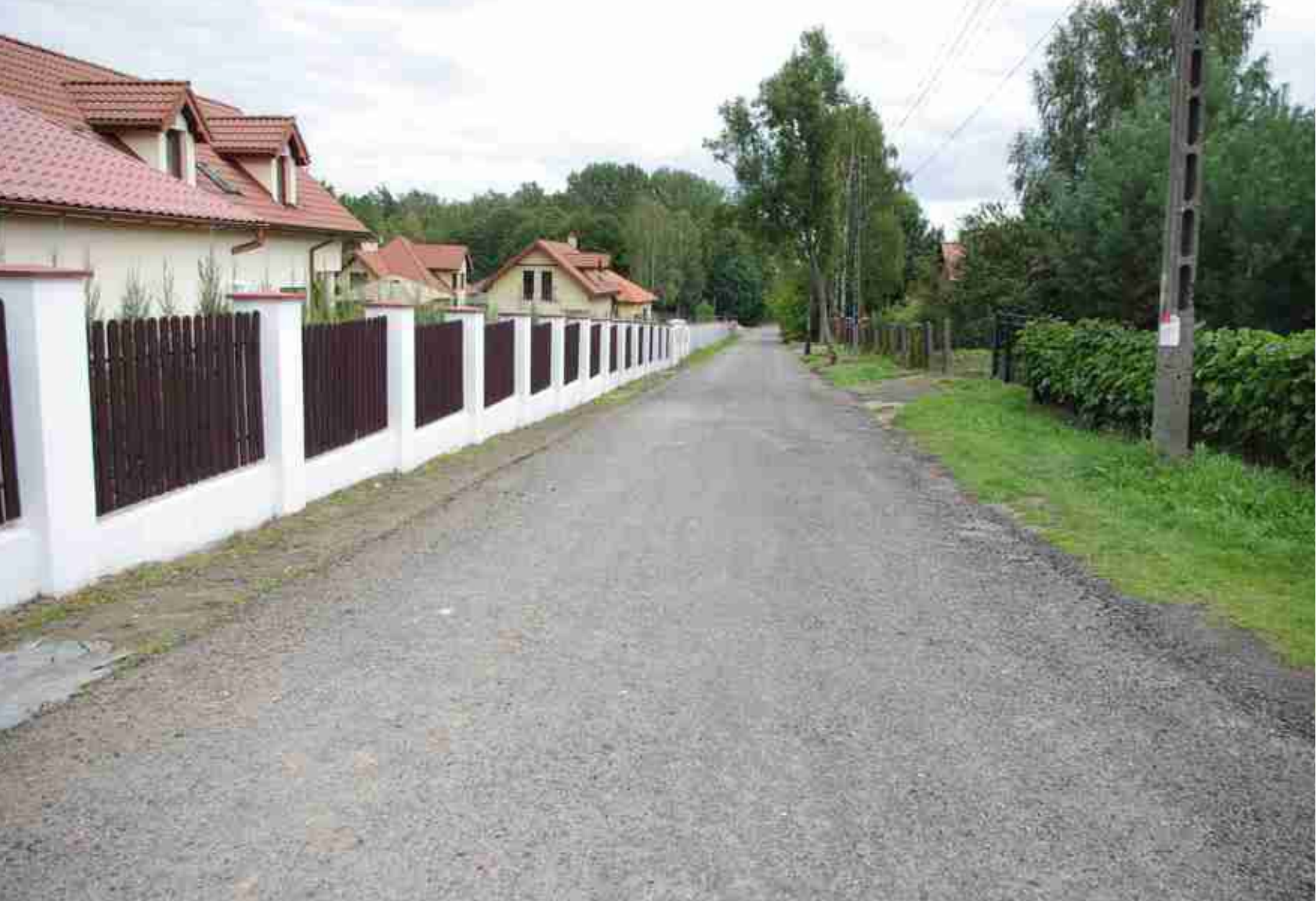
Ulica Wschodnia w Gródkowie po wykonaniu prac.
