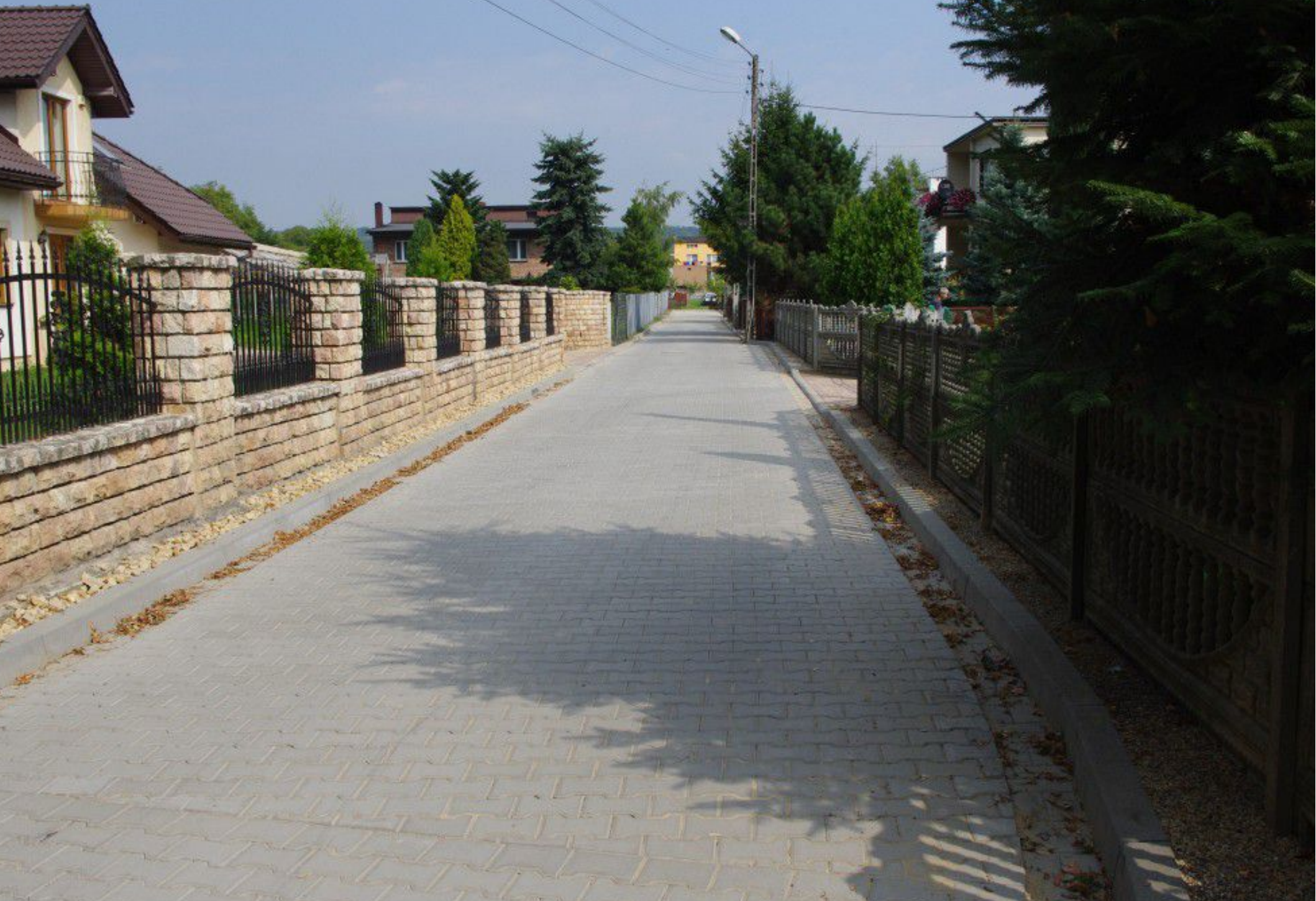
Ulica Reymonta po zakończeniu prac.
