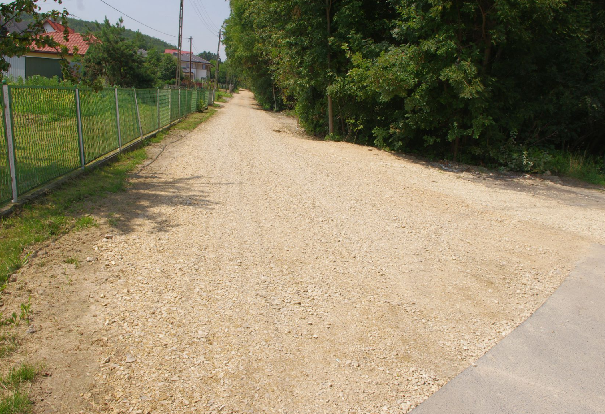
Utwardzona kruszywem ulica Spokojna w Gródkowie.
