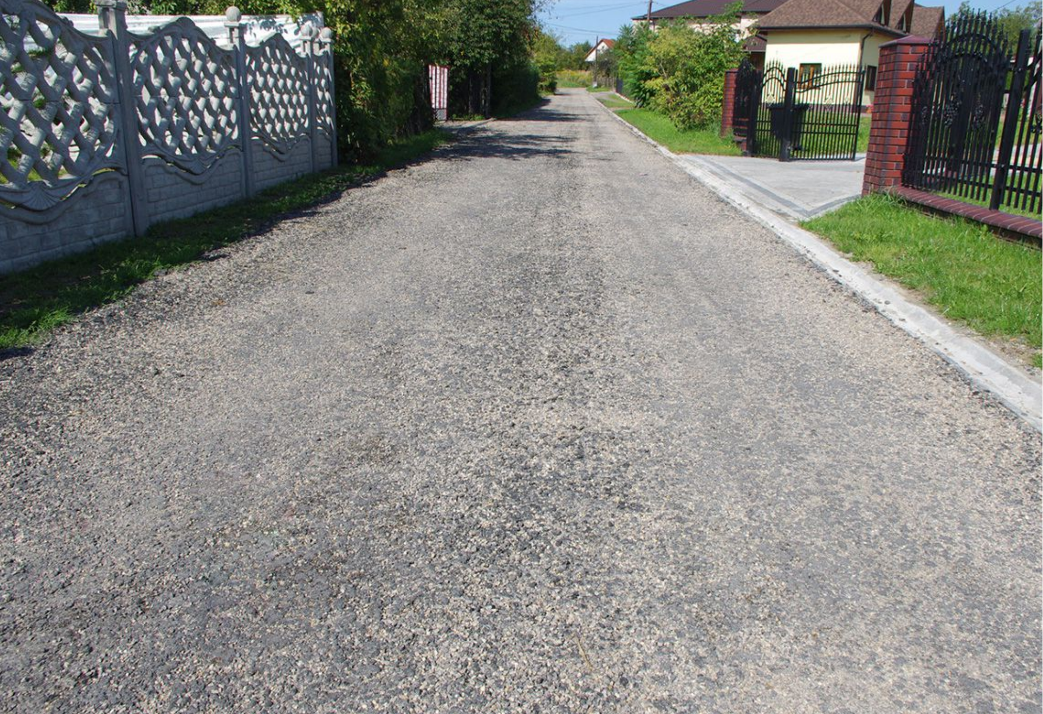
Ulica Browarna w Sarnowie po zakończeniu remontu.
