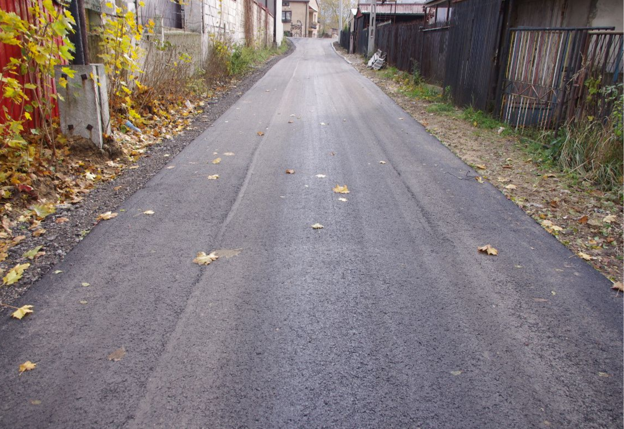
Ulica Spacerowa w Sarnowie po zakończeniu prac.
