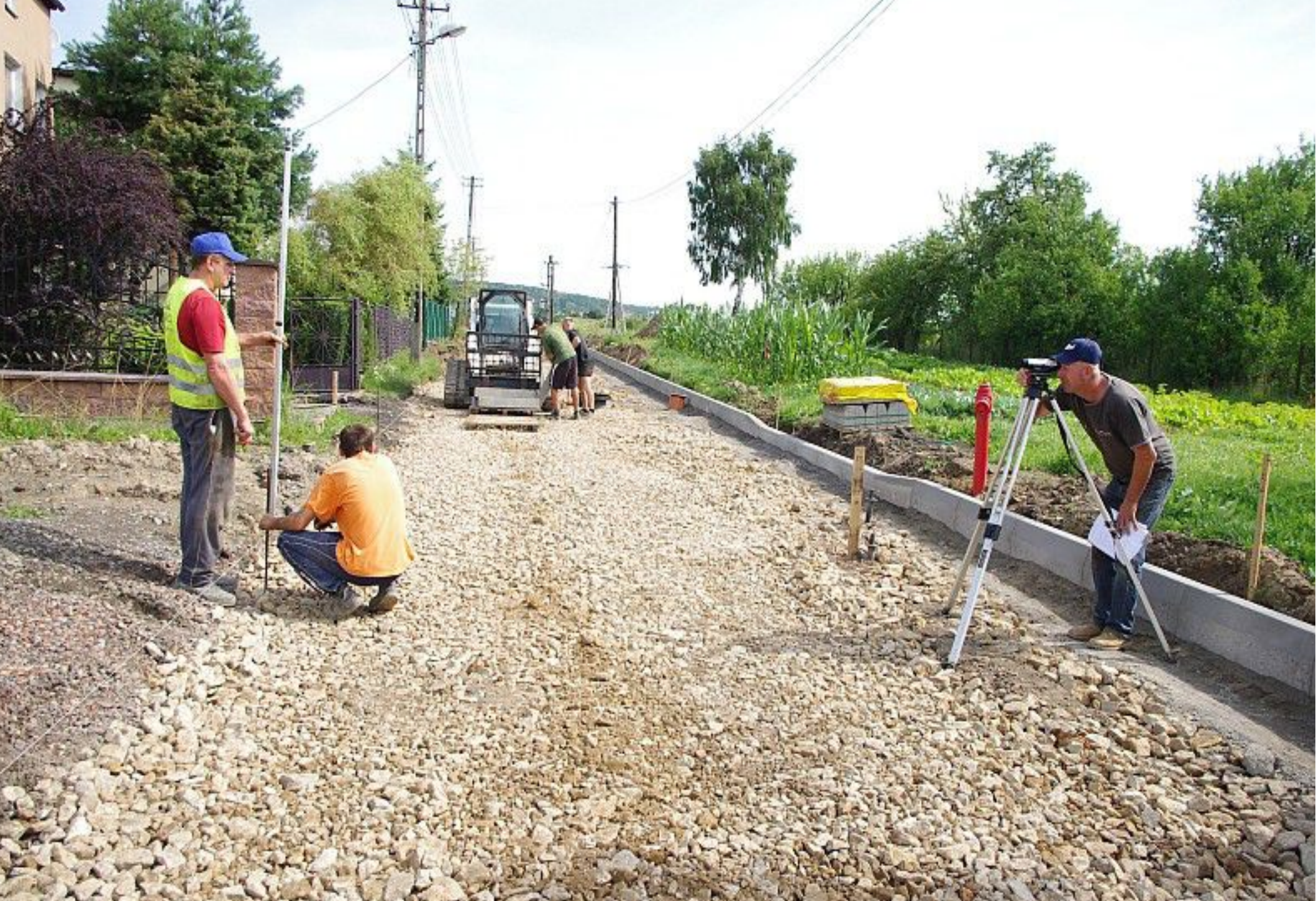
Ulica Kasztanowa w Psarach w trakcie remontu.
