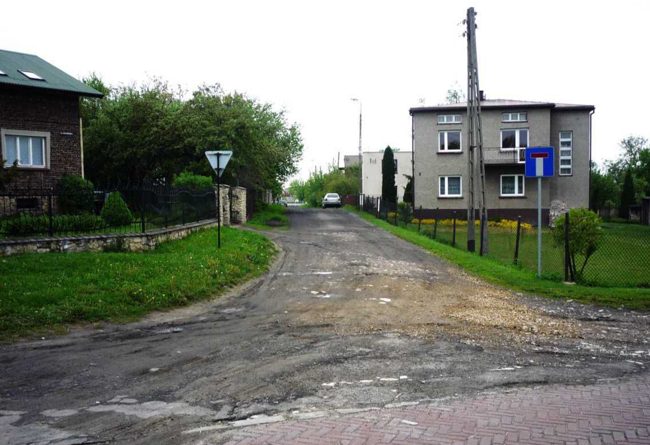
Ulica Źródłana w Sarnowie przed remontem.
