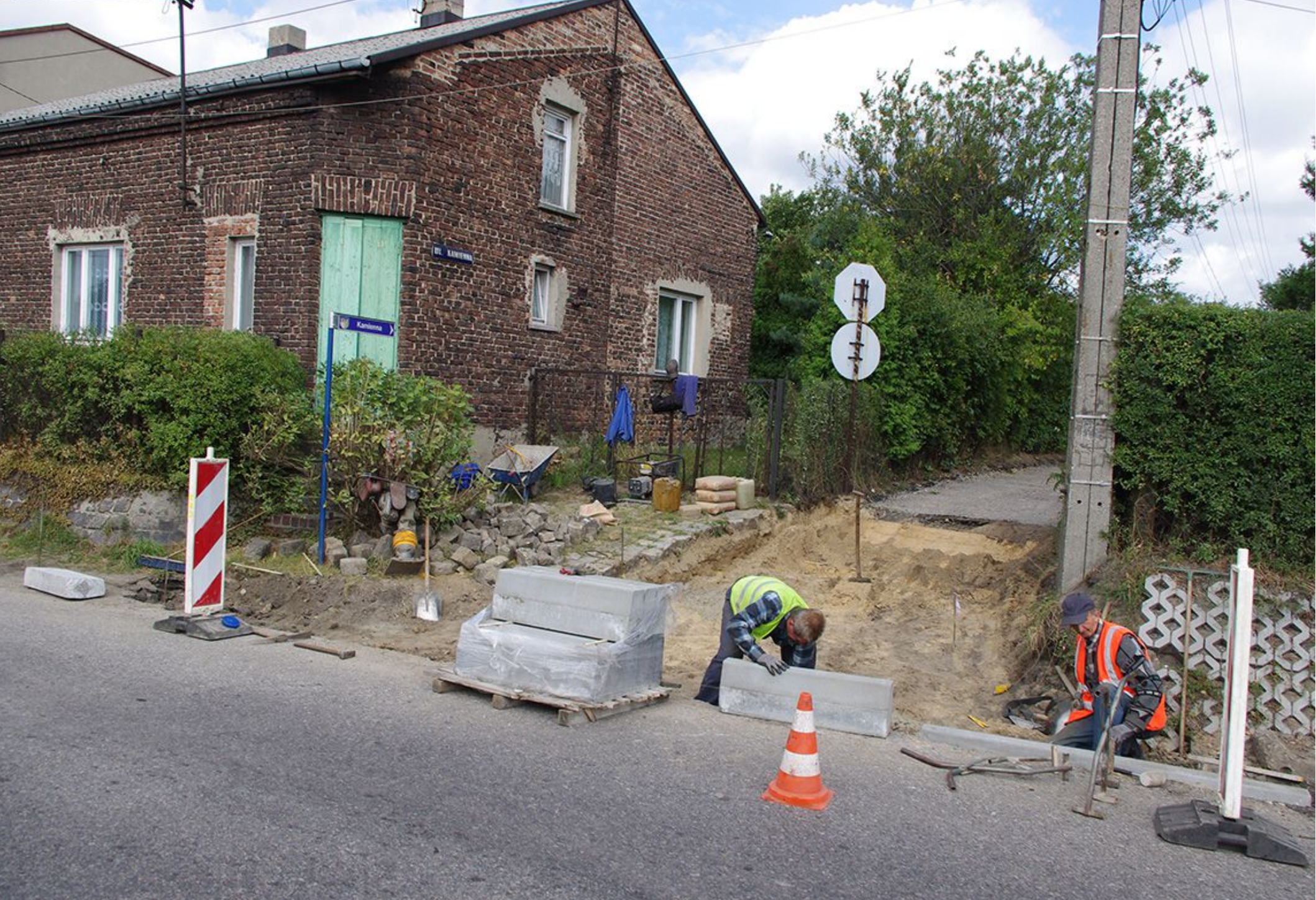
Ulica Kamienna w Sarnowie w trakcie prac.
