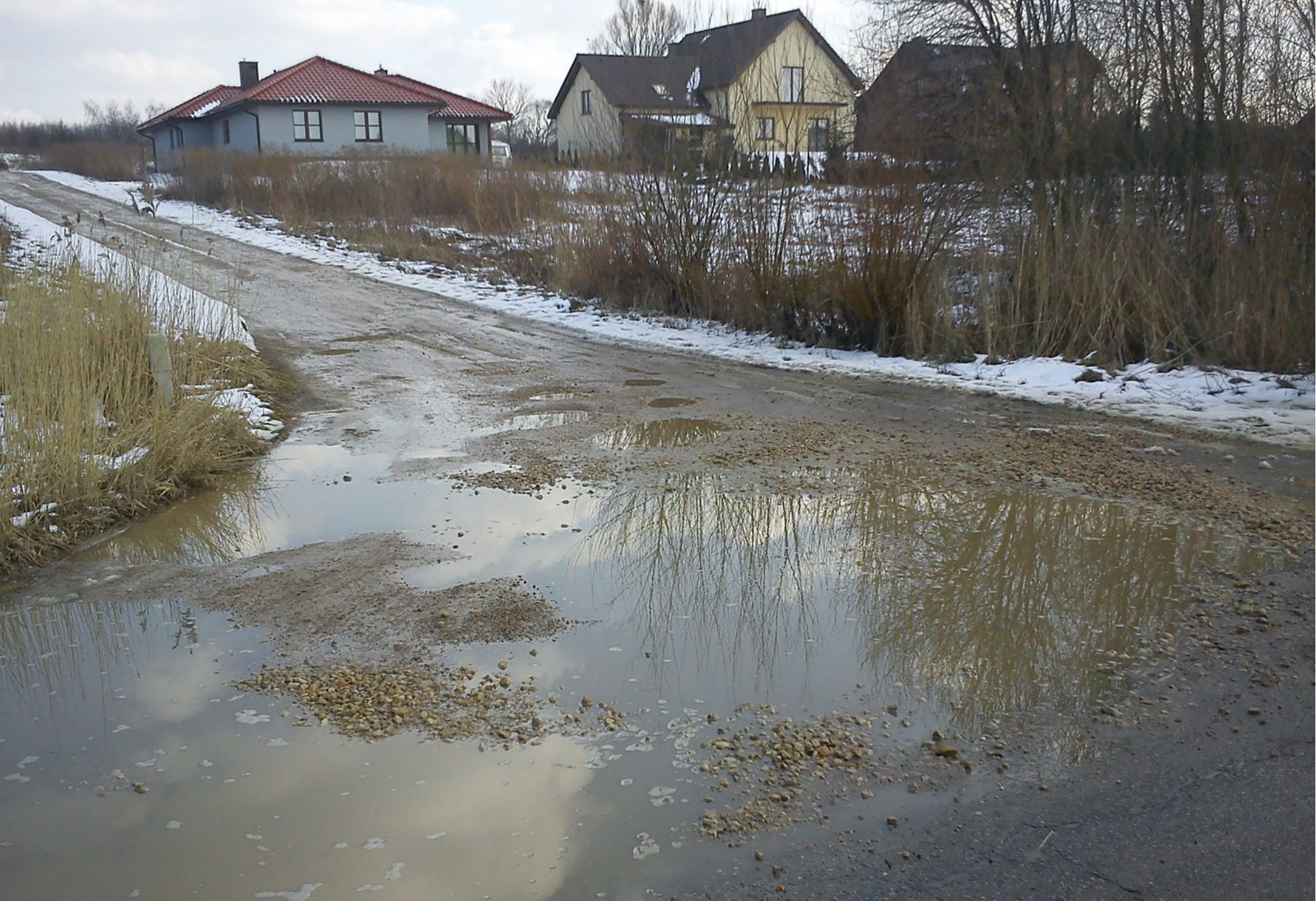
Ulica Irysów w Psarach przed rozpoczęciem inwestycji.
