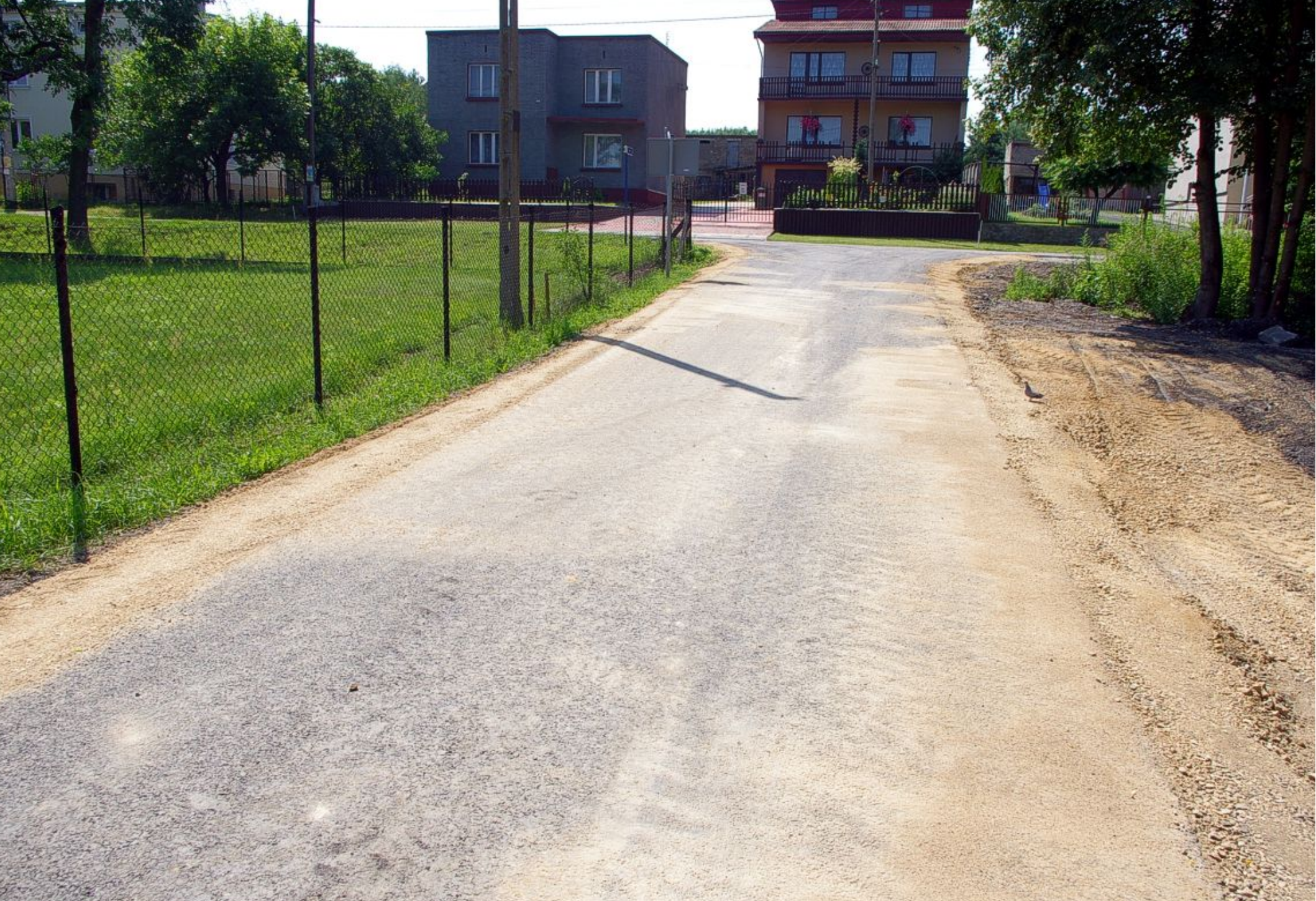
Nowa nakładka na ulicy Górnej w Górze Siewierskiej.
