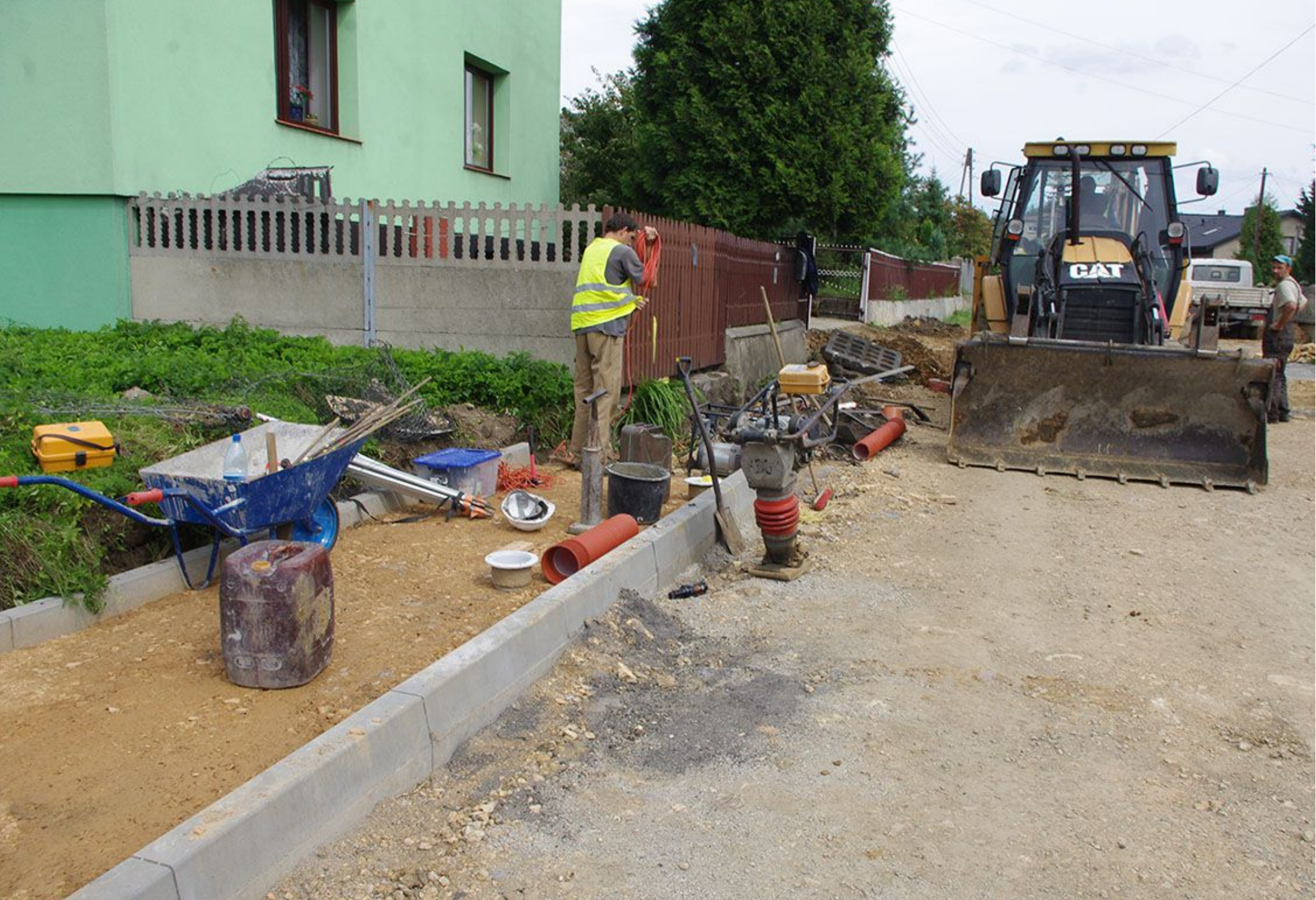
Ulica Kościuszki w Górze Siewierskiej w trakcie przebudowy.
