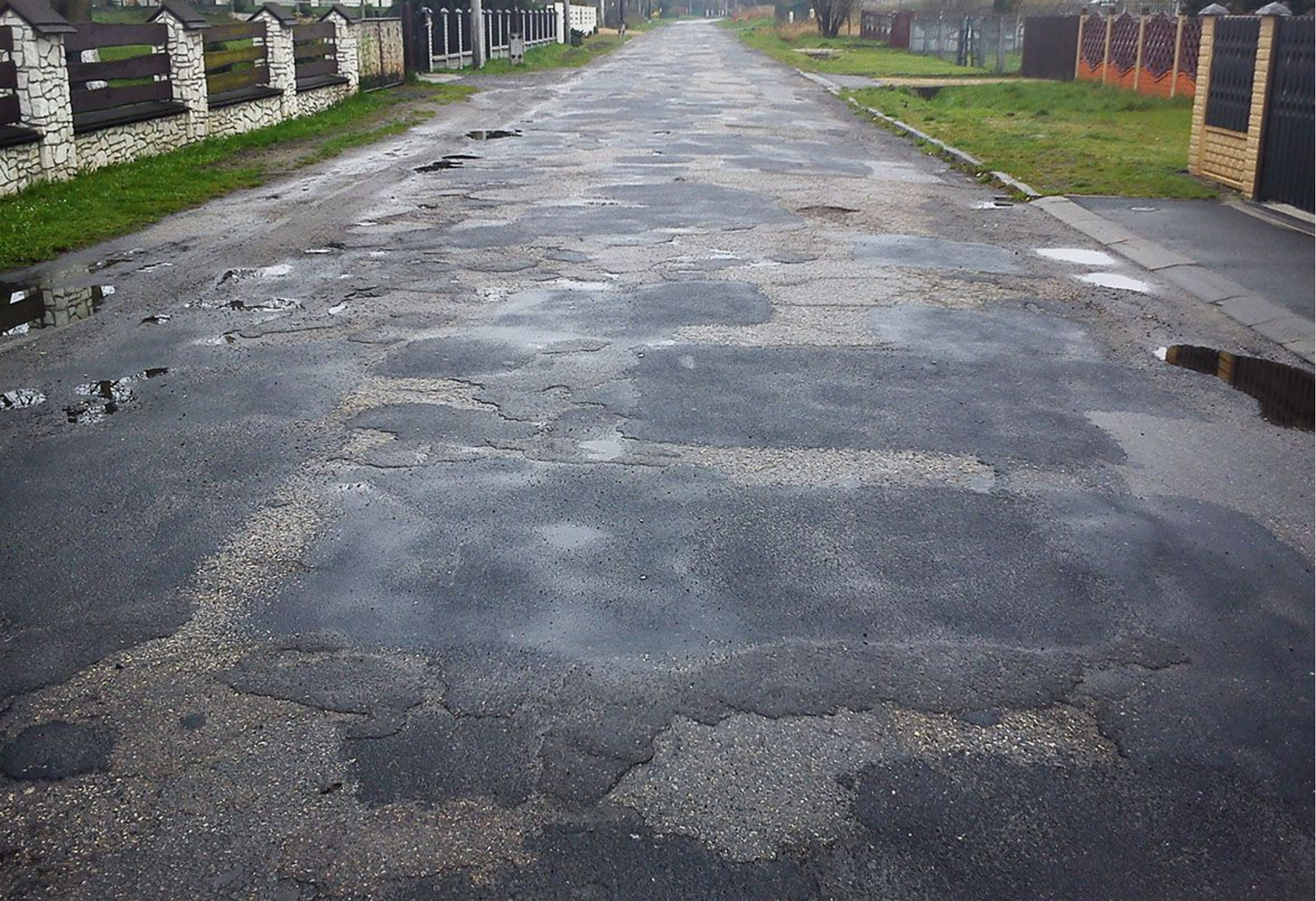
Ulica Szkolna w Preczowie przed rozpoczęciem inwestycji.
