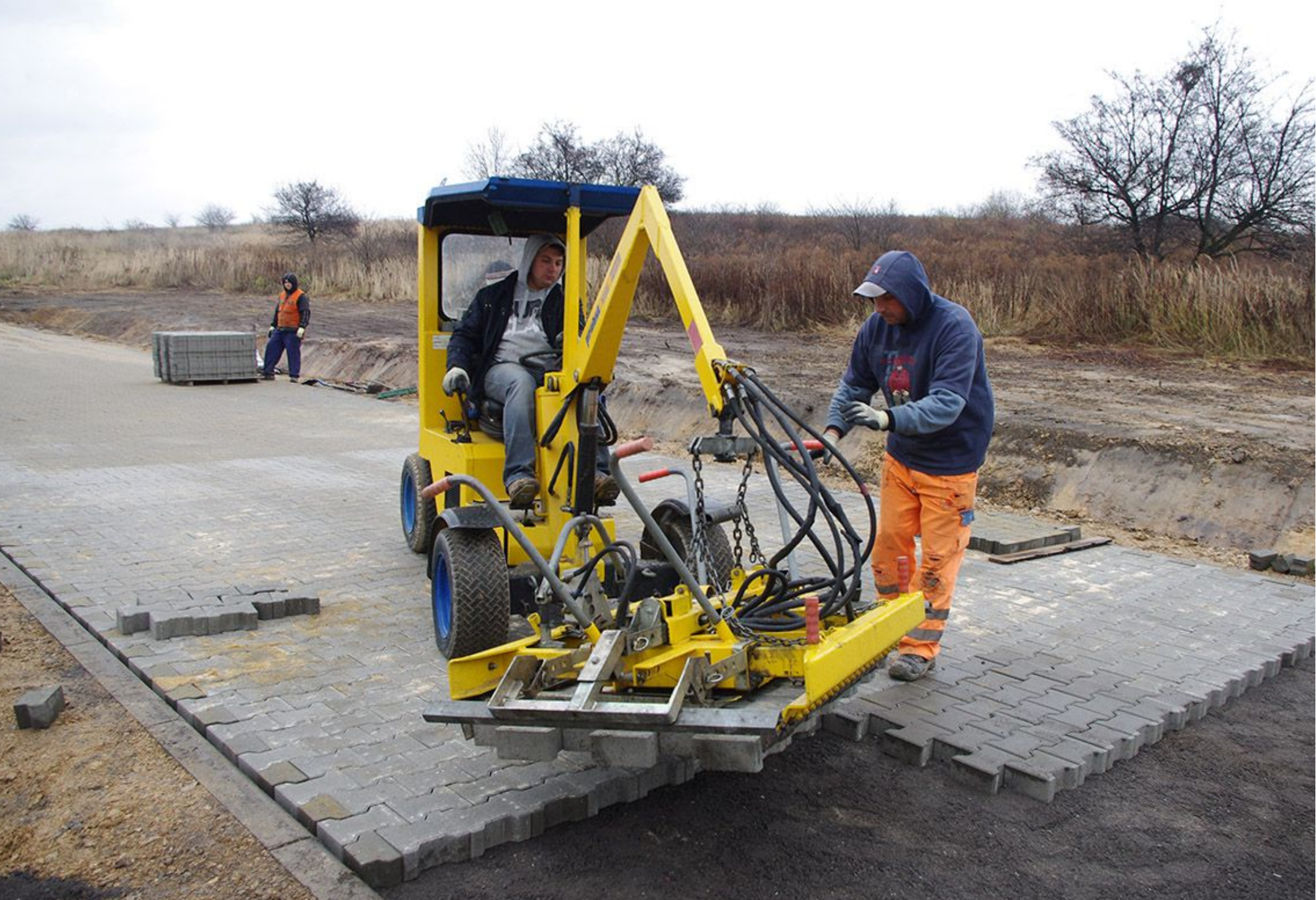
Ulica Irysów w Psarach w trakcie remontu.
