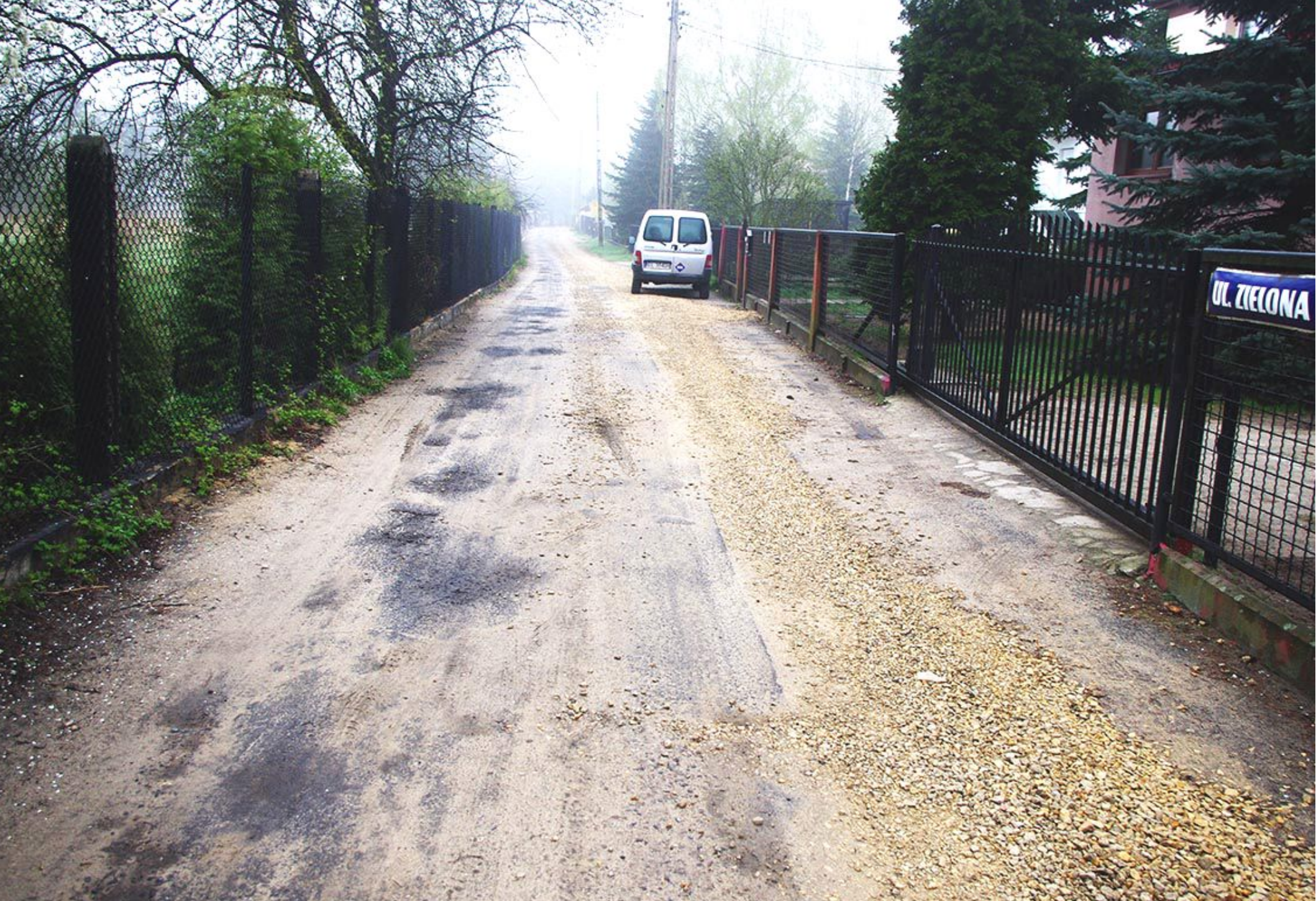
Ulica Zielona w Preczowie przed rozpoczęciem inwestycji.
