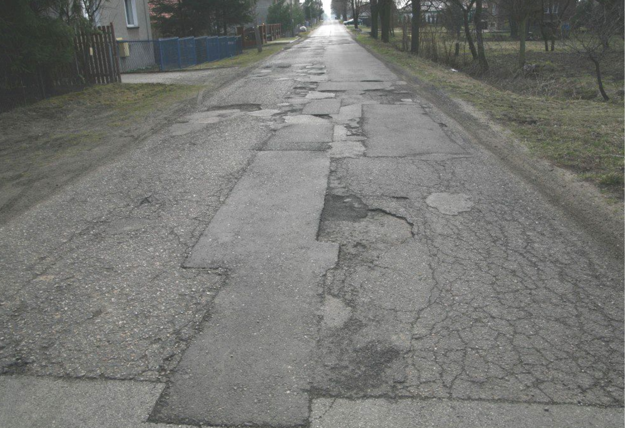
Ulica Graniczna przed remontem.
