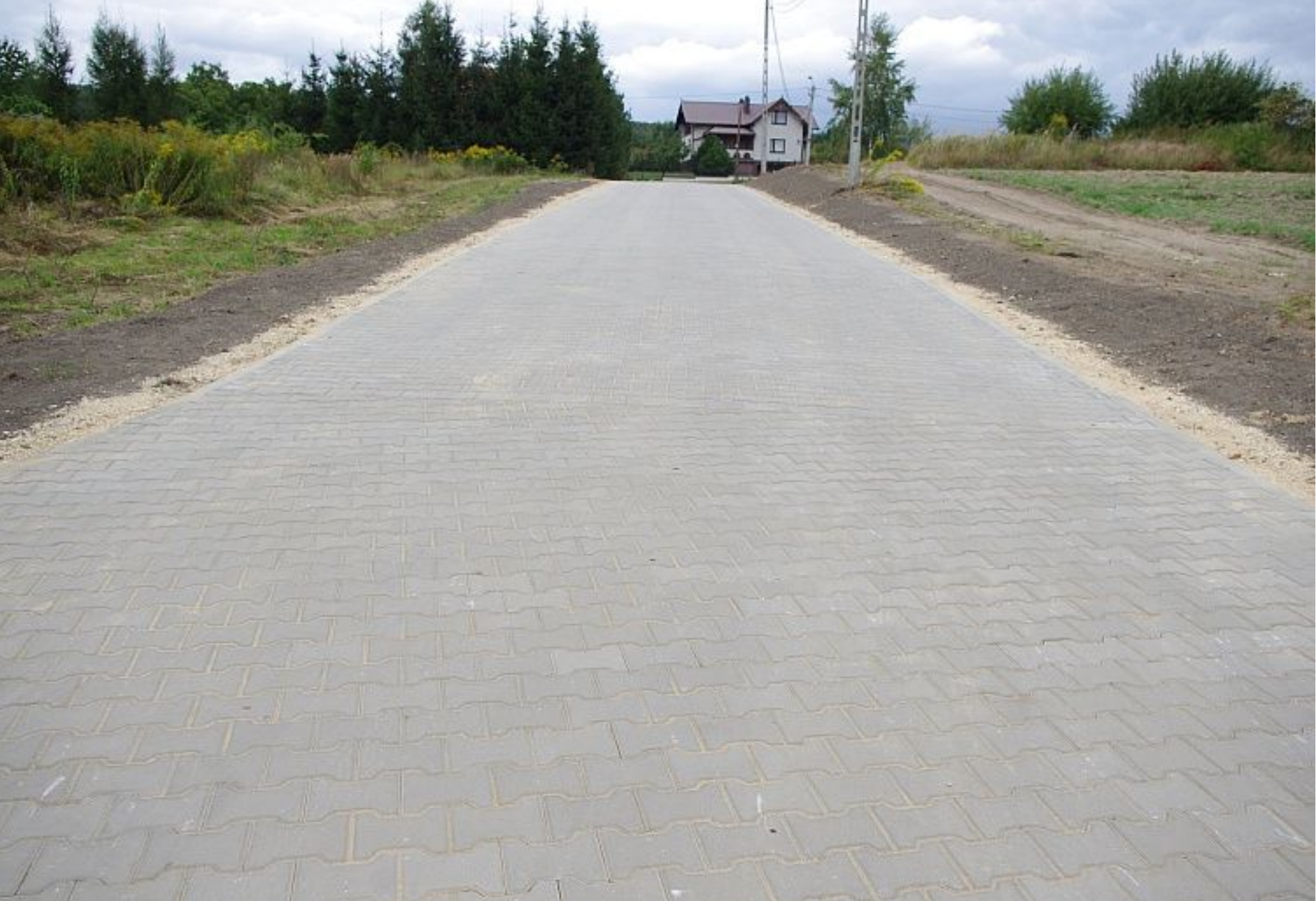
Ulica Belna w Strzyżowicach po zakończeniu prac.
