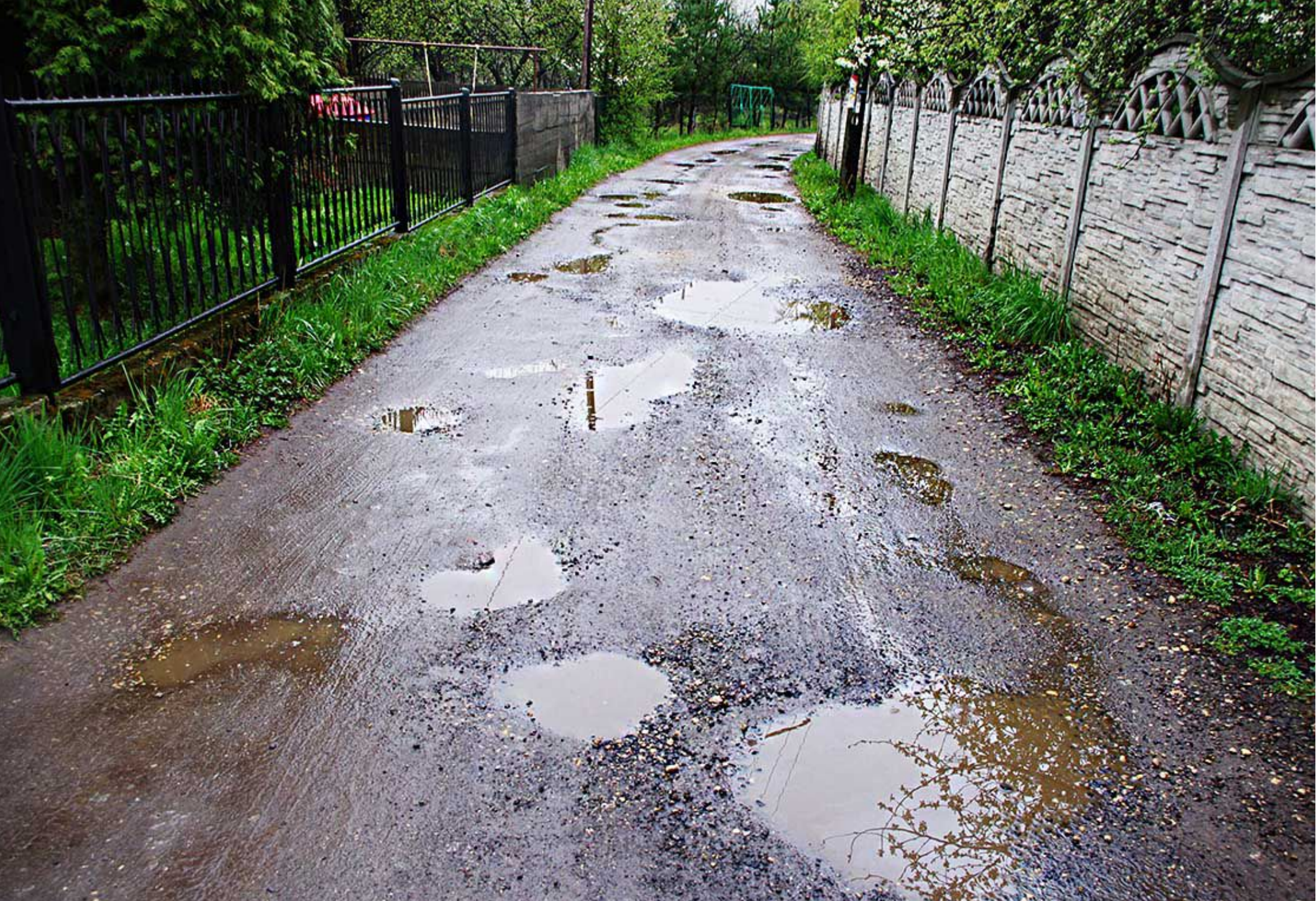
Ulica Bocznej w Strzyżowicach przed rozpoczęciem inwestycji.
