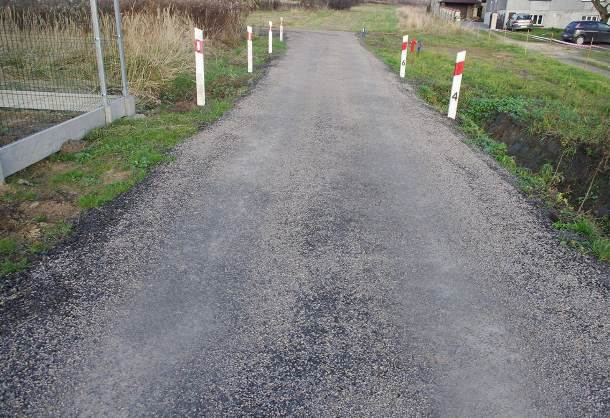
Ulica Szosowa w Strzyżowicach po zakończeniu remontu.
