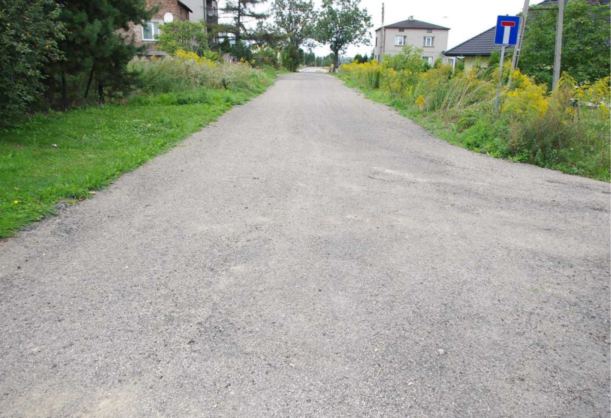
Ulica Jasna w Sarnowie po utwardzeniu.
