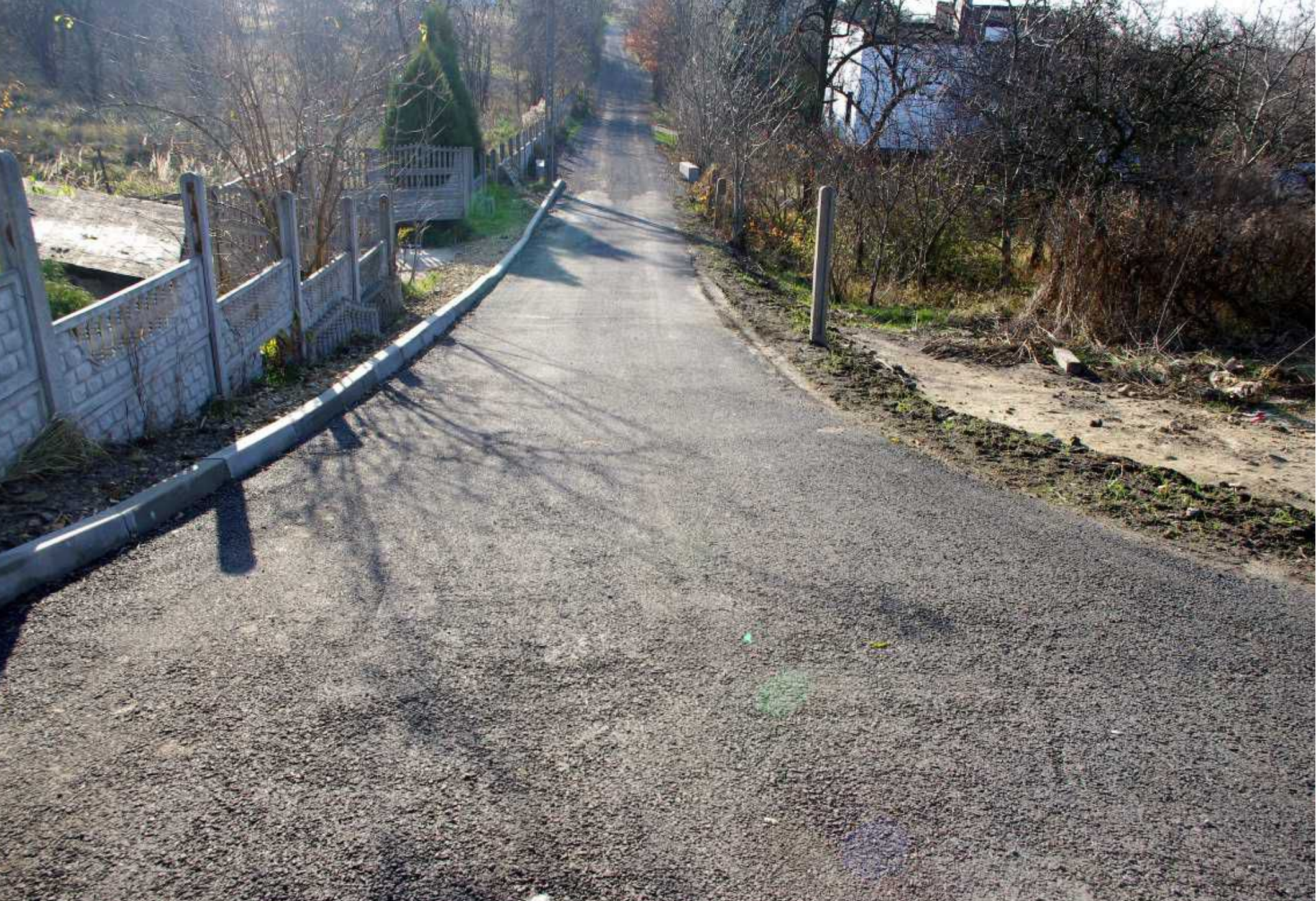
Ulica Kwiatowa w Gródkowie po wykonaniu prac.
