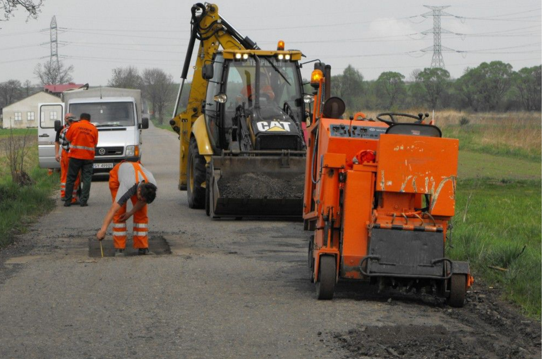
Profesjonalne naprawy nawierzchni asfaltowych ul. Kolejowej w Dąbiu Chrobakowym i ul. Bocznej w Psarach o wartości ponad 60 000 zł w 2011 roku.
