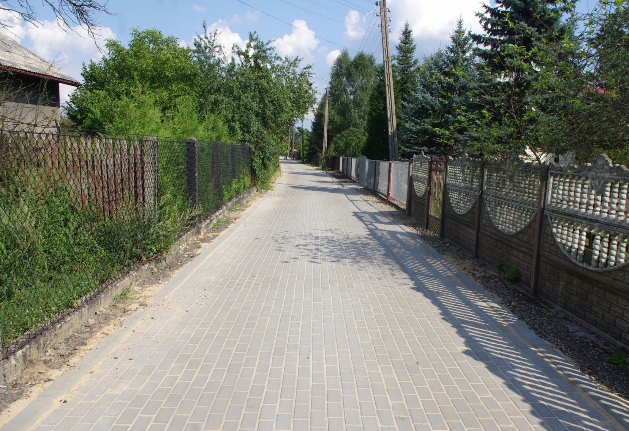
Ulica Zielona w Preczowie po przebudowie.
