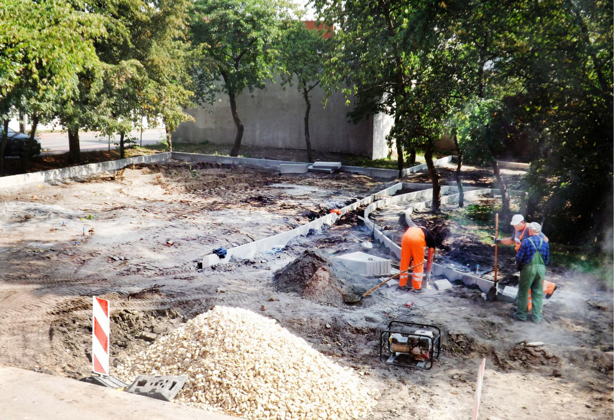
Prace nad zagospodarowaniem placu przy OSP w Sarnowie.
