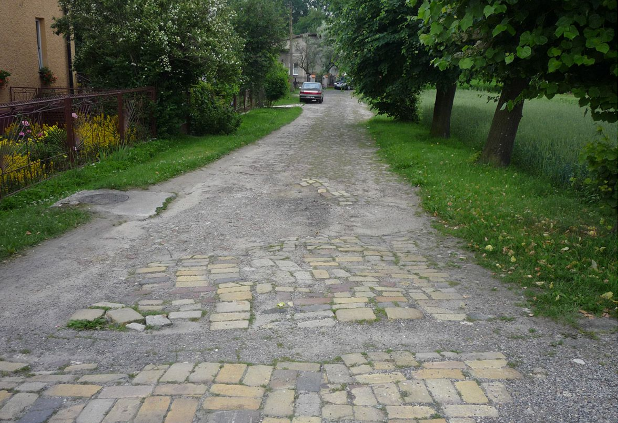
Ulica Dojazdowa w Gródkowie przed remontem.
