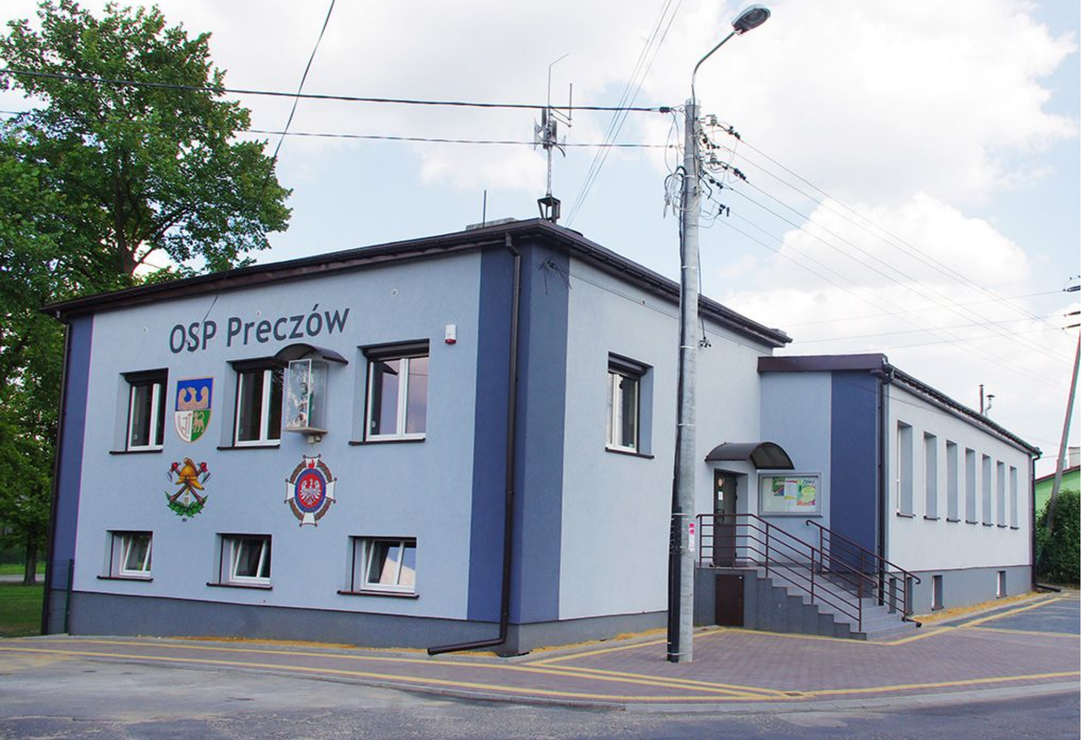
Nowy parking przy remizie OSP w Preczowie.
