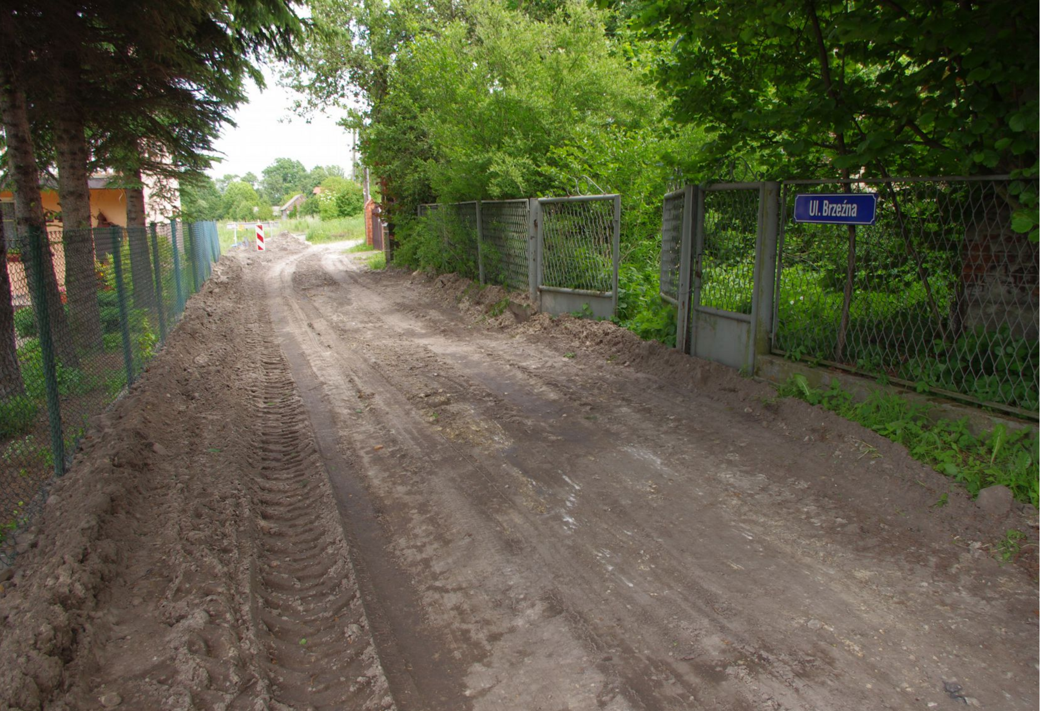
Ulica Brzeźna w Preczowie przed utwardzeniem drogi.
