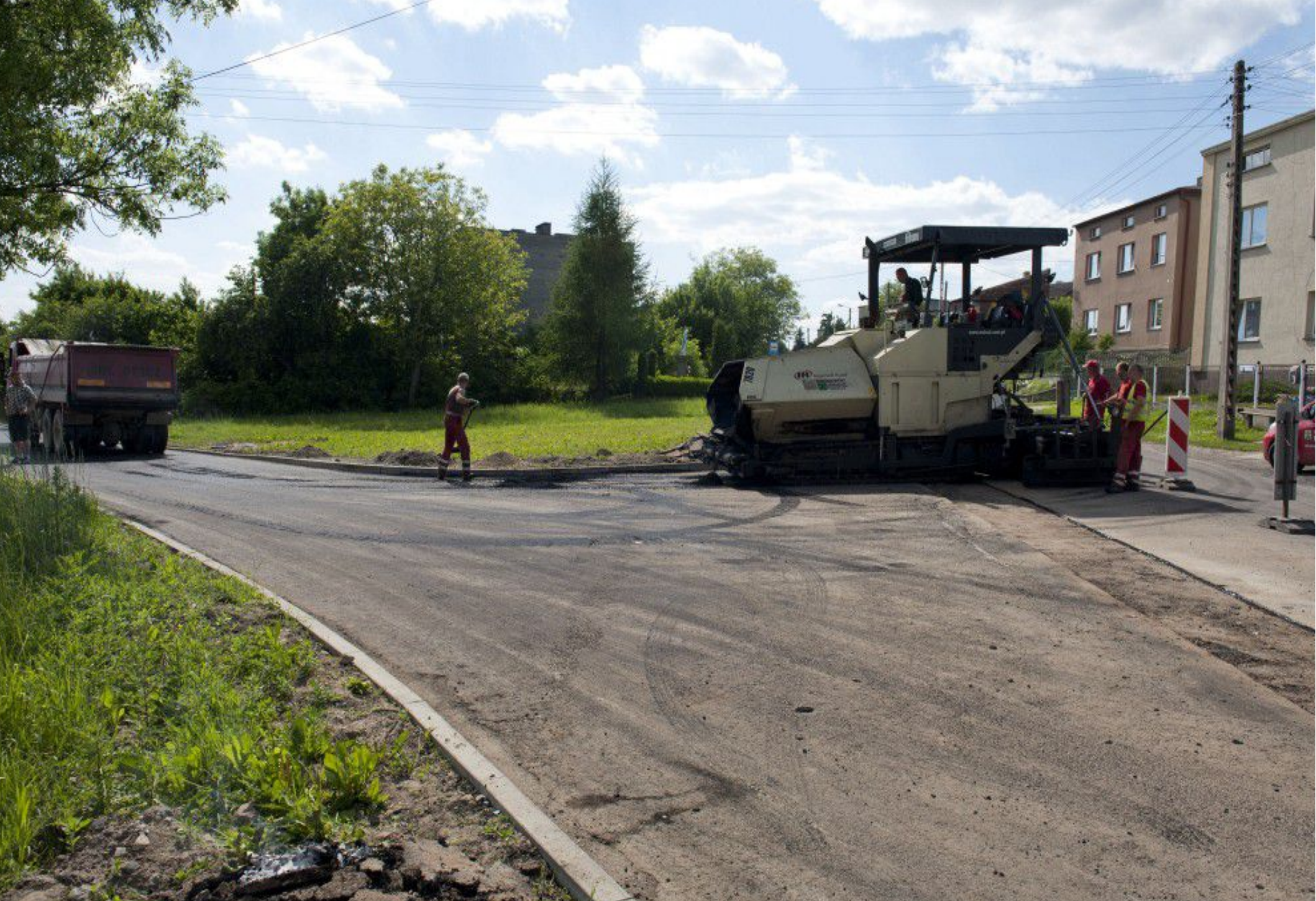
Ulica Graniczna w trakcie remontu.
