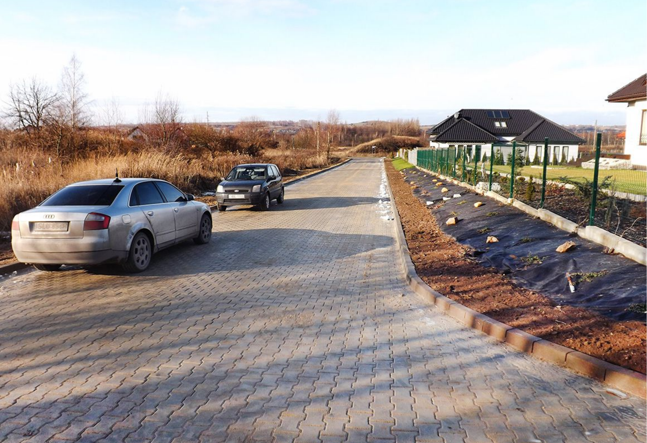
Ulica Irysów po zakończeniu prac.
