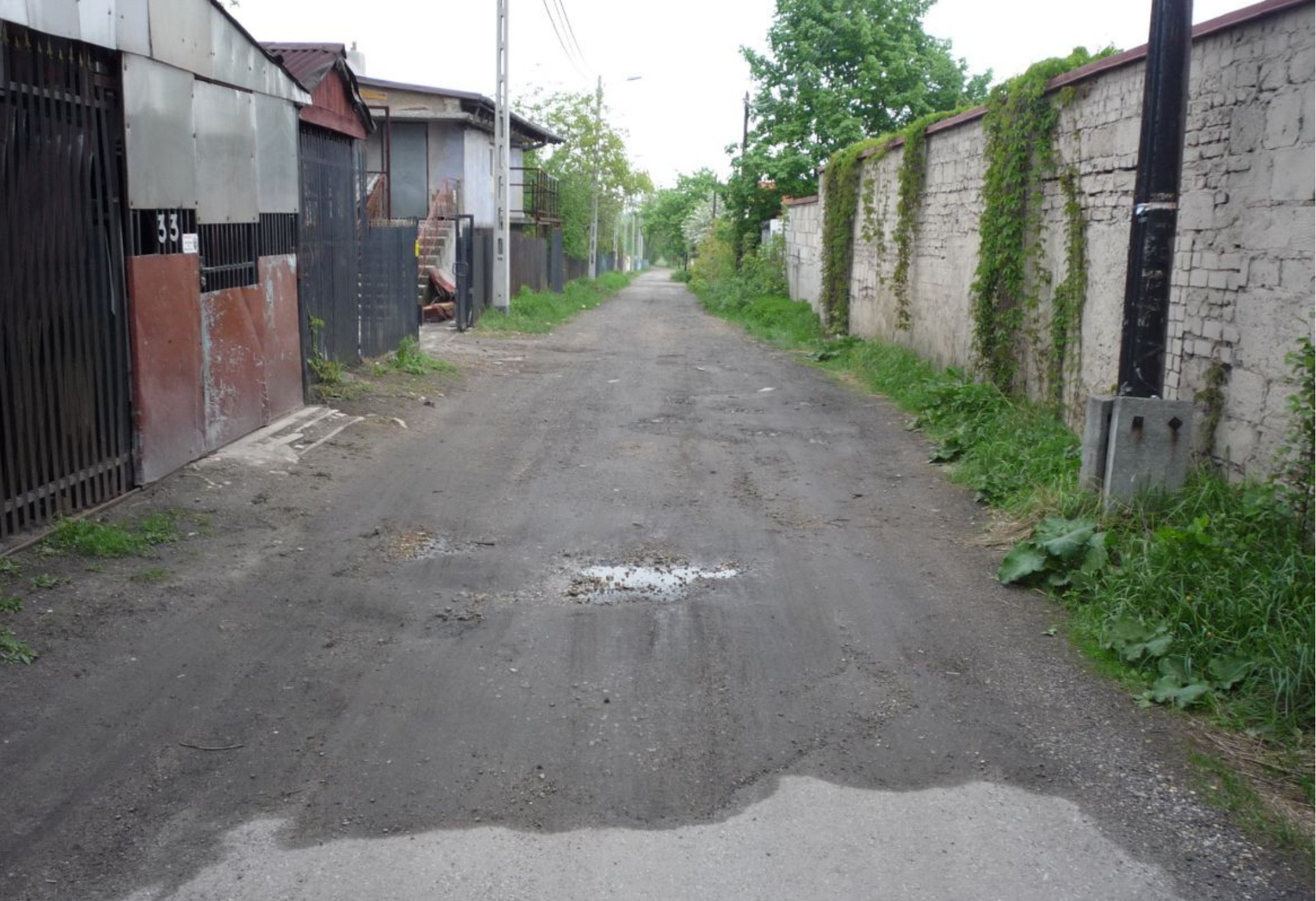
Ulica Spacerowa w Sarnowie przed remontem.
