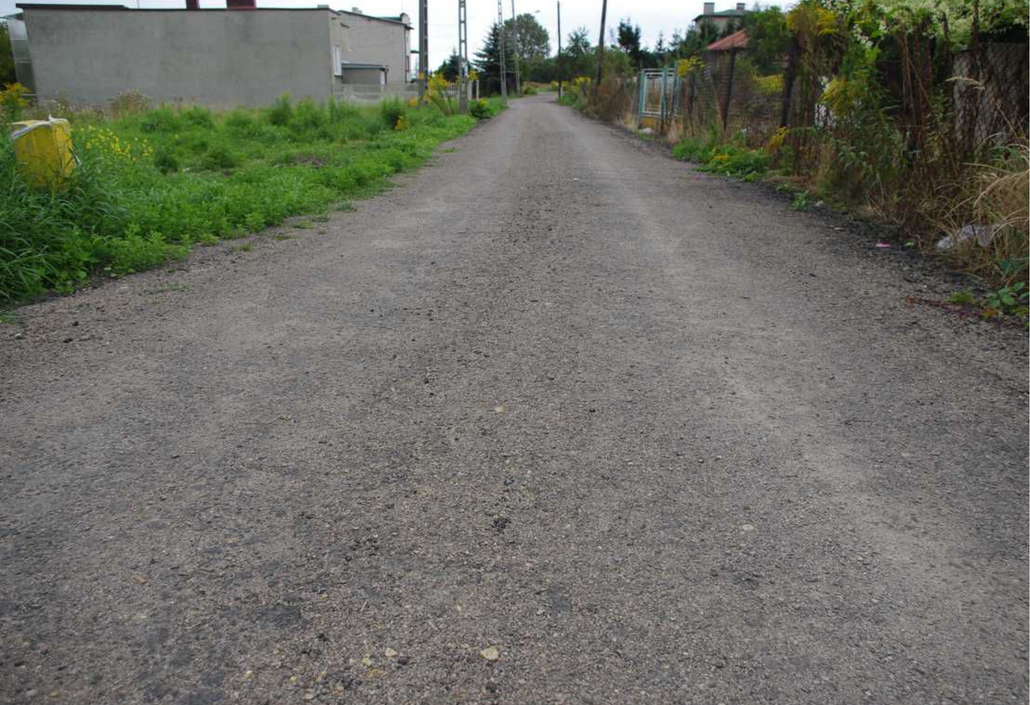
Ulica Polna w Psarach po utwardzeniu.
