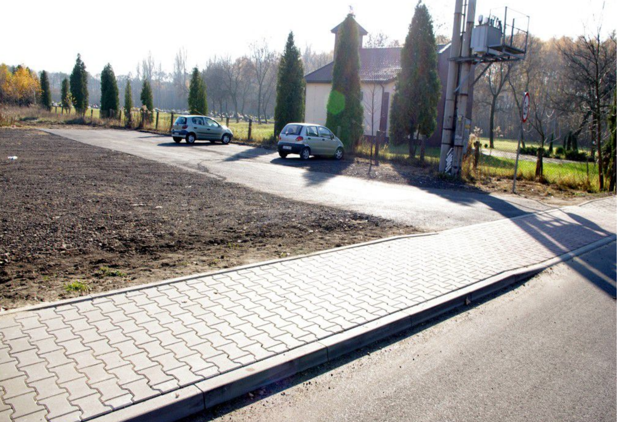
Ulica Graniczna po przebudowie.
