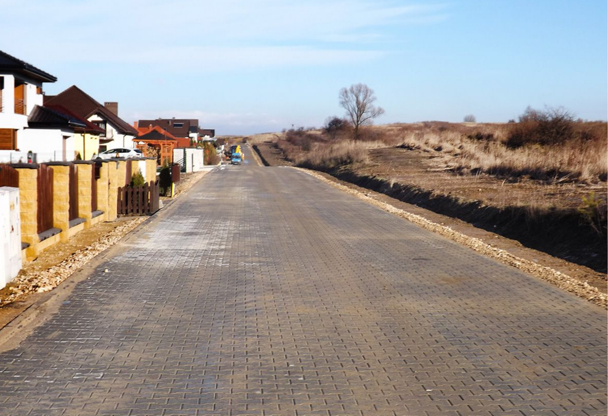
Ulica Irysów po zakończeniu prac.
