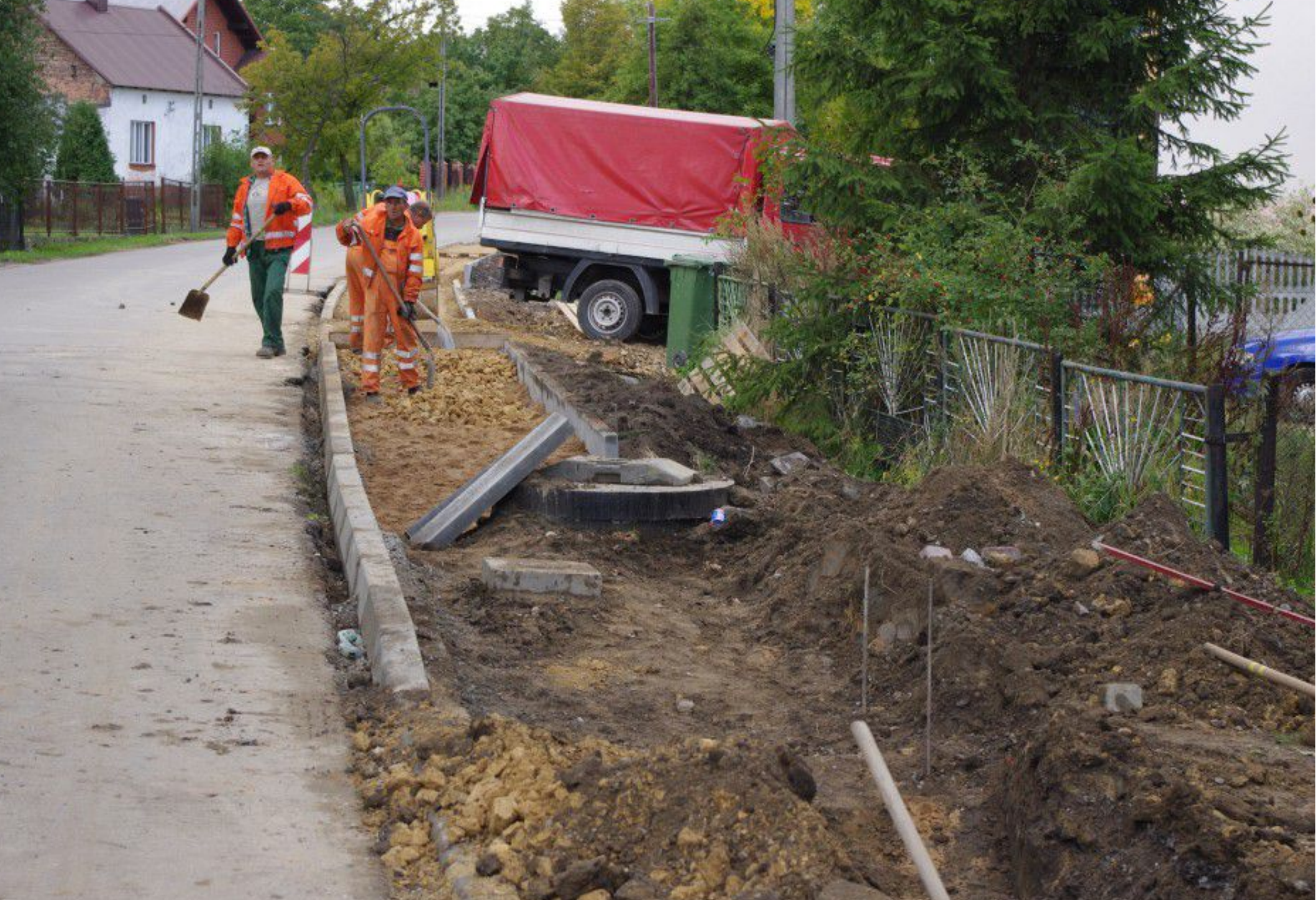
Prace przy budowie chodnika przy ulicy Wiejskiej w Sarnowie.
