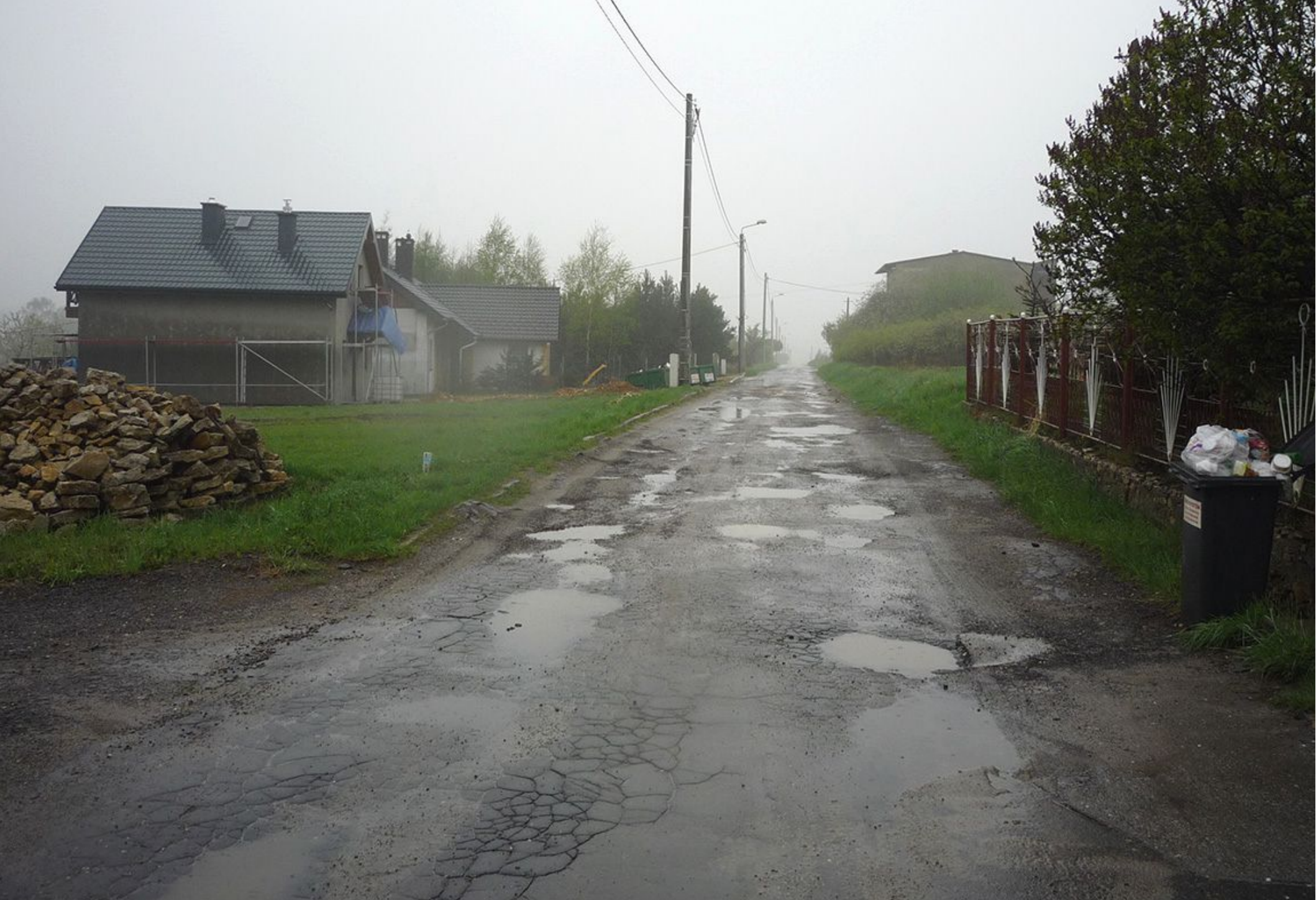
Ulica Górna w Górze Siewierskiej przed remontem.
