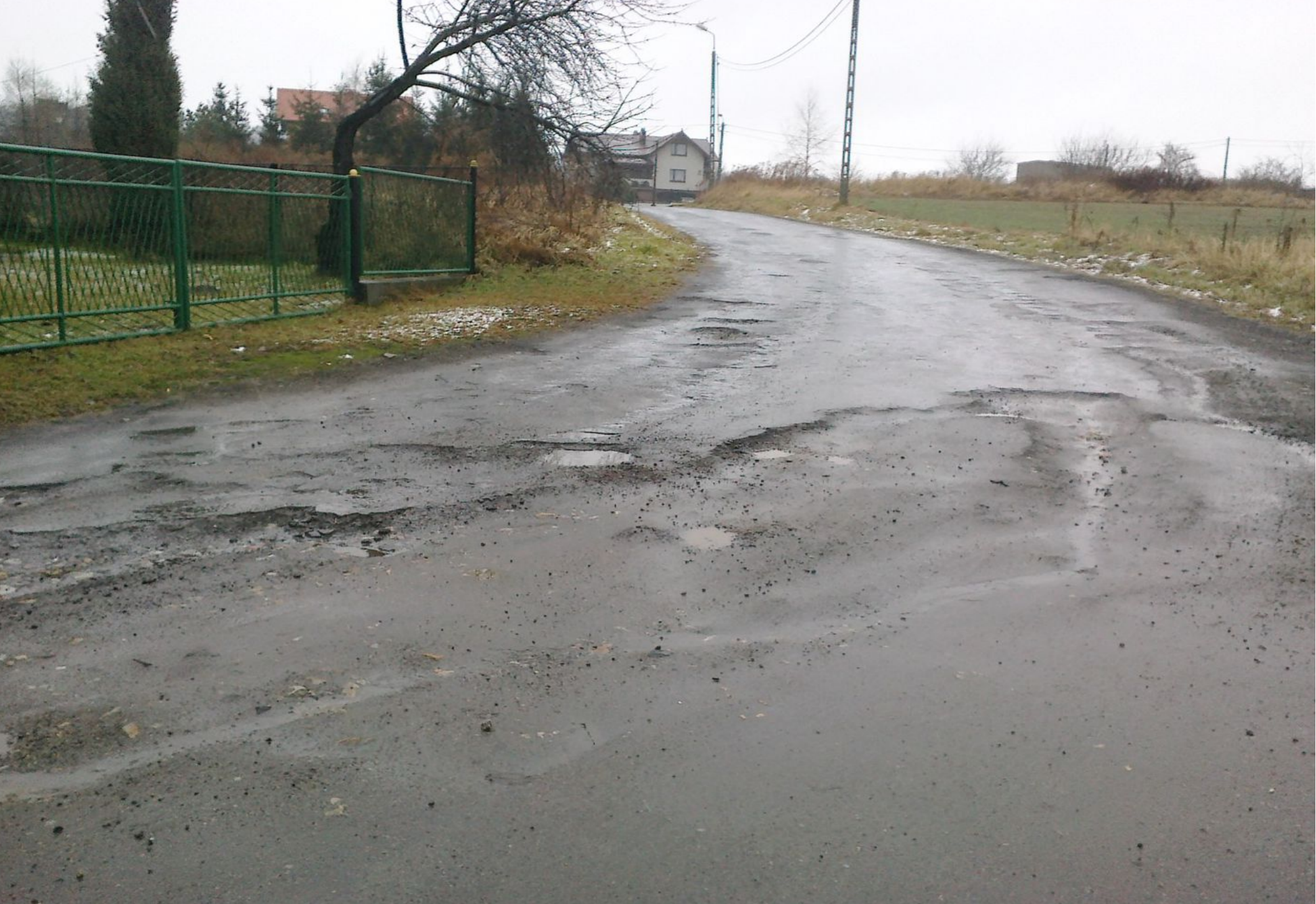
Ulica Belna w Strzyżowicach przed rozpoczęciem inwestycji.
