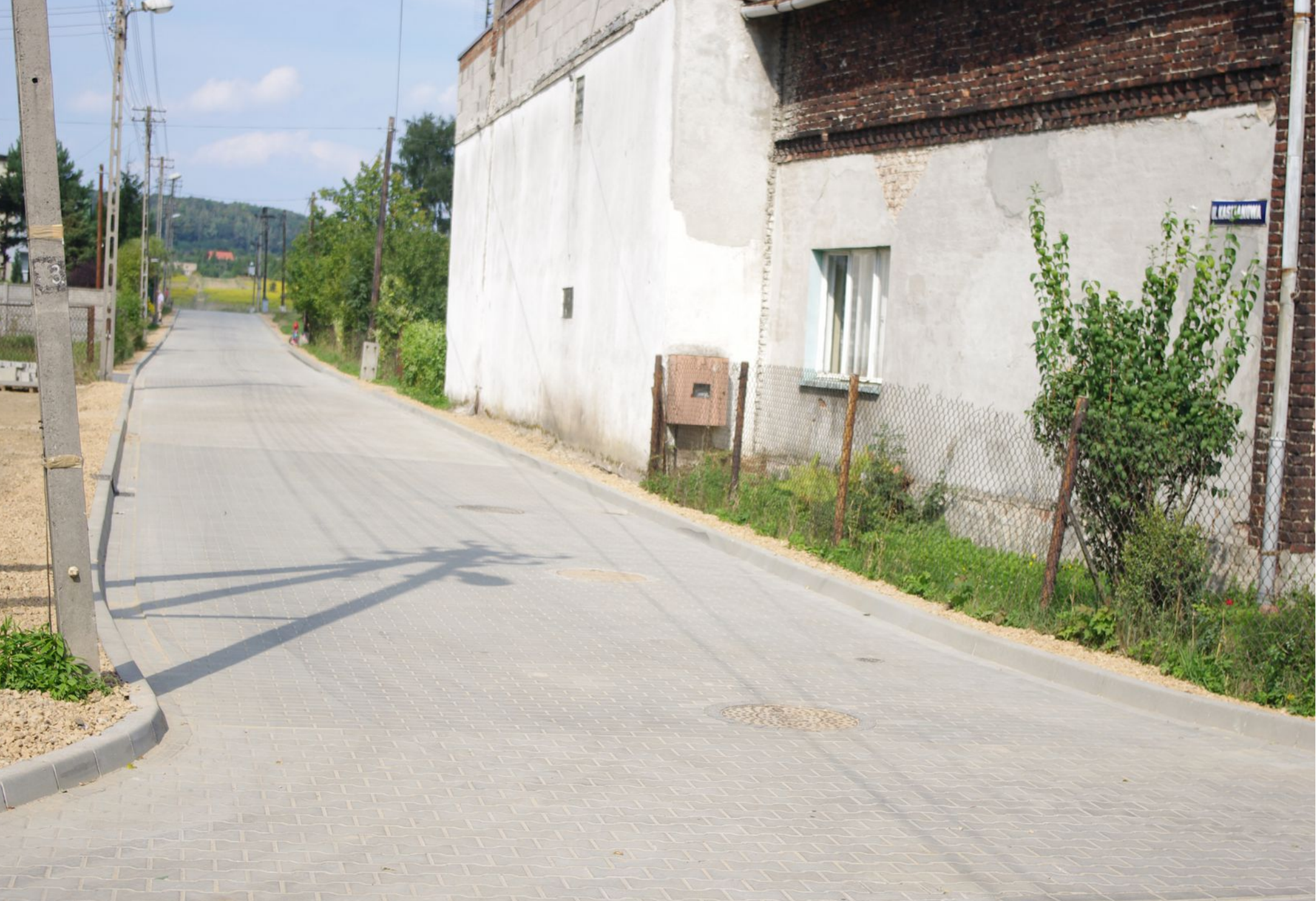
Ulica Kasztanowa po zakończeniu prac.
