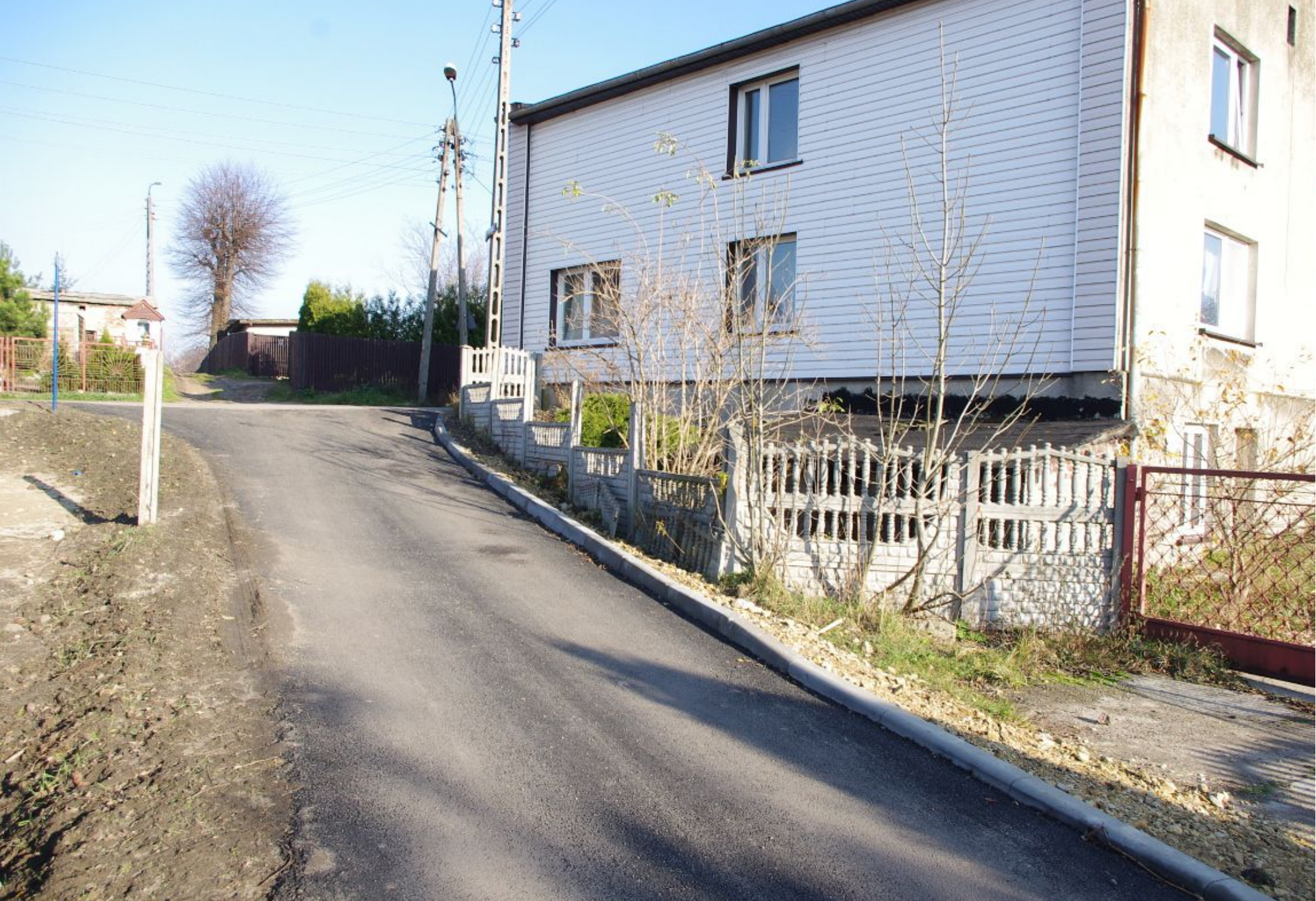
Ulica Kwiatowa w Gródkowie po wykonaniu prac.
